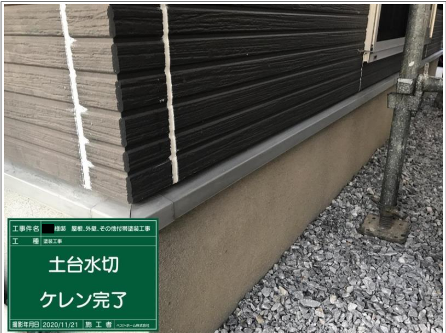
工事件名 様邸 屋根・外壁、その他付帯塗装工事 工 種 塗装工事 土台水切 ケレン 撮影年月日 2020/11/21 施 工 者 ヘストホーム株式会社
