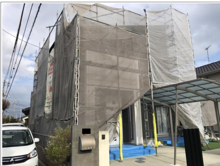
足場組立 完了
