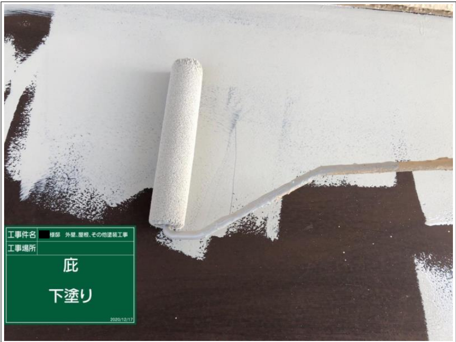
工事件名 様邸 外壁、屋根、その他塗装工事 工事場所 庇 下塗り 2020/12/17
