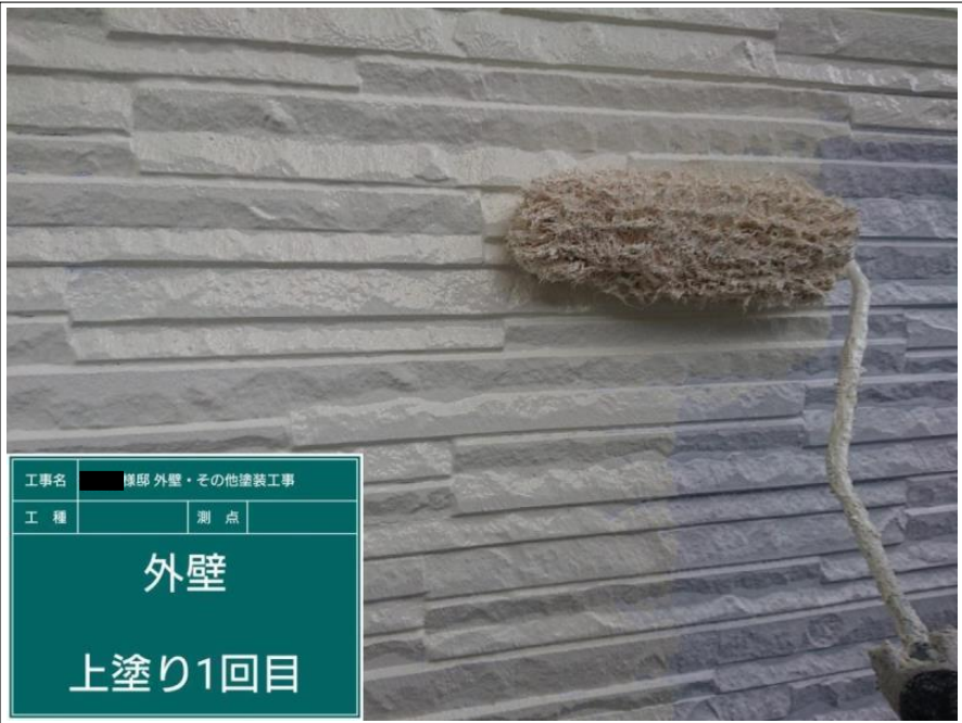
工事名 様邸 外壁・その他塗装工事 工 種 測 点 外壁 上塗り1回目
