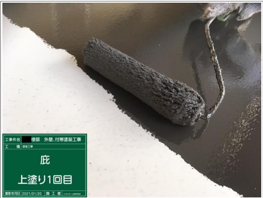
工事件名 棟部 外壁、付帯塗装工事 工 種 塗装工事 庇 上塗り1回目 撮影年月日 2021/01/20 施 工 者 ハコブネー・山本建設
