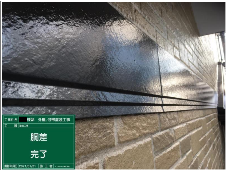
工事件名 様邸 外壁、付帯塗装工事 工 種 塗装工事 胴差 上塗り2回目 撮影年月日 2021/01/21 施 工 者 ハコブホーム株式会社
