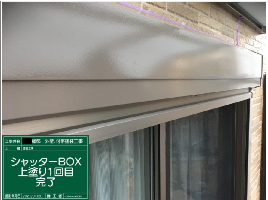
工事件名 様邸 外壁、付帯塗装工事 工 種 塗装工事 シャッターBOX 上塗り1回目 撮影年月日 2021/01/20 施 工 者 ハコブホーム株式会社
