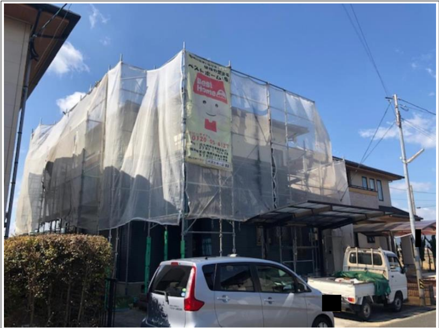
足場組立 完了
