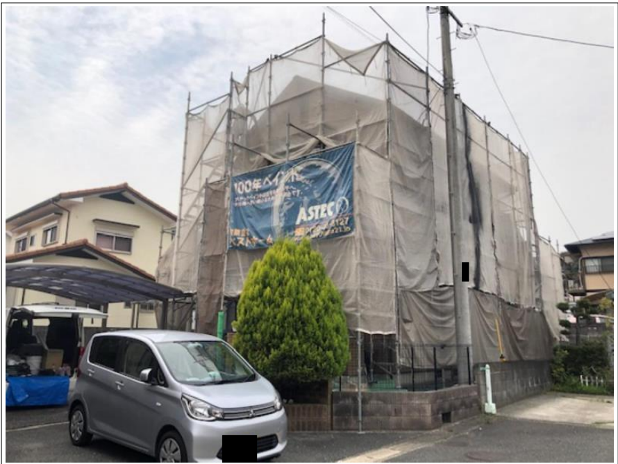
足場組立 完了
