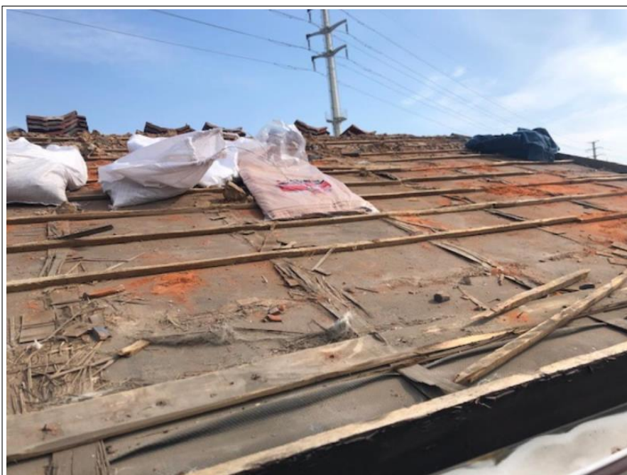
屋根 葺き替え工事
