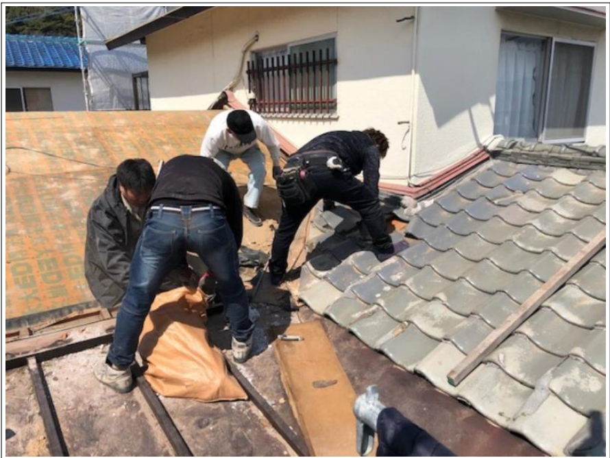
屋根 葺き替え工事
