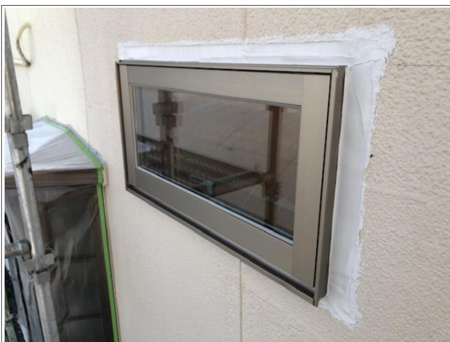
窓枠サッシ取付け工事
