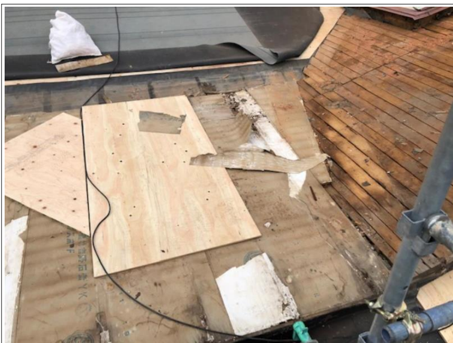
屋根 葺き替え工事
