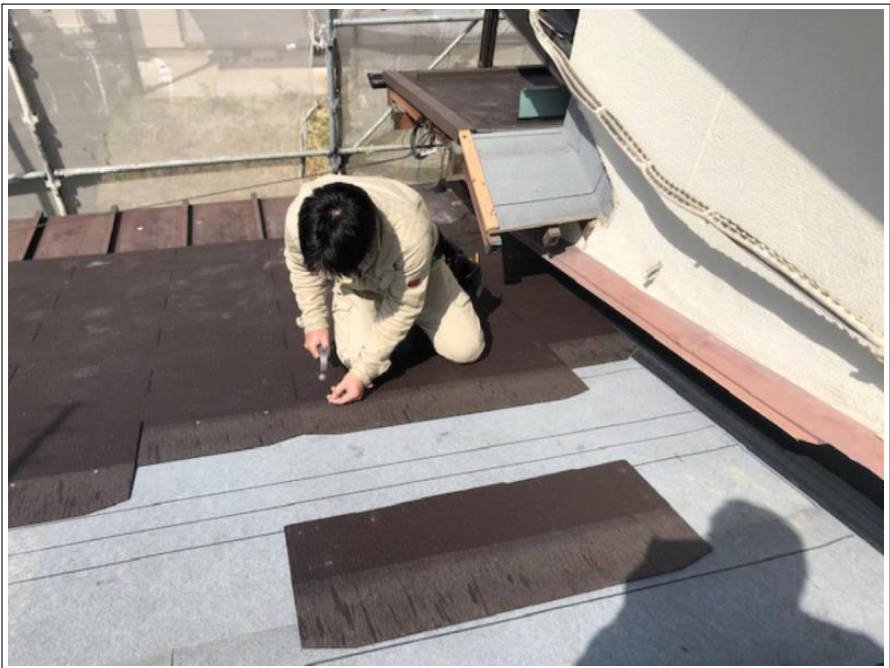
屋根 葺き替え工事
