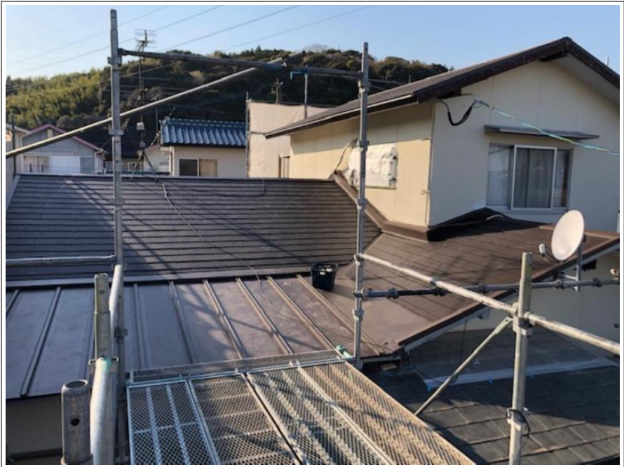
屋根 葺き替え工事
