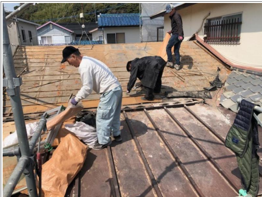
屋根 葺き替え工事
