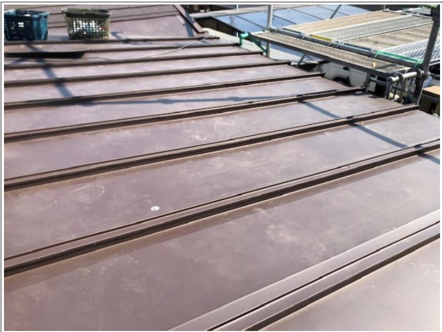
屋根 葺き替え工事
