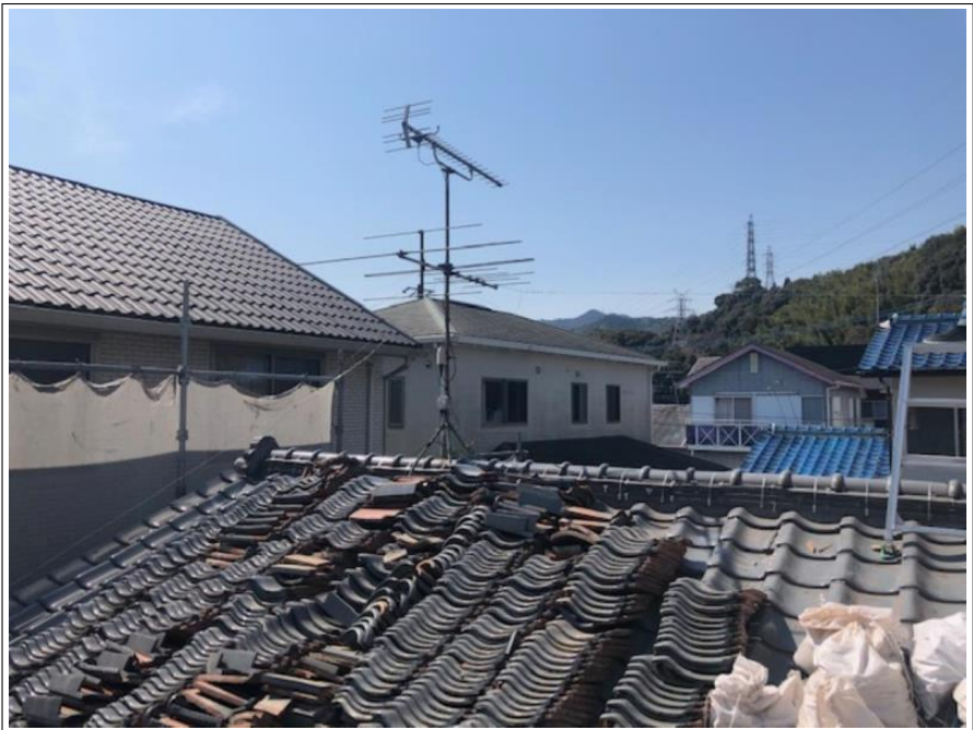
屋根 葺き替え工事
