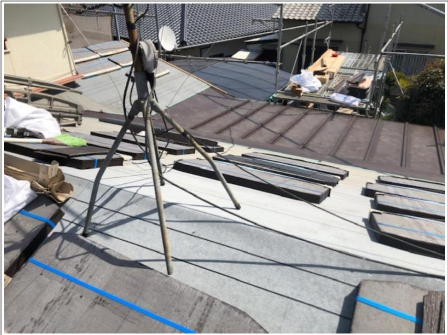
屋根 葺き替え工事
