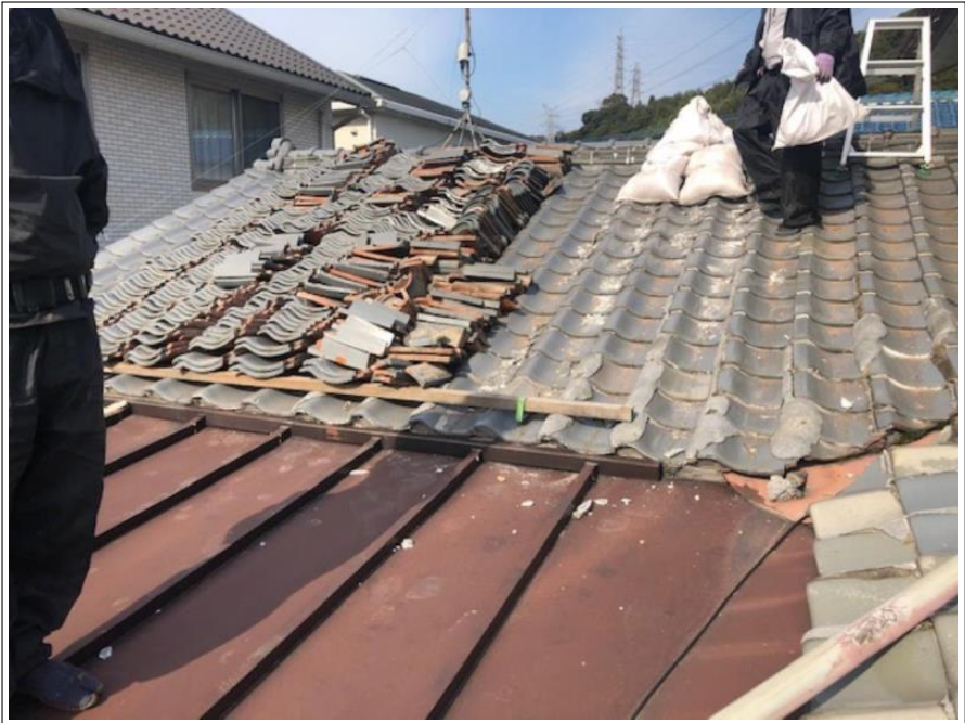
屋根 葺き替え工事
