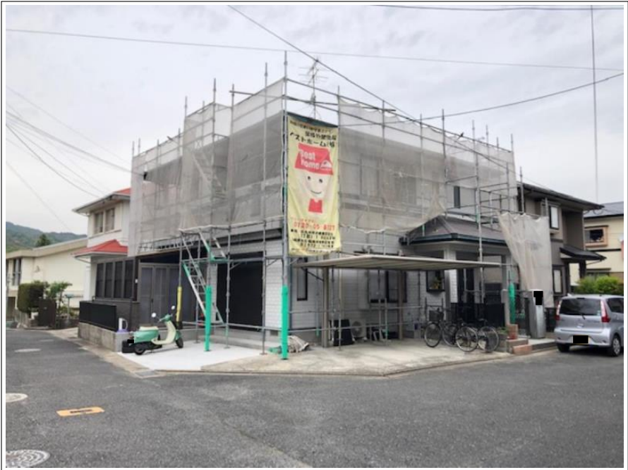
足場組立 完了
