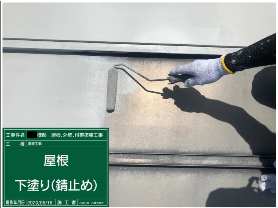
工事件名 様邸 屋根、外壁、付帯塗装工事 工 種 塗装工事 屋根 下塗り(錆止め) 撮影年月日 2020/06/16 施 工 者 ヘストホーム株式会社
