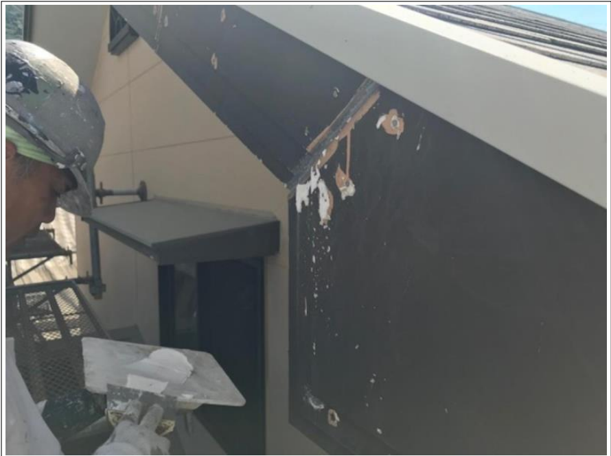
破風板 クラック補修
