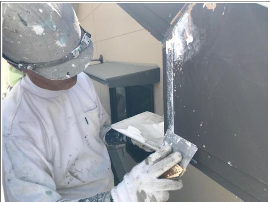
破風板 クラック補修
