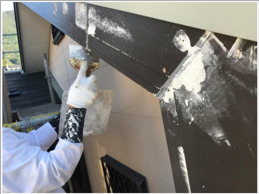
破風板 クラック補修
