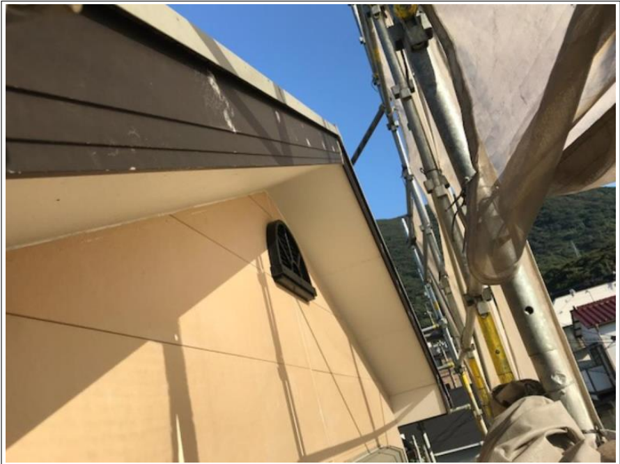
破風板 クラック補修
