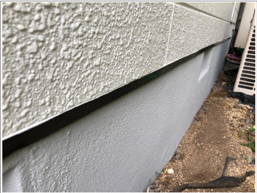
工事件名 ■ 様邸屋根、外壁、その他塗装工事 工 種 塗装工事 土台水切 完了 撮影年月日 2020/08/28 施 工 者 ペストホーム株式会社
