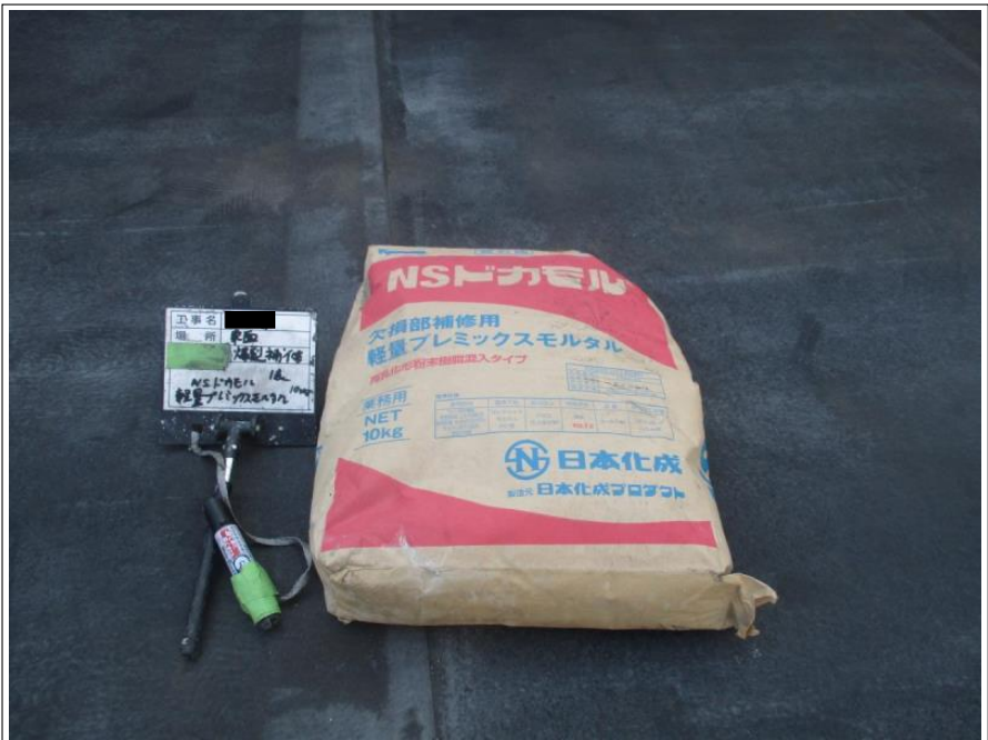
外壁 爆裂部 補修材
