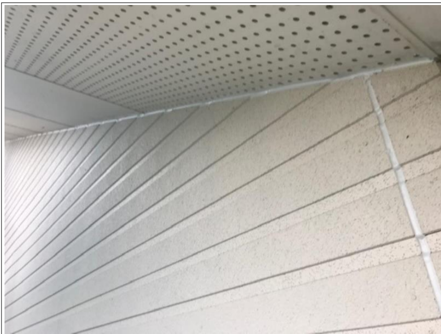
外壁 シーリング 施工完了
