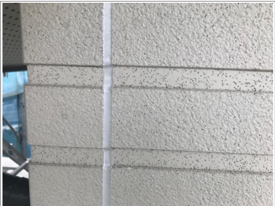
外壁 シーリング 施工完了
