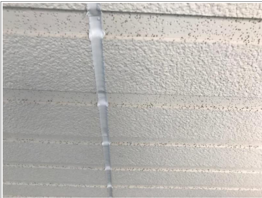
外壁 シーリング 施工完了
