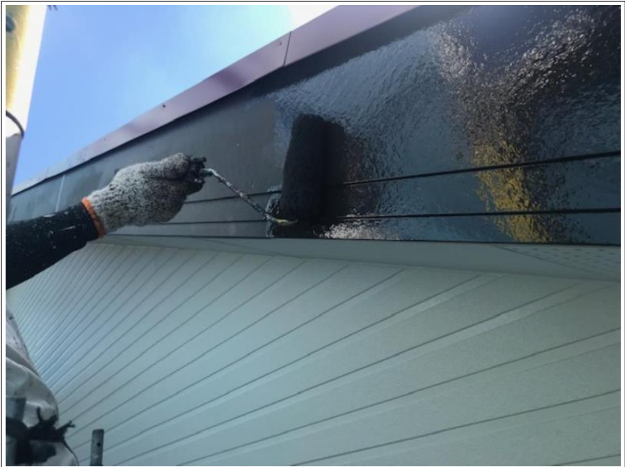
破風板 上塗り1回目
