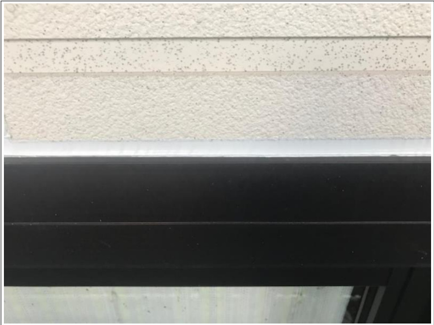
サッシ廻り シーリング 施工完了
