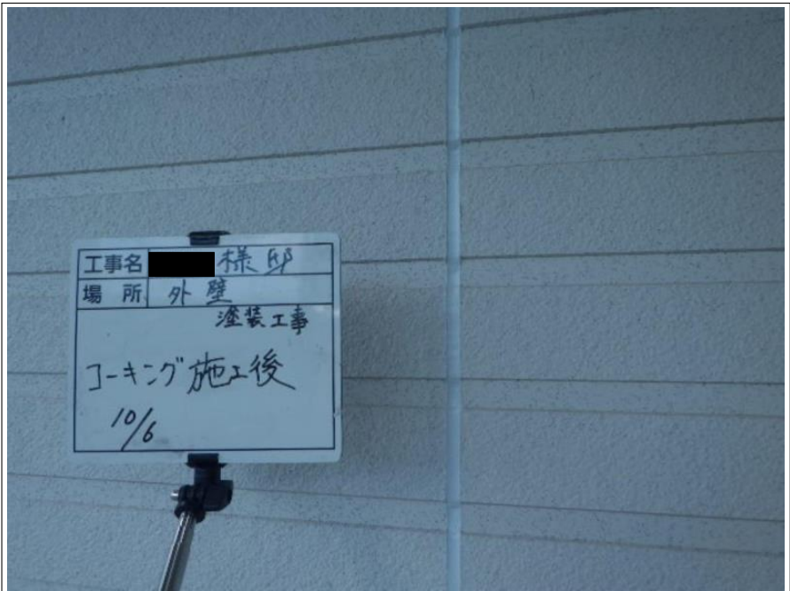
外壁 シーリング 施工完了
