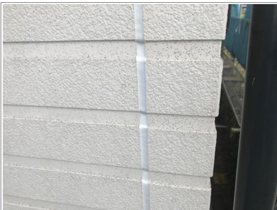
外壁 シーリング 施工完了
