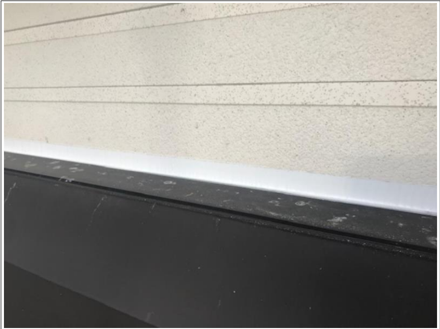
サッシ廻り シーリング 施工完了
