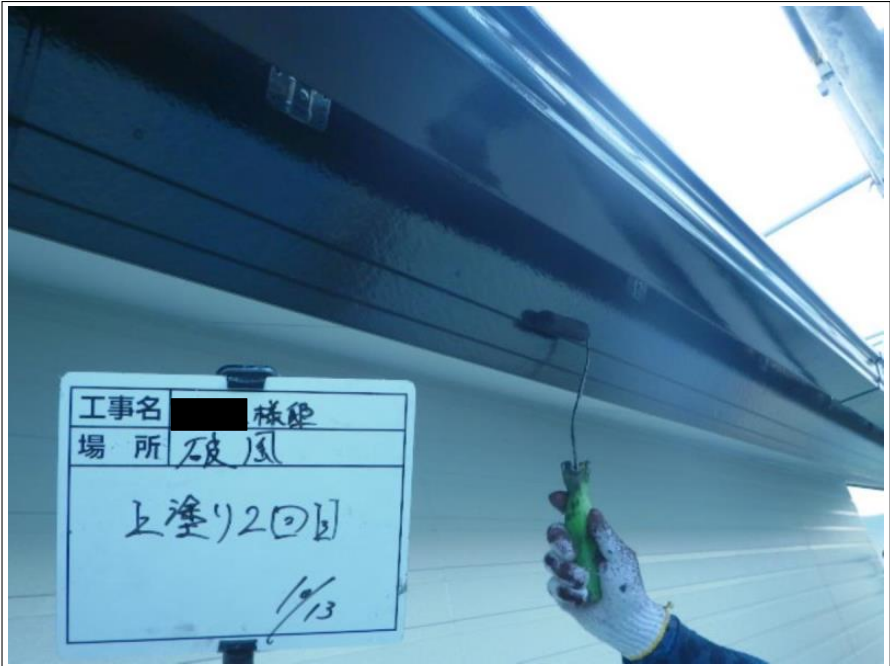
破風板 上塗り2回目
