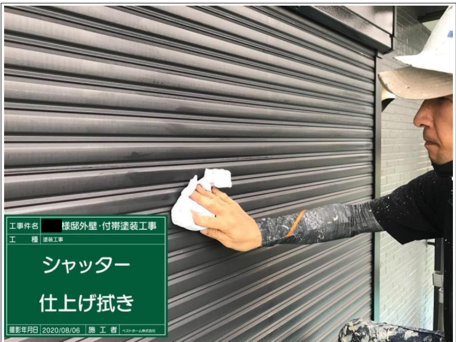
工事件名 様邸外壁・付帯塗装工事 工 種 塗装工事 シャッター 磨き清掃 撮影年月日 2020/08/06 施 工 者 ヘストホーム株式会社
