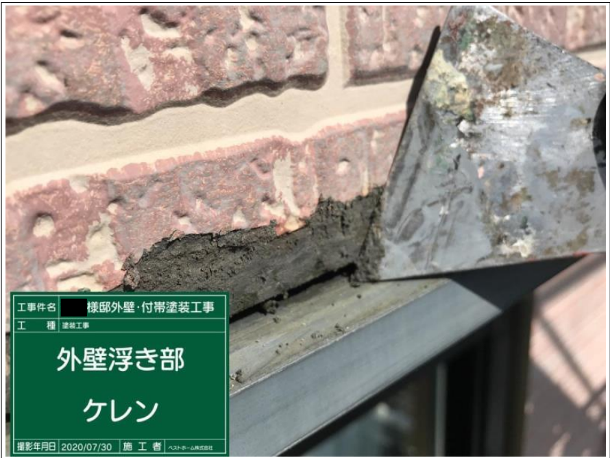
工事件名 様邸外壁・付帯塗装工事 工 種 塗装工事 外壁浮き部 ケレン 撮影年月日 2020/07/30 施 工 者 ペストホーム株式会社
