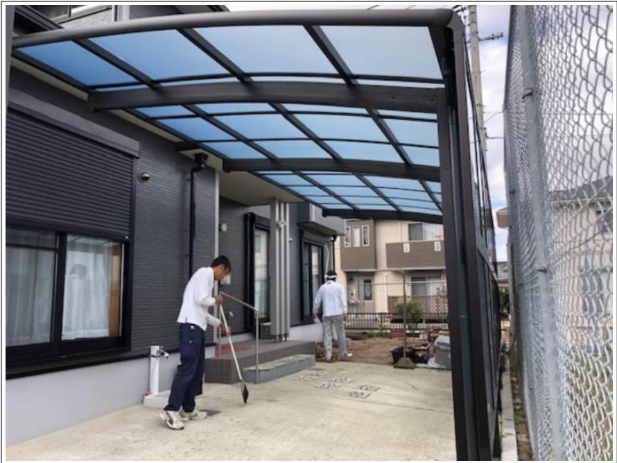
カーポート取付け工事
