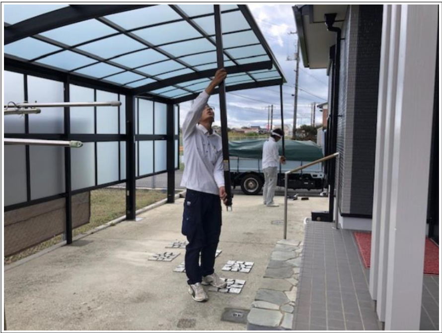
カーポート取付け工事
