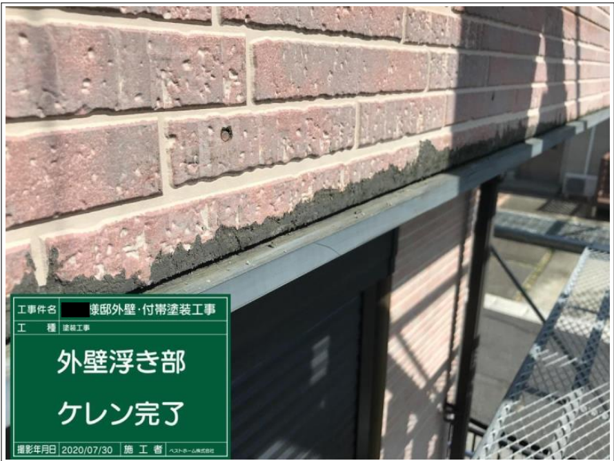
工事件名 様邸外壁・付帯塗装工事 工 種 塗装工事 外壁浮き部 ケレン 撮影年月日 2020/07/30 施 工 者 ペストホーム株式会社
