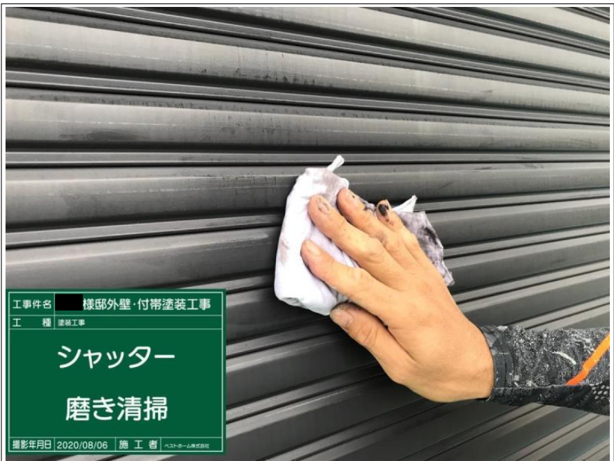
工事件名 様邸外壁・付帯塗装工事 工 種 塗装工事 シャッター 磨き清掃 撮影年月日 2020/08/06 施 工 者 ヘストホーム株式会社
