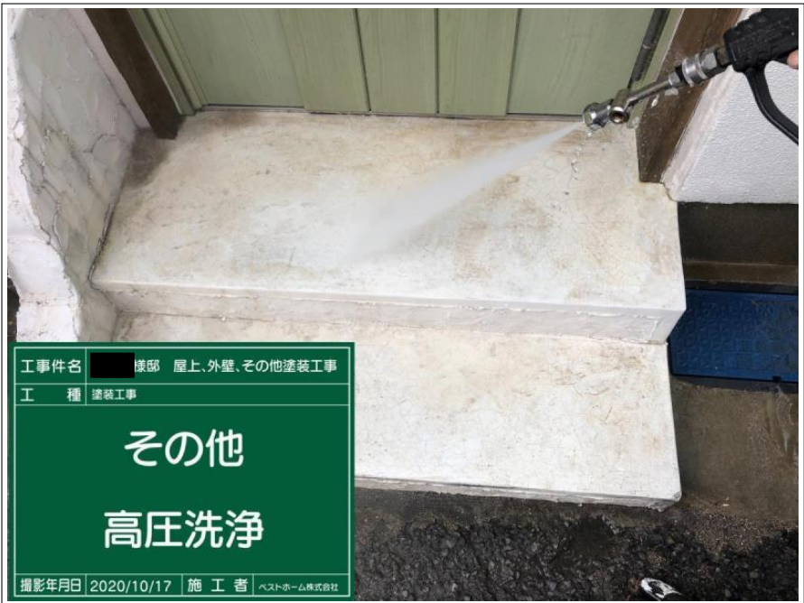
工事件名 ■ 様邸 屋上、外壁、その他塗装工事 工 種 塗装工事 その他 高圧洗浄 撮影年月日 2020/10/17 施 工 者 ベストホーム株式会社
