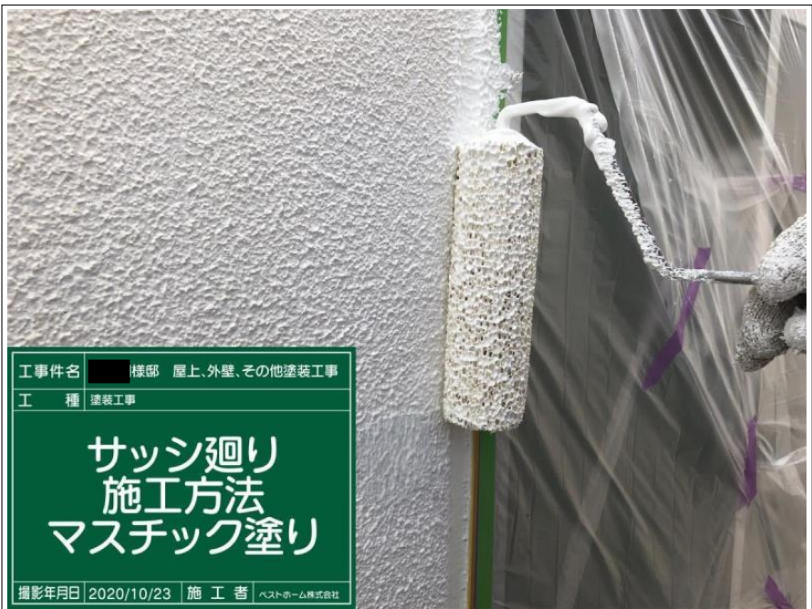
工事件名 様邸 屋上、外壁、その他塗装工事 工 種 塗装工事 メイン外壁 下塗り(マスチック) 撮影年月日 2020/10/23 施 工 者 ベストホーム株式会社
