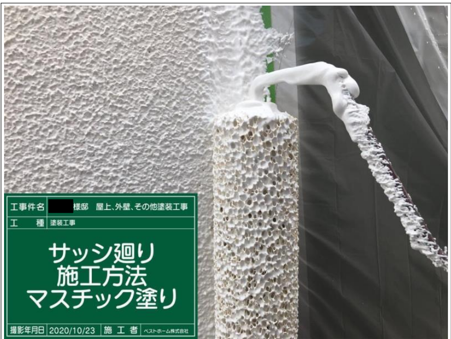
工事件名 様邸 屋上、外壁、その他塗装工事 工 種 塗装工事 サッシ廻り 施工方法 マスチック塗り 撮影年月日 2020/10/23 施 工 者 ベストホーム株式会社
