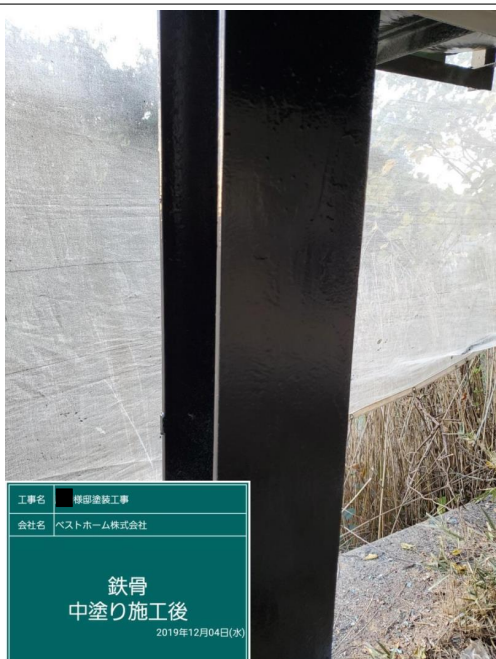
工事名 屋根塗装工事 会社名 ペストホーム株式会社 鉄骨 中塗り施工後 2019年12月04日(水)
