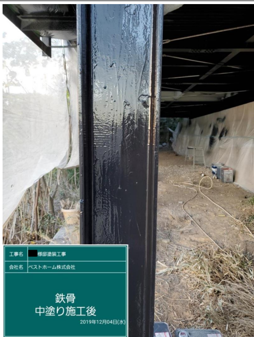
工事名 屋根塗装工事 会社名 ペストホーム株式会社 鉄骨 中塗り施工後 2019年12月04日(水)
