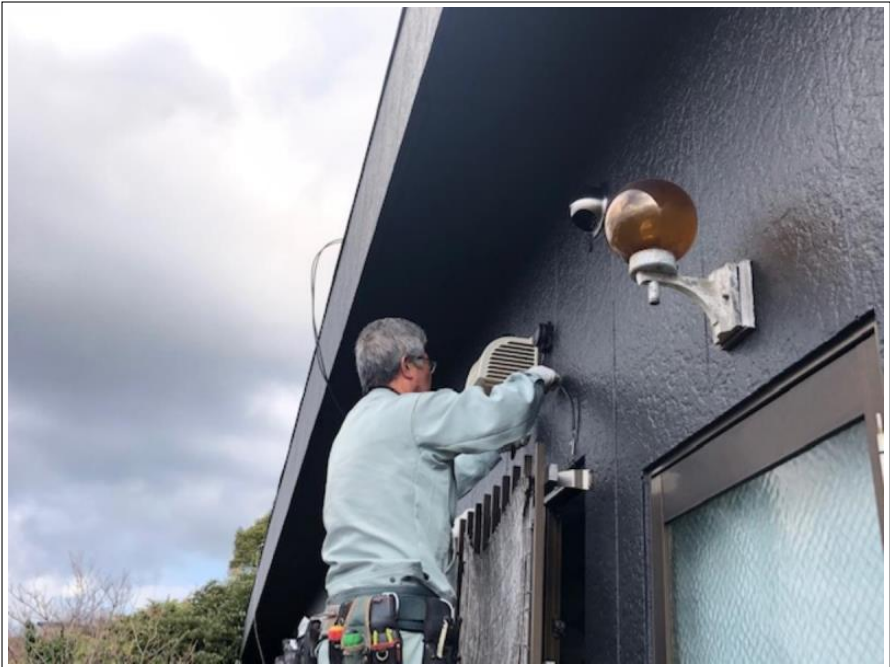
換気扇 取替工事
