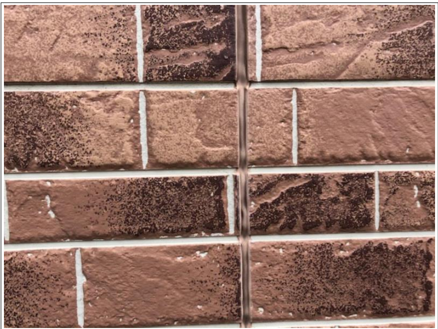
C棟 ボードシーリング劣化部
