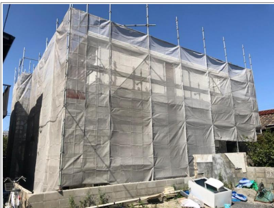
足場組立 完了
