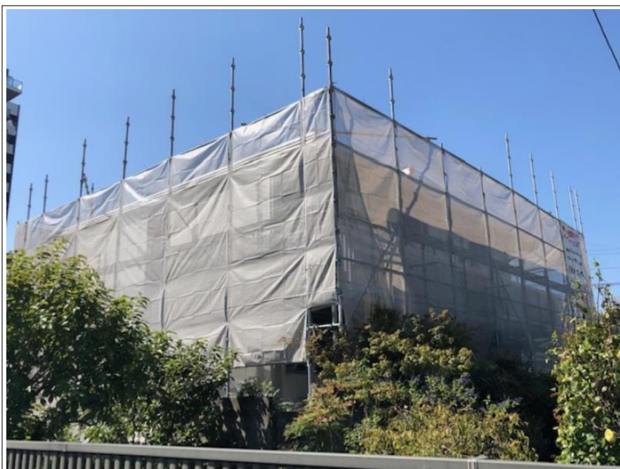
足場組立 完了
