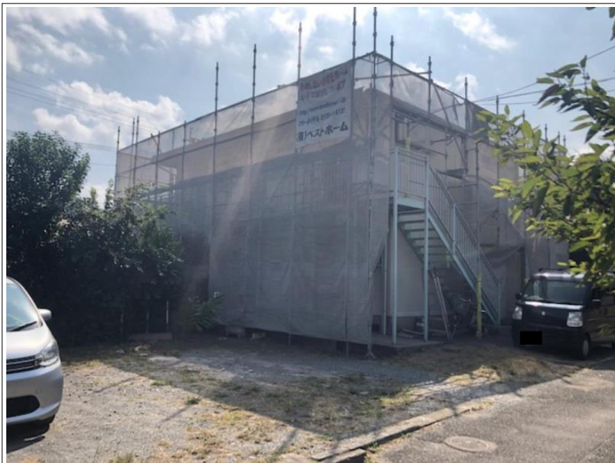
足場組立 完了
