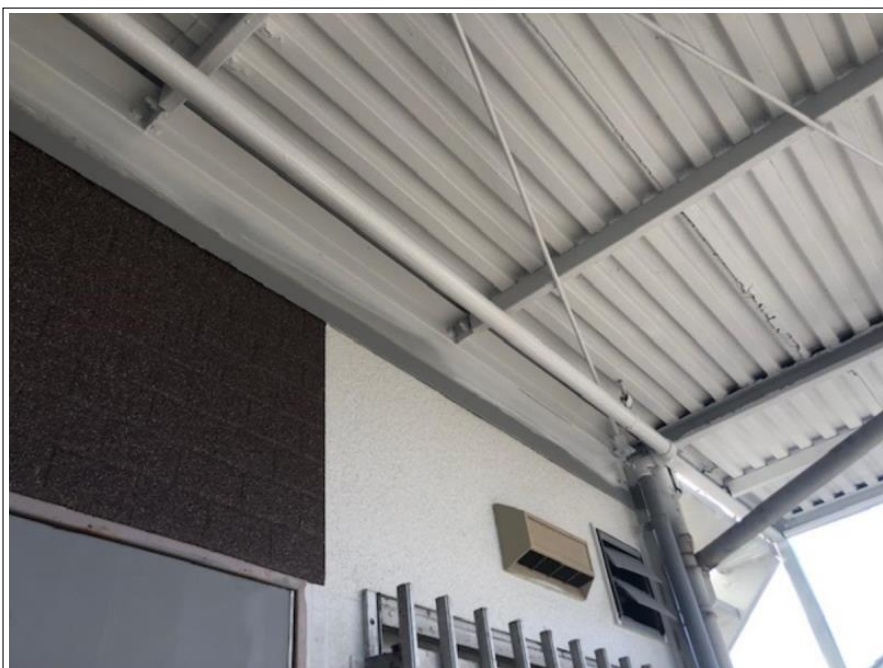
鉄骨階段 上裏
