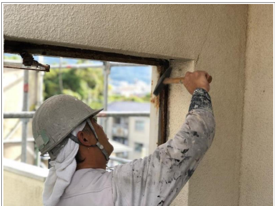
爆裂部下地処理
