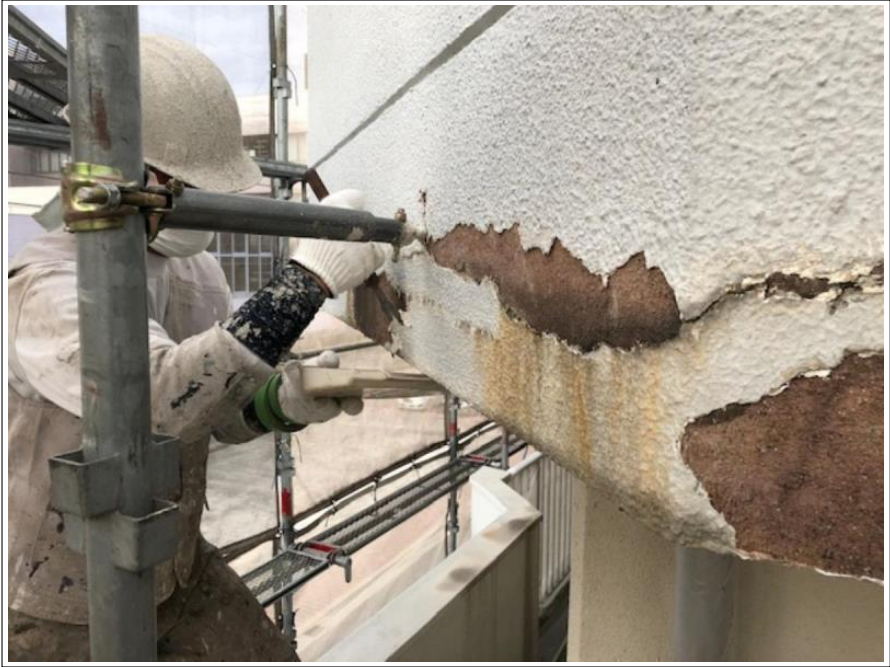
爆裂部下地処理
