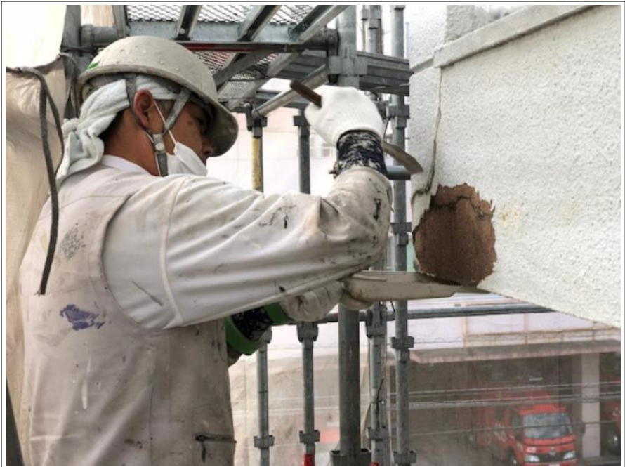
爆裂部下地処理
