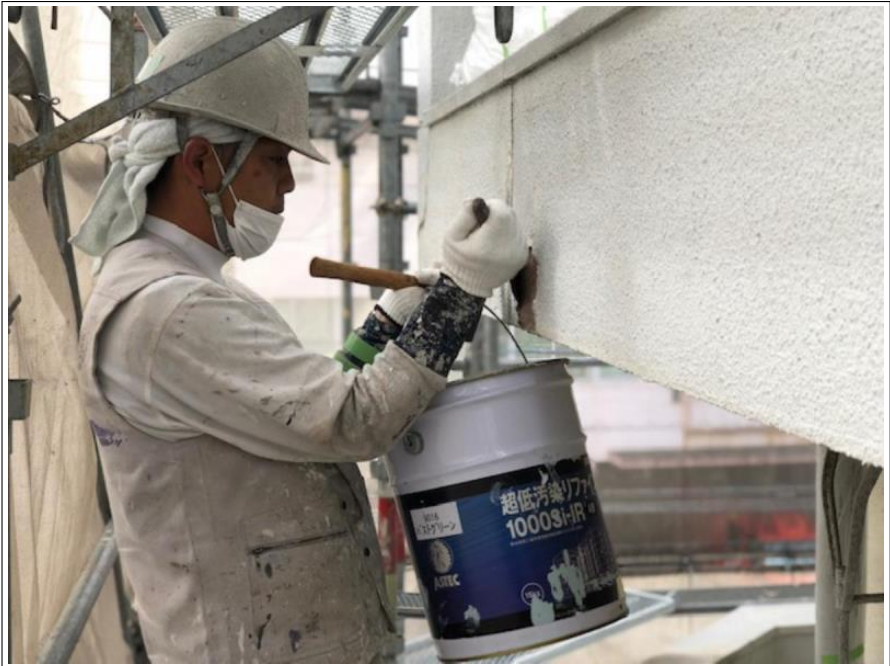
爆裂部下地処理
