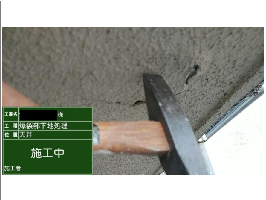
爆裂部下地処理
