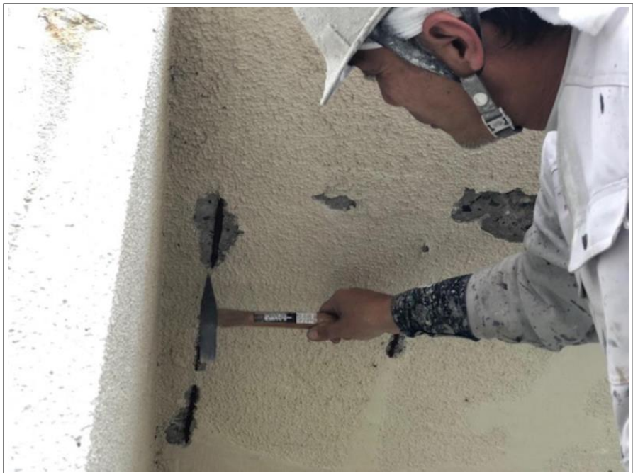
爆裂部下地処理
