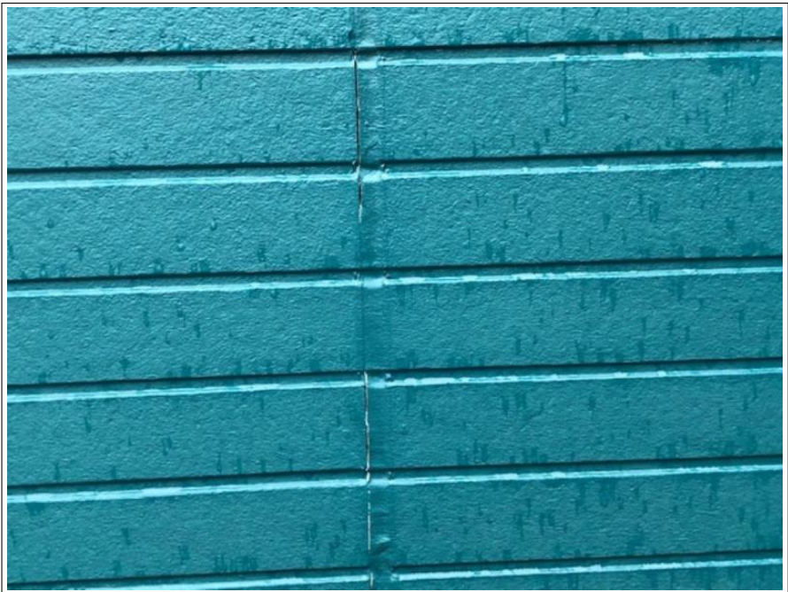
外壁 ボードシーリング部
