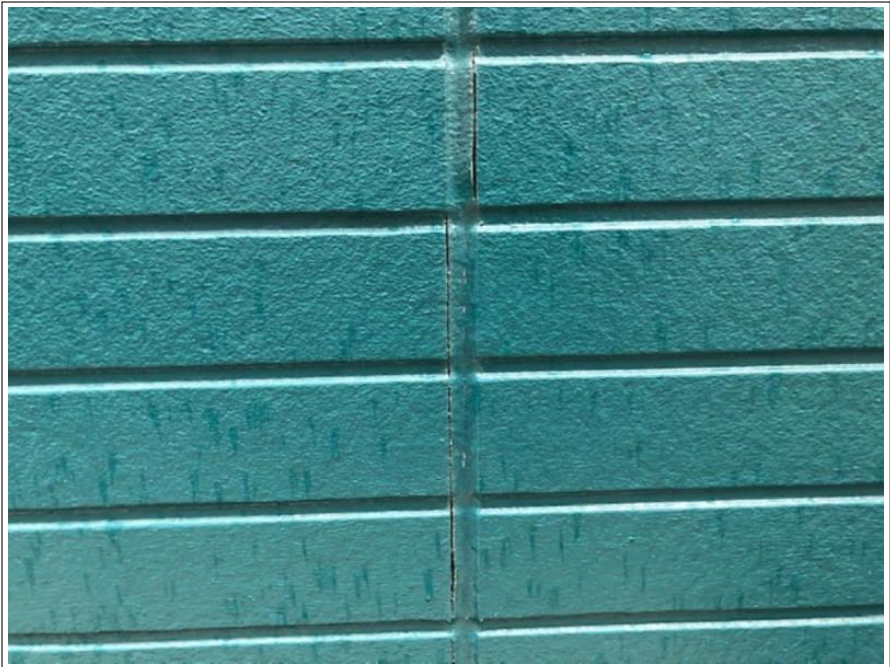
外壁 ボードシーリング部
