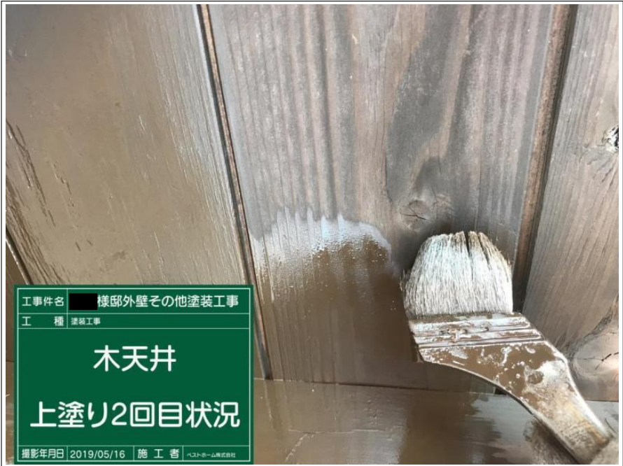
工事件名 様邸外壁その他塗装工事 工 種 塗装工事 木天井 上塗り2回目状況 撮影年月日 2019/05/16 施 工 者 ヘストホーム株式会社
