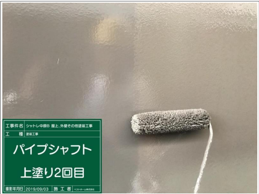
工事件名 シャトレ中原B 屋上、外壁その他塗装工事 工 種 塗装工事 パイプシャフト 上塗り2回目 撮影年月日 2019/09/03 施 工 者 ベストホーム株式会社
