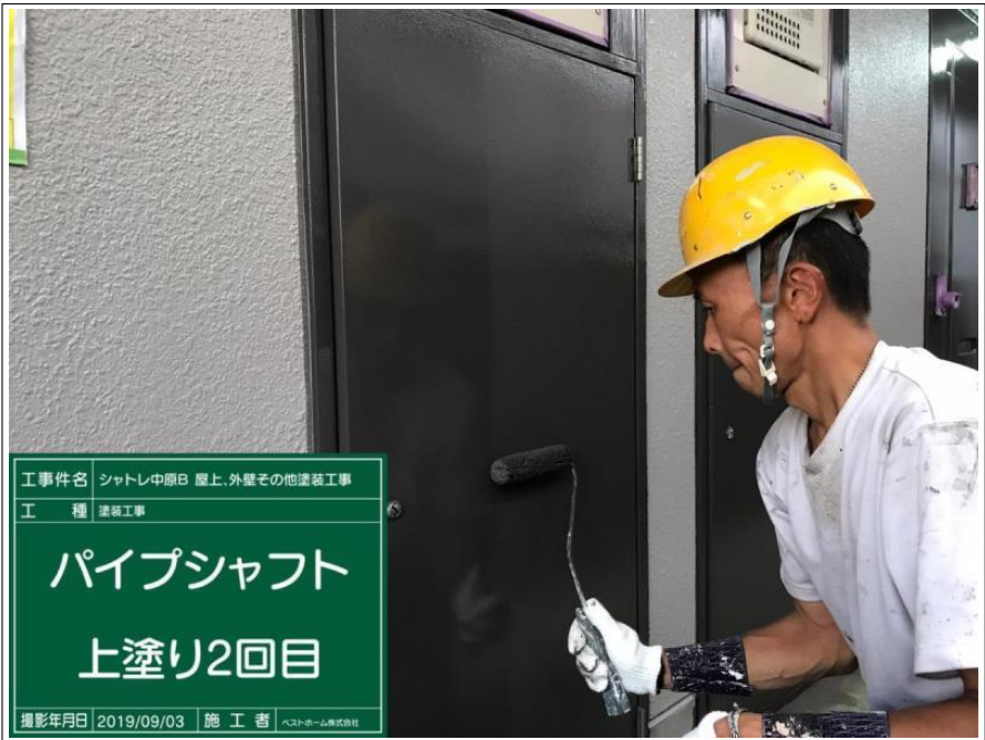
工事件名 シャトレ中原B 屋上、外壁その他塗装工事 工 種 塗装工事 パイプシャフト 上塗り1回目 撮影年月日 2019/09/03 施 工 者 ベストホーム株式会社
