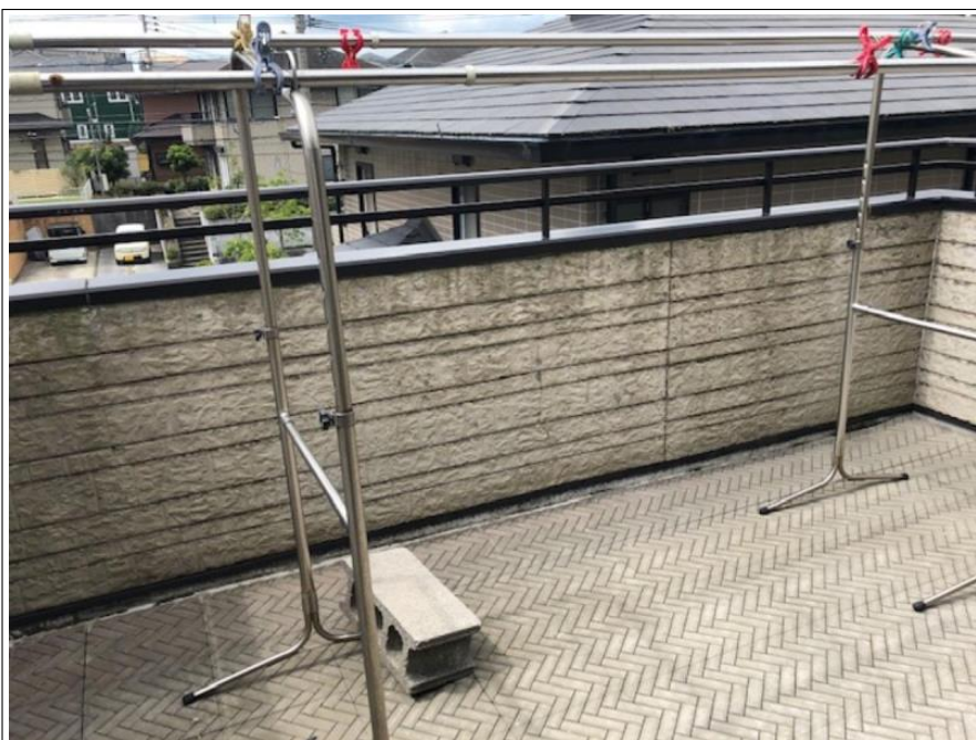
ベランダ 壁 現状
