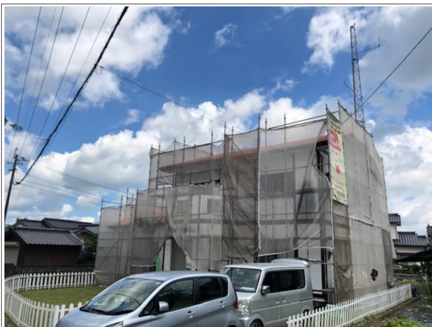
足場組立完了
