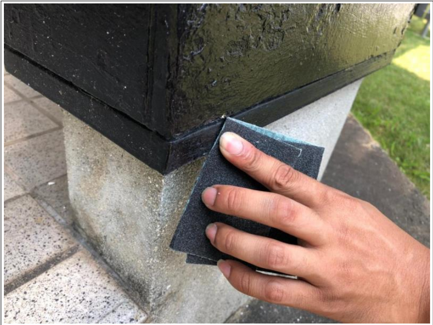
水切り板金部
