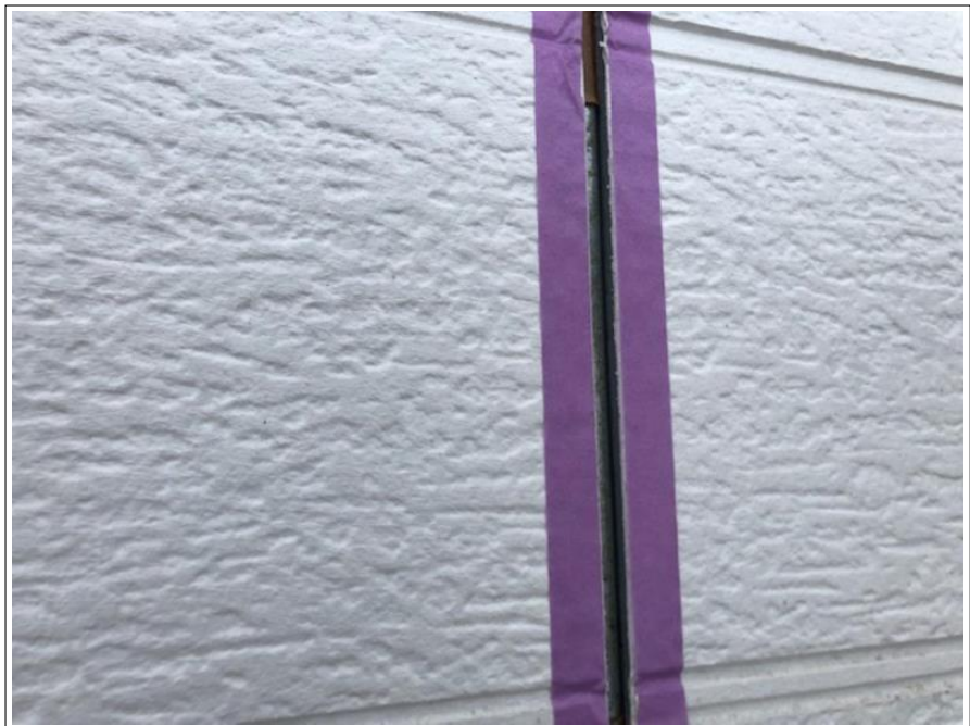
シーリング打ち替え
