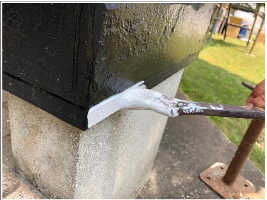
水切り板金部
