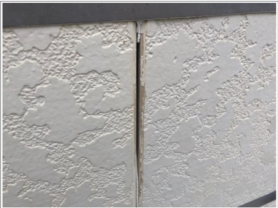
外壁 ボードシーリング劣化部
