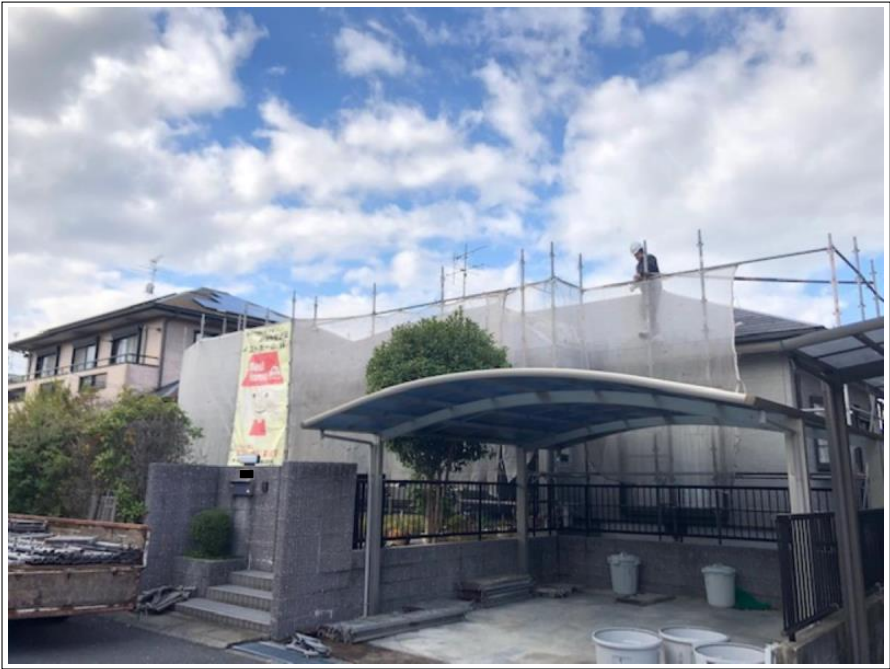
足場組立完了
