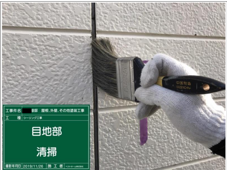
工事件名 ■ 屋根、外壁、その他塗装工事 工 種 シーリング工事 目地部 清掃 撮影年月日 2019/11/26 施 工 者 ヘストホーム株式会社
