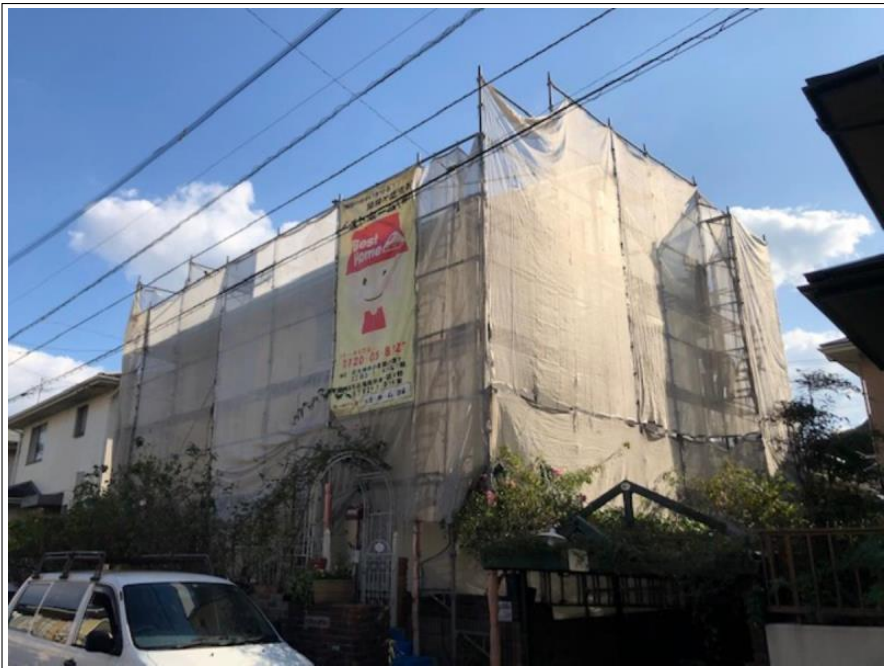
足場組立完了
