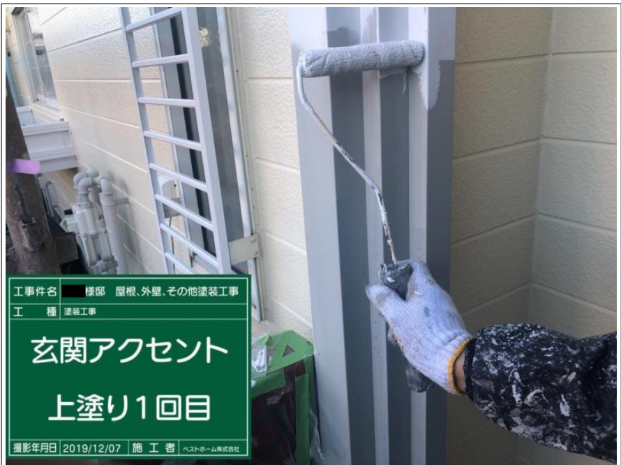
工事件名 棟部 屋根、外壁、その他塗装工事 工 種 塗装工事 玄関アクセント 上塗り1回目 撮影年月日 2019/12/07 施工者 ヘストホーム株式会社
