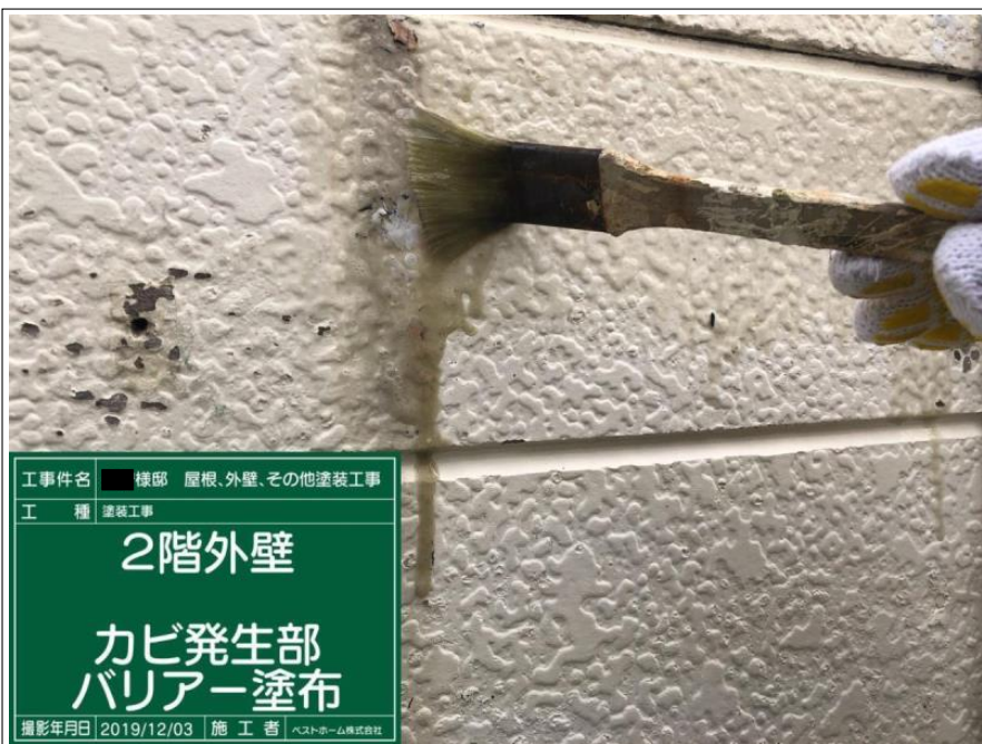
工事件名 ■ 棟部 屋根、外壁、その他塗装工事 工 種 塗装工事 2階外壁 カビ発生部 バリアー塗布 撮影年月日 2019/12/03 施 工 者 ヘストホーム株式会社
