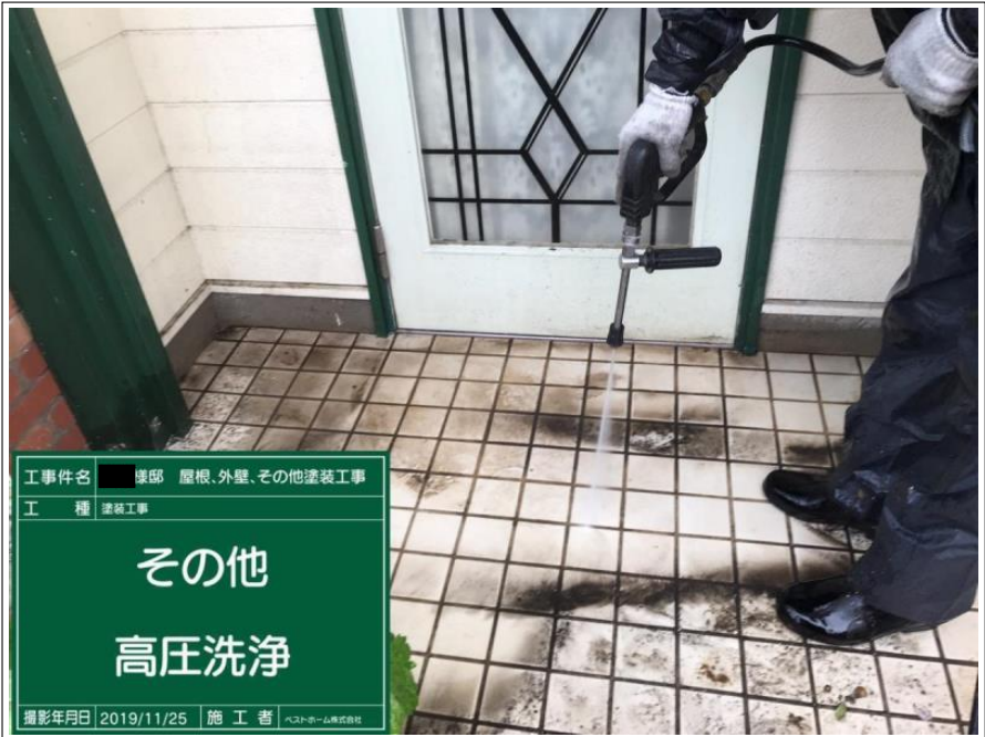
工事件名 様邸 屋根、外壁、その他塗装工事 工 種 塗装工事 基礎 高圧洗浄 撮影年月日 2019/11/25 施 工 者 ヘストホーム株式会社
