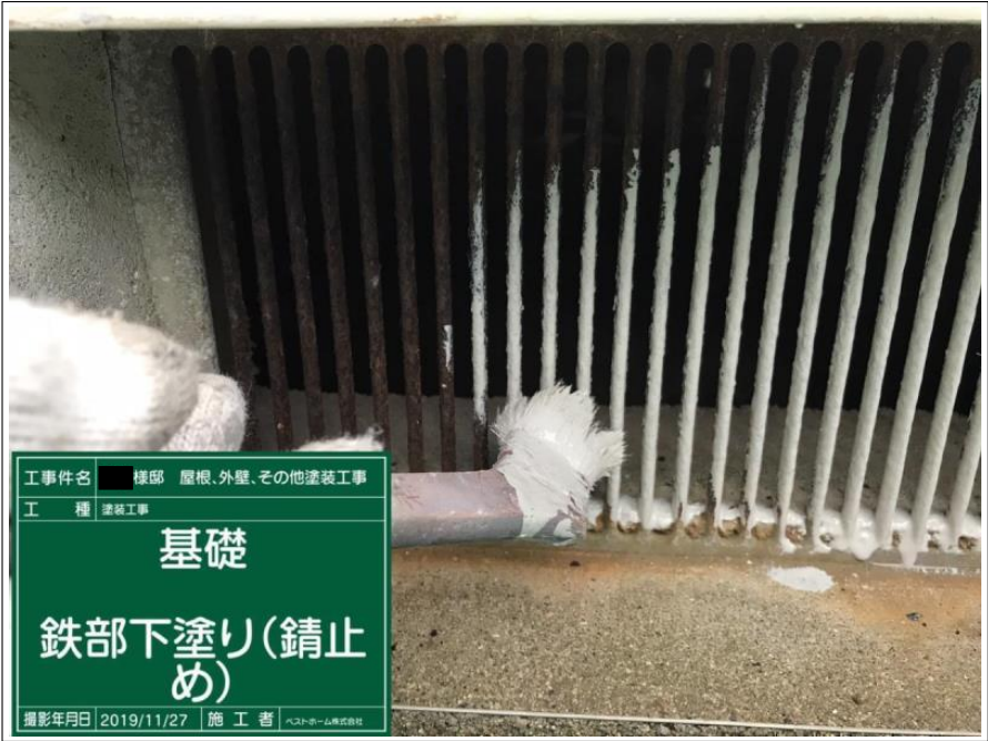
工事件名 様邸 屋根、外壁、その他塗装工事 工 種 塗装工事 基礎 鉄部下塗り(錆止め) 撮影年月日 2019/11/27 | 施 工 者 ヘストホーム株式会社
