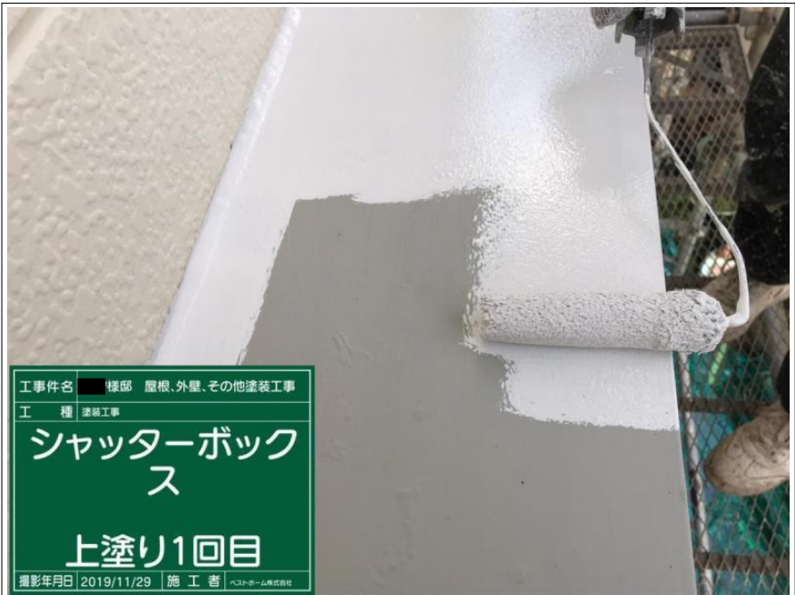
工事件名 ■ 様邸 屋根、外壁、その他塗装工事 工 種 塗装工事 シャッターボックス 上塗り1回目 撮影年月日 2019/11/29 施 工 者 ヘストホーム株式会社
