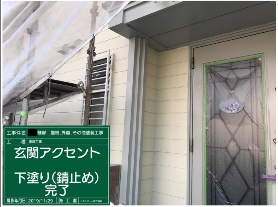
工事件名 様邸 屋根、外壁、その他塗装工事 工 種 塗装工事 玄関アクセント 下塗り(錆止め) 撮影年月日 2019/11/29 施 工 者 ヘストホーム株式会社
