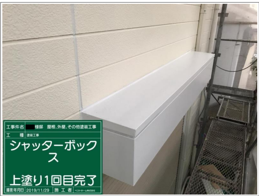
工事件名 ■ 様邸 屋根、外壁、その他塗装工事 工 種 塗装工事 シャッターボックス 上塗り1回目 撮影年月日 2019/11/29 施 工 者 ヘストホーム株式会社
