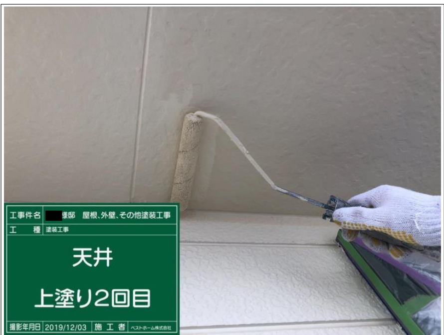
工事件名 棟邸 屋根、外壁、その他塗装工事 工 種 塗装工事 天井 上塗り2回目 撮影年月日 2019/12/03 施 工 者 ヘストホーム株式会社
