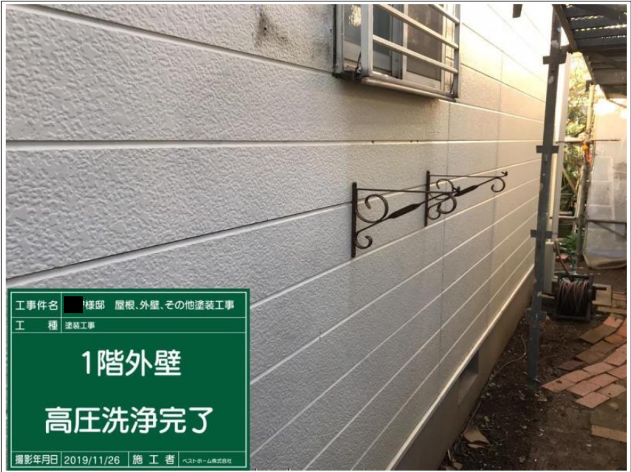
工事件名 様邸 屋根、外壁、その他塗装工事 工 種 塗装工事 1階外壁 高圧洗浄 撮影年月日 2019/11/25 施 工 者 ヘストホーム株式会社
