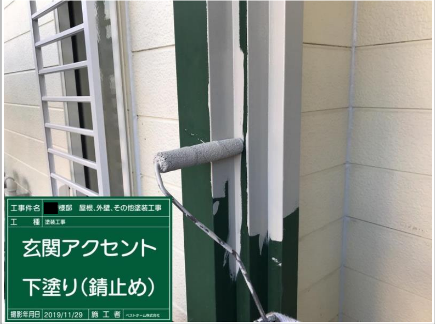
工事件名 様邸 屋根、外壁、その他塗装工事 工 種 塗装工事 玄関アクセント 下塗り(錆止め) 撮影年月日 2019/11/29 施 工 者 ヘストホーム株式会社
