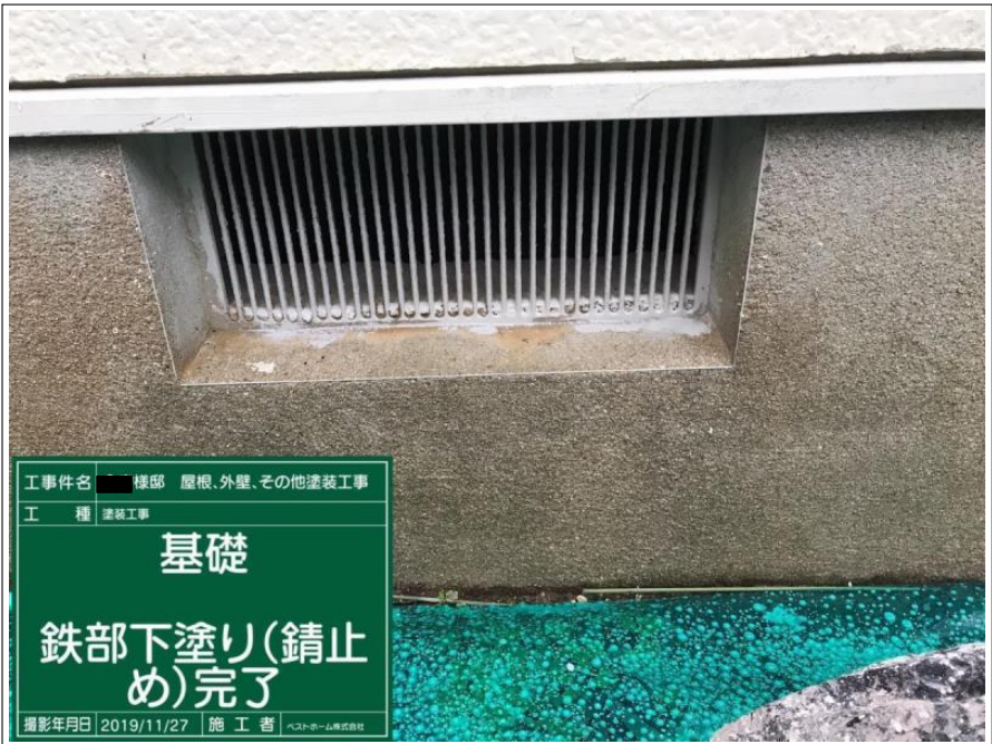
工事件名 様邸 屋根、外壁、その他塗装工事 工 種 塗装工事 基礎 鉄部下塗り(錆止め) 撮影年月日 2019/11/27 | 施 工 者 ヘストホーム株式会社
