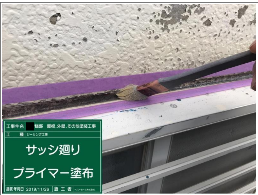
工事件名 様邸 屋根、外壁、その他塗装工事 工 種 シーリング工事 サッシ廻り プライマー塗布 撮影年月日 2019/11/26 施 工 者 ヘストホーム株式会社
