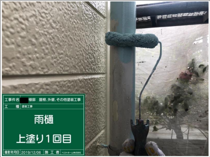
工 事 件 名 棟 部 屋 根、外 壁、其 他 塗 装 工 事 工 種 塗 装 工 事 雨樋 上塗り1回目 撮 影 年 月 日 2019/12/06 施 工 者 ヘ ス ト ホ ー ム 株 式 有 限 公 司
