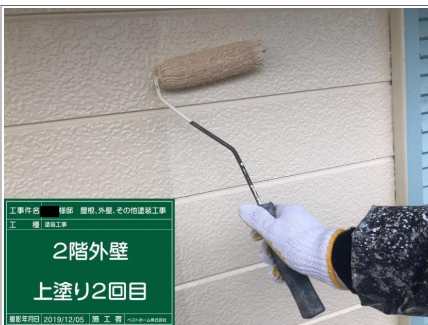
工事件名 棟部 屋根、外壁、その他塗装工事 工 種 塗装工事 2階外壁 上塗り2回目 撮影年月日 2019/12/05 施 工 者 ベストホーム株式会社
