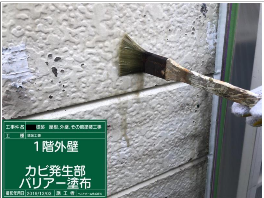
工事件名 棟部 屋根、外壁、その他塗装工事 工種 塗装工事 1階外壁 カビ発生部 バリアー塗布 撮影年月日 2019/12/03 施工者 ヘストホーム株式会社
