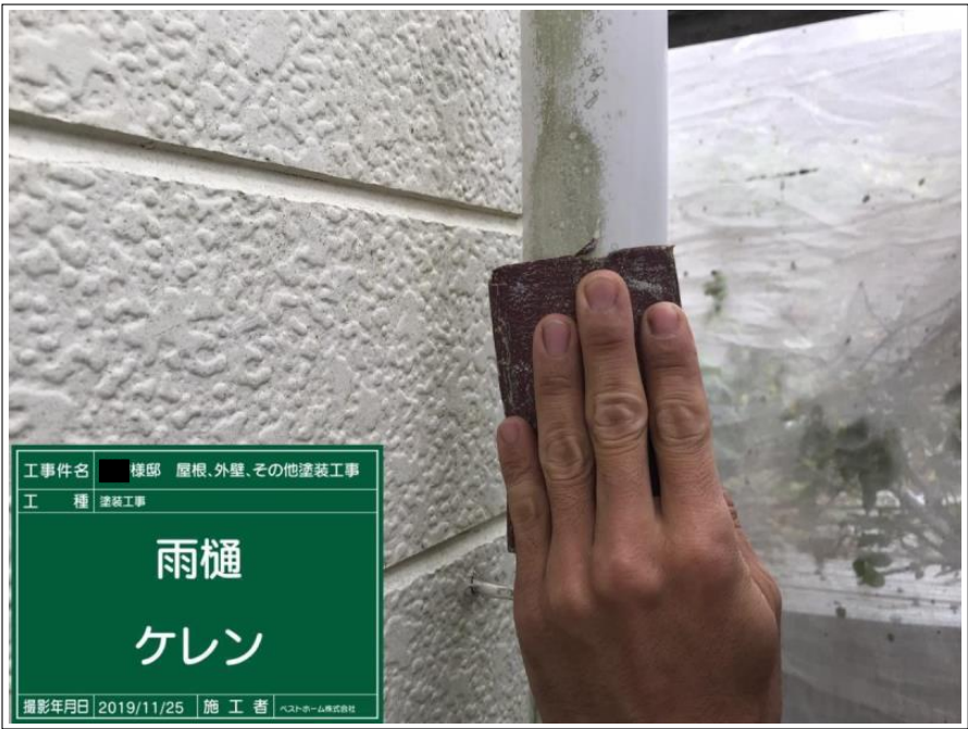
工事件名 ■ 様邸 屋根、外壁、その他塗装工事 工 種 塗装工事 雨樋 ケレン 撮影年月日 2019/11/25 施 工 者 ヘストホーム株式会社
