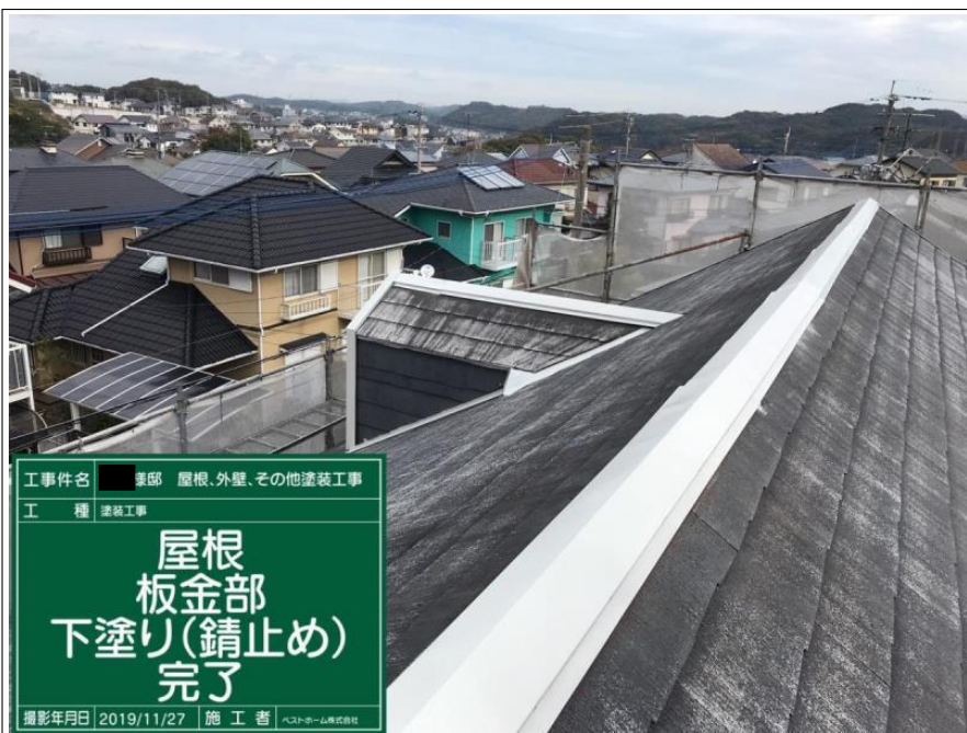
工事件名 様邸 屋根、外壁、その他塗装工事 工 種 塗装工事 屋根 板金部 下塗り(錆止め) 撮影年月日 2019/11/27 施 工 者 ヘストホーム株式会社
