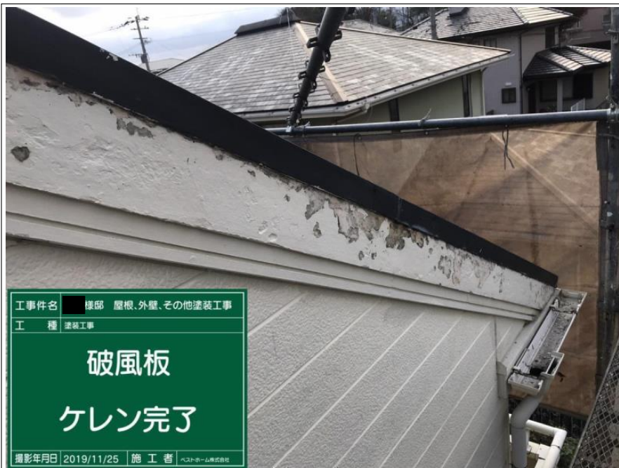
工事件名 様邸 屋根、外壁、その他塗装工事 工種 塗装工事 破風板 ケレン 撮影年月日 2019/11/25 施工者 ヘストホーム株式会社
