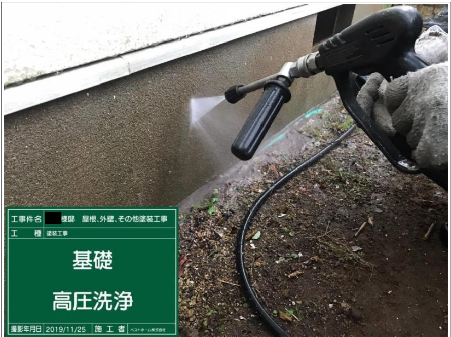
工事件名 様邸 屋根、外壁、その他塗装工事 工 種 塗装工事 基礎 高圧洗浄 撮影年月日 2019/11/25 施 工 者 ヘストホーム株式会社
