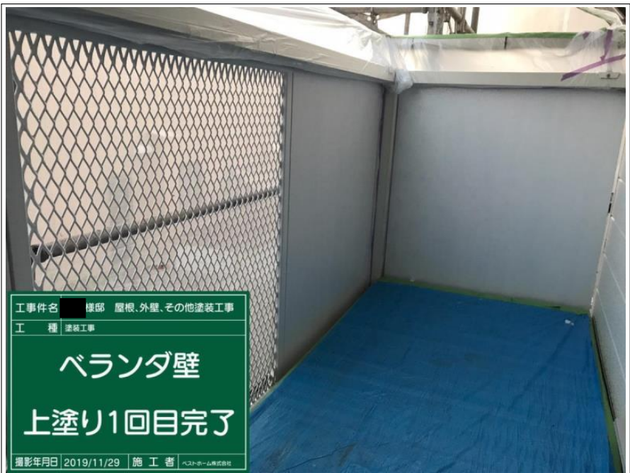
工事件名 様邸 屋根、外壁、その他塗装工事 工 種 塗装工事 ベランダ壁 上塗り1回目 撮影年月日 2019/11/29 施 工 者 ヘストホーム株式会社
