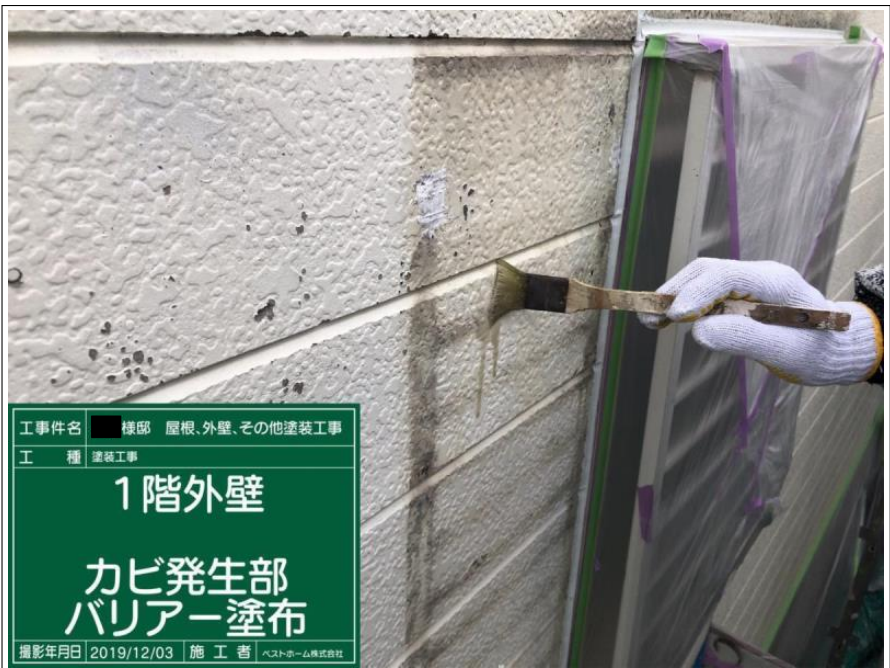
工事件名 棟部 屋根、外壁、その他塗装工事 工種 塗装工事 1階外壁 カビ発生部 着工前 撮影年月日 2019/12/03 施工者 ヘストホーム株式会社
