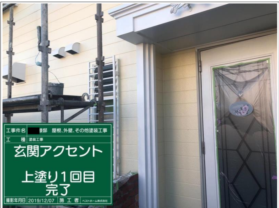
工事件名 棟部 屋根、外壁、その他塗装工事 工 種 塗装工事 玄関アクセント 上塗り1回目 撮影年月日 2019/12/07 施工者 ヘストホーム株式会社
