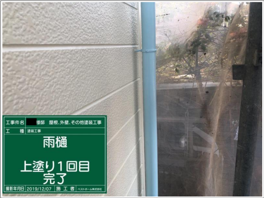
工 事 件 名 棟 部 屋 根、外 壁、其 他 塗 装 工 事 工 種 塗 装 工 事 雨樋 上塗り1回目 撮 影 年 月 日 2019/12/06 施 工 者 ヘ ス ト ホ ー ム 株 式 有 限 公 司
