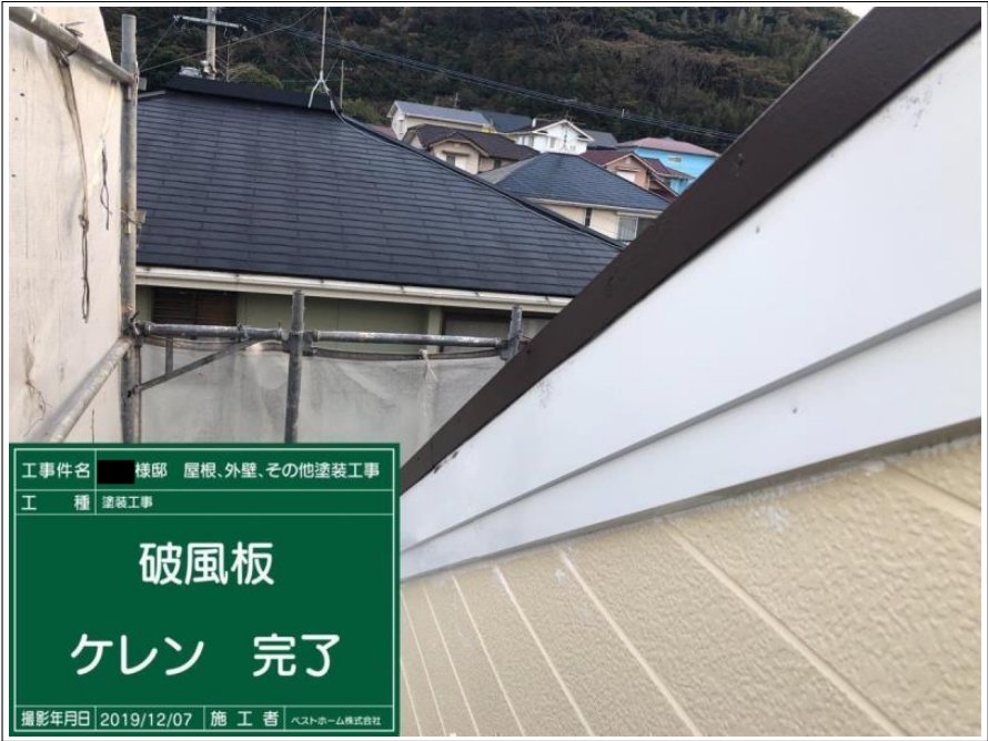
工 事 名 棟 部 屋根、外壁、その他塗装工事 工 種 塗装工事 破風板 ケレン 撮影年月日 2019/12/07 施 工 者 ヘストホーム株式会社
