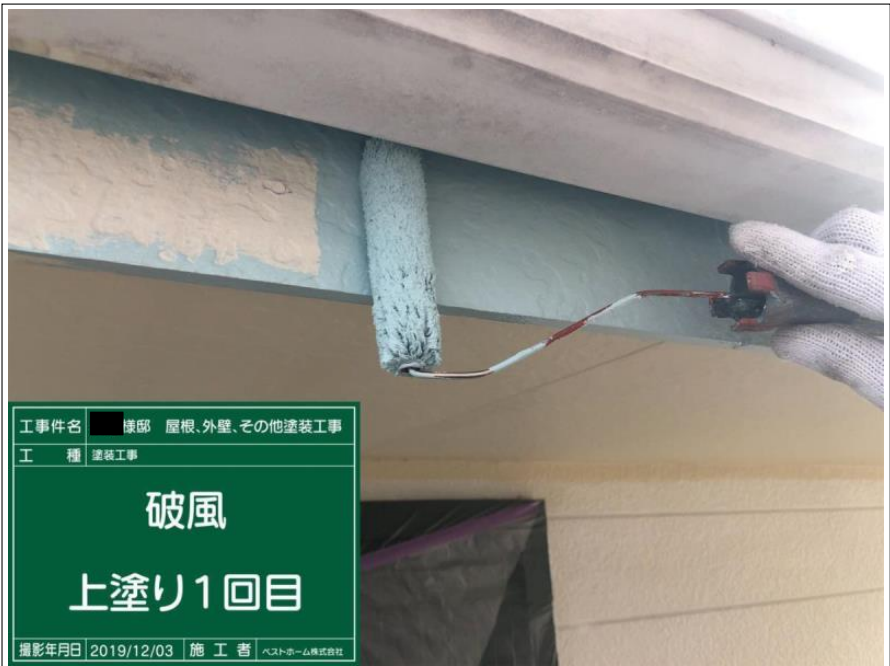
工 事 件 名 棟 部 屋 根、外 壁、其 他 塗 装 工 事 工 種 塗 装 工 事 破風 上塗り1回目 撮 影 年 月 日 2019/12/03 施 工 者 ヘ ス ト ホ ー ム 株 式 有 限 公 司
