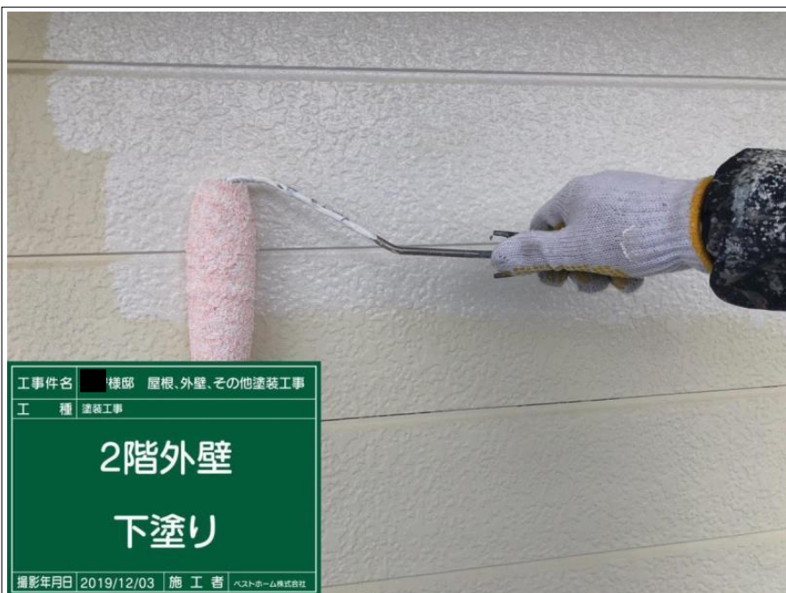
工事件名 棟部 屋根、外壁、その他塗装工事 工 種 塗装工事 2階外壁 下塗り 撮影年月日 2019/12/03 施 工 者 ヘストホーム株式会社
