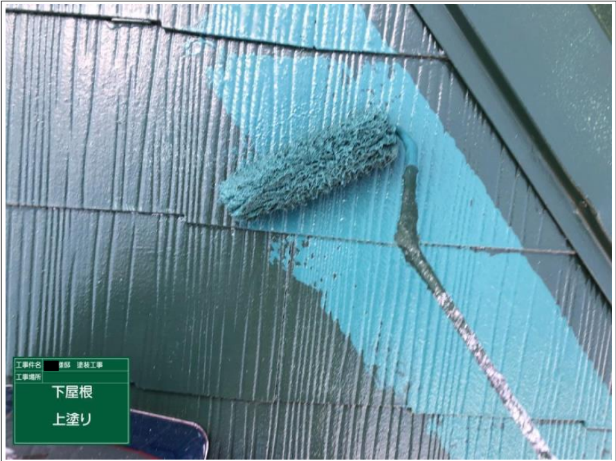
工事件名 緑部 塗装工事 工事場所 下屋根 上塗り
