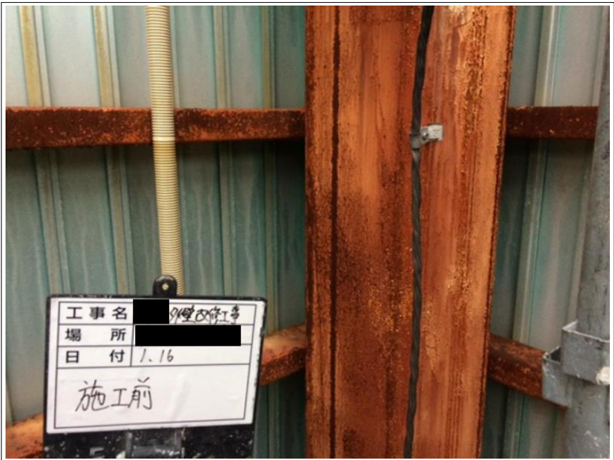
看板塔屋 鉄骨部
