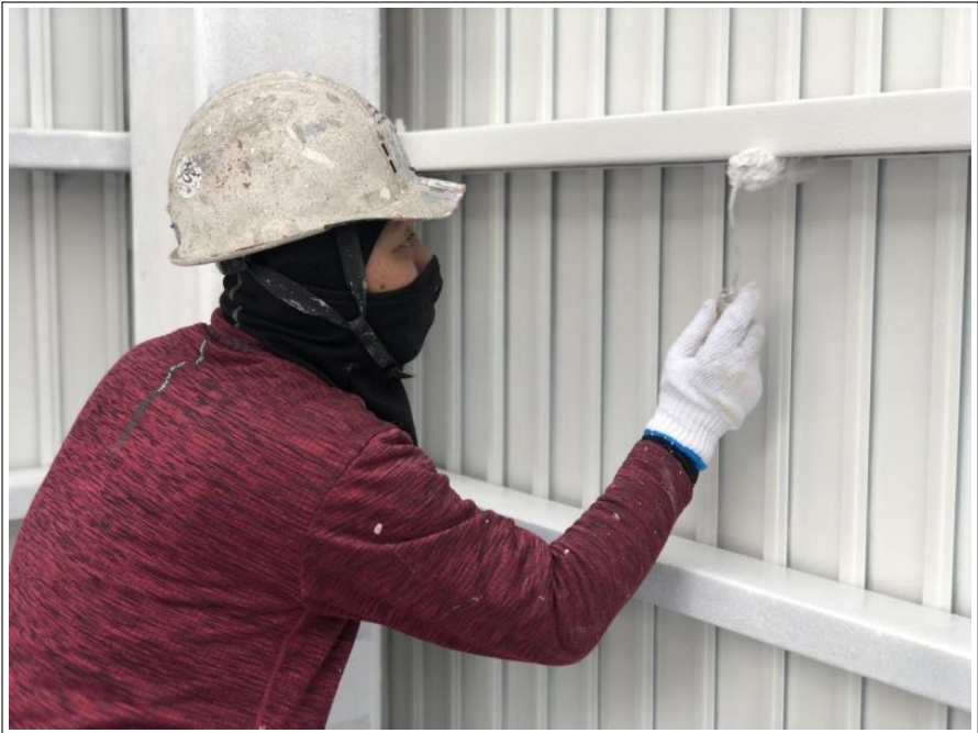
看板塔屋 鉄骨部
