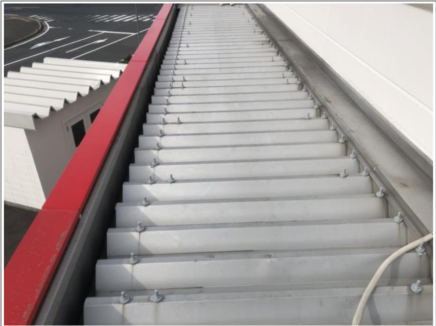
底屋根 ボルトキャップ取付け
