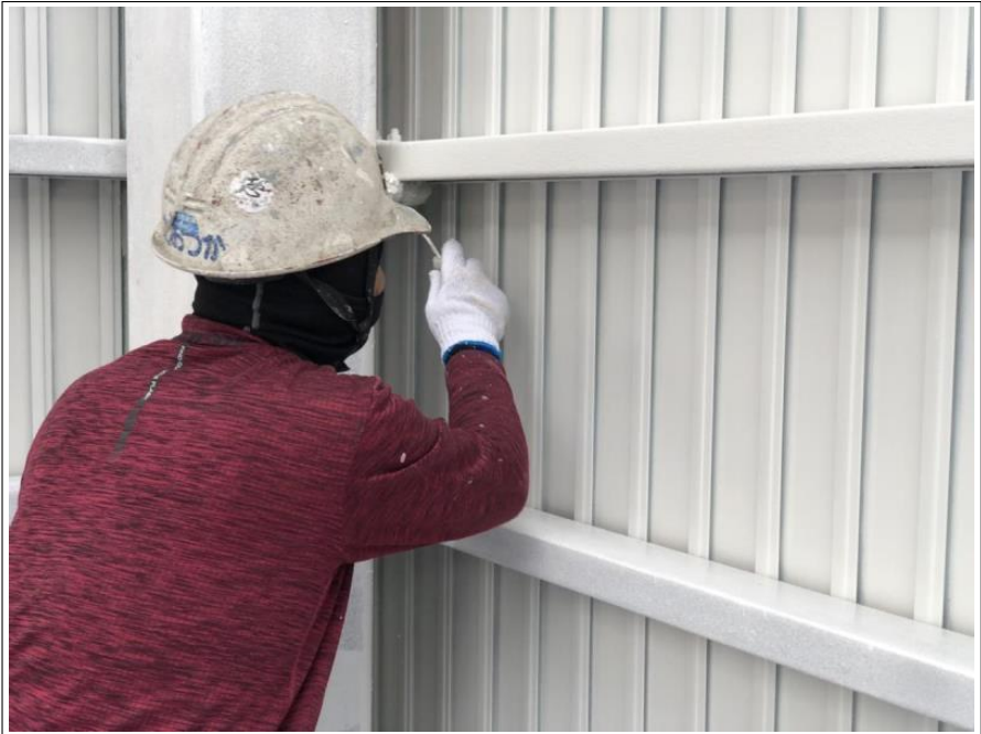
看板塔屋 鉄骨部
