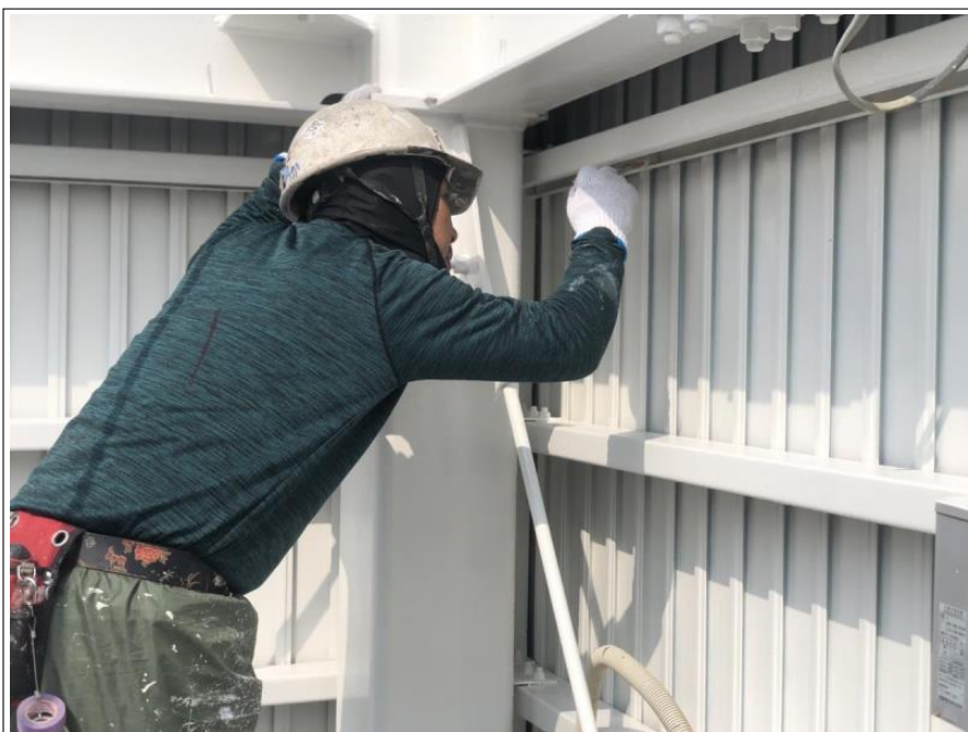
看板塔屋 鉄骨部
