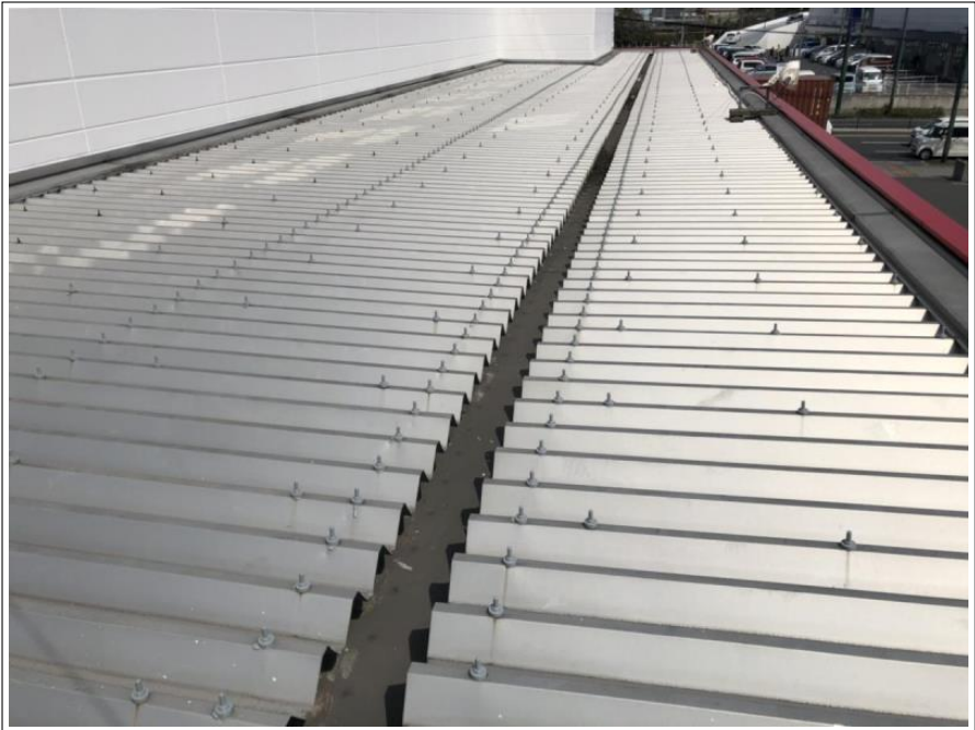
底屋根 ボルトキャップ取付け
