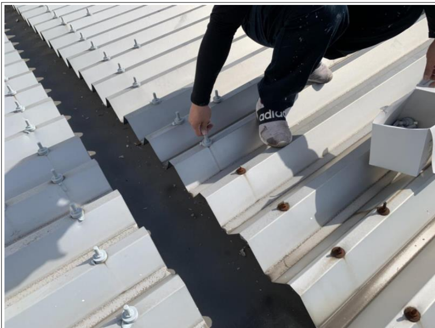
底屋根 ボルトキャップ取付け
