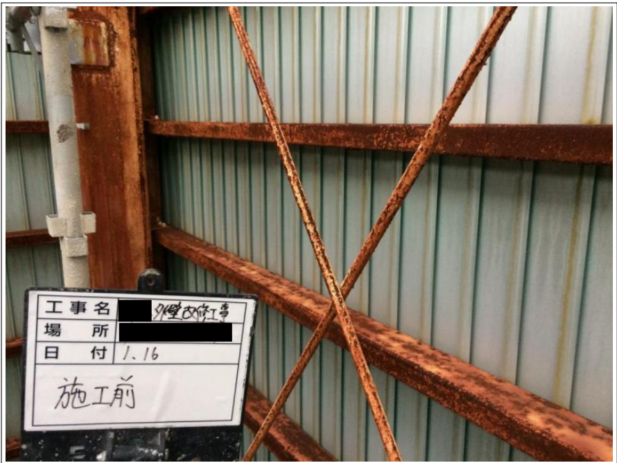
看板塔屋 鉄骨部
