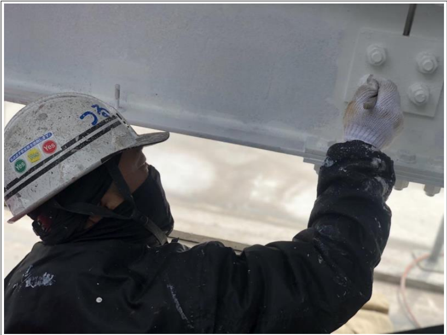
看板塔屋 鉄骨部
