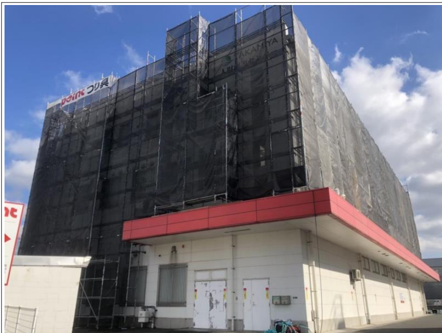
足場組立 完了
