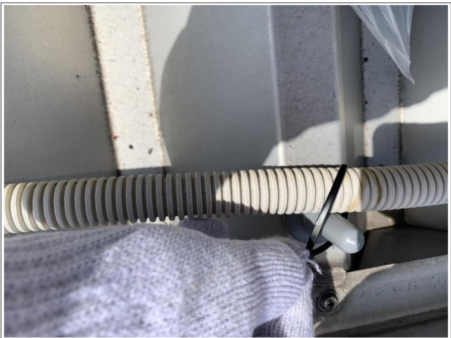
底屋根 ボルトキャップ取付け
