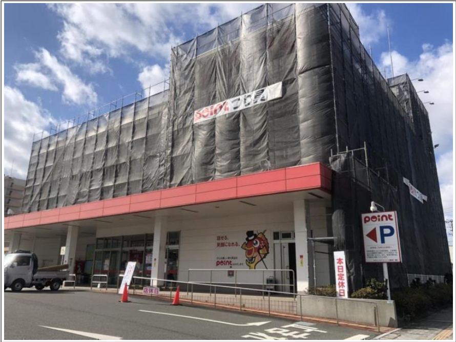
足場組立 完了
