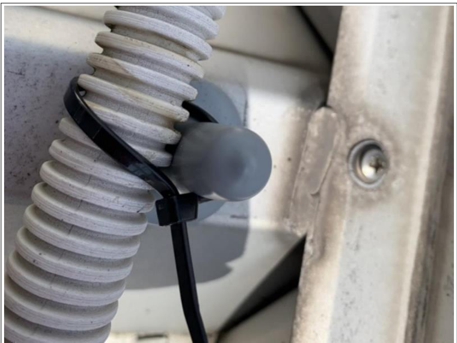
底屋根 ボルトキャップ取付け
