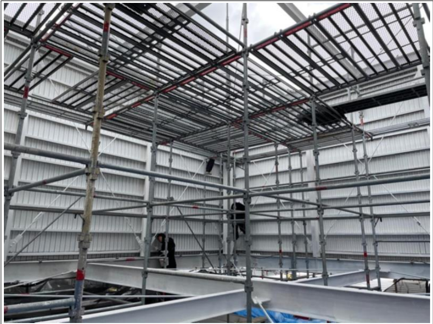
看板塔屋 鉄骨部
