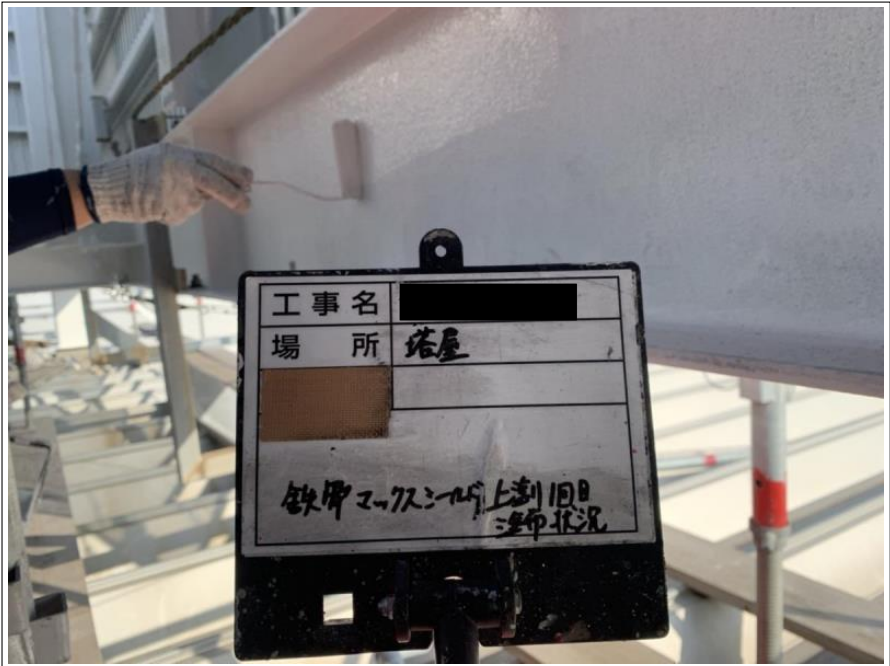
看板塔屋 鉄骨部
