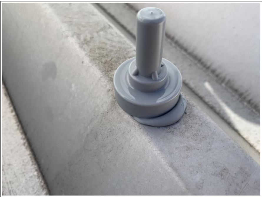
底屋根 ボルトキャップ取付け
