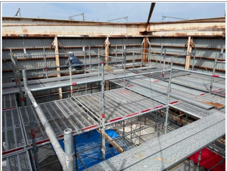
看板塔屋 鉄骨部
