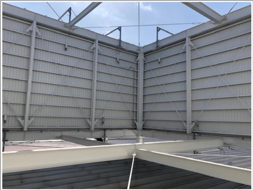
看板塔屋 鉄骨部
