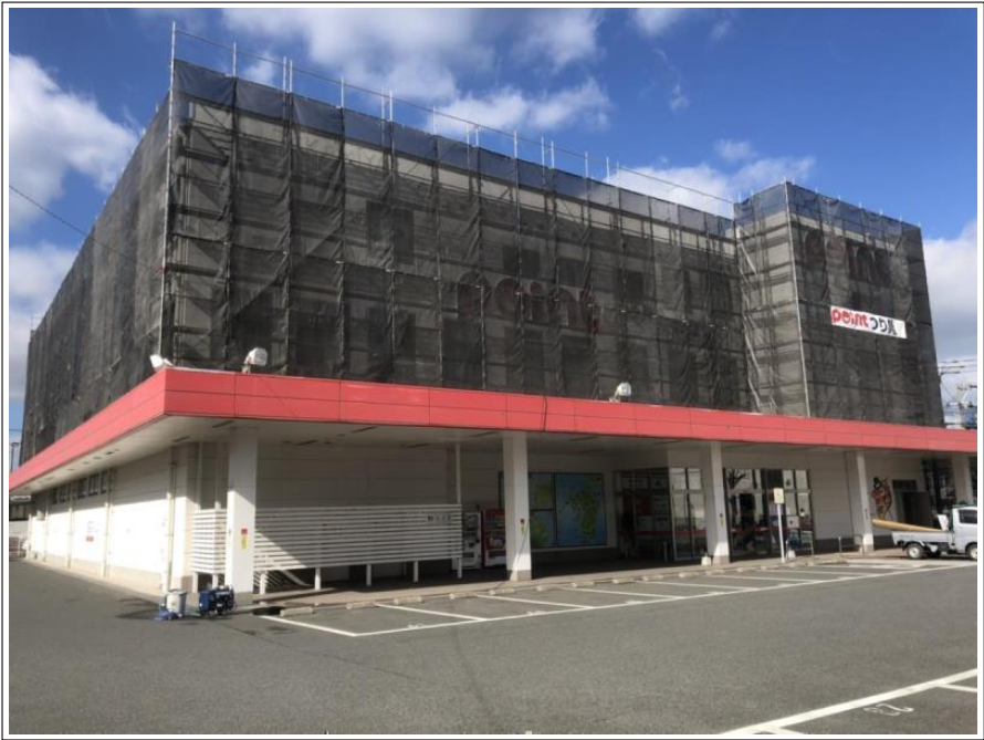
足場組立 完了
