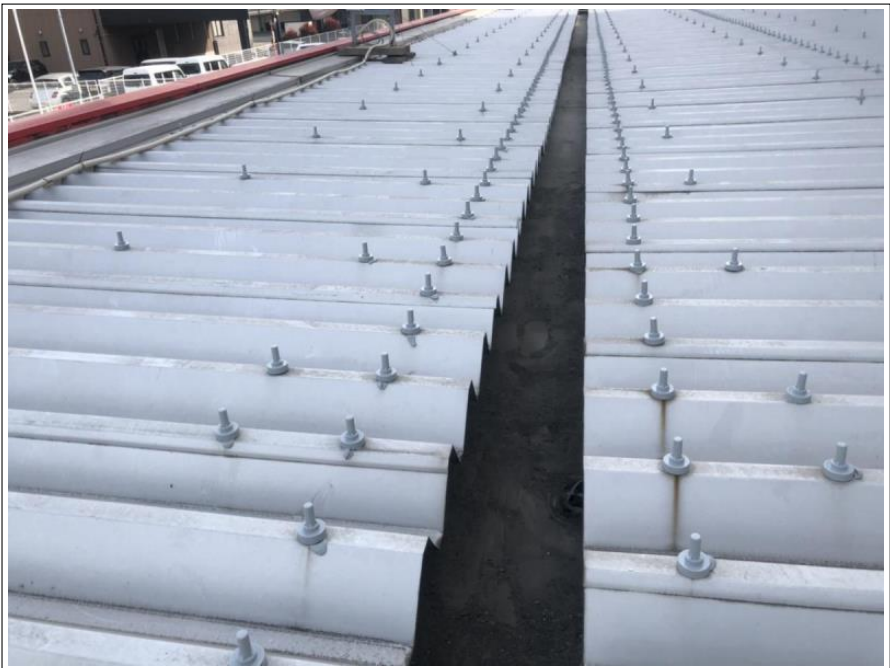
底屋根 ボルトキャップ取付け
