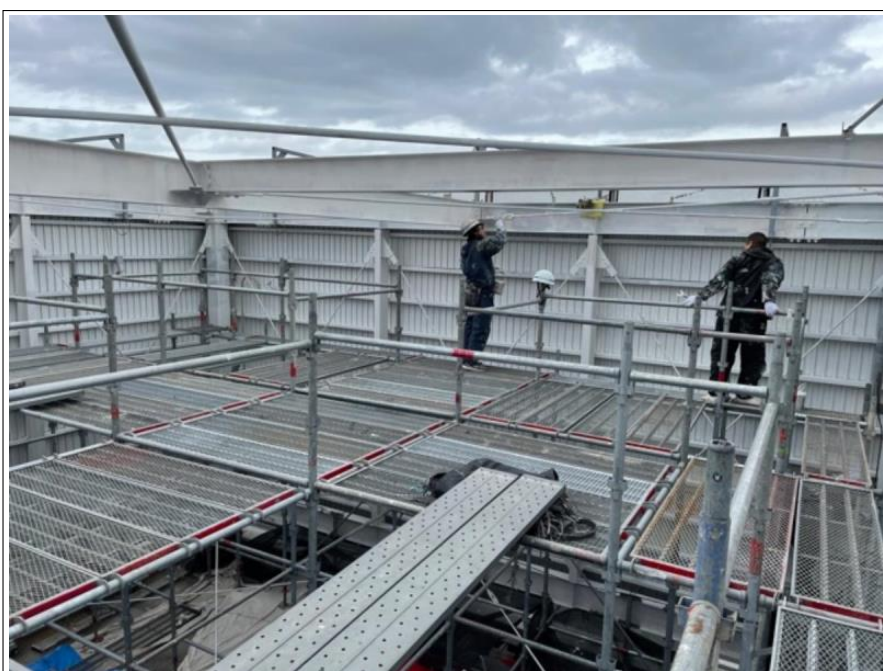
看板塔屋 鉄骨部
