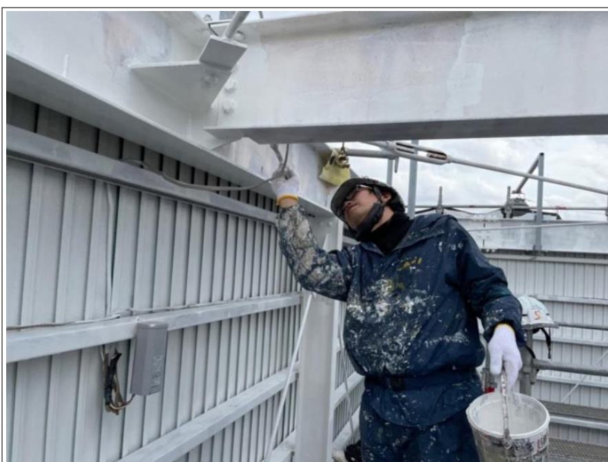
看板塔屋 鉄骨部
