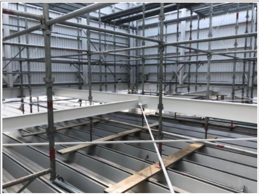
看板塔屋 鉄骨部
