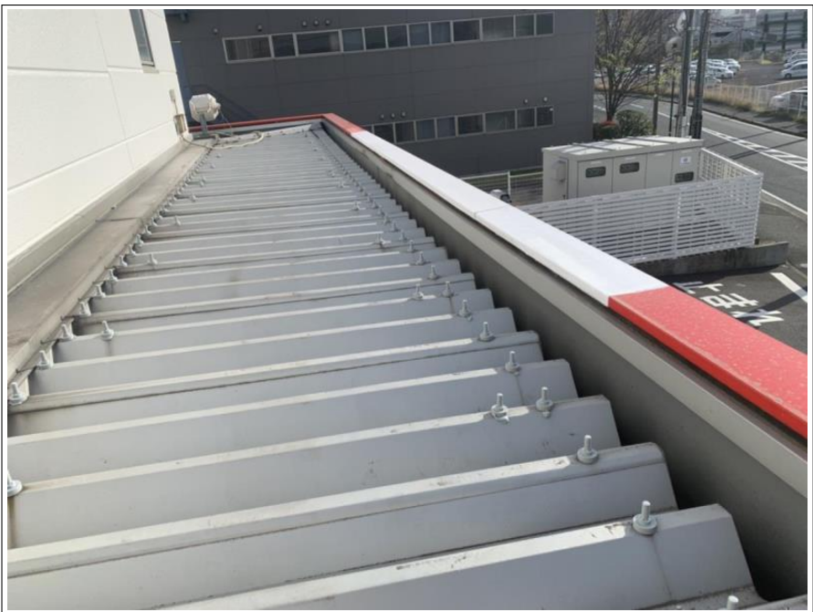
底屋根 ボルトキャップ取付け
