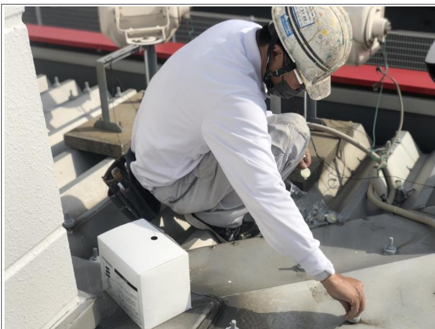
底屋根 ボルトキャップ取付け
