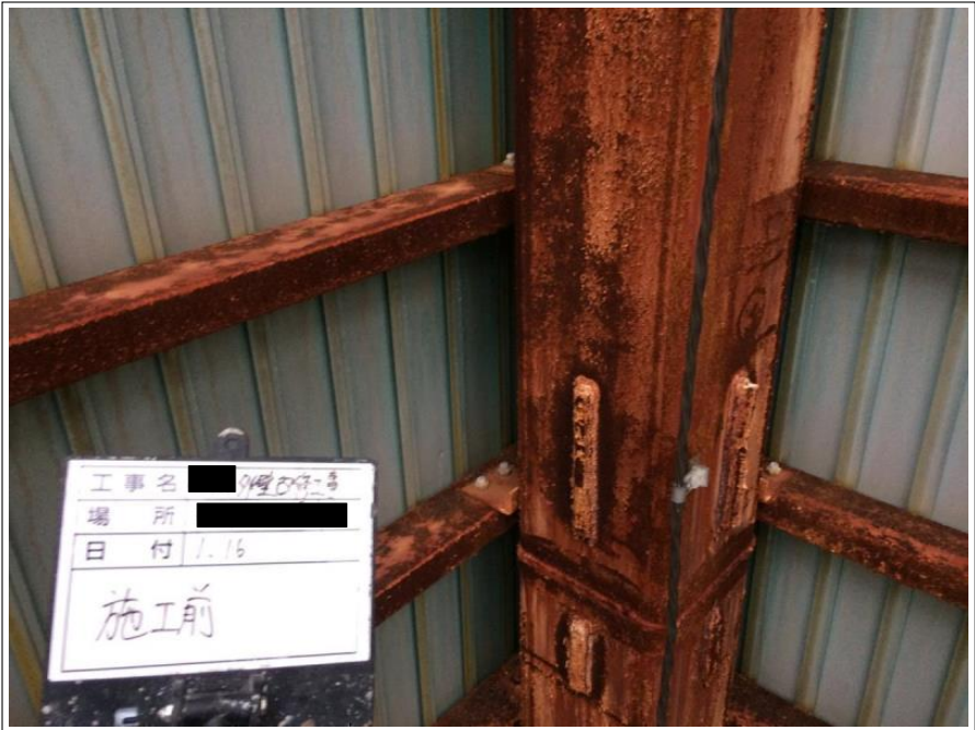
看板塔屋 鉄骨部
