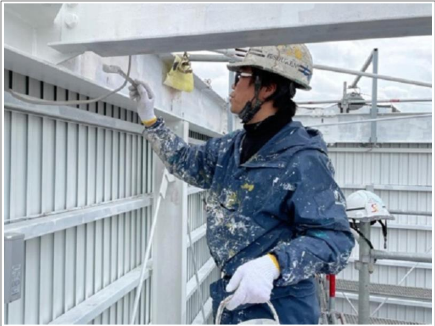
看板塔屋 鉄骨部
