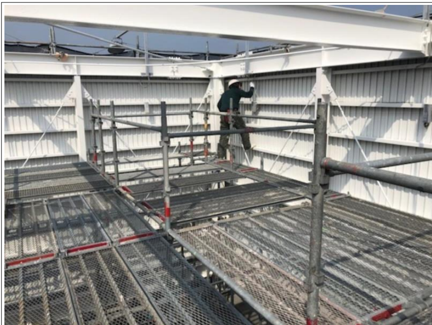
看板塔屋 鉄骨部
