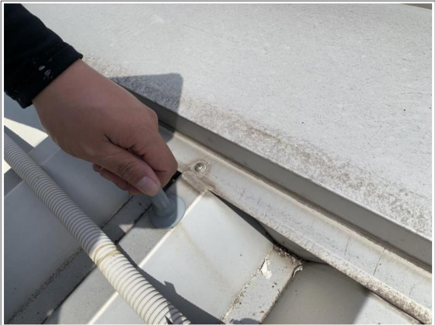
底屋根 ボルトキャップ取付け
