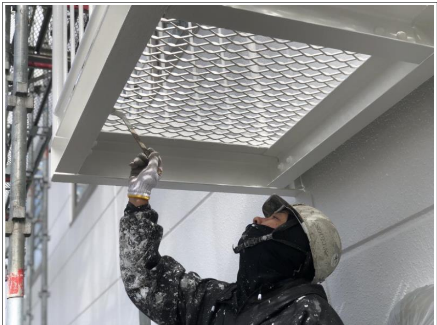
西面 鉄骨デッキ
