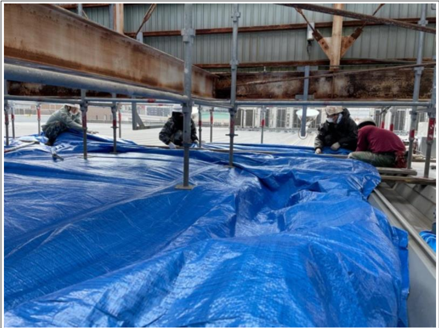
看板塔屋 鉄骨部
