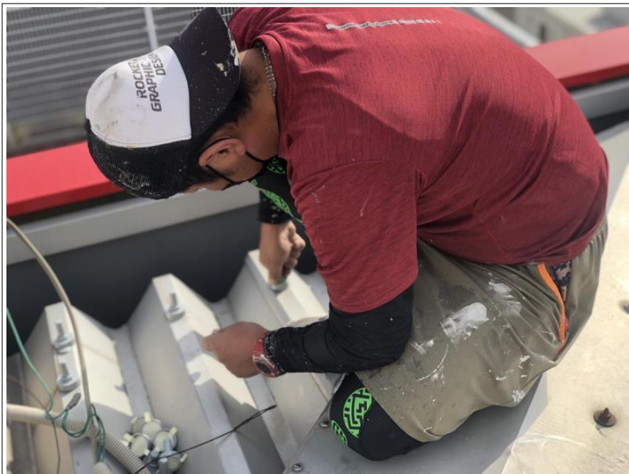
底屋根 ボルトキャップ取付け
