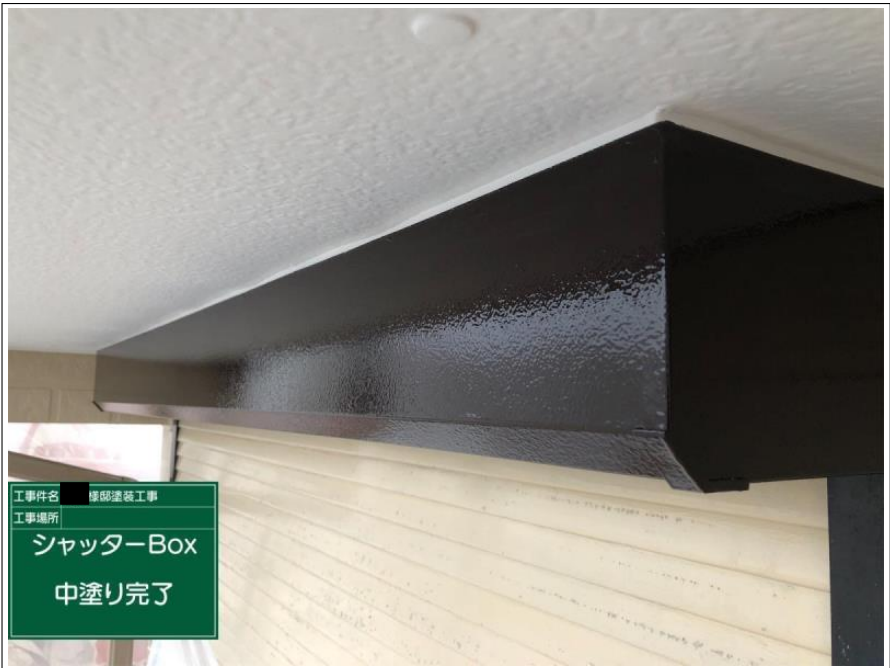
工事件名 屋根塗装工事 工事場所 シャッターBox 中塗り
