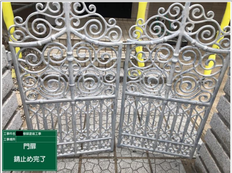
工事件名 屋根塗装工事 工事場所 門扉 上塗り
