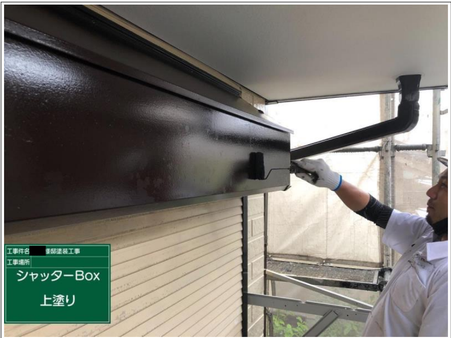
工事件名 屋根塗装工事 工事場所 シャッターBox 中塗り完了
