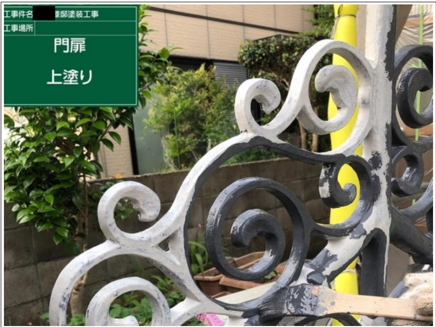
工事件名 屋根塗装工事 工事場所 門扉 錆止め完了
