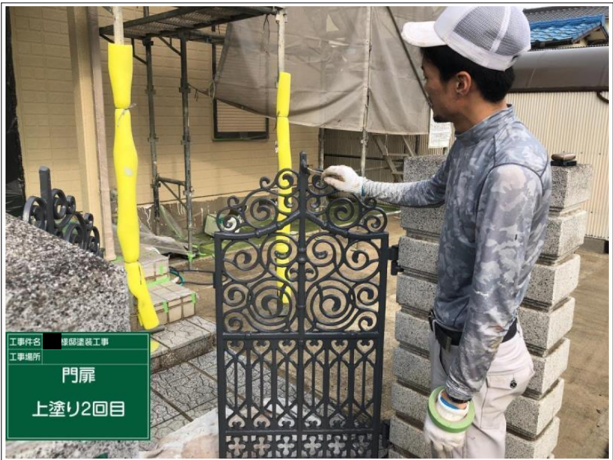
工事件名 様邸塗装工事 工事場所 門扉 上塗り完了
