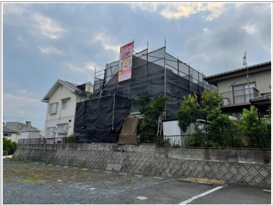
足場組立 完了
