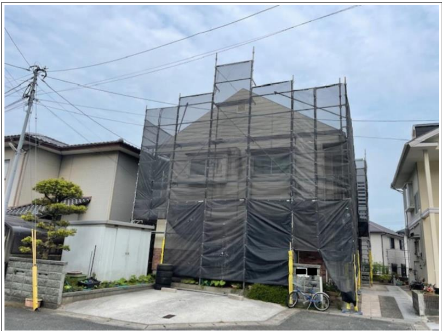
足場組立 完了
