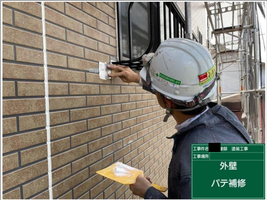
外壁 破損部
