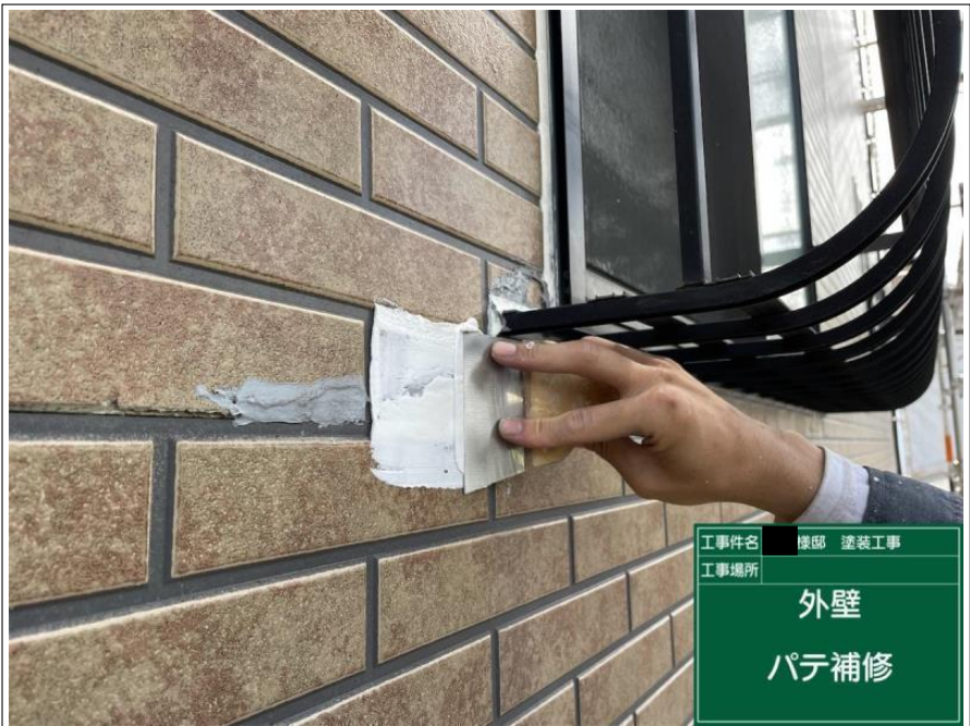
外壁 破損部
