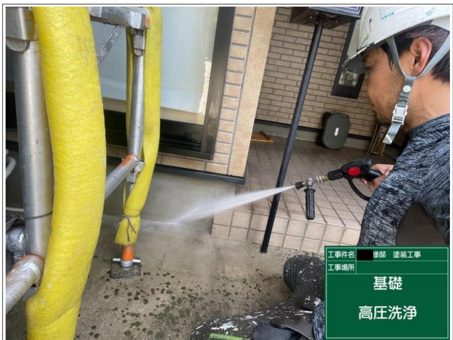
工事件名 〇〇邸 塗装工事 工事場所 玄関ドア 高圧洗浄完了
