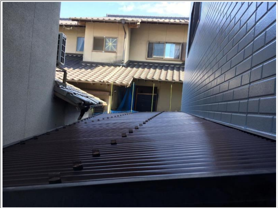
ストックヤード屋根貼替工事
