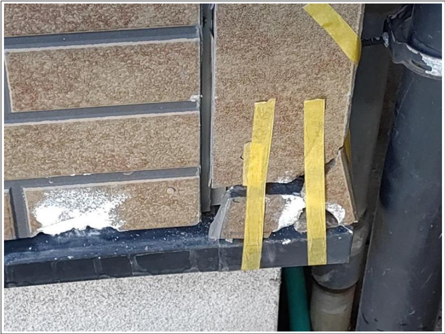
外壁 破損部
