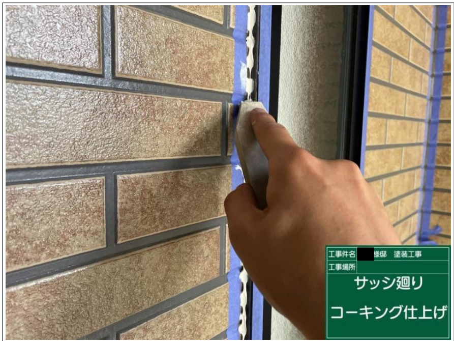
工事件名 棟梁 塗装工事 工事場所 サッシ廻り コーキング仕上げ
