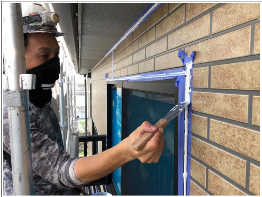
工事件名 棟梁 塗装工事 工事場所 サッシ廻り コーキング仕上げ
