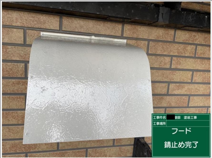
工事件名 屋根 塗装工事 工事場所 フード 錆止め
