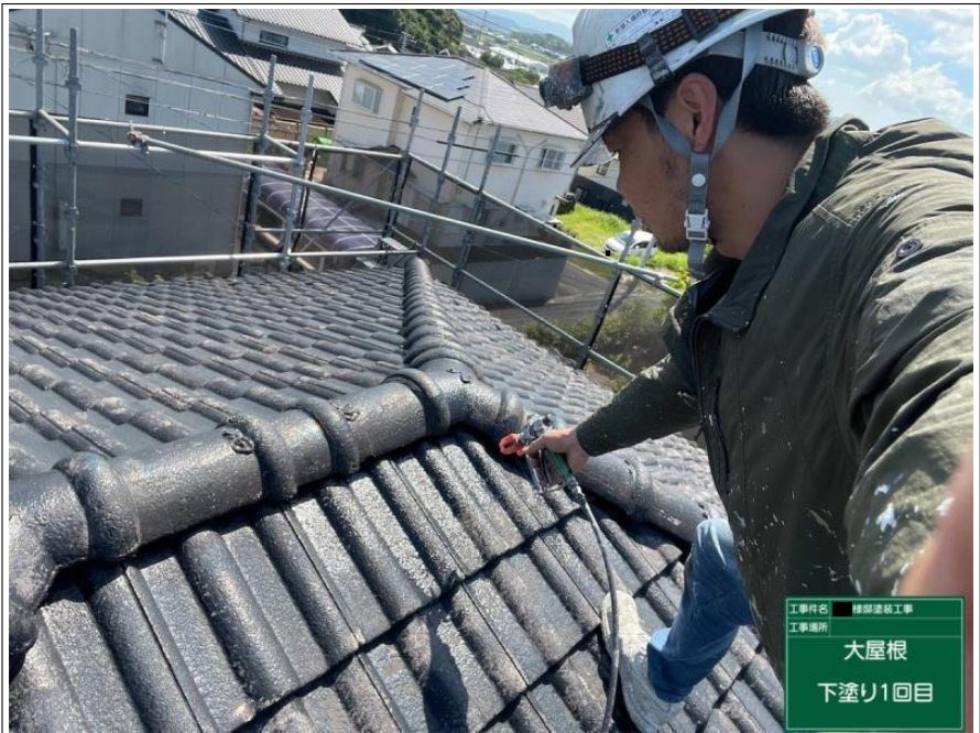
工事件名 屋根塗装工事 工事場所 大屋根 下塗り1回目施工前
