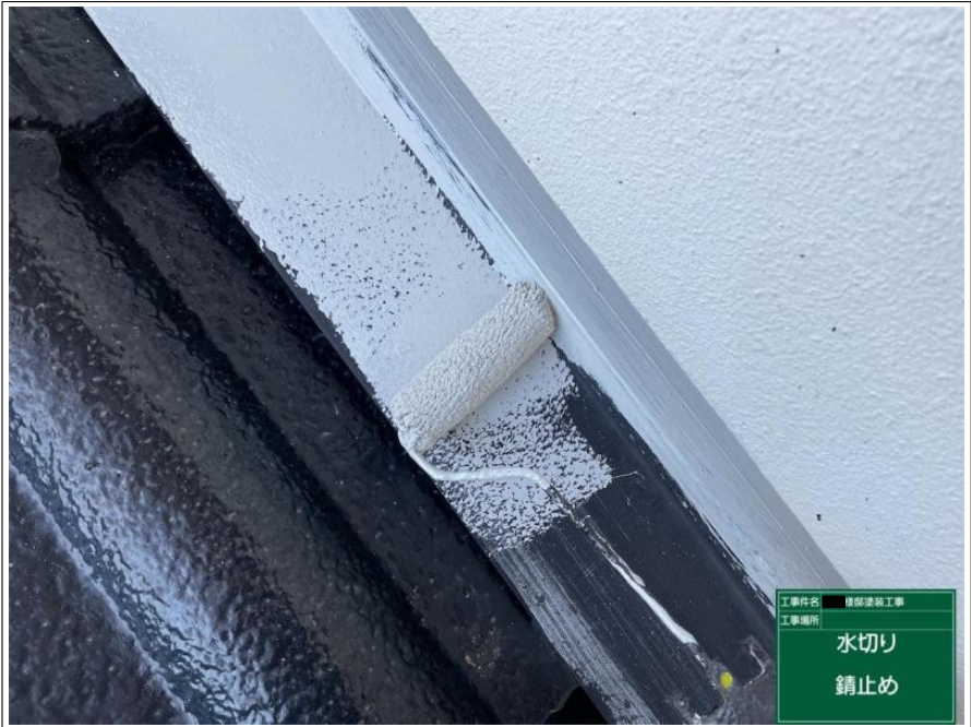
工事件名 屋根塗装工事 工事場所 水切り 錆止め
