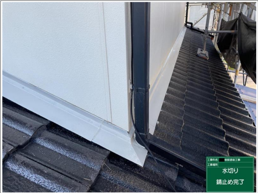
工事件名 屋根塗装工事 工事場所 水切り 錆止め
