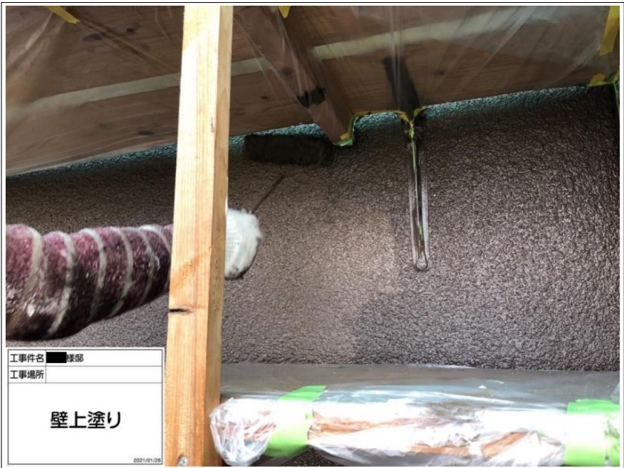
工事件名 ■ 様邸 工事場所 壁上塗り 2021/01/28
