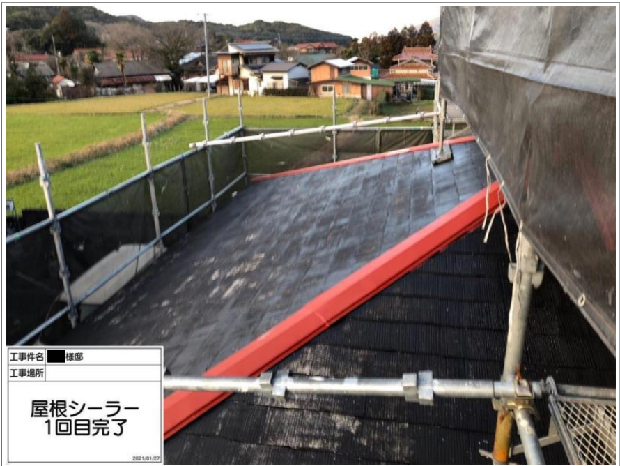
工事件名 ■様邸 工事場所 屋根シーラー 1回目完了 2021/01/27
