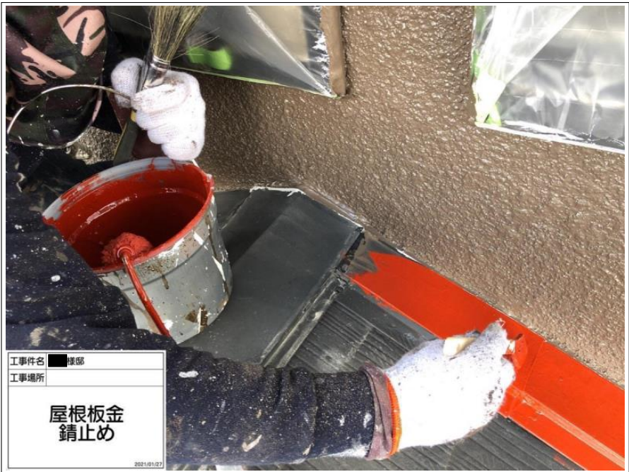
工事件名 ■様邸 工事場所 屋根板金 錆止め 2021/01/27
