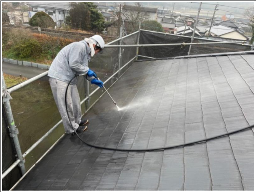
工事件名 ■ 屋根 工事場所 高圧洗浄 屋根面
