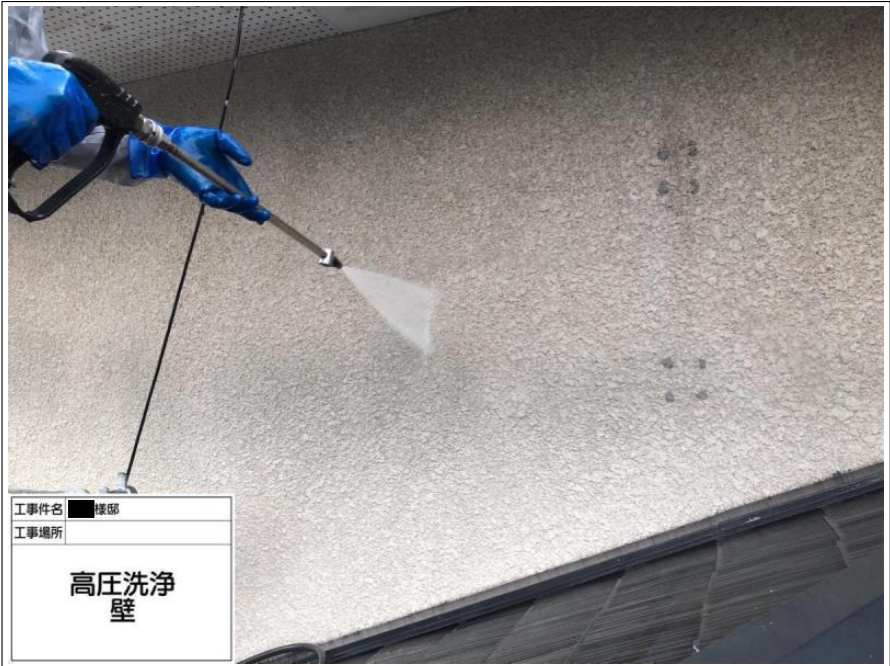
工事件名 ■様邸 工事場所 高圧洗浄 軒
