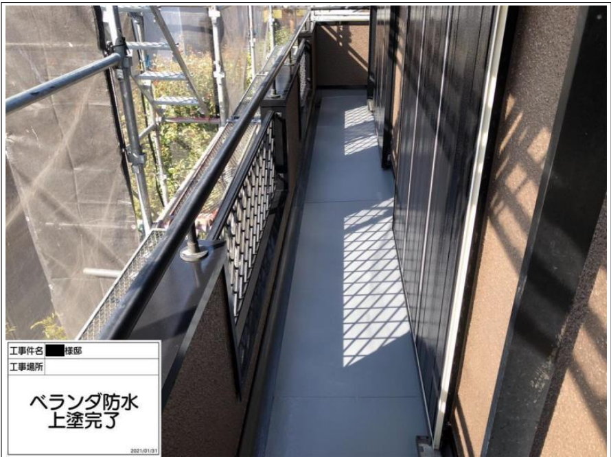
工事件名 ■様邸 工事場所 ベランダ防水 上塗り 2021/09/13
