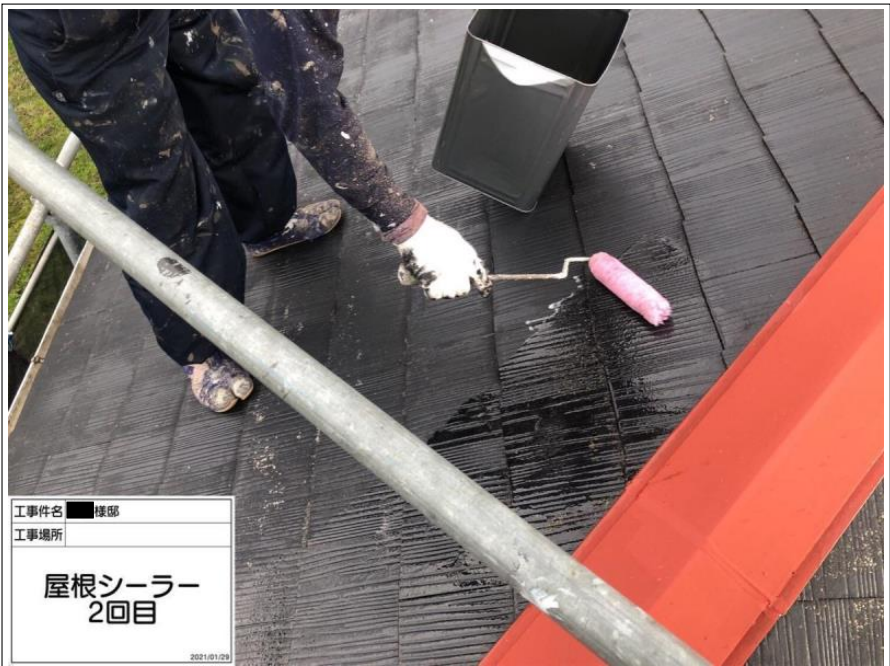
工事件名 ■様邸 工事場所 屋根シーラー 2回目 2021/01/29
