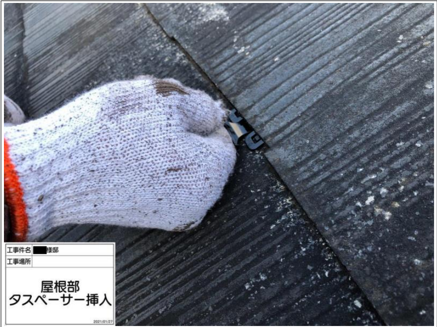
工事件名 ■棟部 工事場所 屋根部 タスペーサー挿入 2021/01/27
