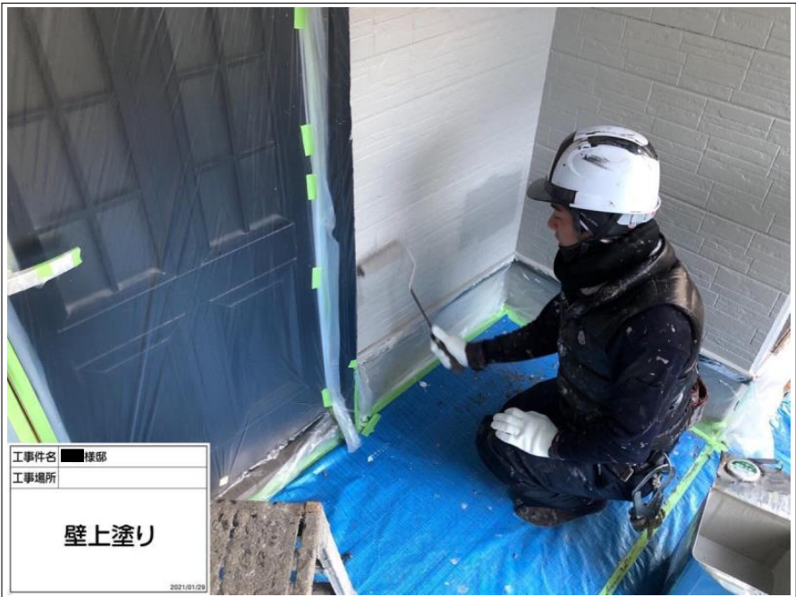
工事件名 ■様邸 工事場所 壁上塗り 2021/01/29
