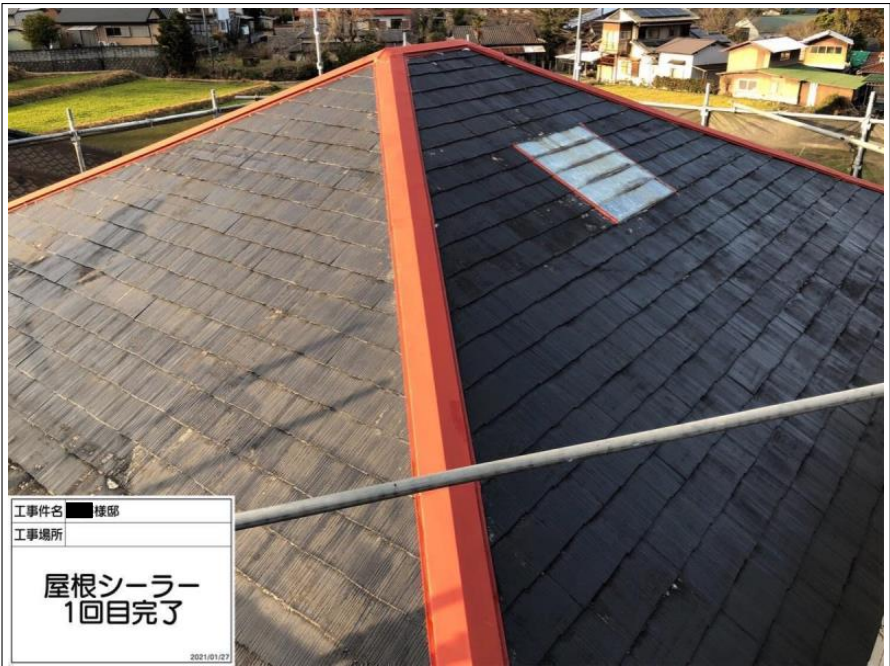
工事件名 ■様邸 工事場所 屋根シーラー 1回目 2021/01/27
