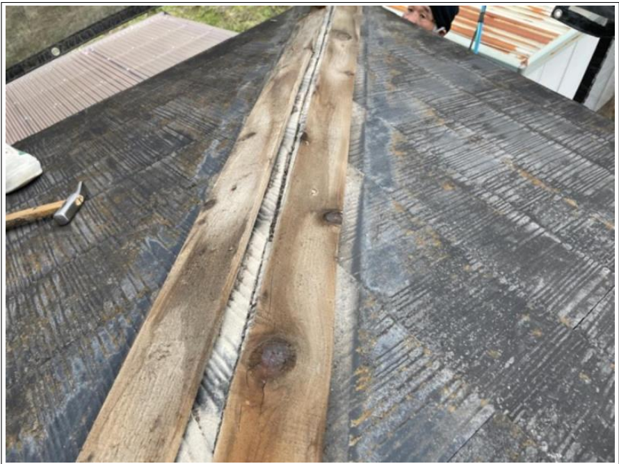
屋根板金 部分補修工事
