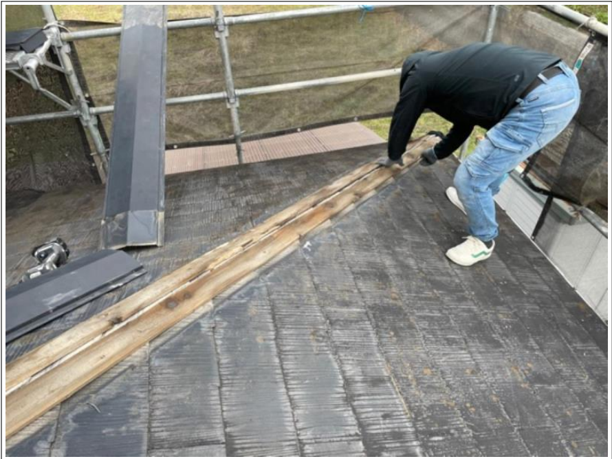
屋根板金 部分補修工事
