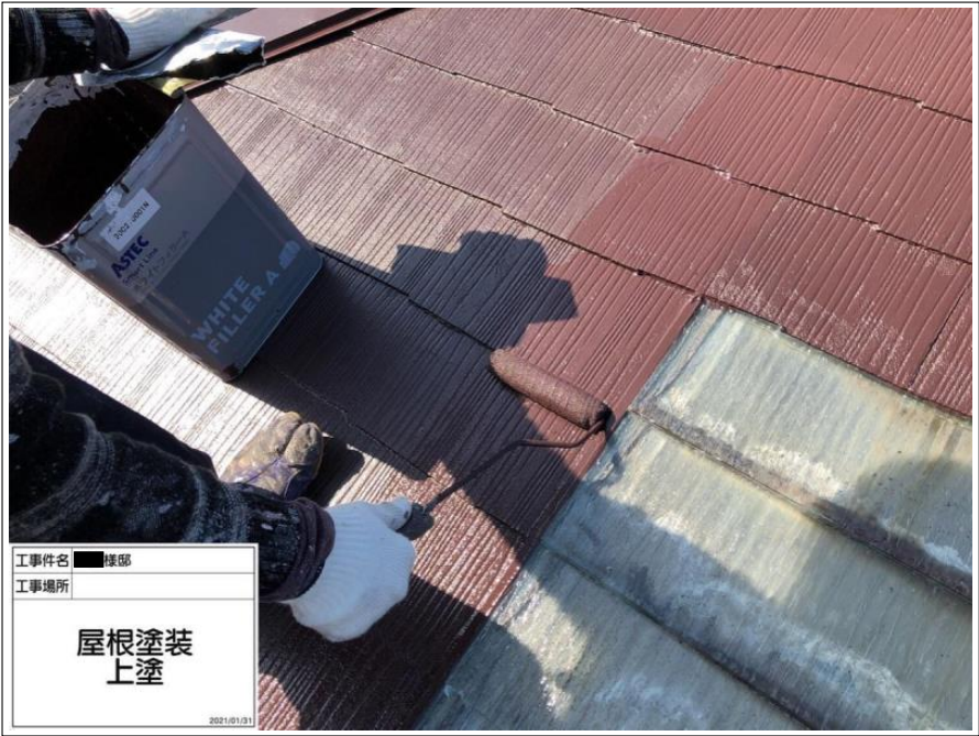
工事件名 ■ 棟部 工事場所 屋根塗装 上塗り 2021/01/31
