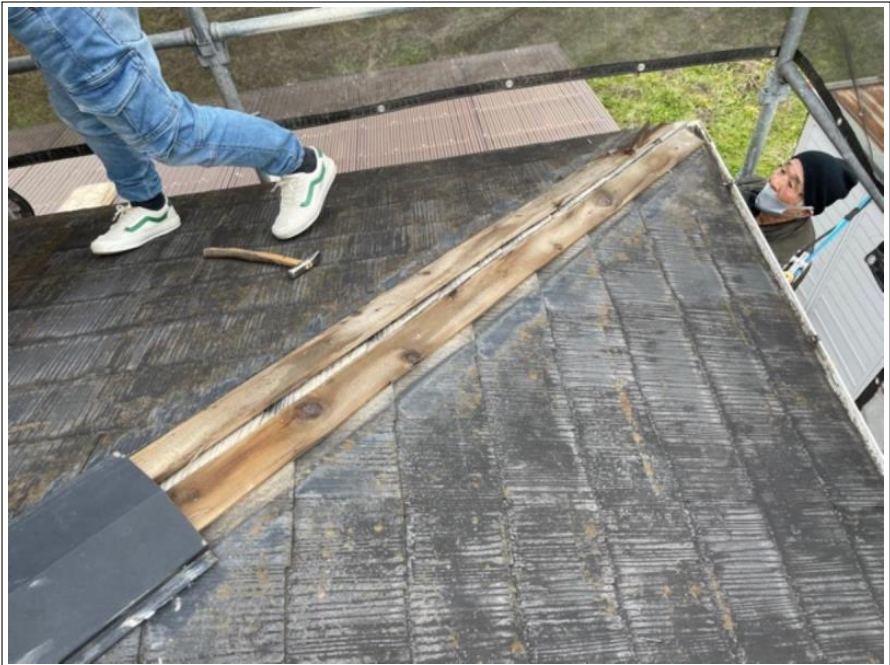
屋根板金 部分補修工事
