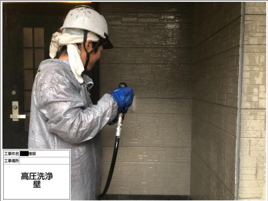
工事件名 ■様邸 工事場所 高圧洗浄 壁
