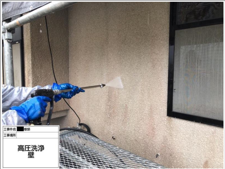
工事件名 ■様邸 工事場所 高圧洗浄 壁
