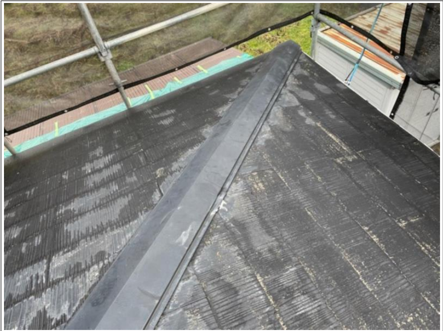
屋根板金 部分補修工事
