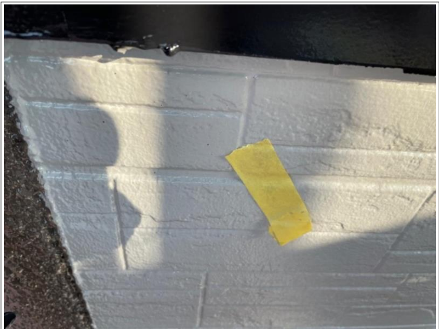
工事件名 ■様邸 工事場所 ベランダ防水 上塗り完了 2021/09/13
