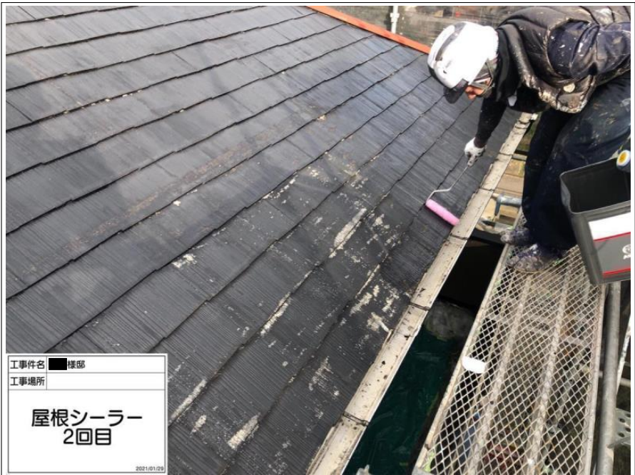
工事件名 ■様邸 工事場所 屋根シーラー 2回目 2021/01/29
