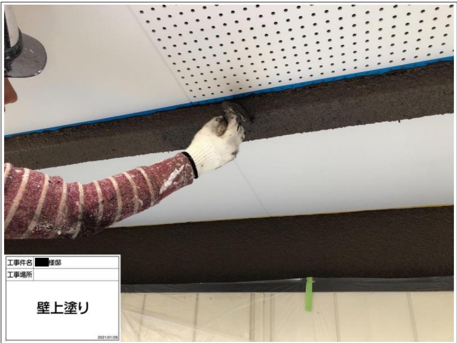
工事件名 ■ 様邸 工事場所 壁上塗り 2021/01/28
