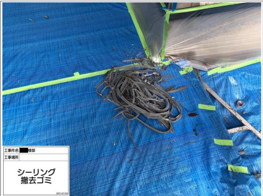
工事件名 ■ 棟部 工事場所 シーリング撤去 2021/01/24
