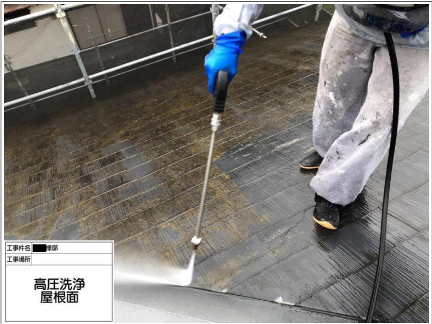
工事件名 ■ 屋根 工事場所 高圧洗浄 屋根面
