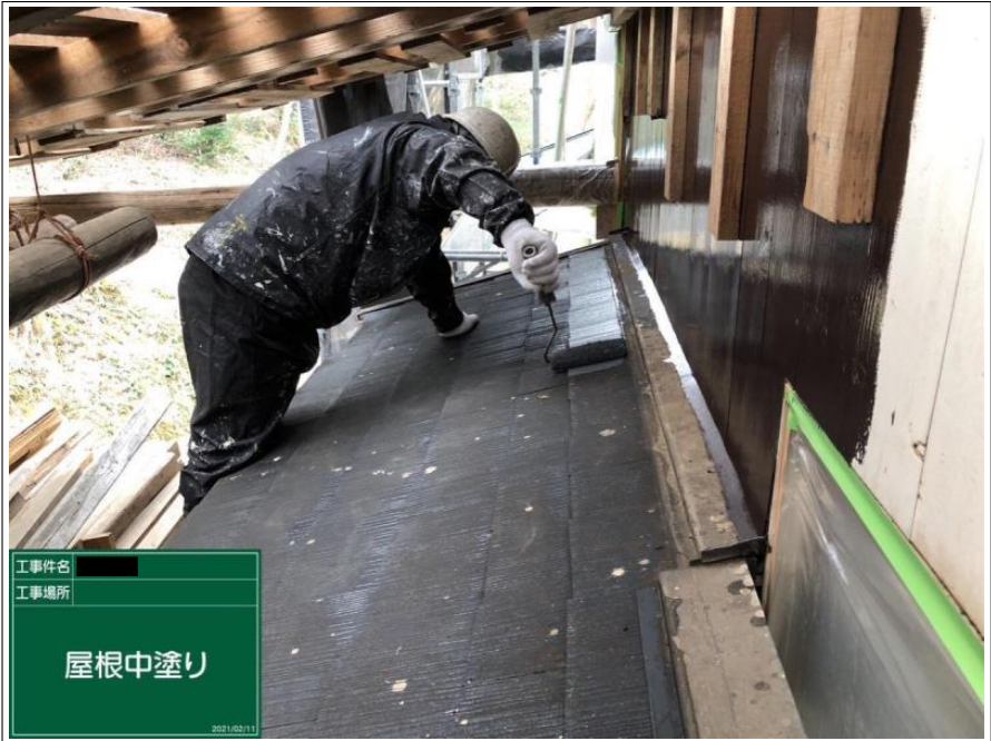
工事件名 [REDACTED] 工事場所 [REDACTED] 屋根中塗り 2021.02.11
