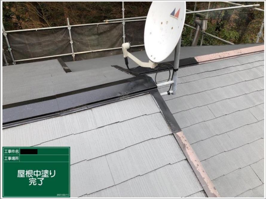
工事件名 [REDACTED] 工事場所 [REDACTED] 屋根中塗り 2021.02.11
