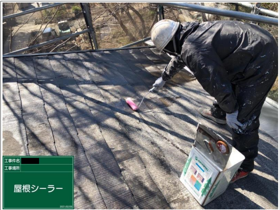
工事件名 [REDACTED] 工事場所 [REDACTED] 屋根シーラー 2021.02.09
