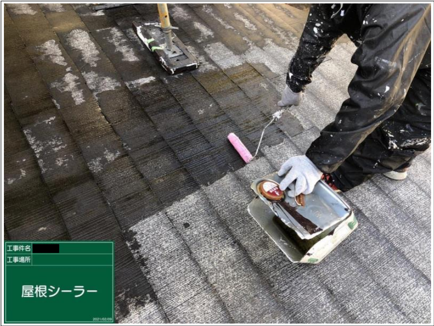
工事件名 [REDACTED] 工事場所 [REDACTED] 屋根シーラー 2021.02.09
