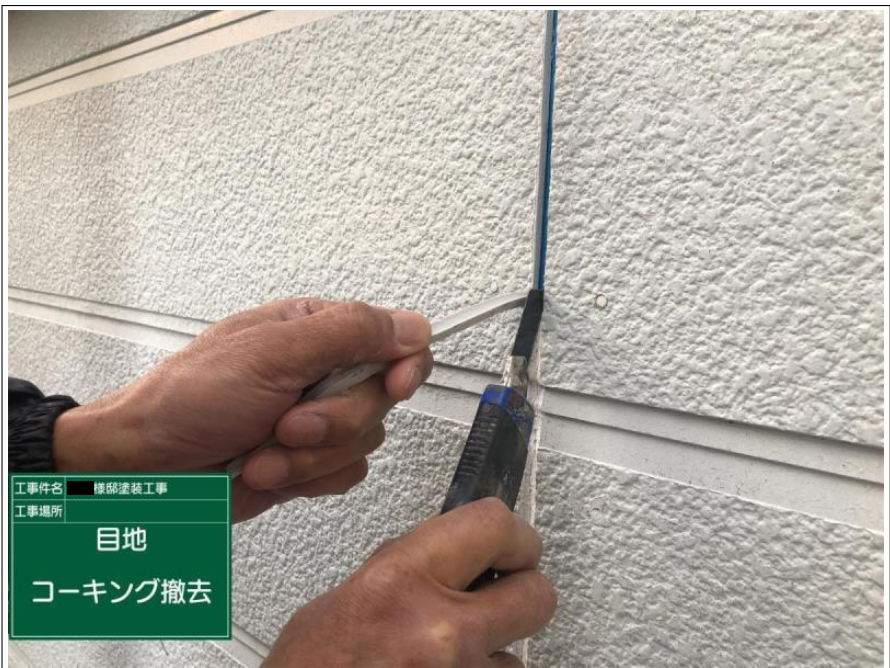
工事件名 棟梁塗装工事 工事場所 目地 コーキング撤去
