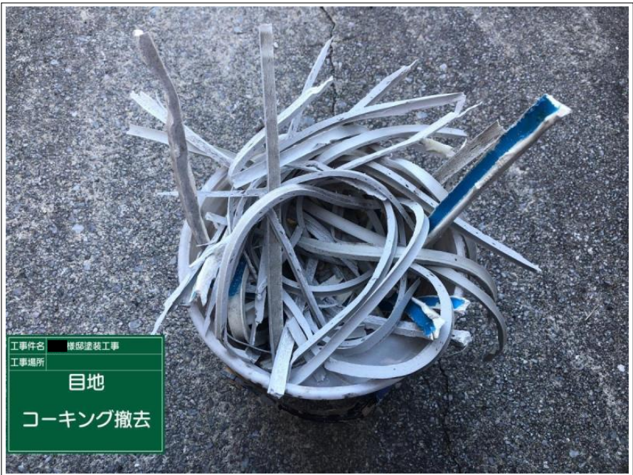
工事件名 棟梁塗装工事 工事場所 目地 コーキング撤去
