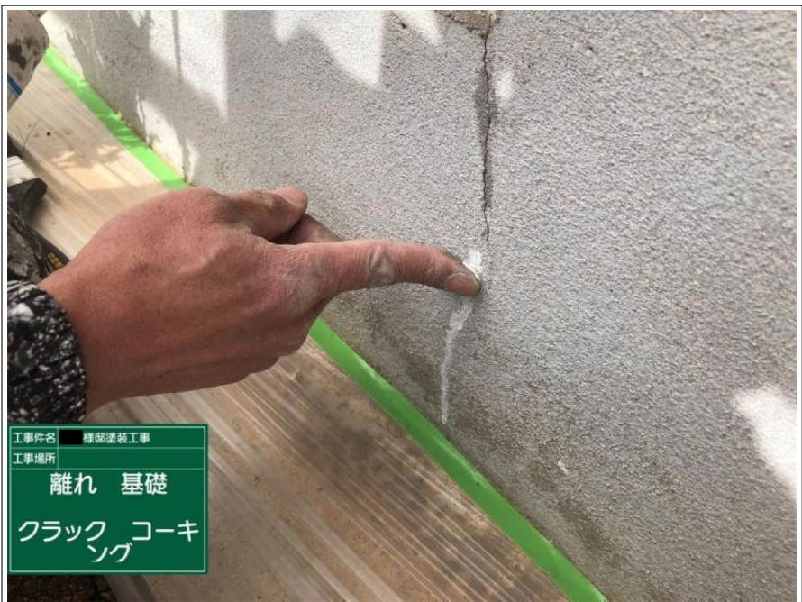
工事件名 様邸塗装工事 工事場所 離れ 基礎 クラック コーキング
