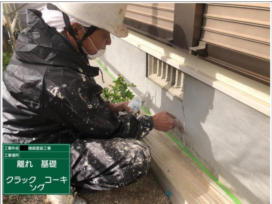
工事件名 様邸塗装工事 工事場所 母屋 基礎 クラック コーキング
