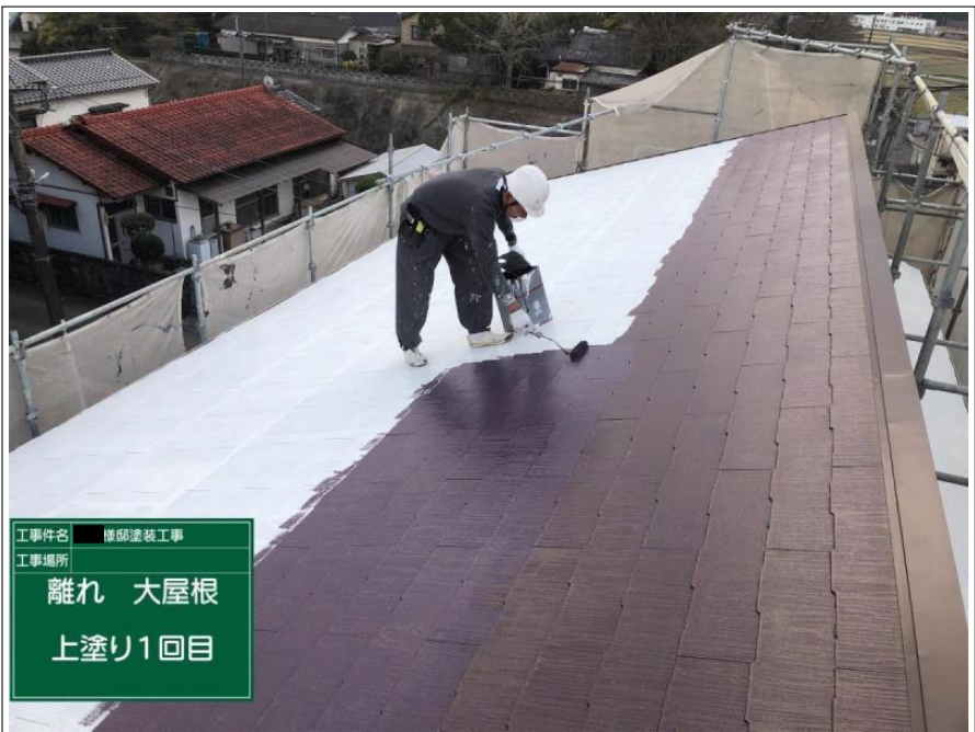
工事件名 屋根塗装工事 工事場所 母屋 下屋根 上塗り1回目
