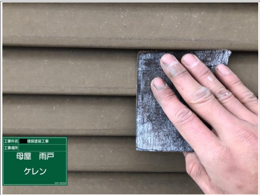
工事件名 様邸塗装工事 工事場所 母屋 雨戸 ケレン 2021.02.04
