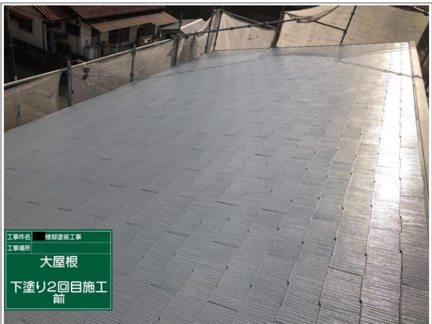
工事件名 棟梁塗装工事 工事場所 下屋根 下塗り2回目施工 前
