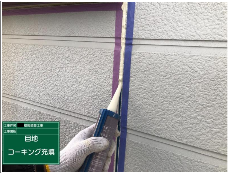
工事件名 棟梁塗装工事 工事場所 目地 コーキング充填
