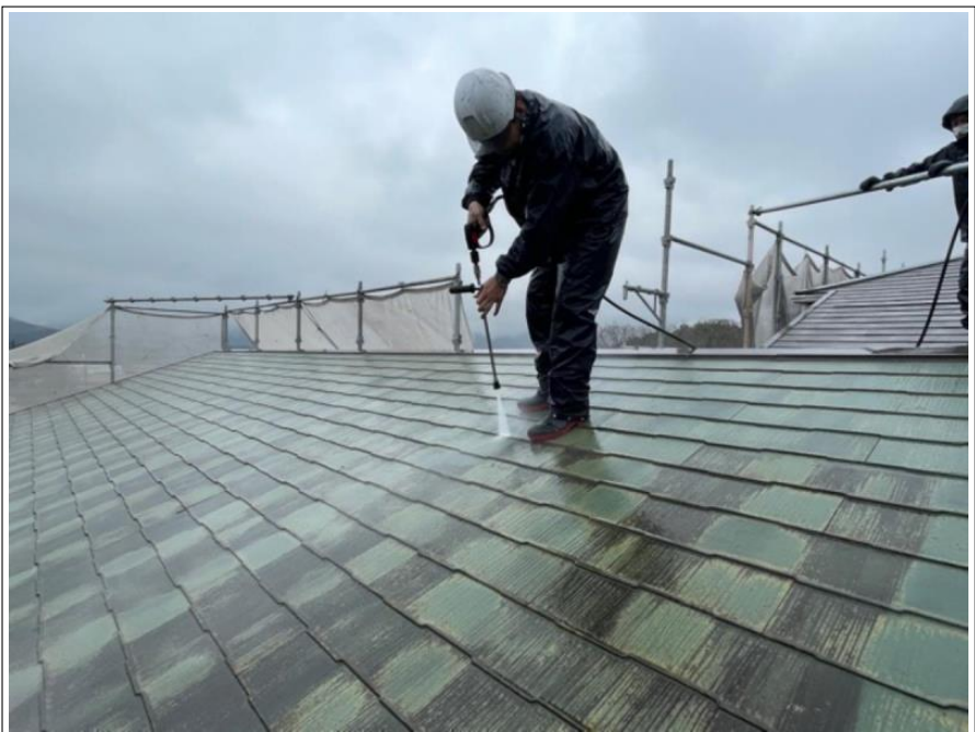
工事件名 屋根塗装工事 工事場所 大屋根 高圧洗浄
