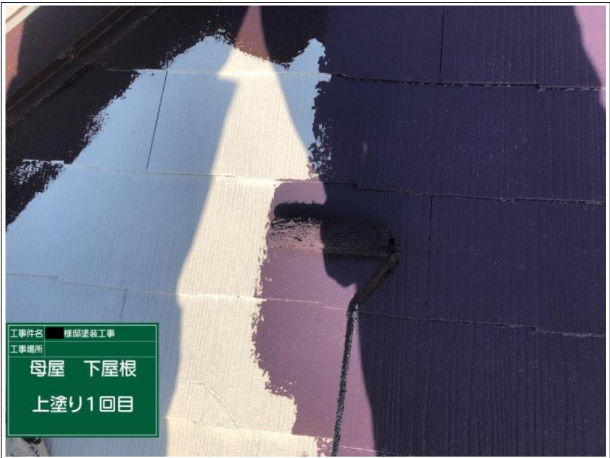
工事件名 屋根塗装工事 工事場所 母屋 下屋根 上塗り1回目
