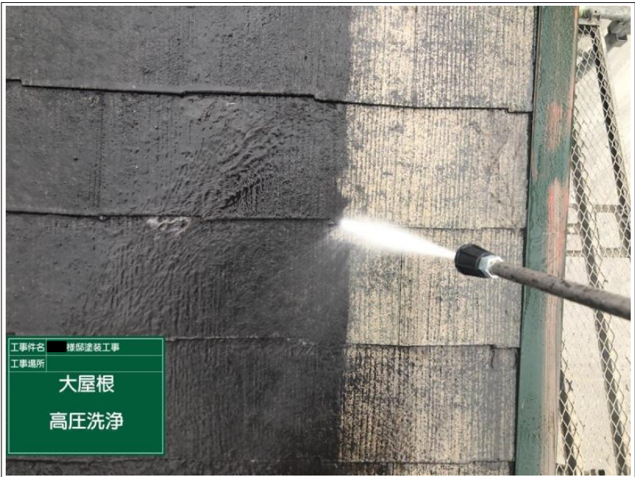
工事件名 屋根塗装工事 工事場所 大屋根 高圧洗浄
