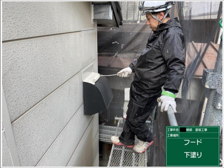
工事件名 棟部 塗装工事 工事場所 フード ケレン完了
