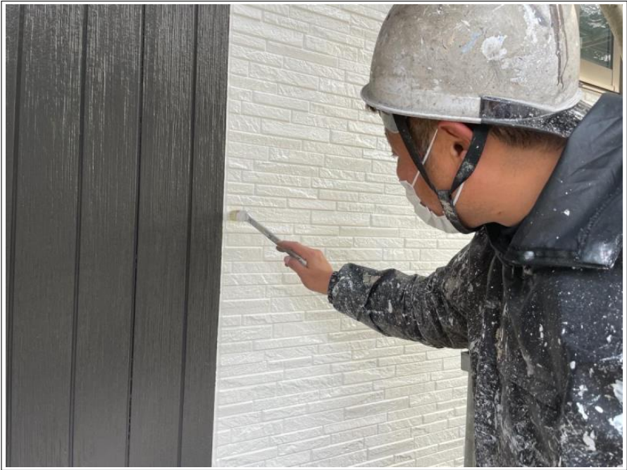
足場解体前検査
