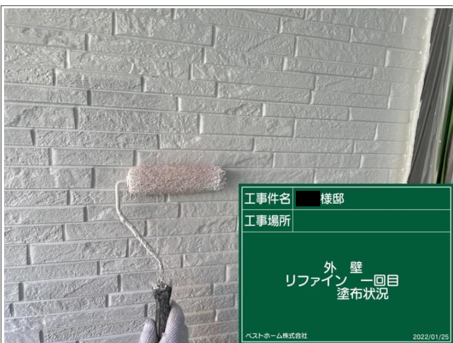
工事件名 ■ 様邸 工事場所 外 壁 リファイン 一回目 塗布状況 ベストホーム株式会社 2022/01/25
