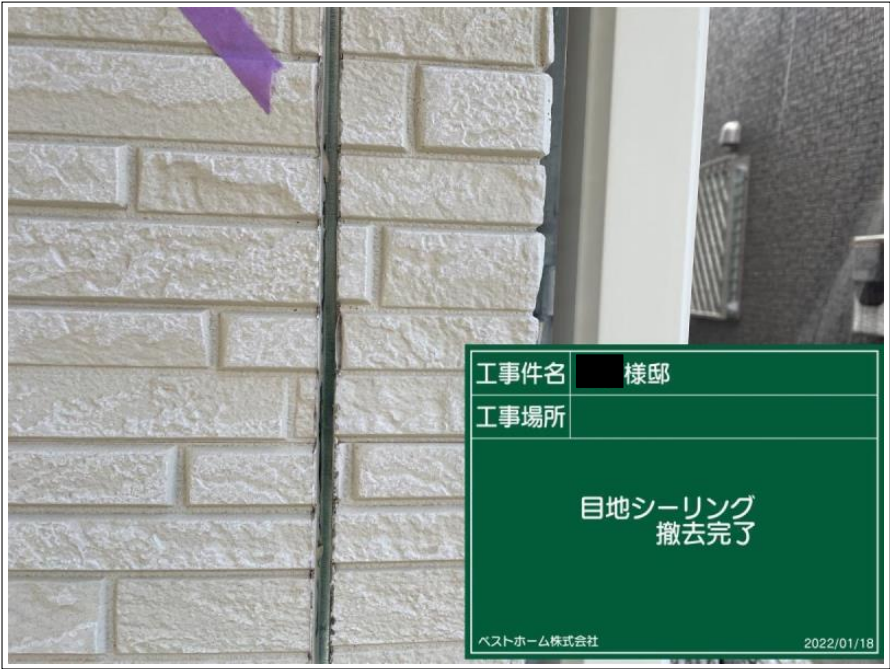
工事件名 様邸 工事場所 目地シーリング 撤去状況 ベストホーム株式会社 2022/01/18
