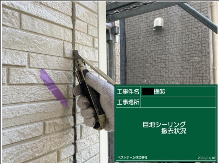
工事件名 様邸 工事場所 目地シーリング 撤去状況 ベストホーム株式会社 2022/01/18
