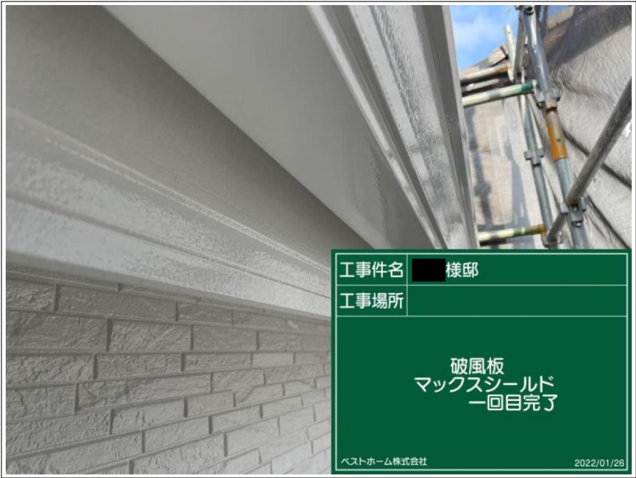
工事件名 ■ 様邸 工事場所 破風板 マックスシールド 一回目状況 ベストホーム株式会社 2022/01/26
