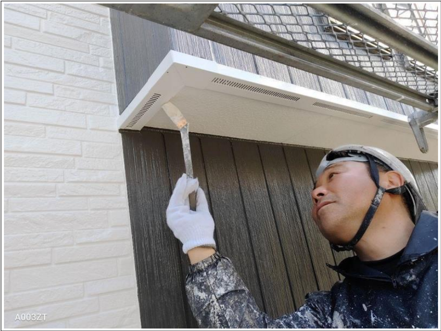
足場解体前検査
