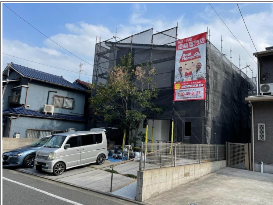
足場組立 完了
