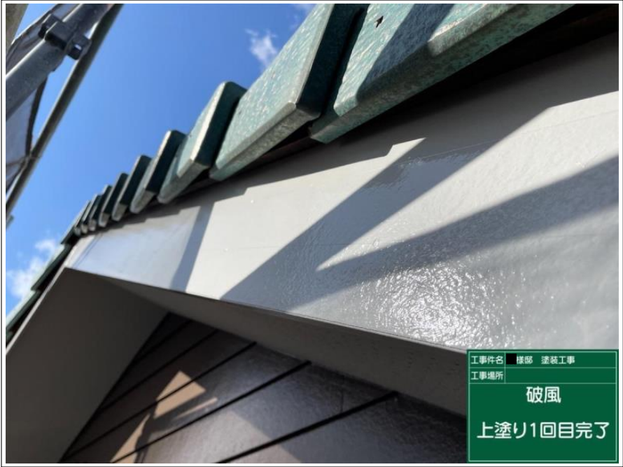
工事件名 様邸 塗装工事 工事場所 破風 上塗り1回目
