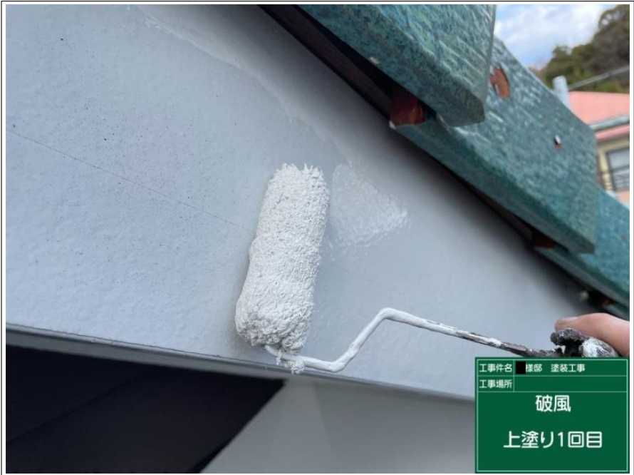
工事件名 様邸 塗装工事 工事場所 破風 上塗り1回目
