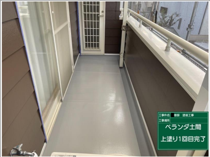
工事件名 様邸 塗装工事 工事場所 ベランダ土間 上塗り1回目
