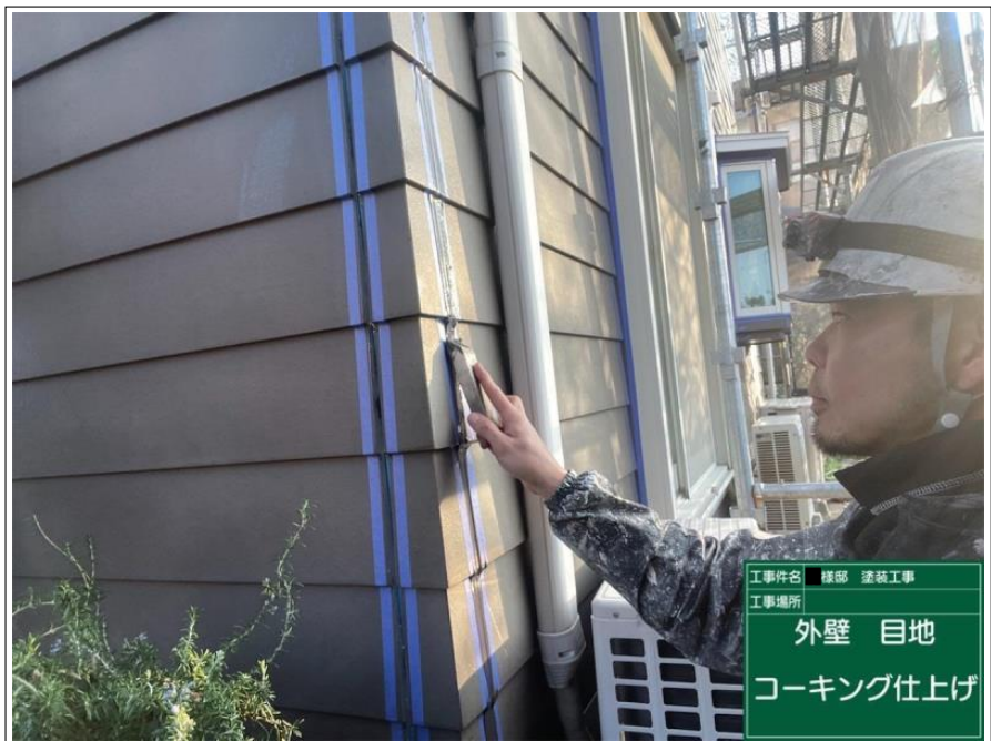
工事件名 様邸 塗装工事 工事場所 外壁 目地 コーキング充填
