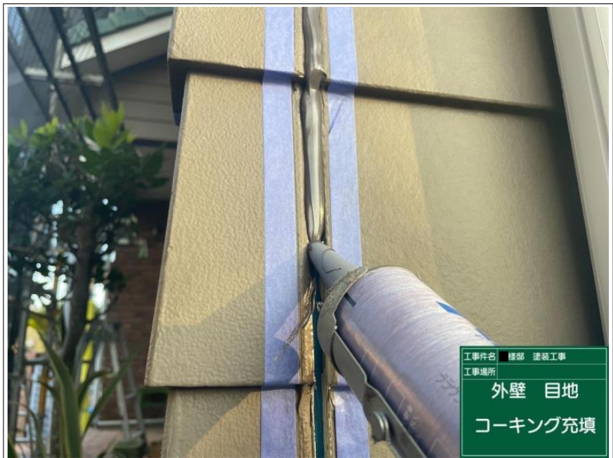
工事件名 様邸 塗装工事 工事場所 外壁 目地 コーキング充填
