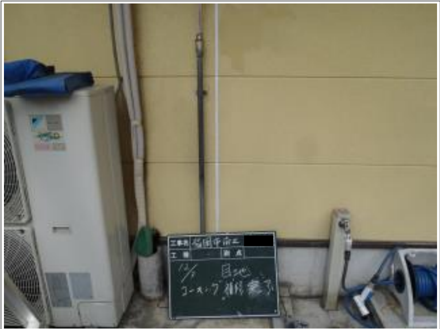
目地コーキング補修施工完了
