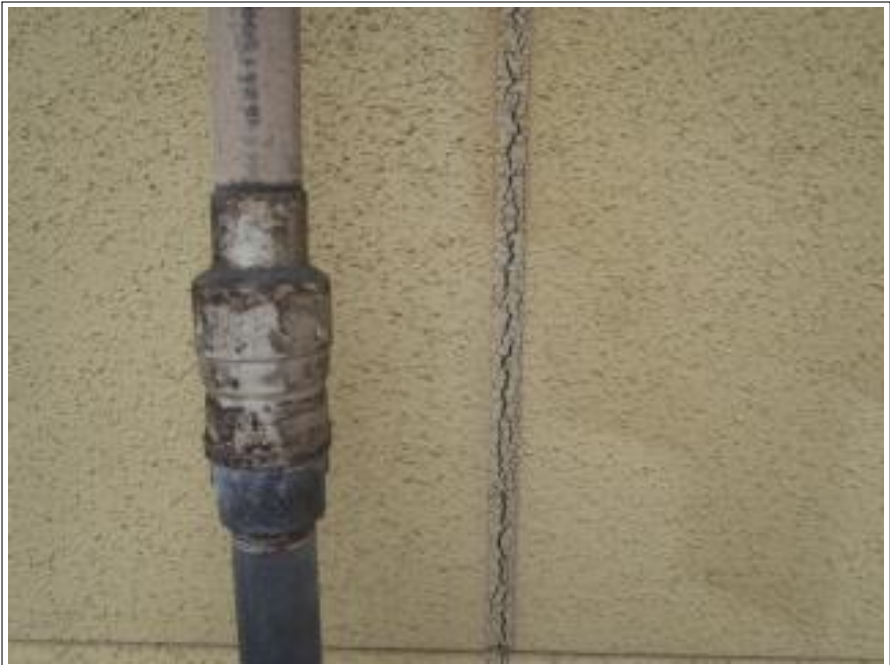
目地コーキング補修施工前
