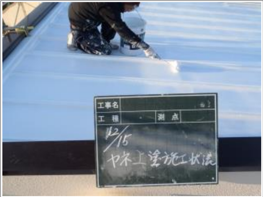
屋根上塗り塗装施工中
