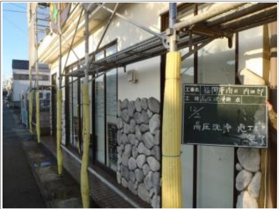
外壁高圧洗浄施工完了
