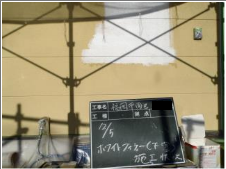
外壁下塗り塗装施工中
