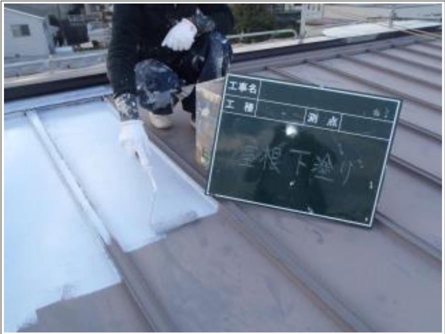
屋根下塗り塗装施工中
