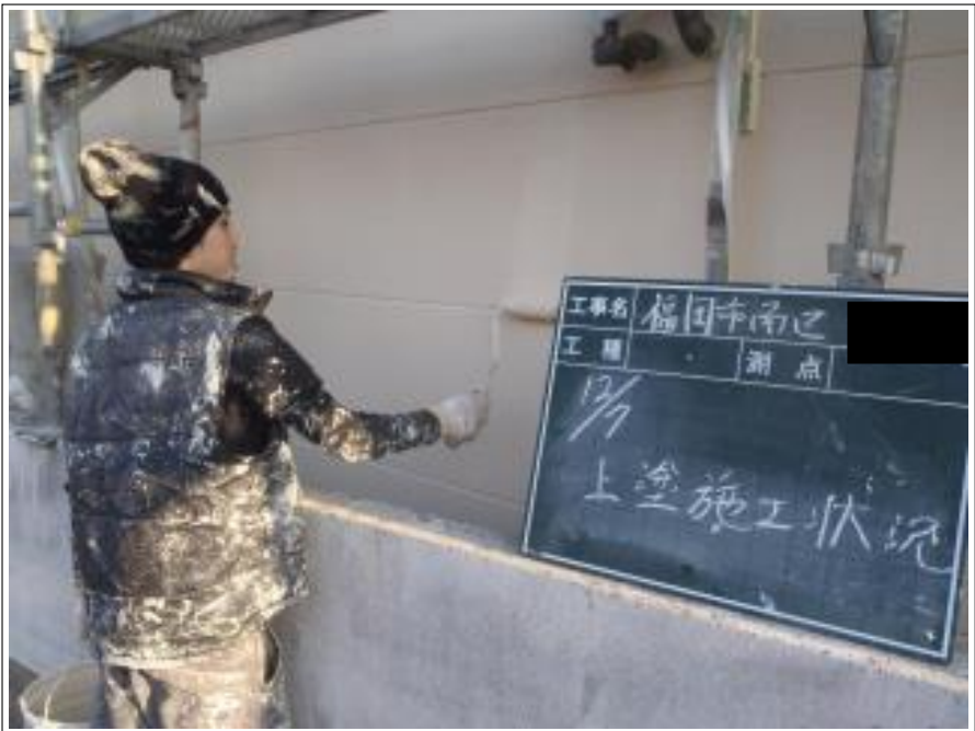
外壁上塗り塗装施工中
