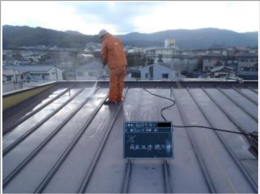
屋根高圧洗浄施工中
