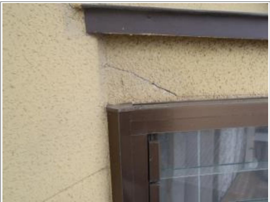
クラック補修施工前
