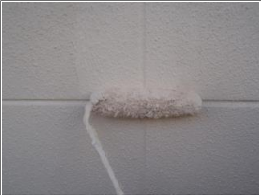
外壁上塗り塗装施工中
