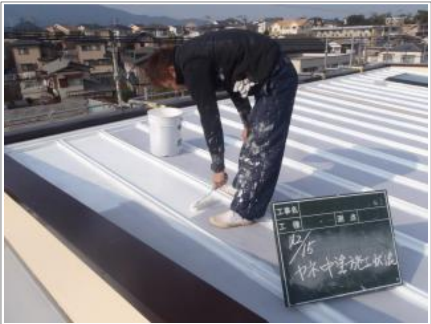
屋根中塗り塗装施工中
