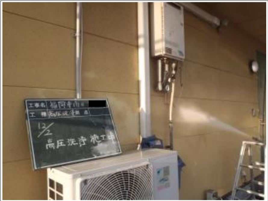
外壁高圧洗浄施工中
