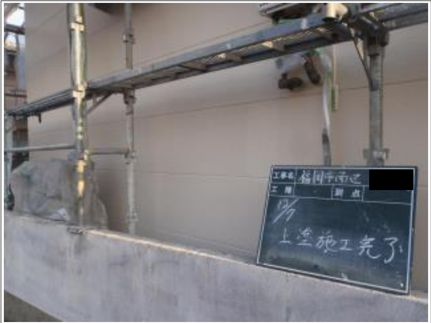
外壁上塗り塗装施工完了
