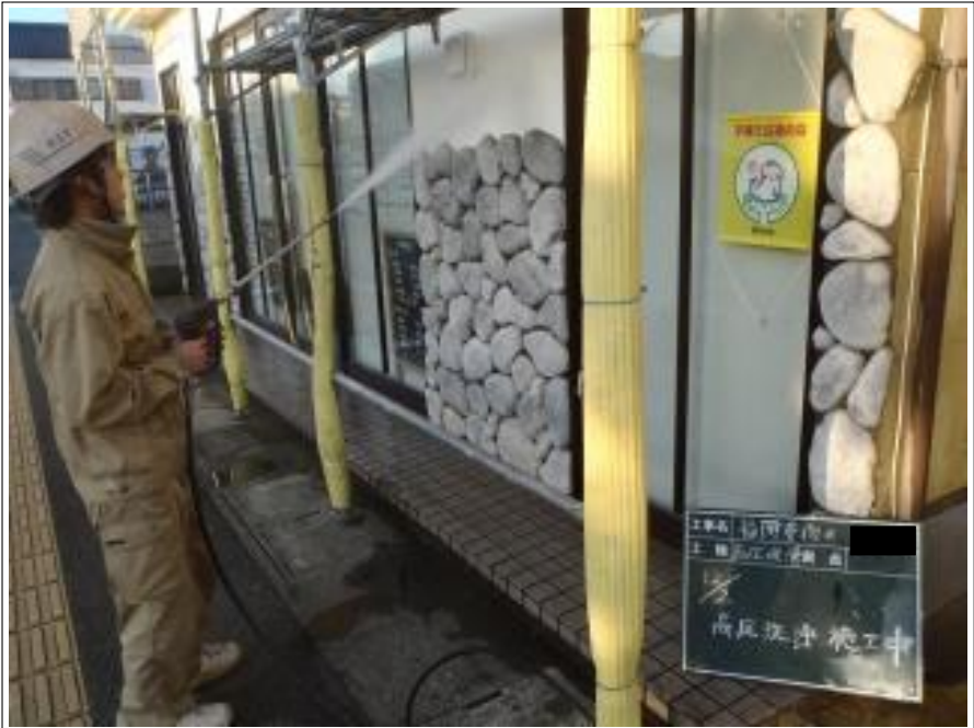
外壁高圧洗浄施工中
