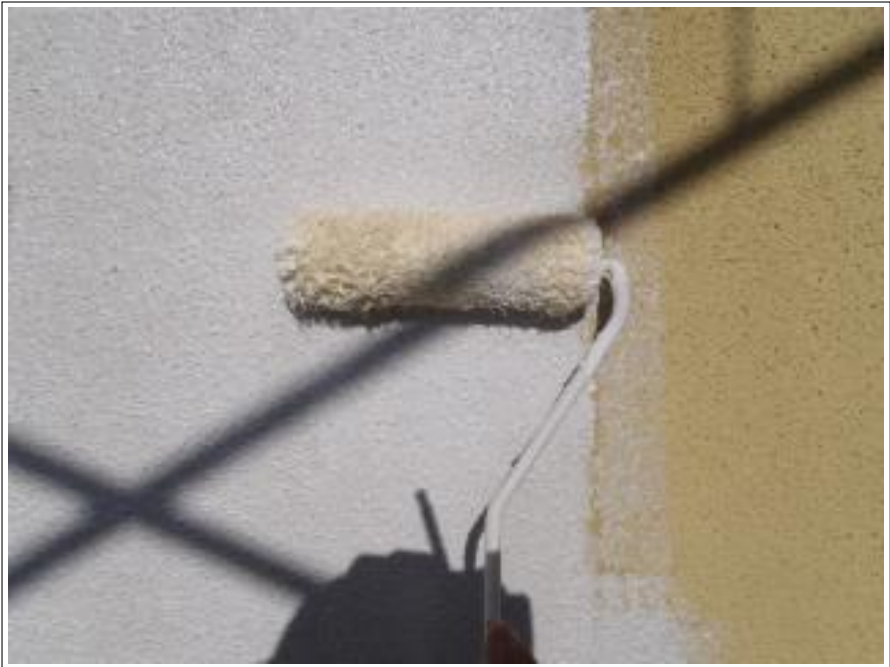
外壁下塗り塗装施工中
