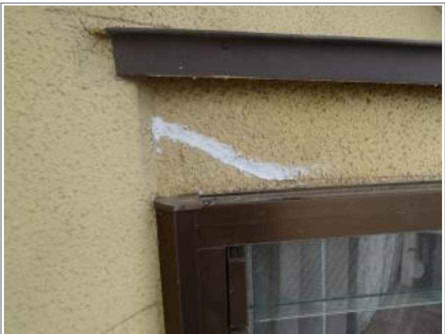
クラック補修施工後
