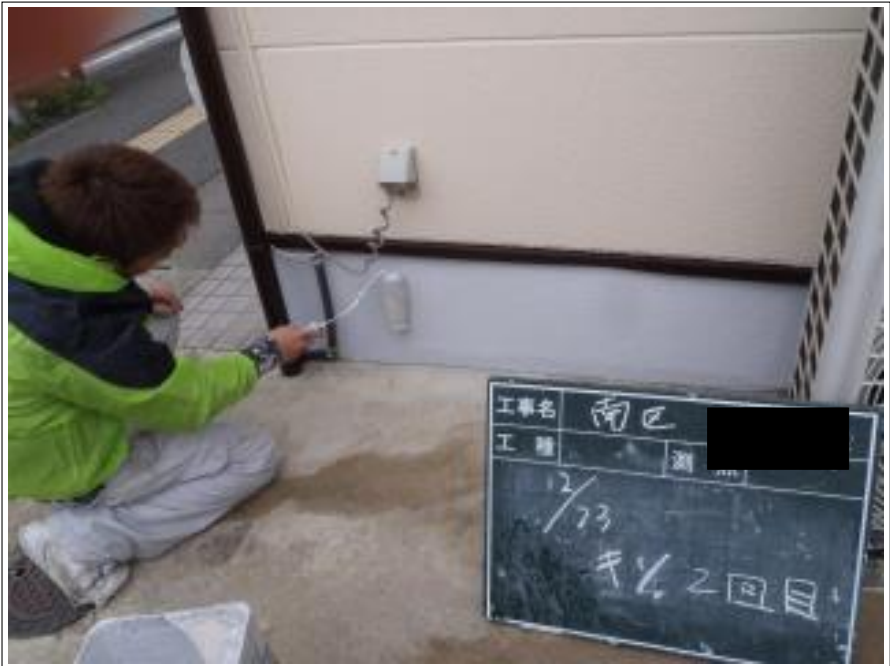
基礎塗装2回目施工中
