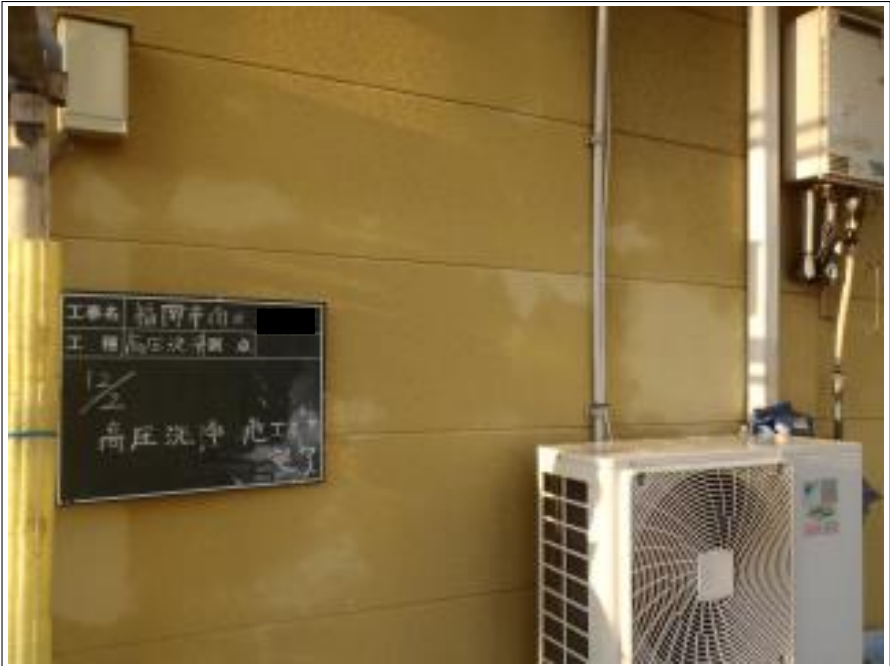
外壁高圧洗浄施工完了
