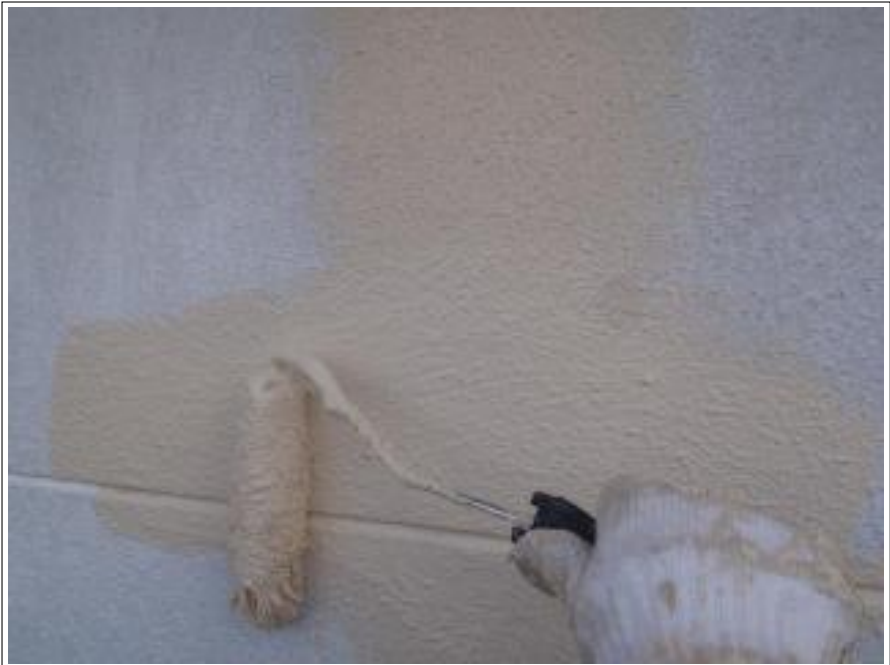
外壁中塗り塗装施工中
