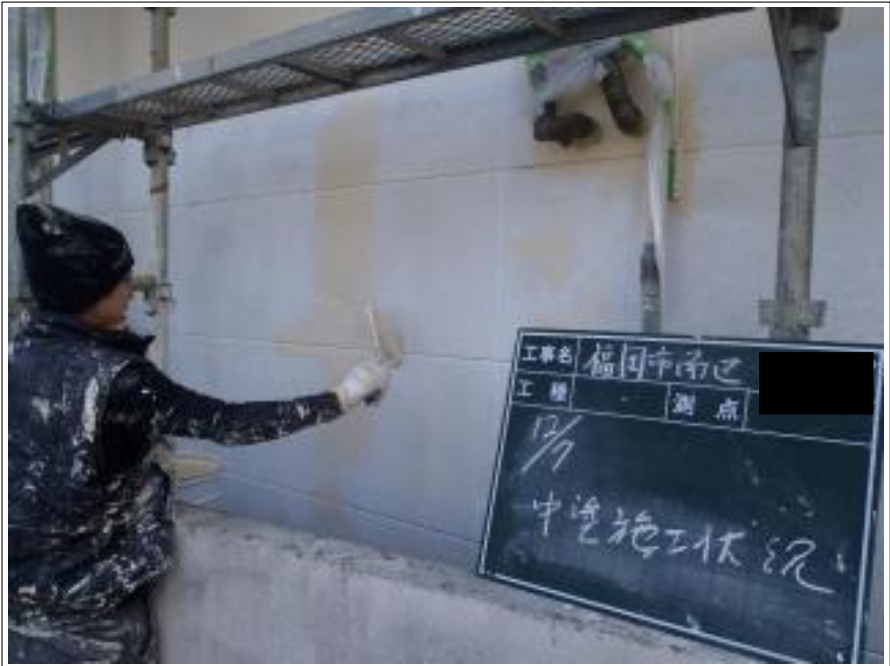
外壁中塗り塗装施工中
