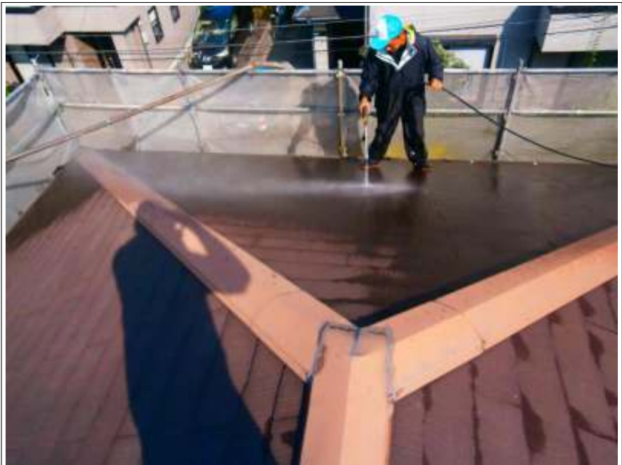
屋根高圧洗浄中
