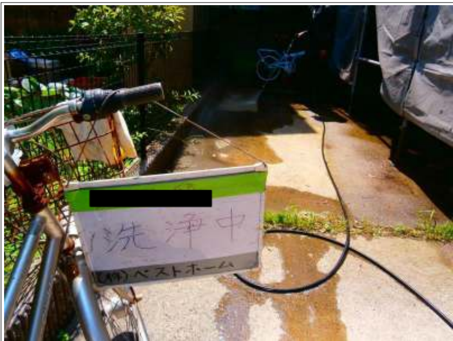
床高圧洗浄中
