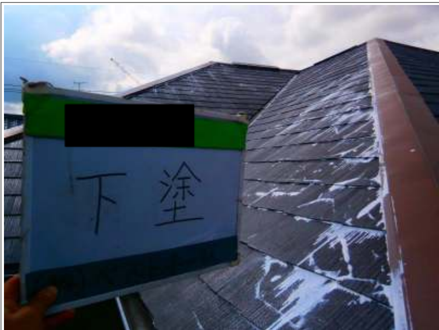
屋根下塗り塗装施工中
