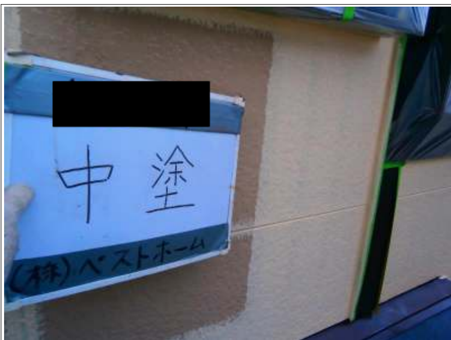
外壁中塗り塗装施工中
