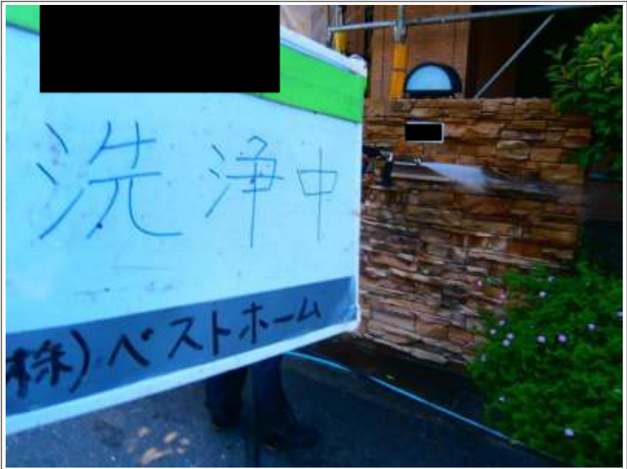
塀高圧洗浄中
