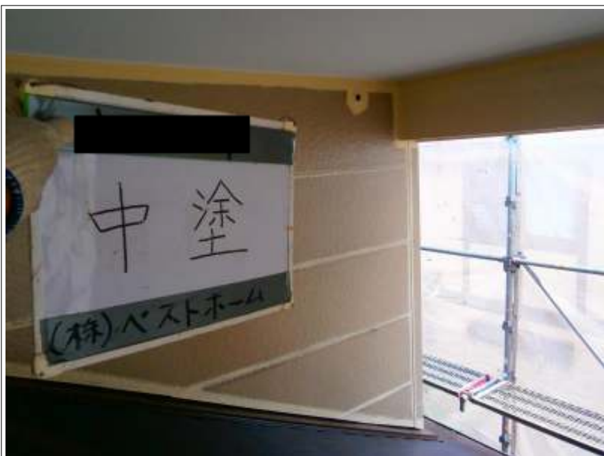
外壁中塗り塗装施工中
