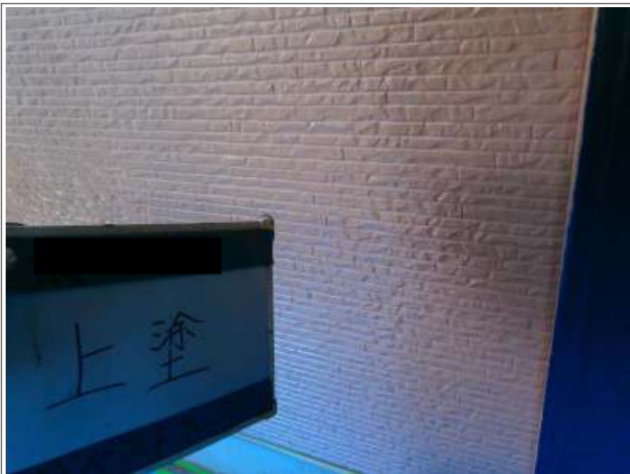
外壁上塗り塗装施工中
