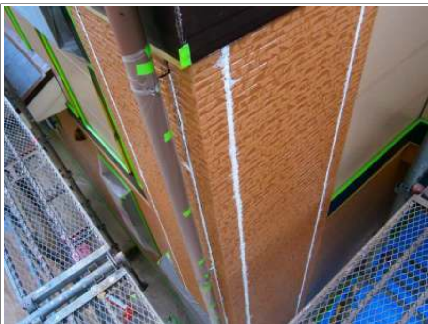
外壁コーキング補修
