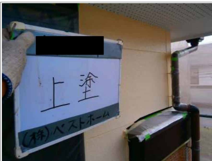
外壁上塗り塗装施工中
