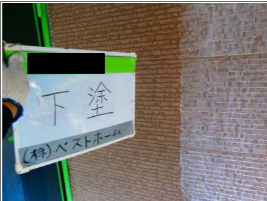
外壁下塗り塗装施工中
