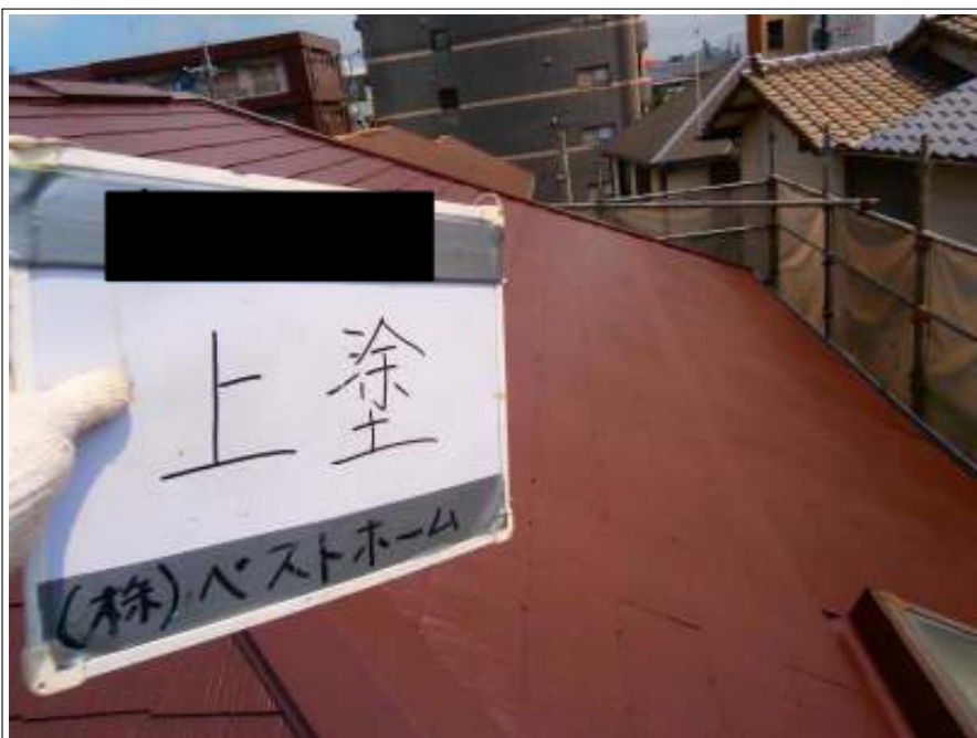
屋根上塗り塗装施工中
