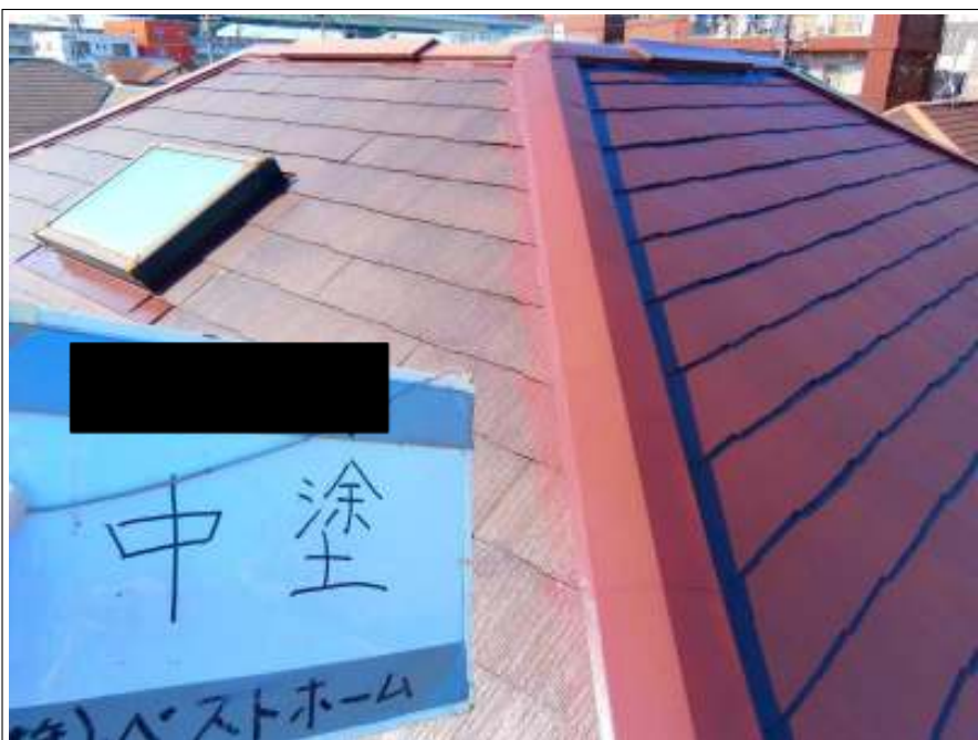
屋根中塗り塗装施工中
