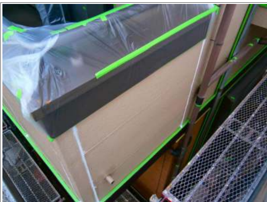
外壁コーキング補修
