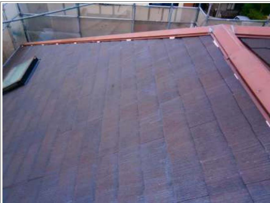
屋根コーキング補修
