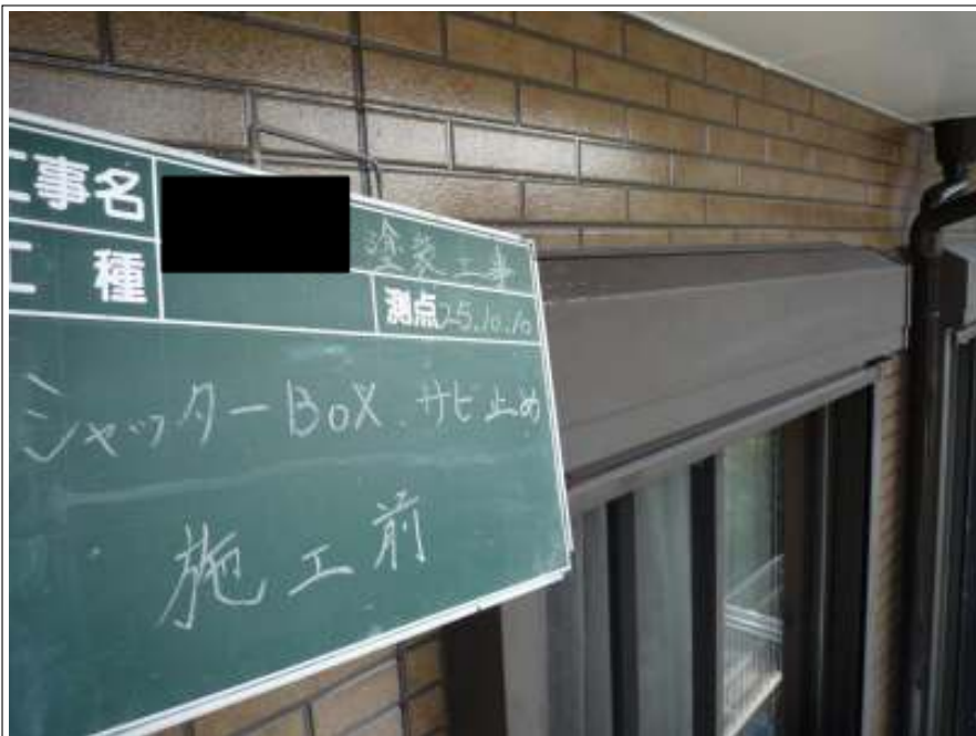
シャッターBOXサビ止め施工前
