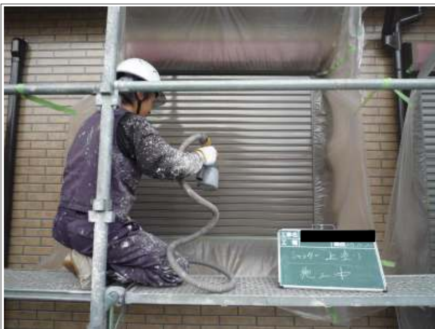
シャッター上塗り施工中
