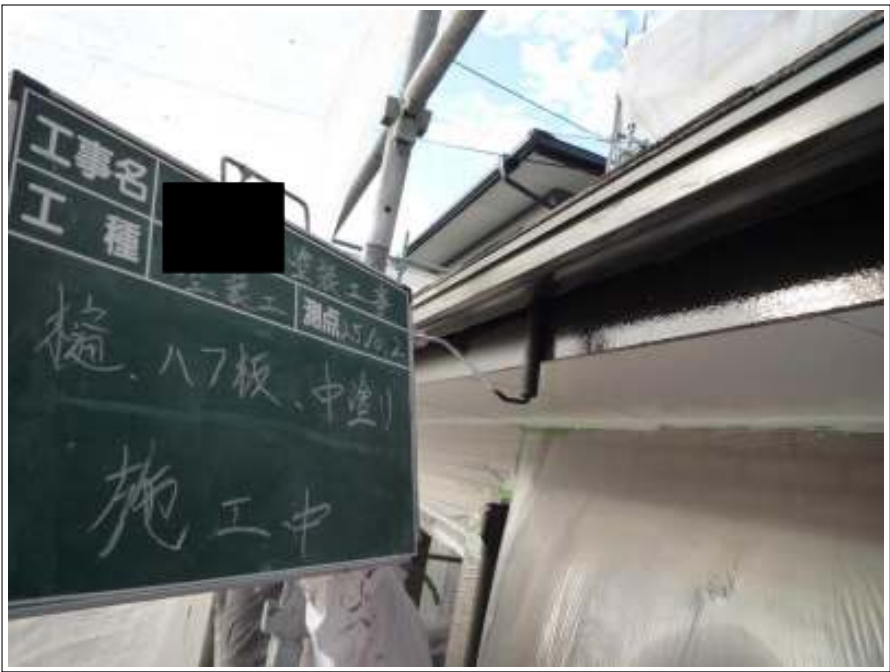
樋. ハフ板塗装中塗り施工中
