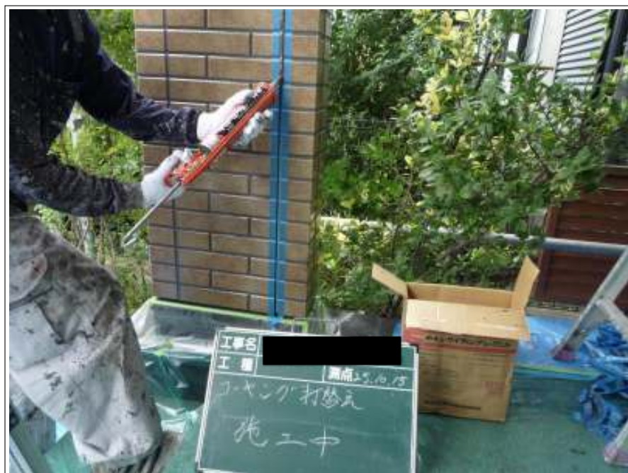
コーキング打替え施工中
