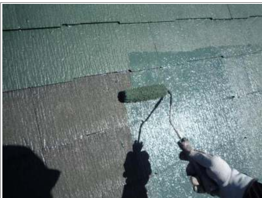
屋根塗装中塗り施工中
