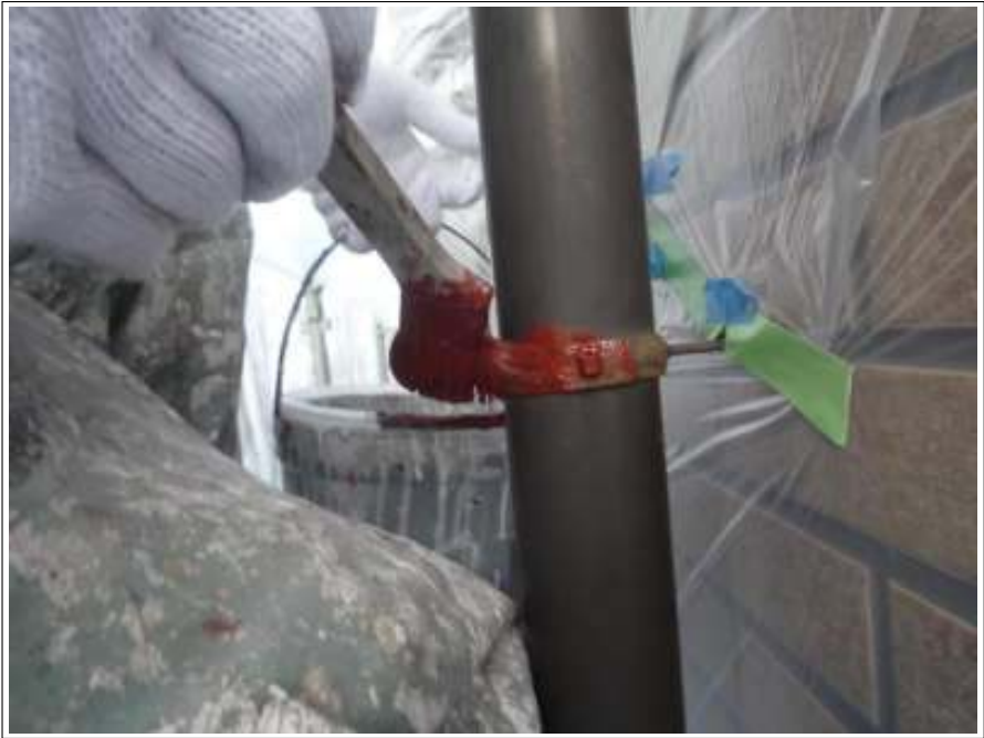
樋金具サビ止め施工中
