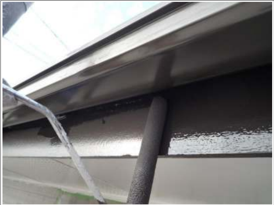
樋. ハフ板塗装中塗り施工中
