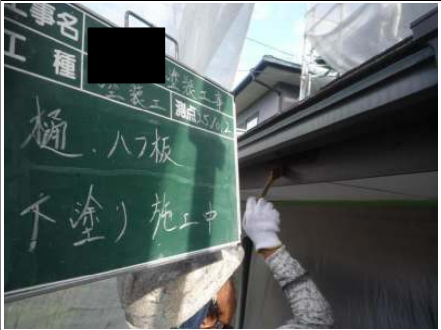
樋・ハフ板塗装下塗り施工中
