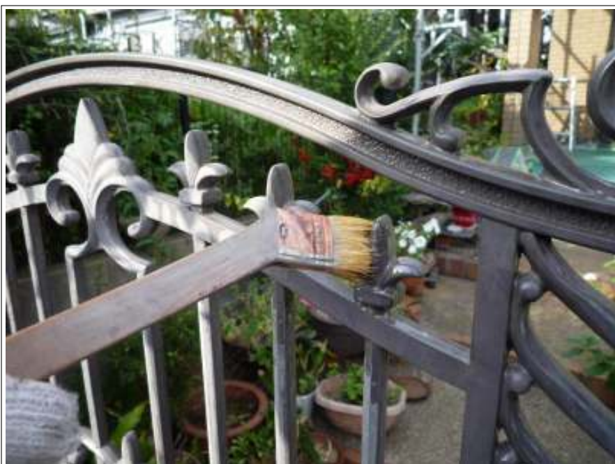
門扉下塗り施工中
