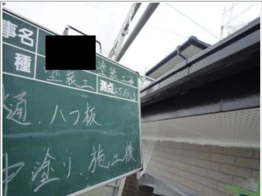
樋. ハフ板塗装中塗り施工後
