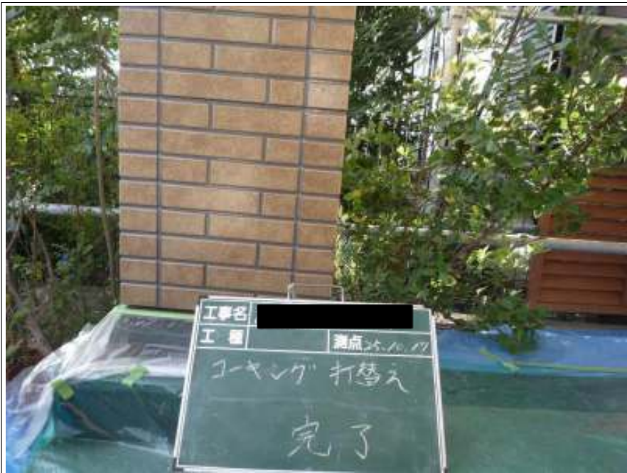
コーキング打替え完了
