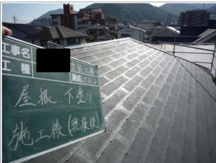
屋根塗装下塗り施工後（乾燥後）
