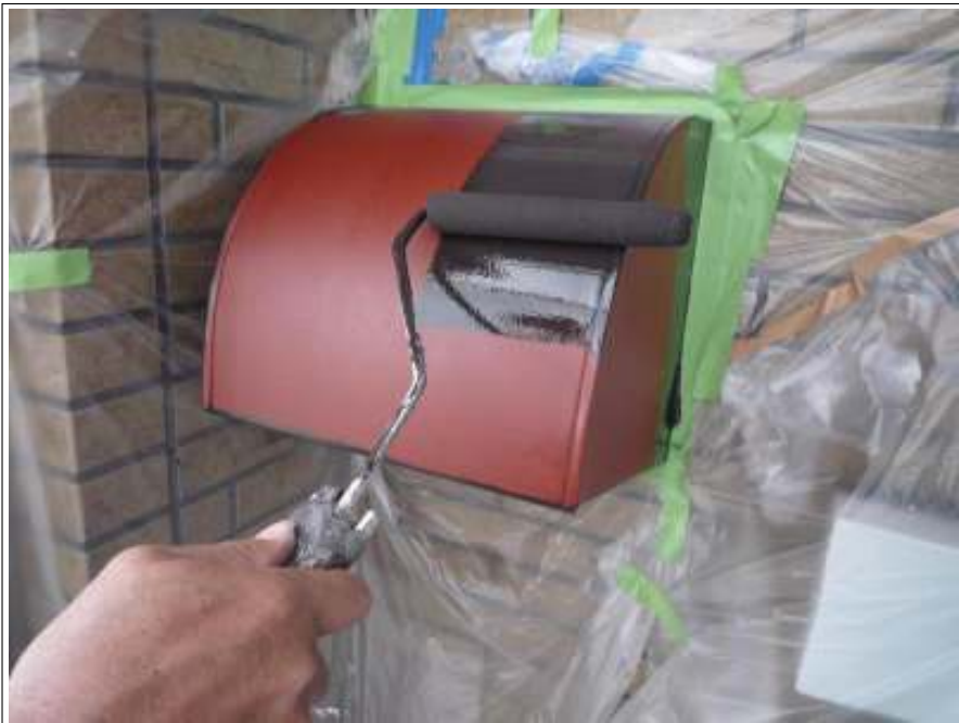
換気フード上塗り施工中
