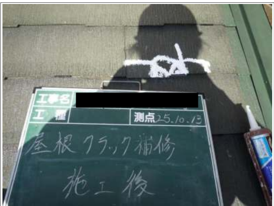
屋根クラック補修施工後
