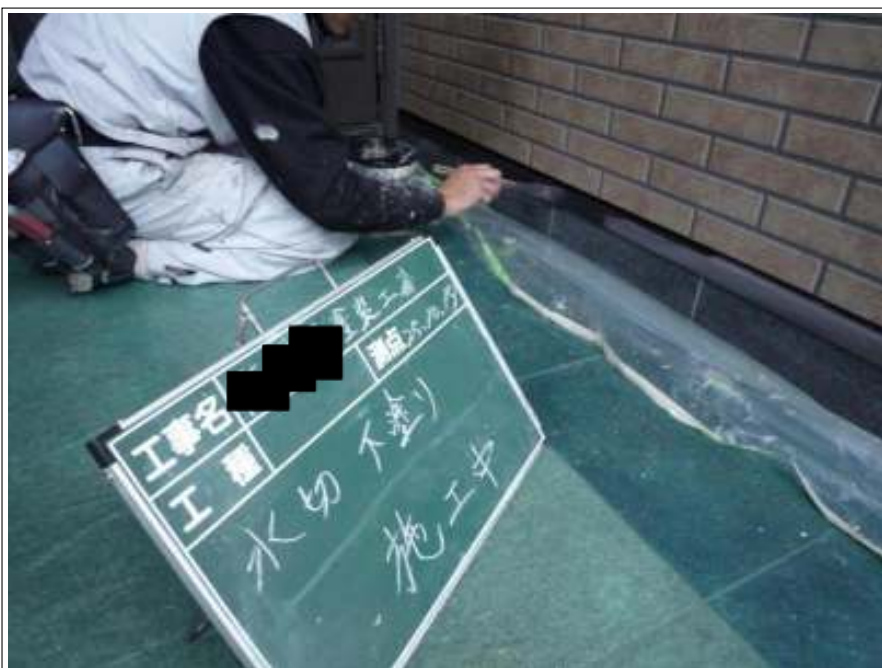
水切り塗装下塗り施工中
