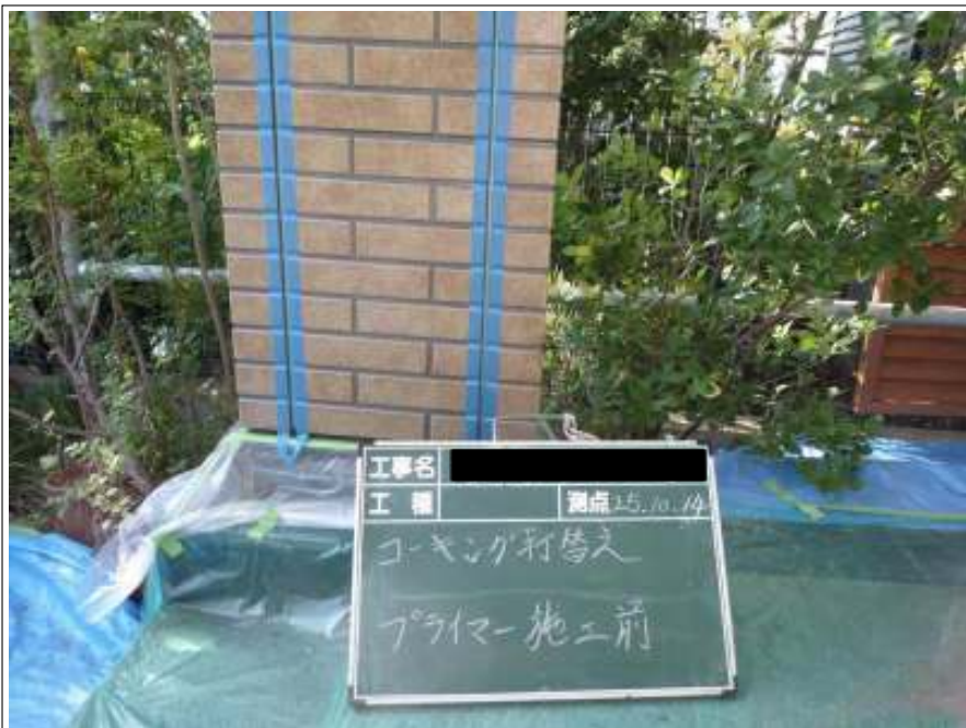
コーキング打替えプライマー施工前
