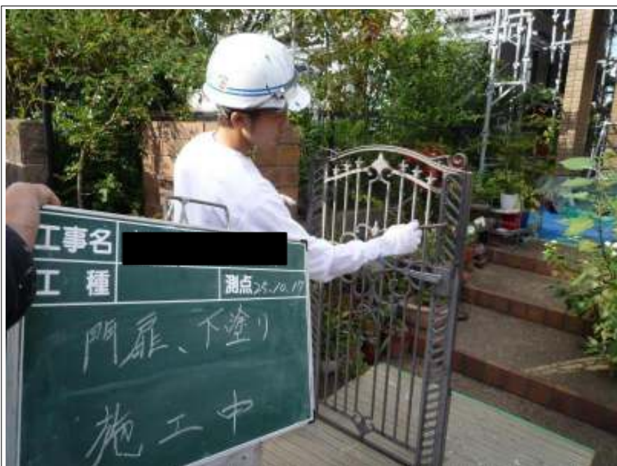
門扉下塗り施工中
