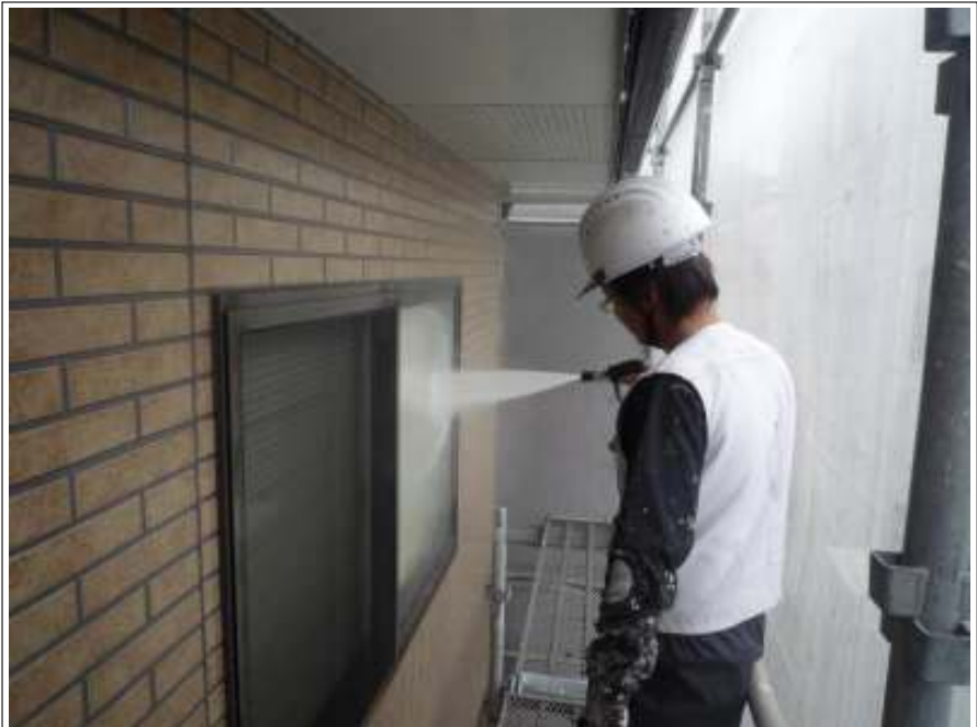
窓高压洗浄中
