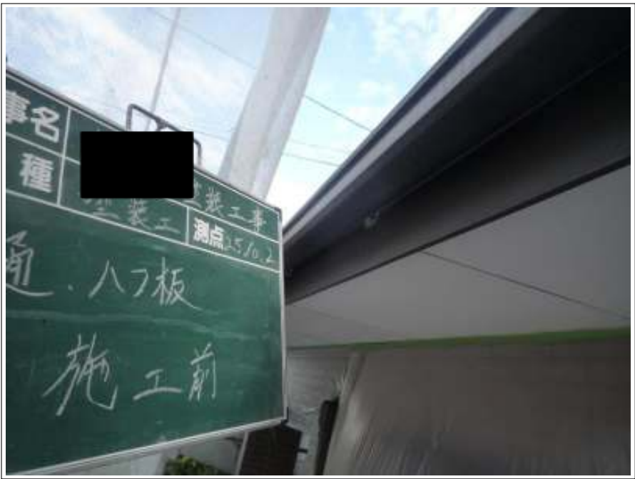
樋・ハフ板塗装施工前
