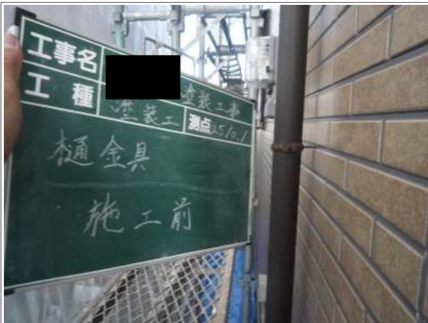
樋金具施工前
