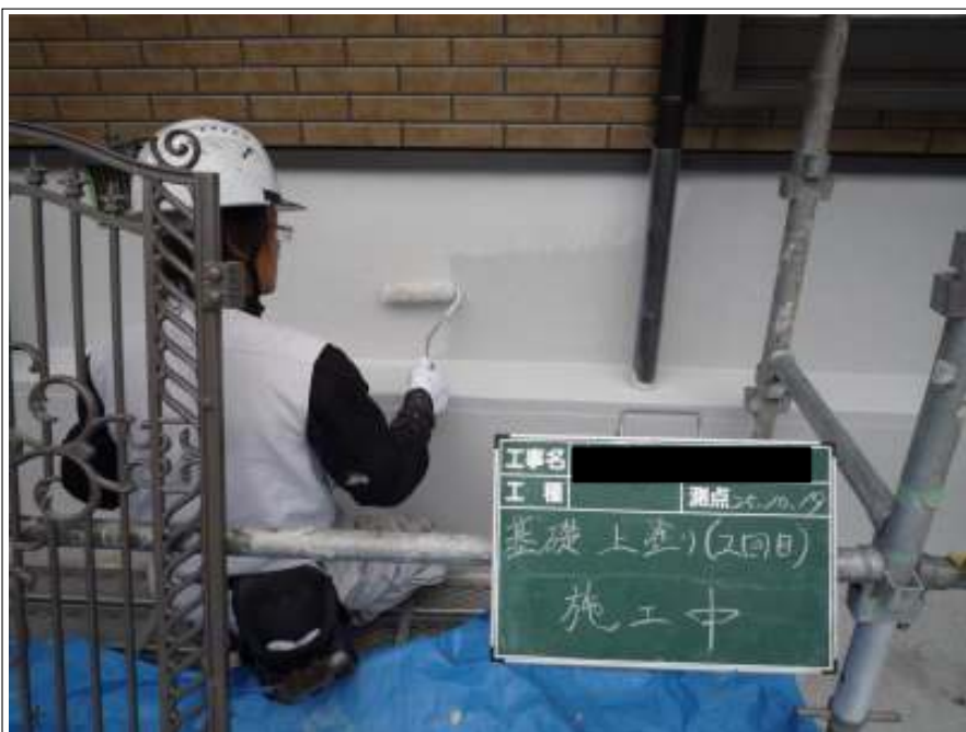
基礎 上塗り 施工中
