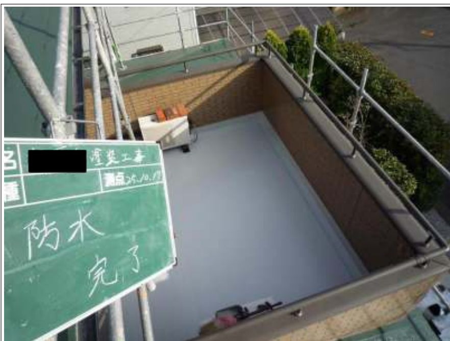
バルコニー防水完了
