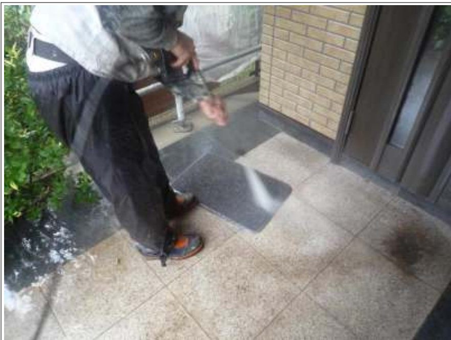
玄関前高圧洗浄中
