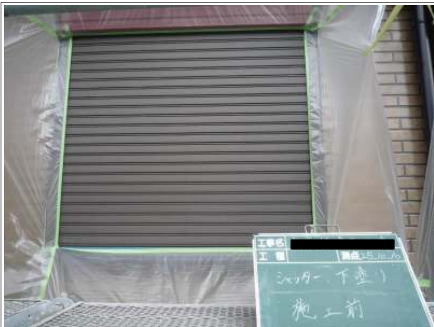
シャッター下塗り施工前
