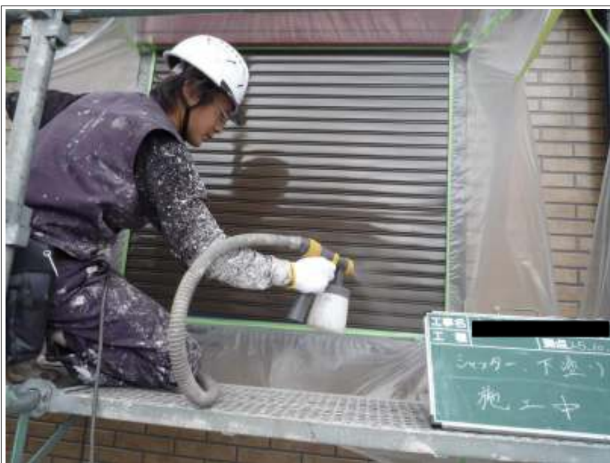
シャッター下塗り施工中
