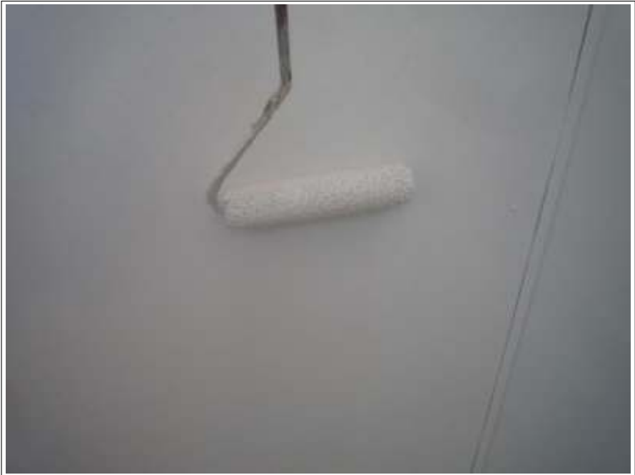
軒天塗装上塗り施工中
