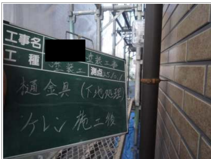
樋金具ケレン施工後
