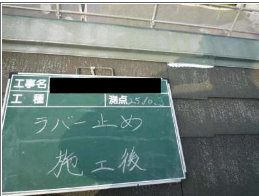
屋根 ラバー止め施工後
