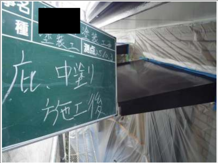
底中塗り施工後
