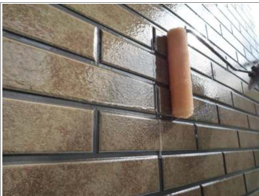
外壁塗装上塗り施工中
