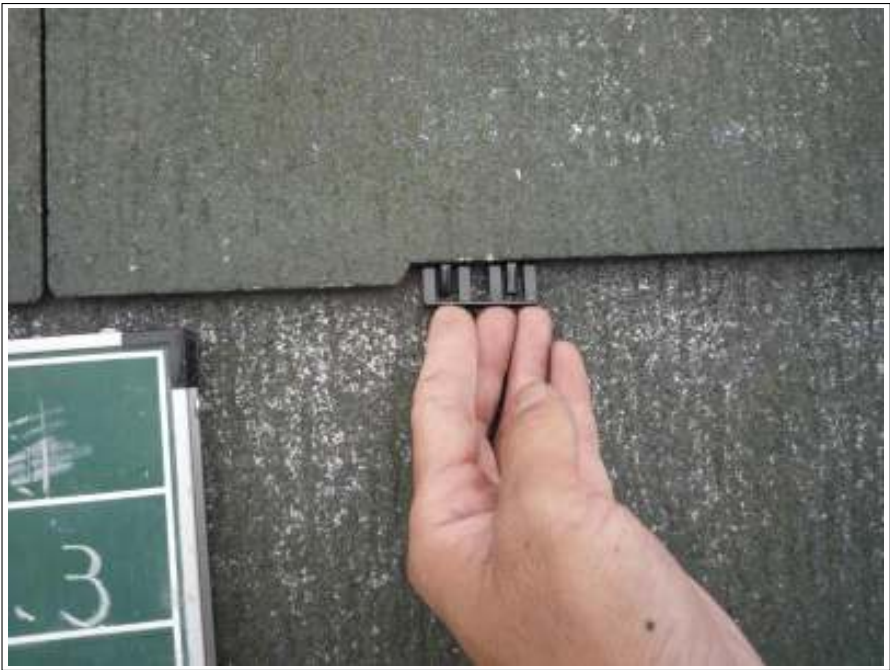
屋根 タスペーサー施工中
