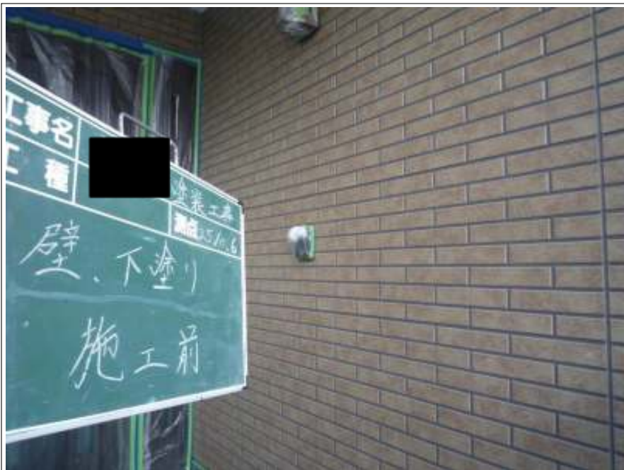
外壁塗装下塗り施工前
