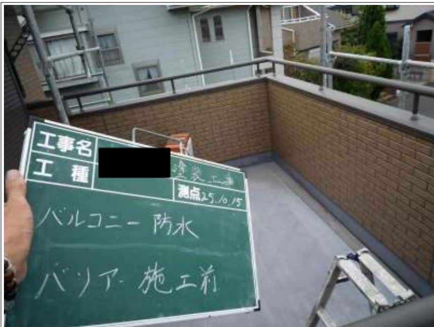
バルコニー防水バリア施工前
