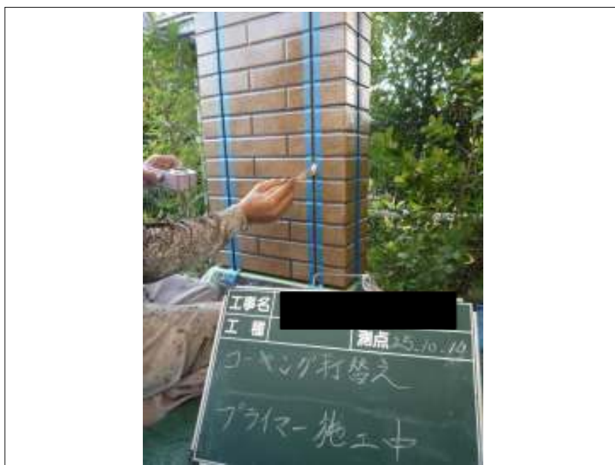
コーキング打替えプライマー施工中
