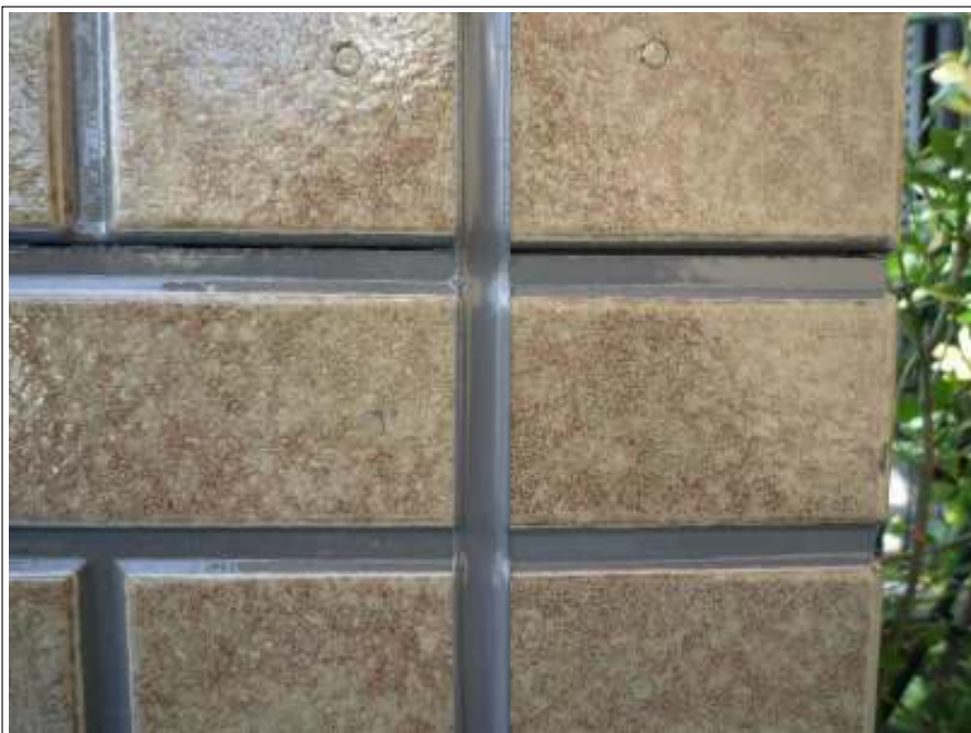
コーキング打替え完了
