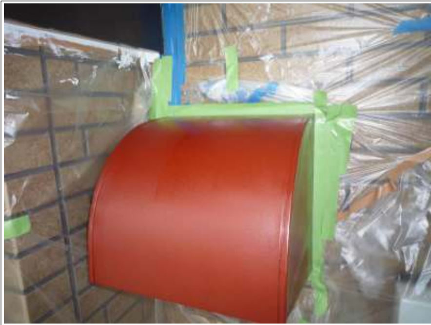
換気フードサビ止め完了
