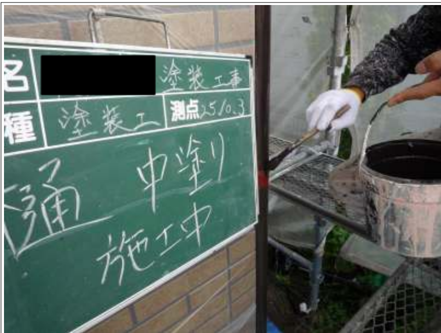
樋塗装中塗り施工中
