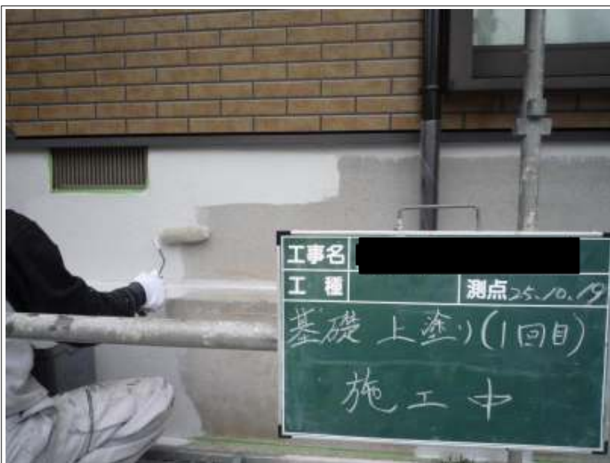
基礎 上塗り 施工中
