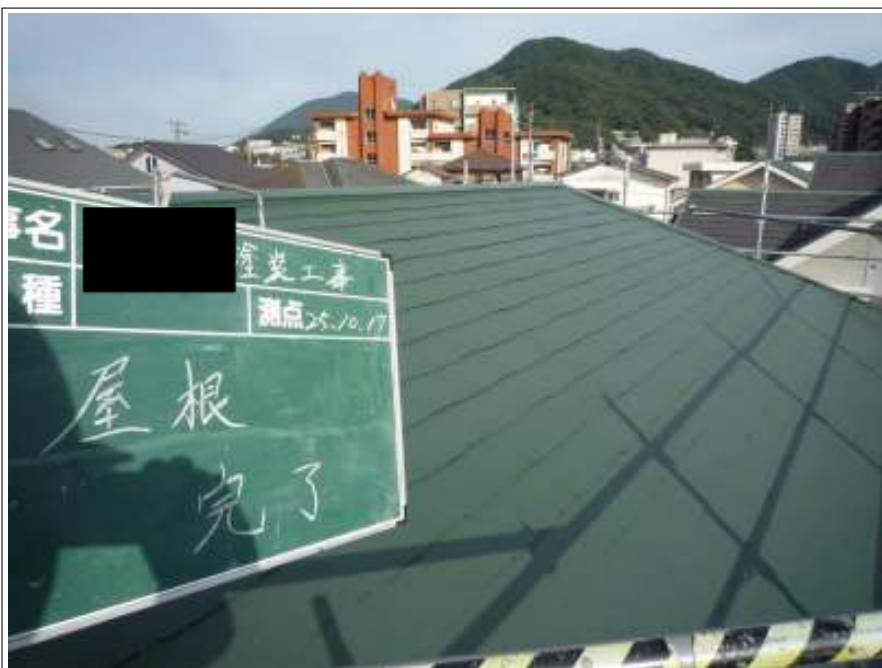
屋根塗装完了
