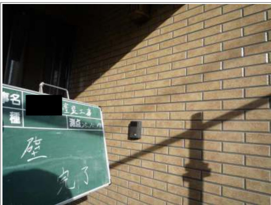
外壁塗装完了
