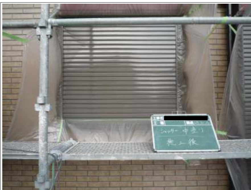
シャッター中塗り施工後
