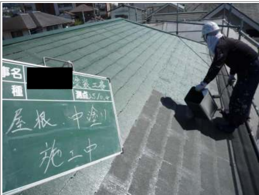
屋根塗装中塗り施工中
