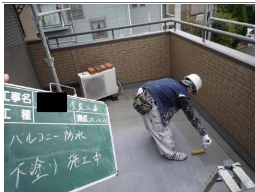
バルコニー防水下塗り施工中
