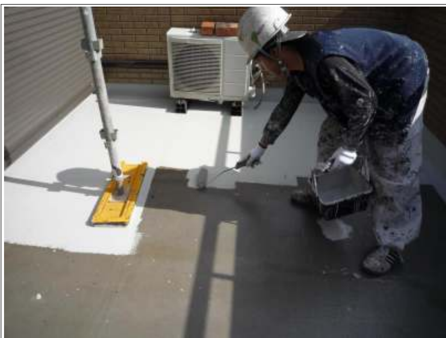
バルコニー防水上塗り施工中
