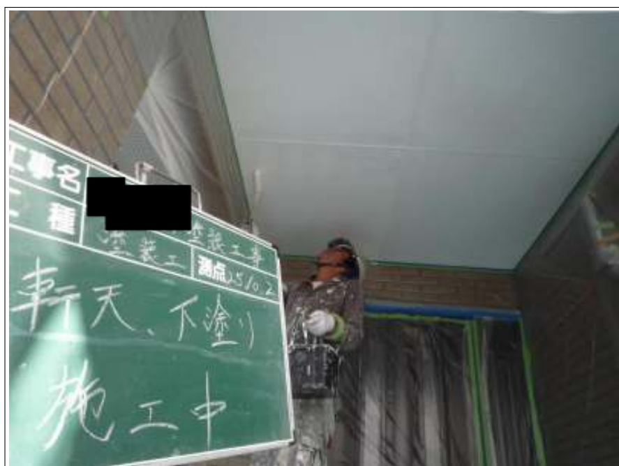
軒天塗装下塗り施工中
