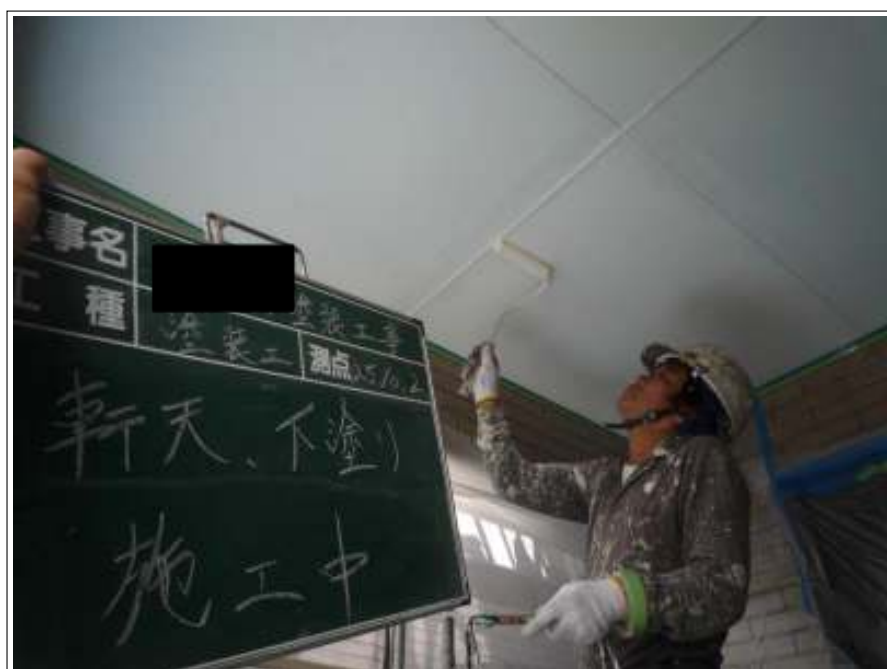
軒天塗装下塗り施工中
