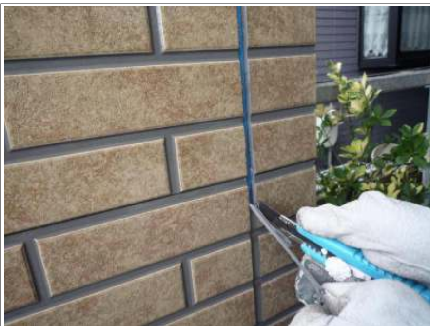
コーキング打替え除去中
