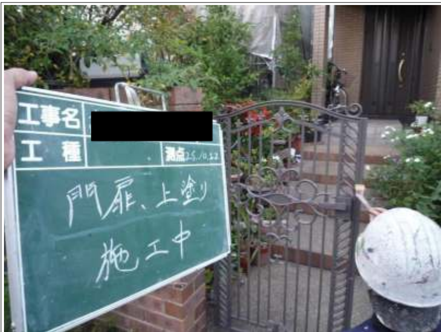
門扉上塗り施工中
