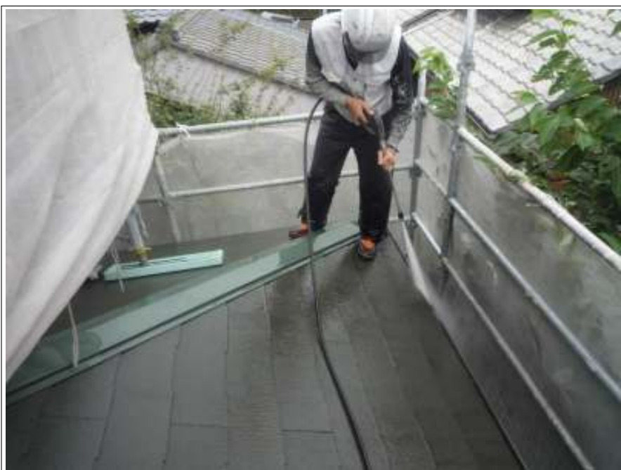
屋根高圧洗浄中
