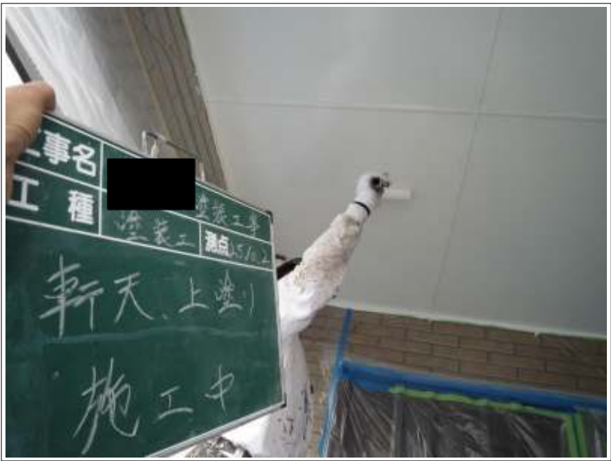
軒天塗装上塗り施工中
