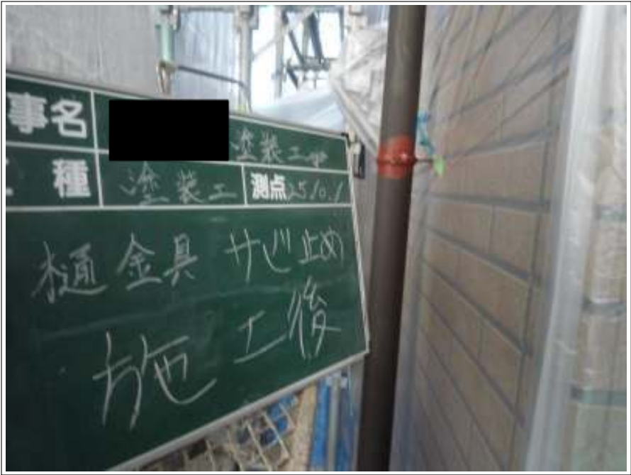
樋金具サビ止め施工後
