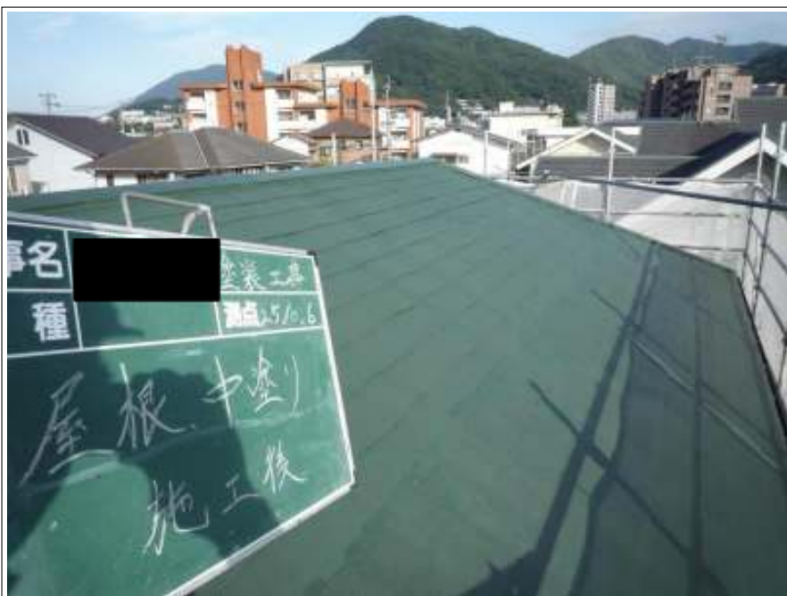
屋根塗装中塗り施工後
