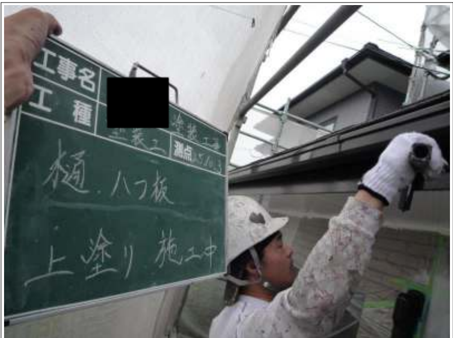
樋. ハフ板塗装上塗り施工中
