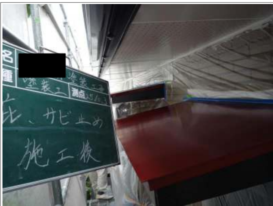
底サビ止め施工後
