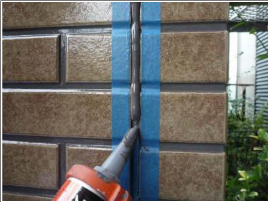
コーキング打替え施工中
