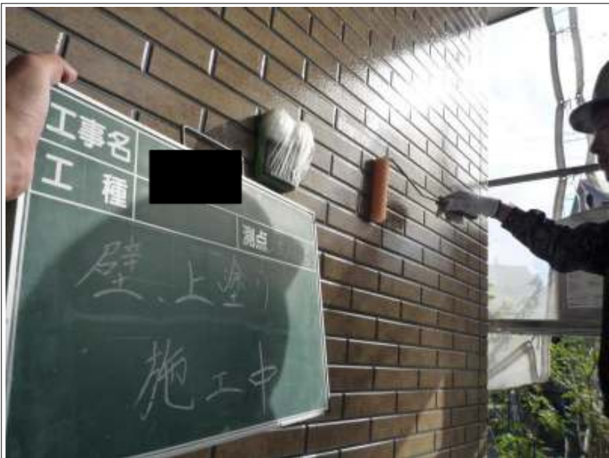
外壁塗装上塗り施工中
