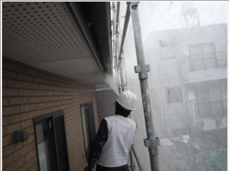
軒天高压洗浄中
