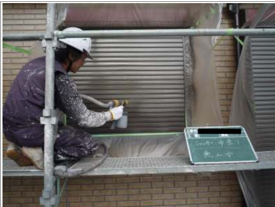
シャッター中塗り施工中
