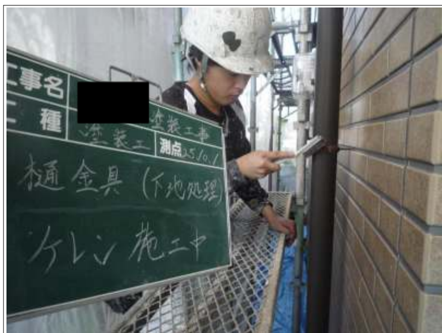
樋金具ケレン施工中
