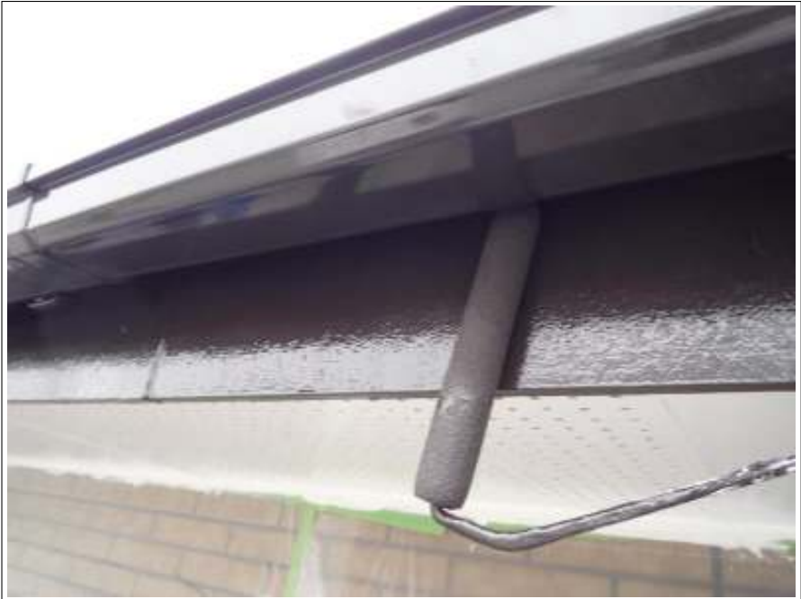
樋. ハフ板塗装上塗り施工中
