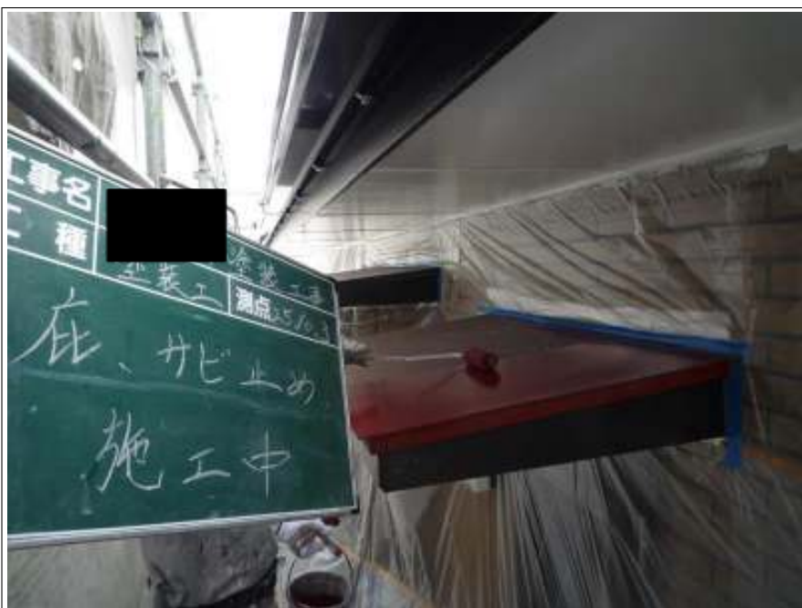
底サビ止め施工中
