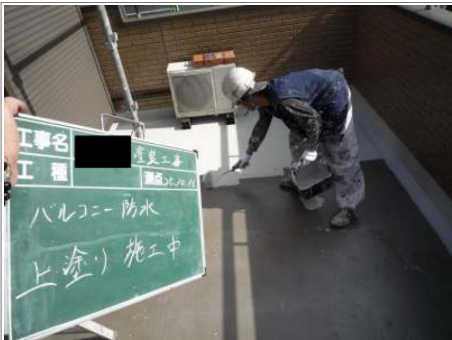
バルコニー防水上塗り施工中
