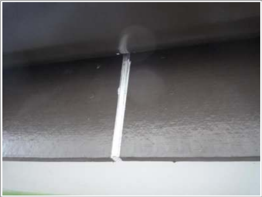
ハフ板コーキング補修施工後
