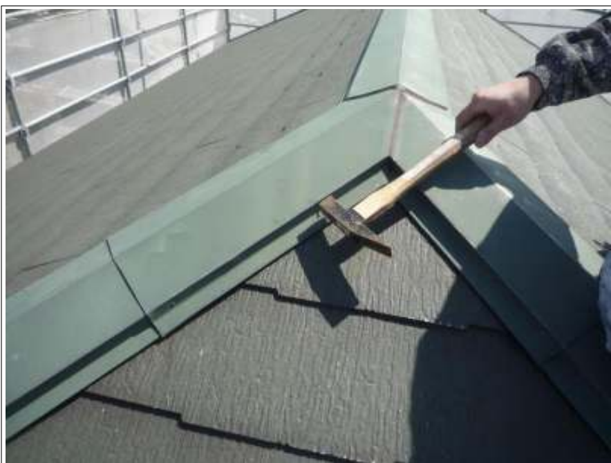
棟鉄板補修施工中
