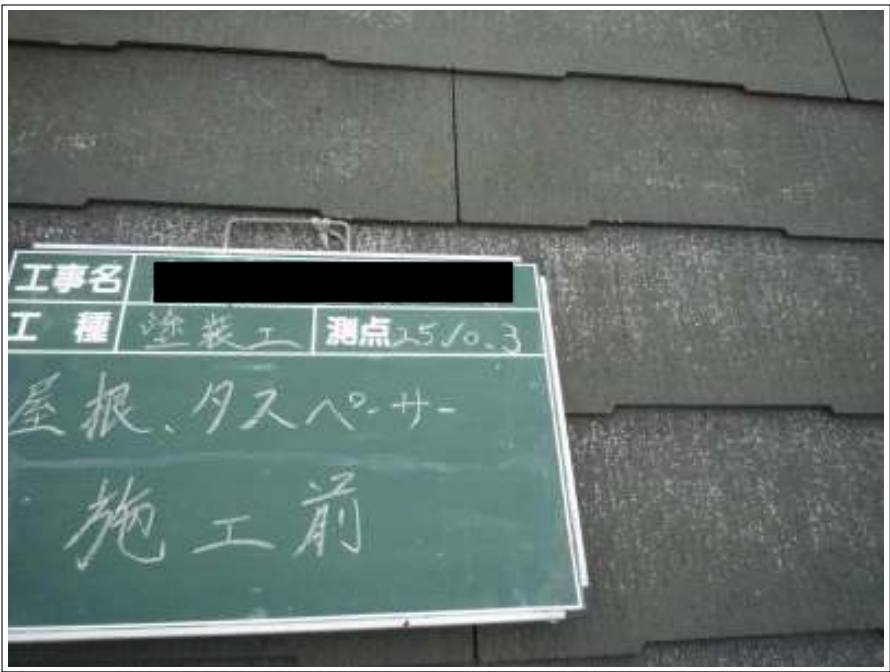
屋根 タスペーサー施工前
