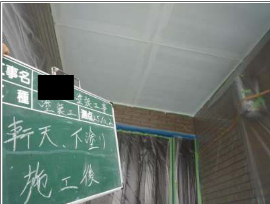
軒天塗装下塗り施工後
