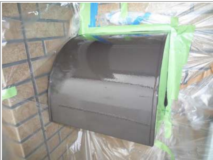
換気フード塗装完了
