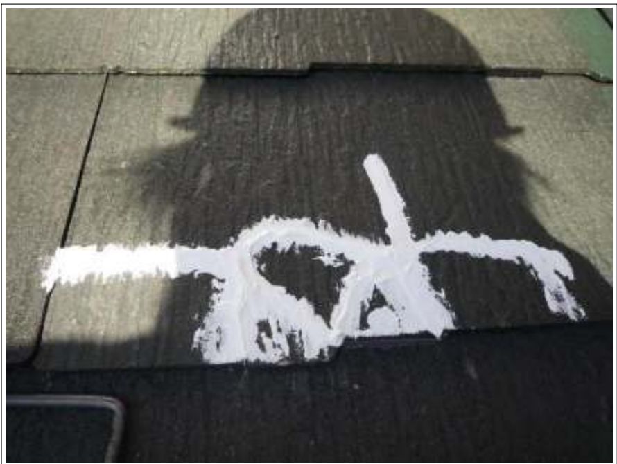
屋根クラック補修施工後
