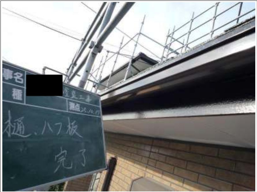
樋. ハフ板塗装完了
