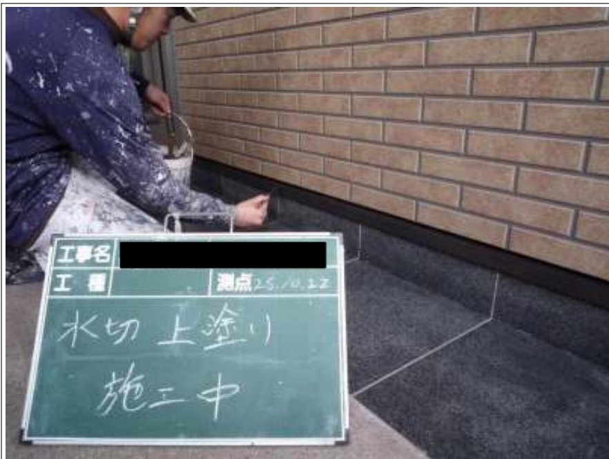
水切り塗装上塗り施工中
