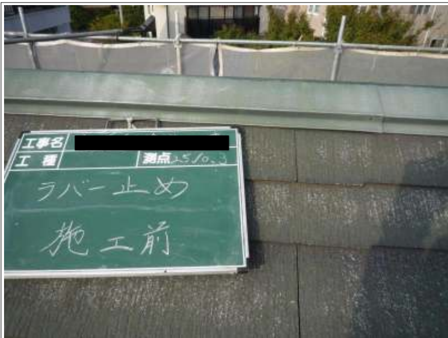
屋根 ラバー止め施工前
