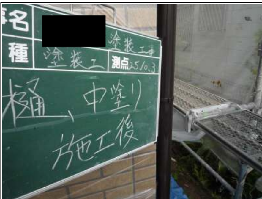
樋塗装中塗り施工後
