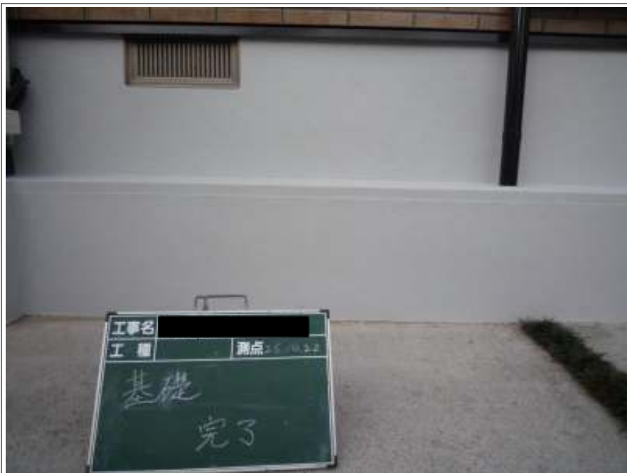
基礎塗装完了
