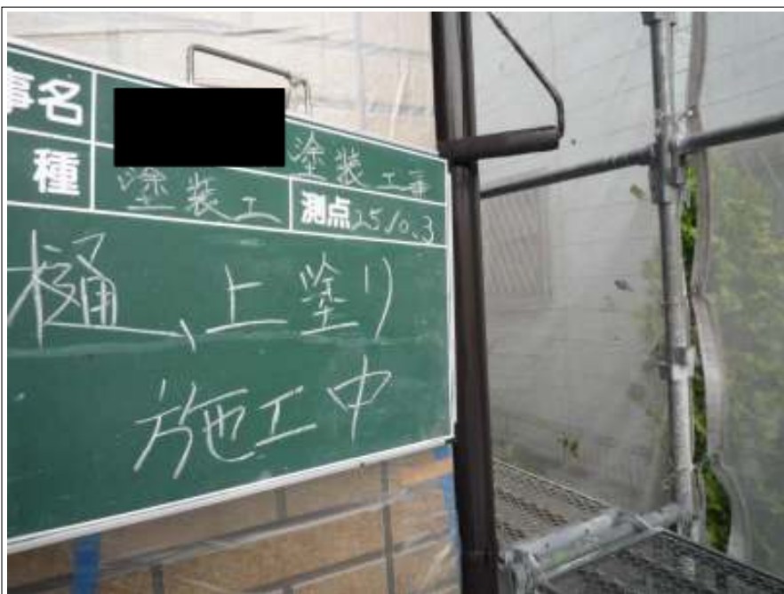
樋塗装上塗り施工中
