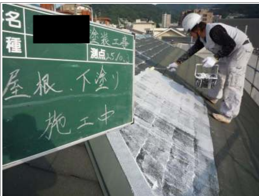
屋根塗装下塗り施工中
