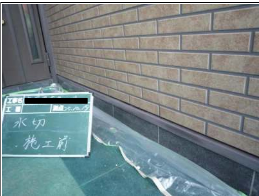
水切り施工前
