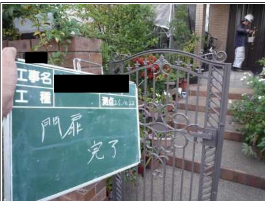
門扉塗装完了
