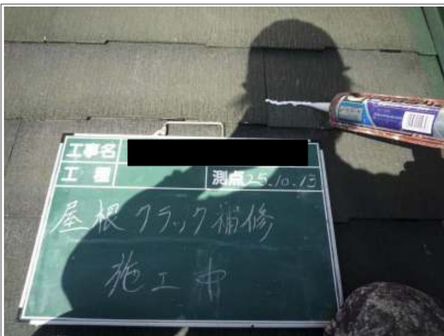
屋根クラック補修施工中
