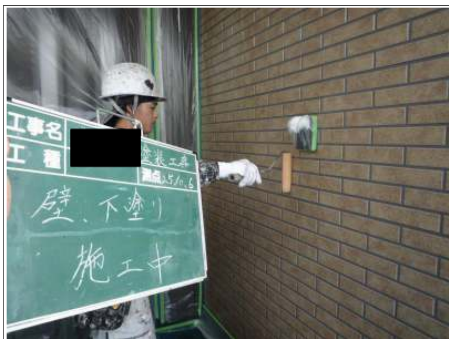
外壁塗装下塗り施工中
