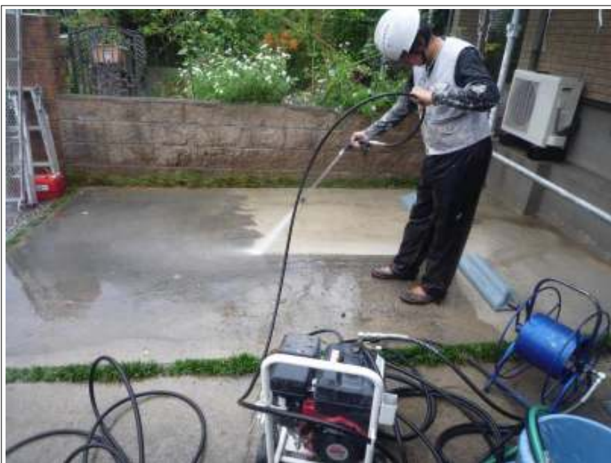
駐車場床高圧洗浄中
