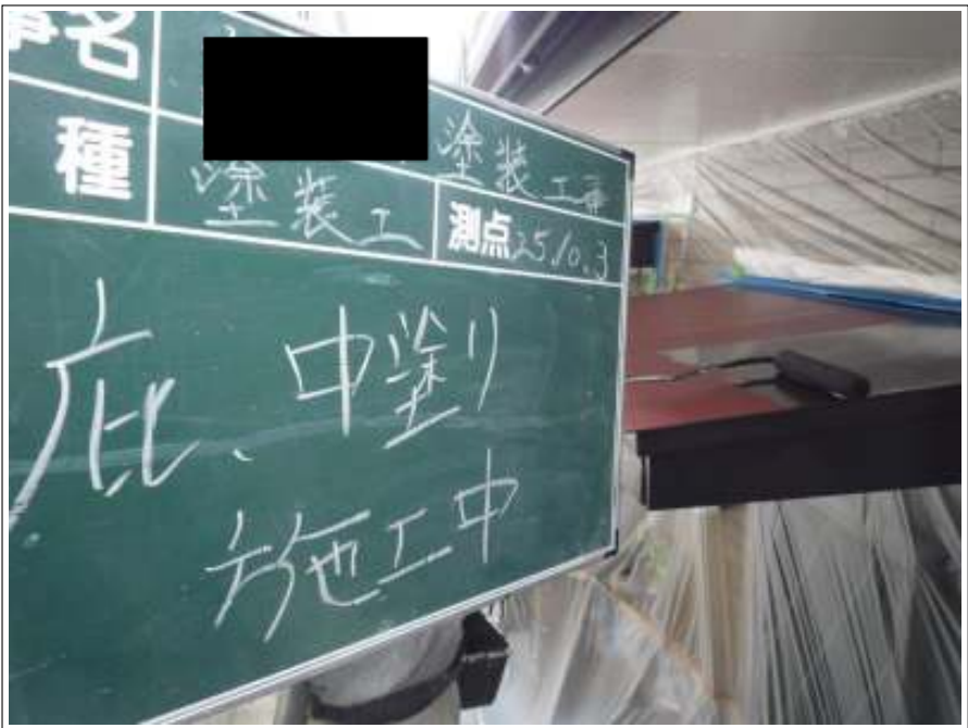
底中塗り施工中
