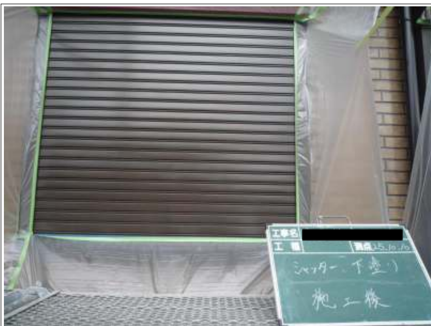
シャッター下塗り施工後
