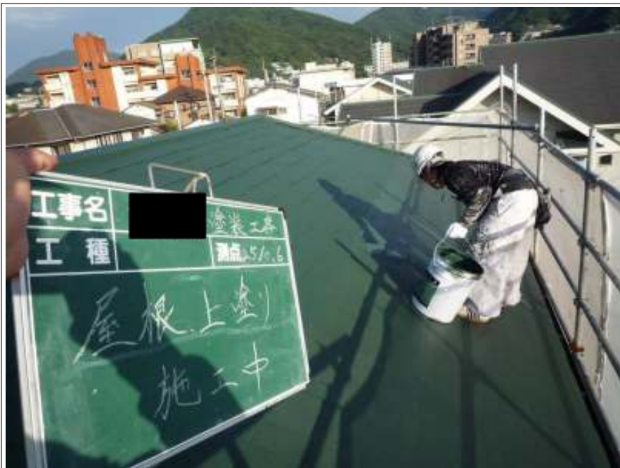
屋根塗装上塗り施工中
