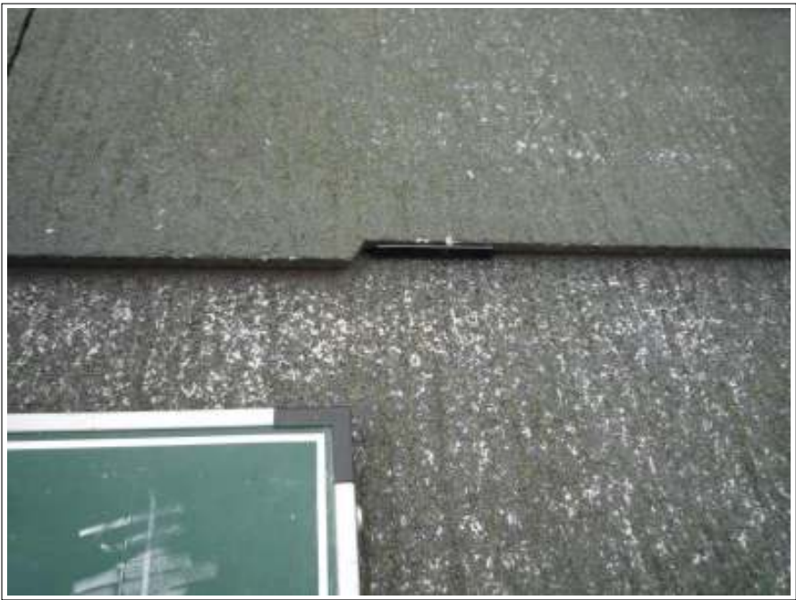
屋根 タスペーサー施工後
