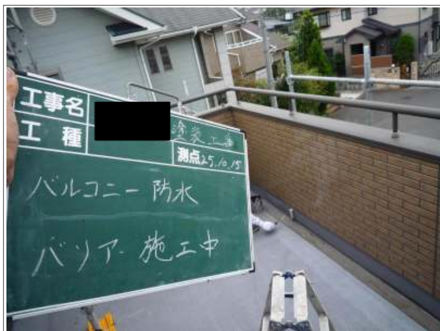
バルコニー防水バリア施工中
