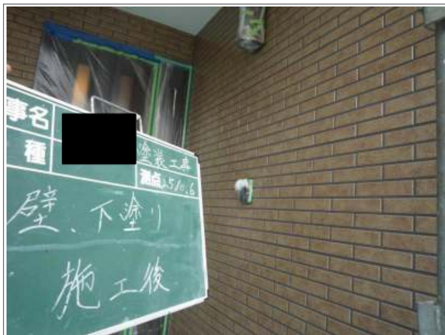
外壁塗装下塗り施工後
