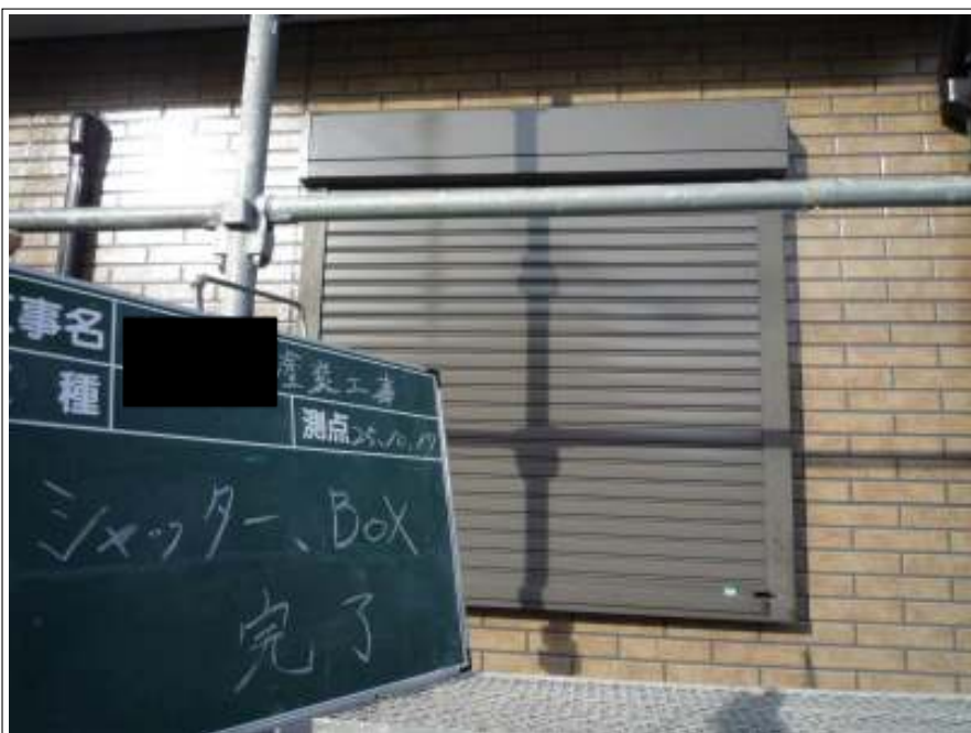
シャッターBOX完了
