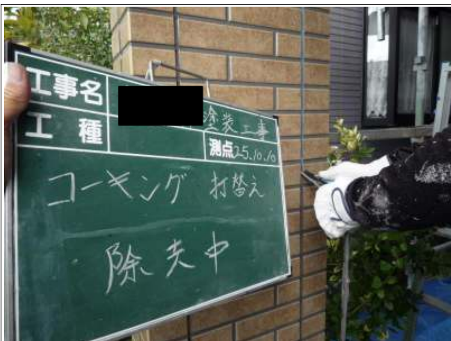
コーキング打替え除去中
