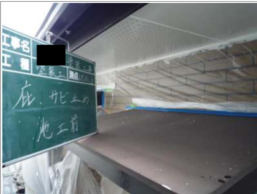
底サビ止め施工前
