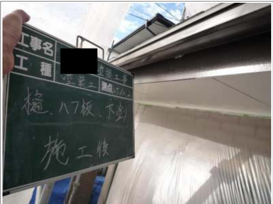
樋・ハフ板塗装下塗り施工後
