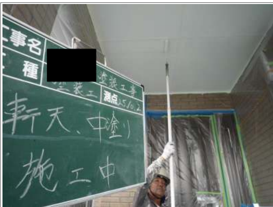
軒天塗装中塗り施工中
