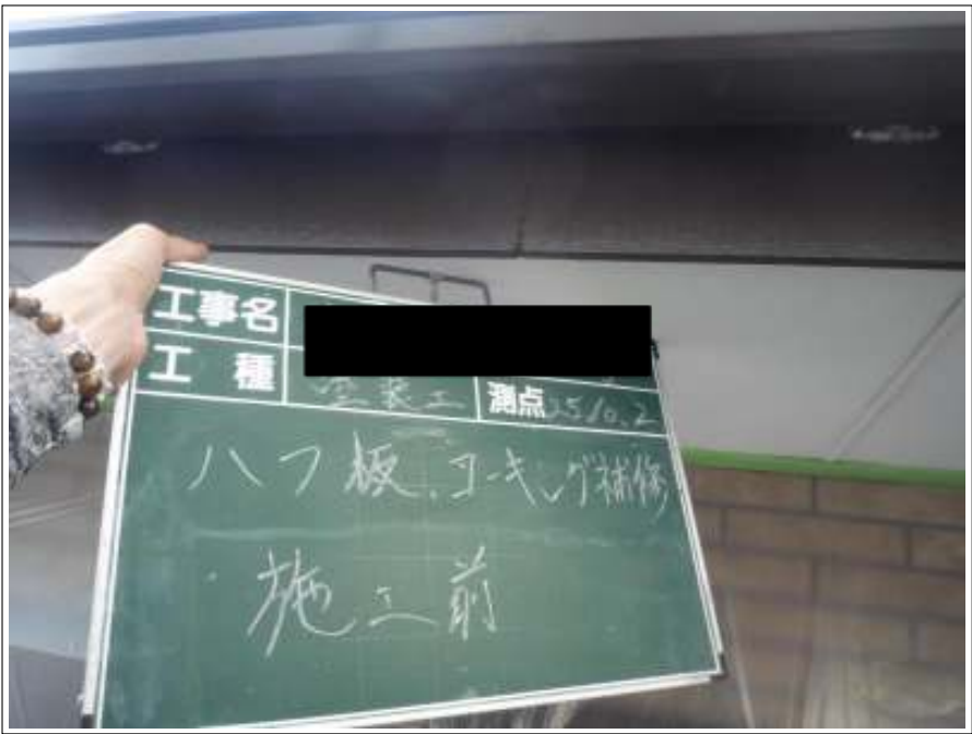
ハフ板. コーキング補修施工前
