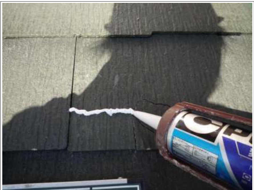
屋根クラック補修施工中
