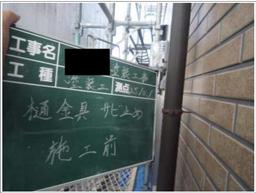
樋金具サビ止め施工前
