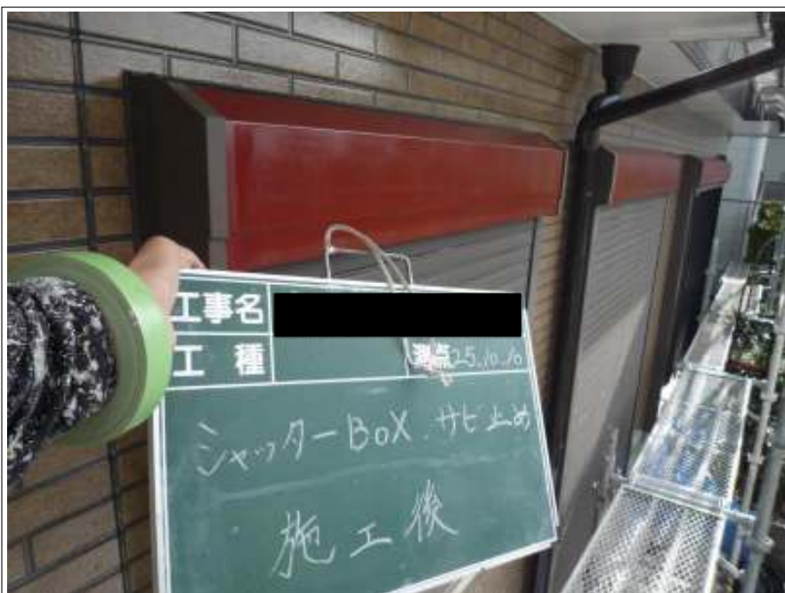
シャッターBOXサビ止め施工後
