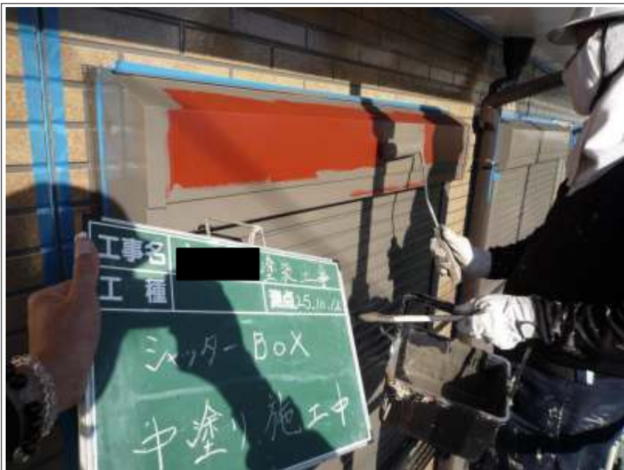
シャッターBOX中塗り施工中
