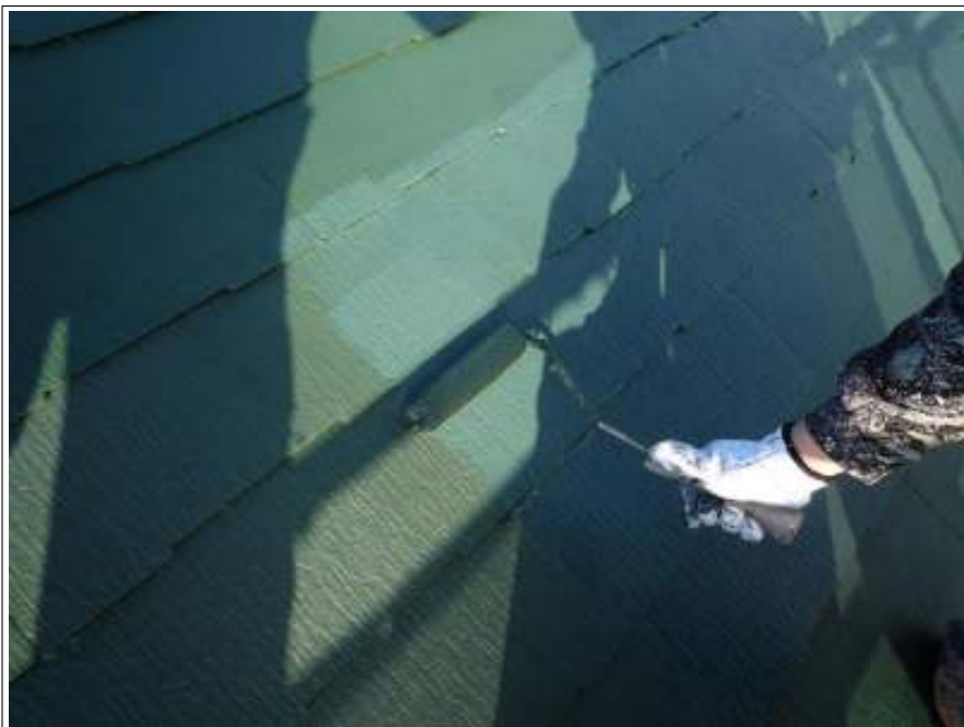
屋根塗装上塗り施工中
