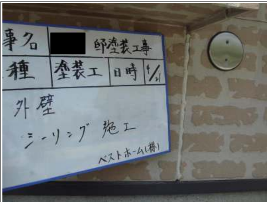
シーリング施工状況
