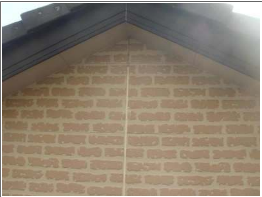
シーリング補修施工前
