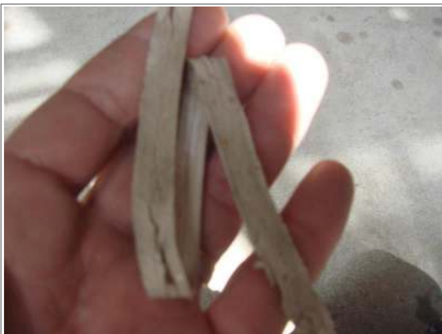
シーリング撤去施工完了
