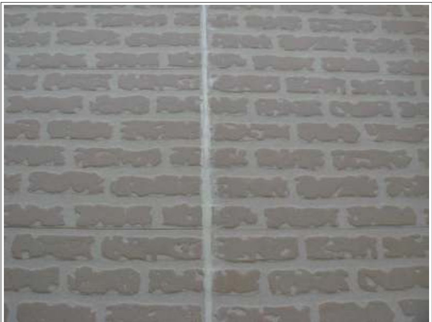
シーリング施工完了
