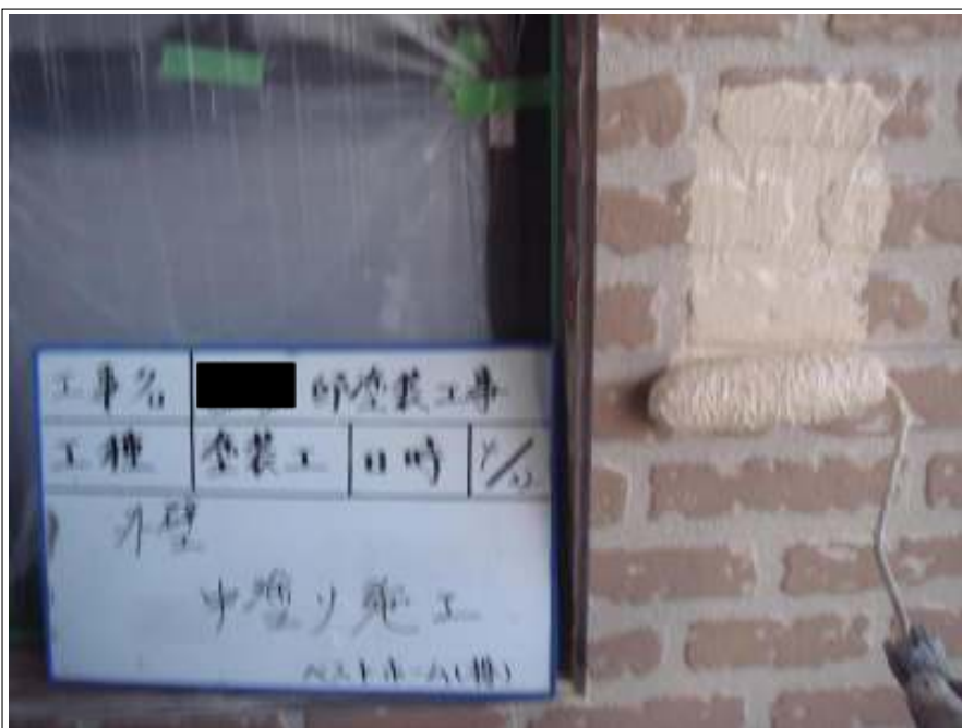
中塗り施工状況
