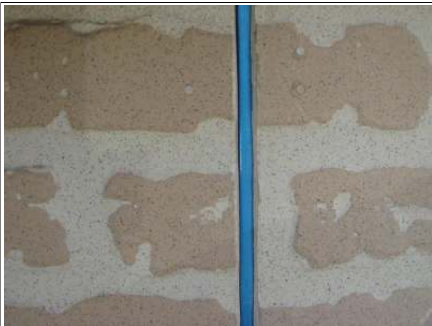
シーリング撤去施工中
