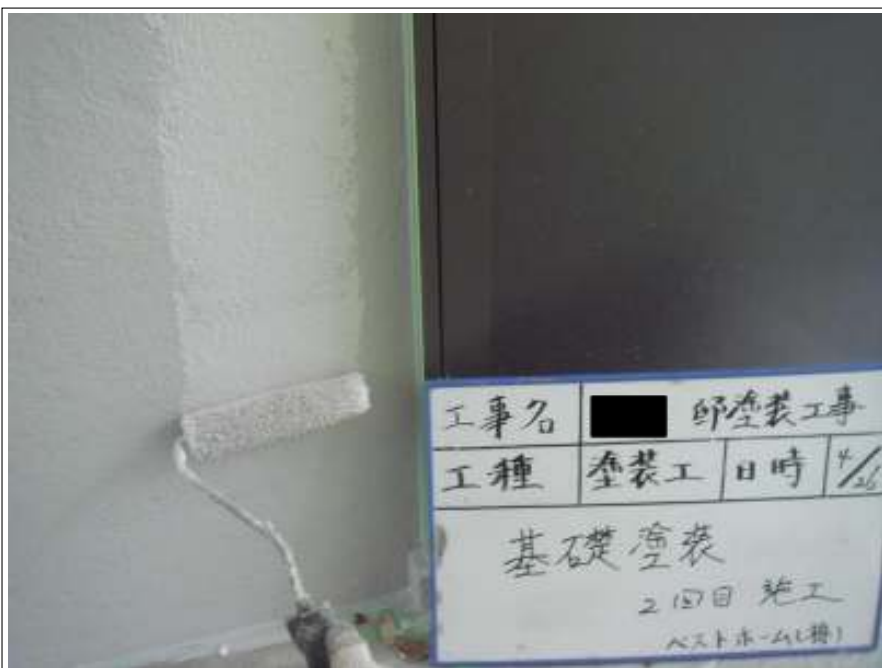
基礎塗装施工状況（2回目）
