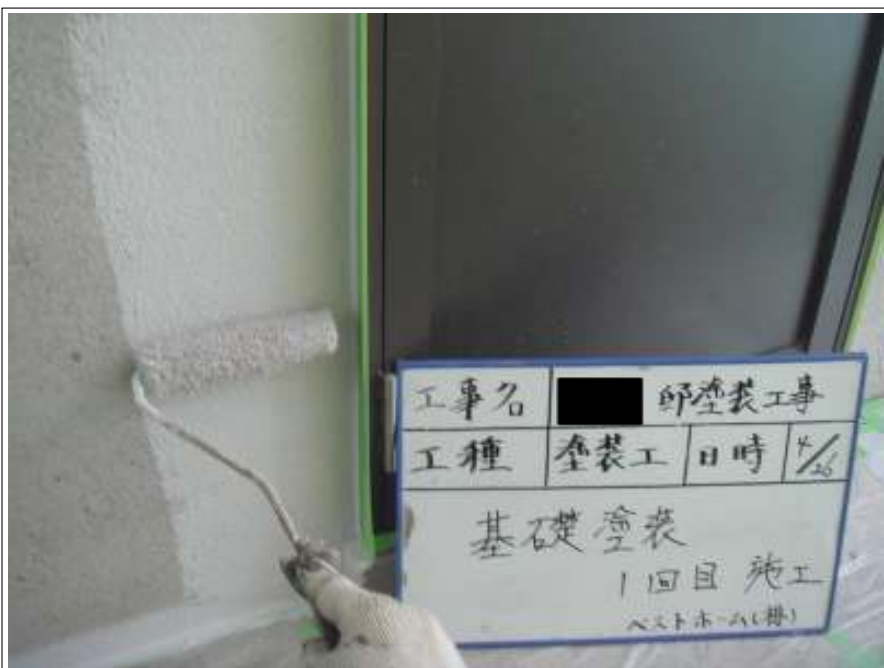
基礎塗装施工状況 (1回目)
