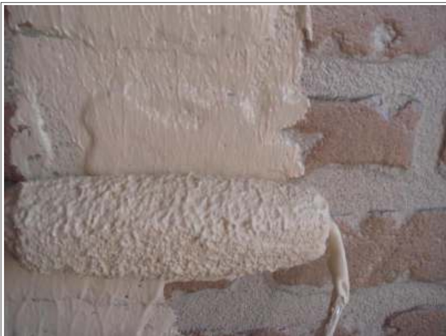
中塗り施工中
