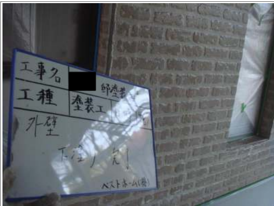
下塗り施工完了
