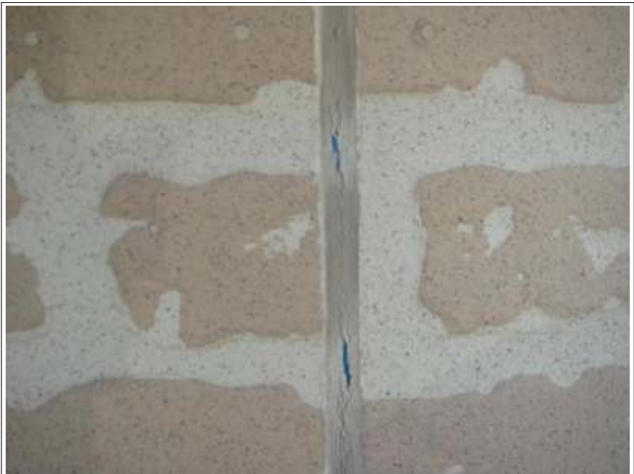
シーリング補修施工前
