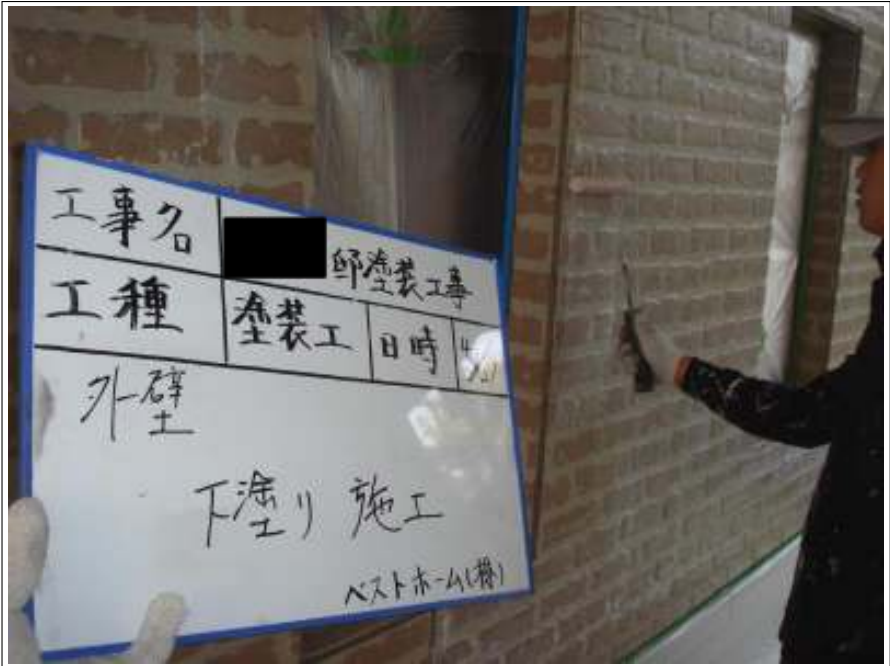
下塗り施工状況
