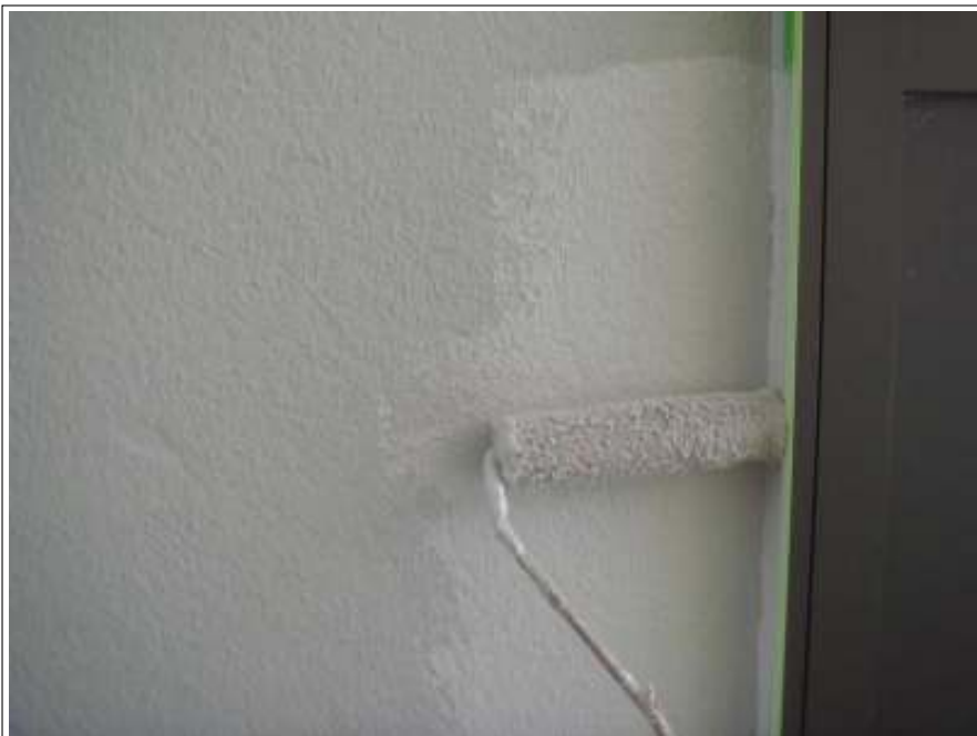
基礎塗装施工中（2回目）
