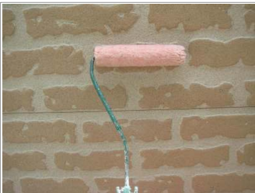
バリアー施工中
