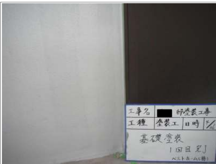
基礎塗装施工完了（1回目）
