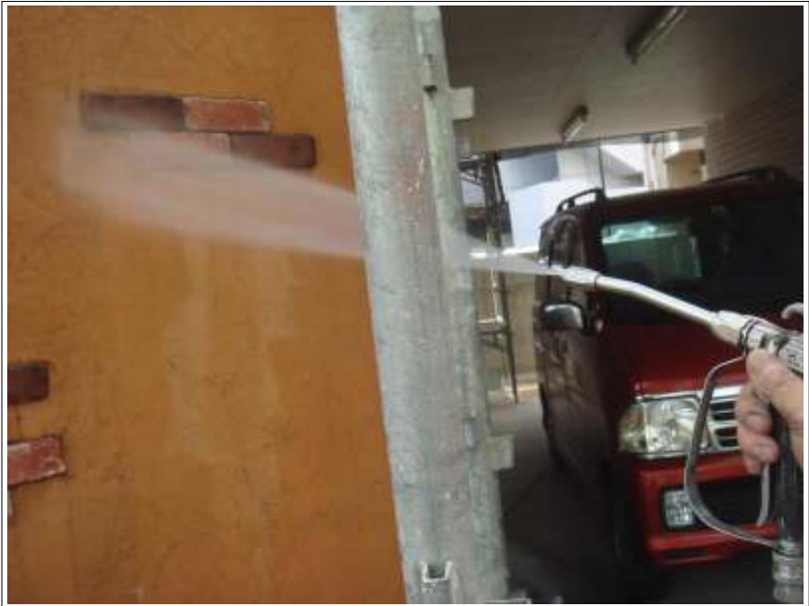
塀高圧洗浄施工中
