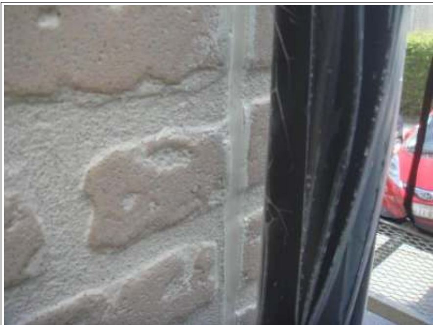
シーリング施工完了
