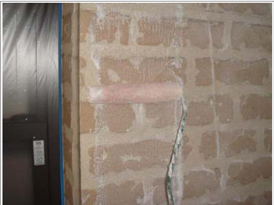
下塗り施工中
