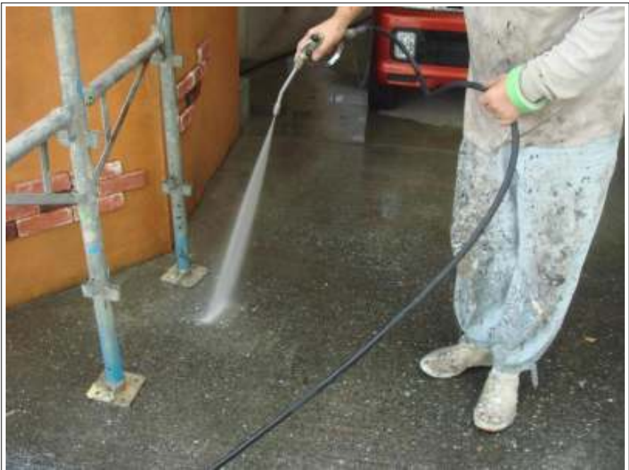
土間高圧洗浄施工状況
