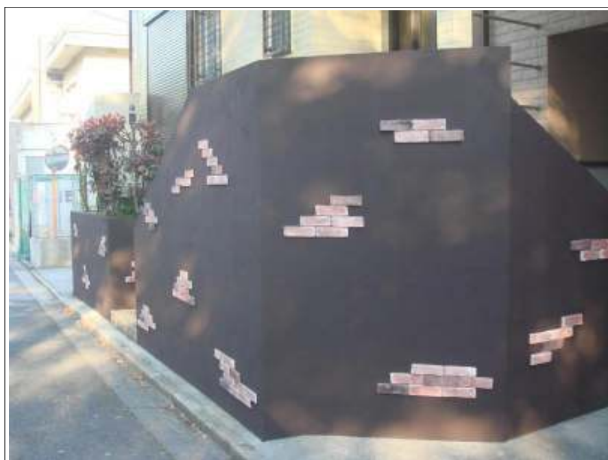
外塀上塗り施工完了
