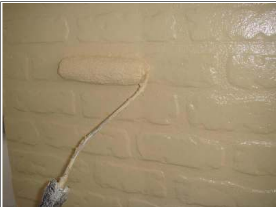
上塗り施工中
