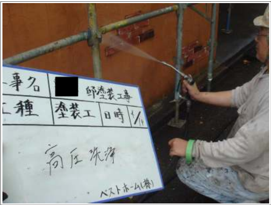
塀高圧洗浄施工状況
