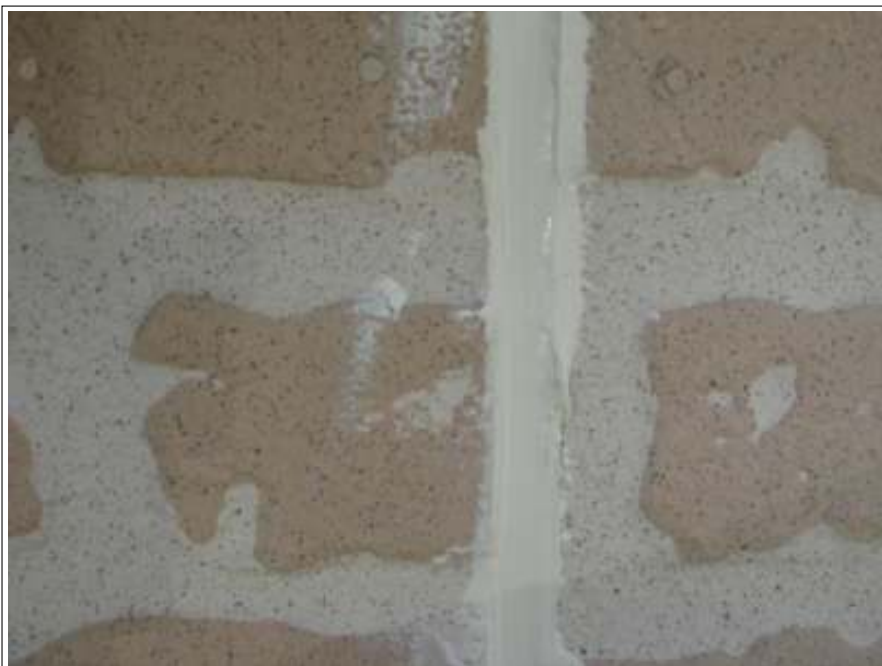
シーリング施工完了
