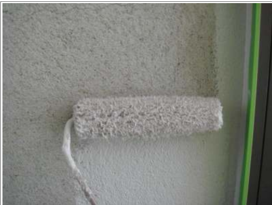
基礎塗装施工中（1回目）
