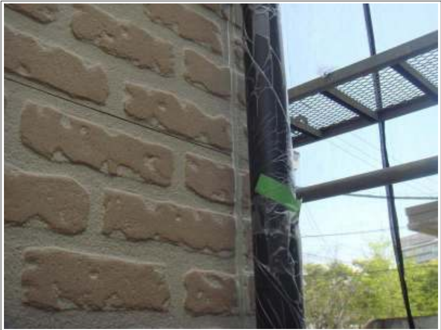
シーリング施工完了
