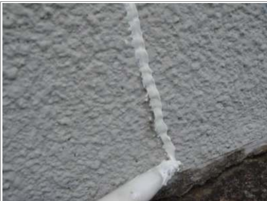
外壁 クラック補修完了
