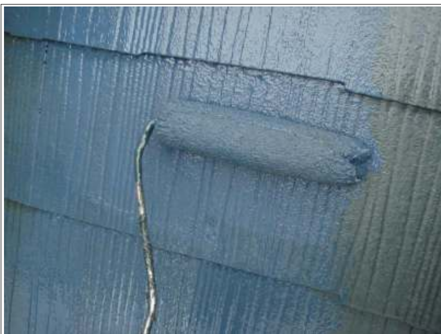
屋根上塗り塗装施工中
