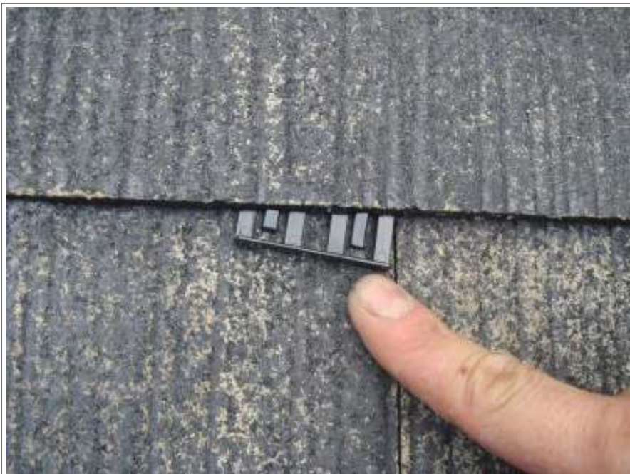
屋根タスペーサー取付
