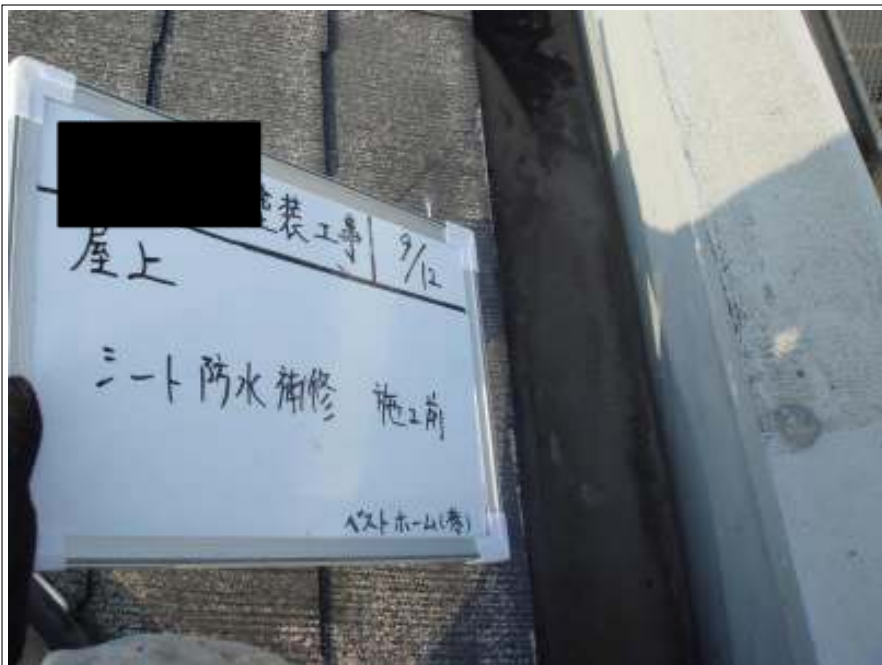
屋上シート防水補修 施工前
