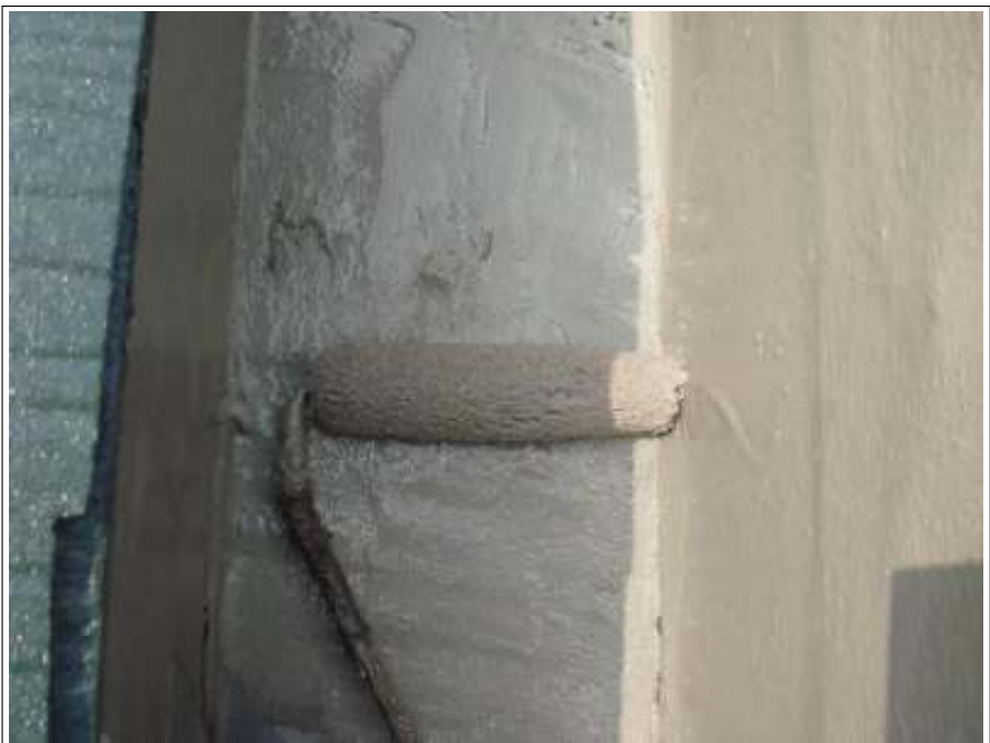
屋上シート防水 塗膜防水材料施工中
