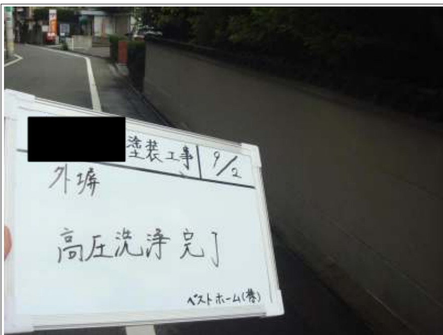
外塀高压洗浄完了
