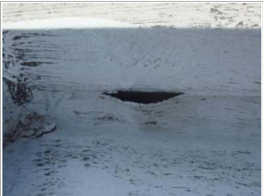
屋上シート防水 撤去前
