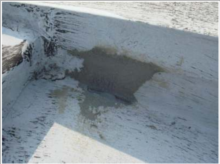
屋上シート防水カチオン補修施工後
