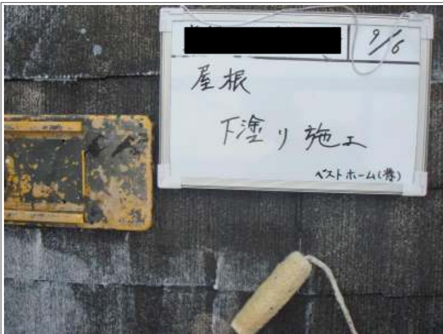
屋根下塗り塗装施工中
