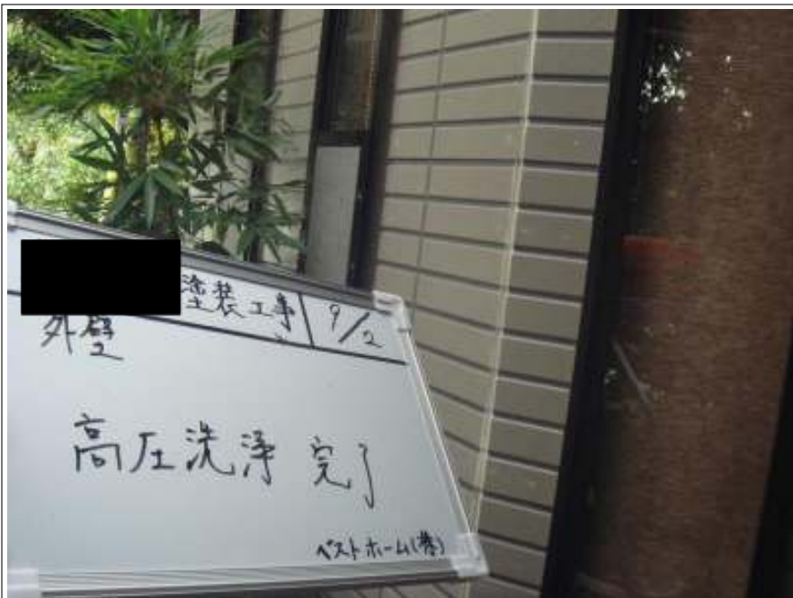
外壁高圧洗浄完了
