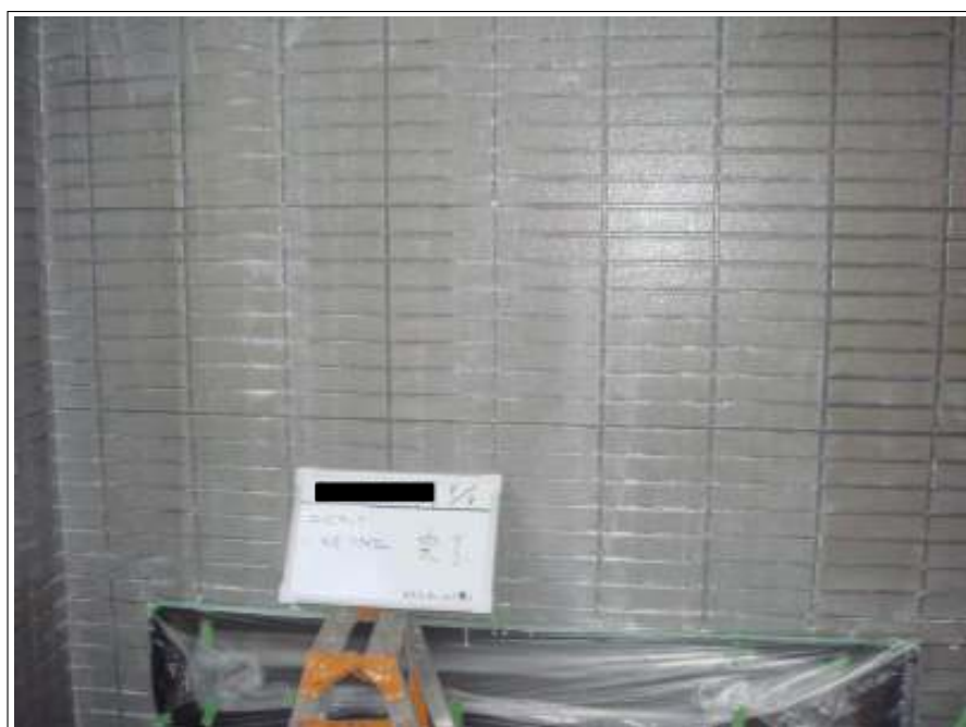
外壁下塗り塗装施工完了
