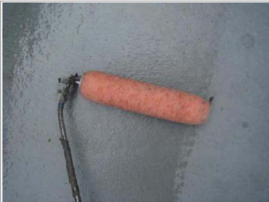
バルコニー防水 下塗り施工中
