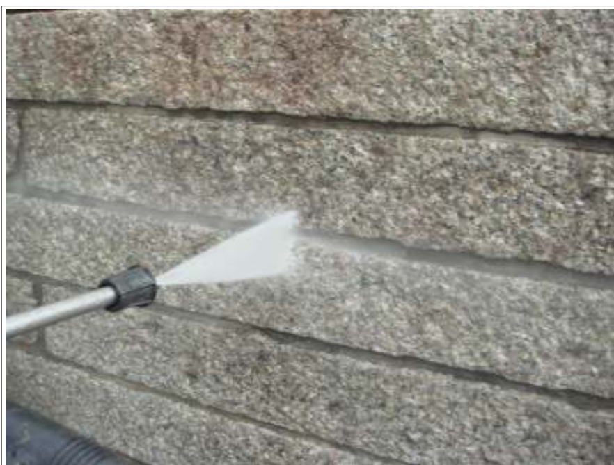
外塀高压洗浄中
