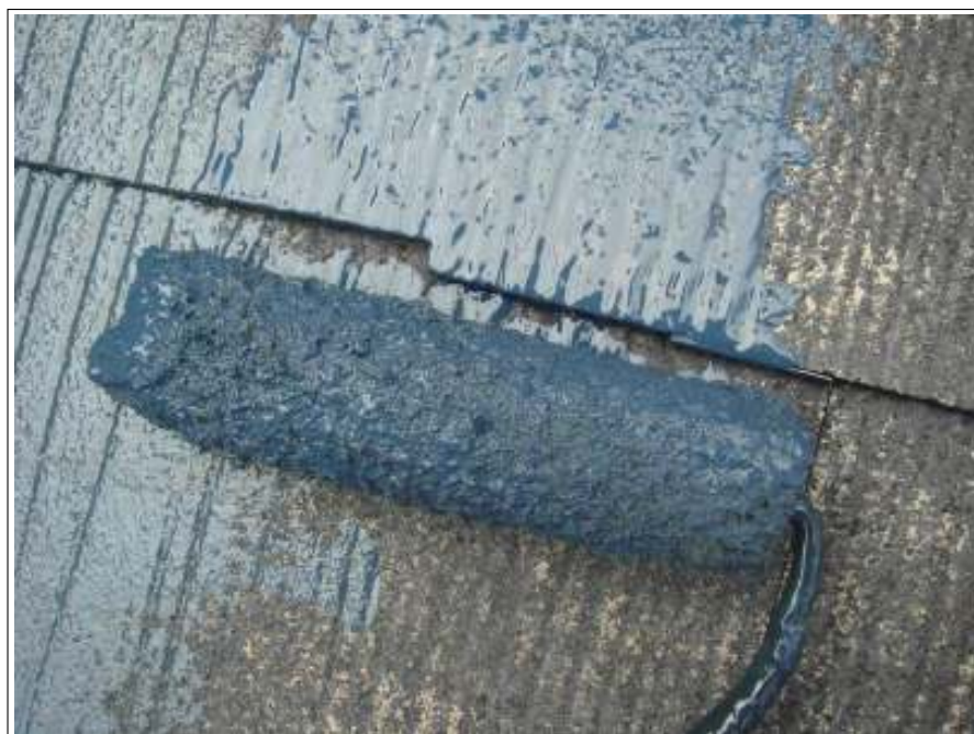
屋根中塗り塗装施工中
