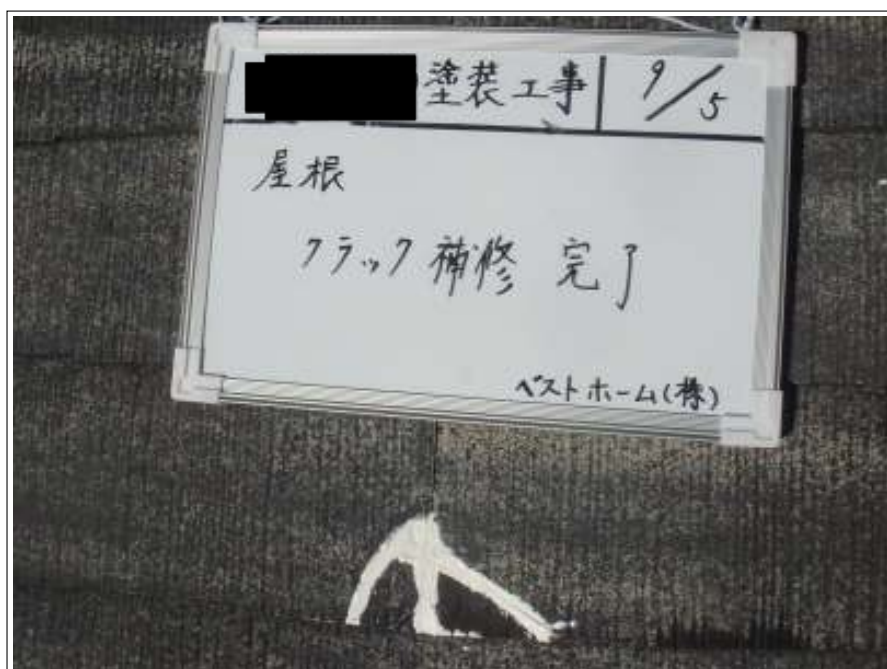
屋根 クラック補修完了
