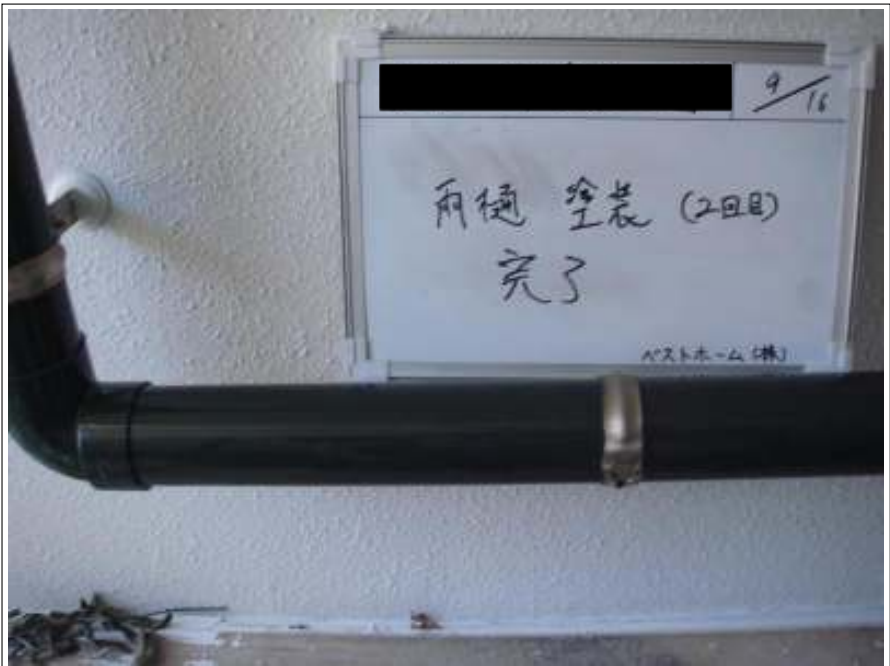
雨樋塗装施工完了
