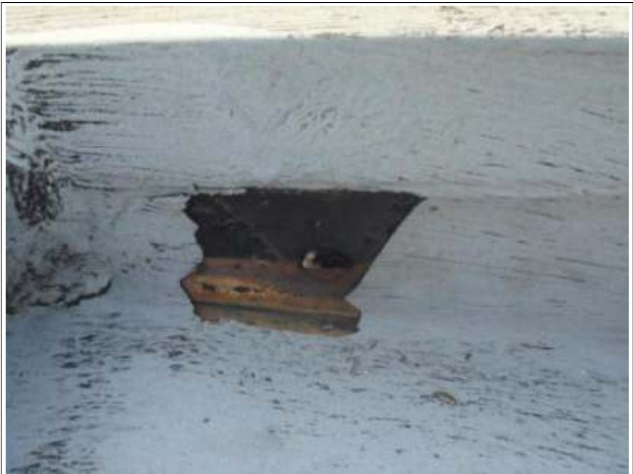
屋上シート防水 撤去後
