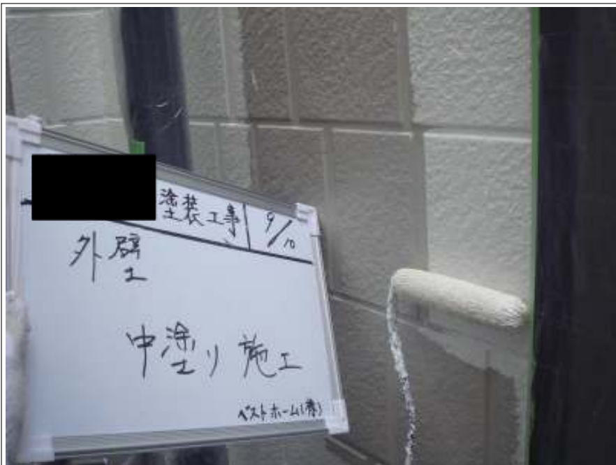
外壁中塗り塗装施工中
