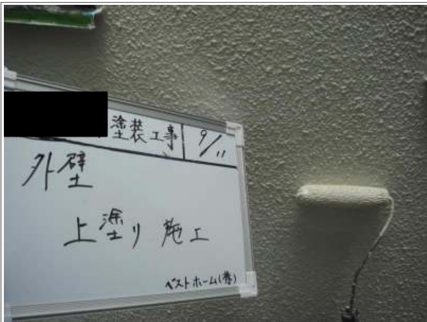
外壁上塗り塗装施工中
