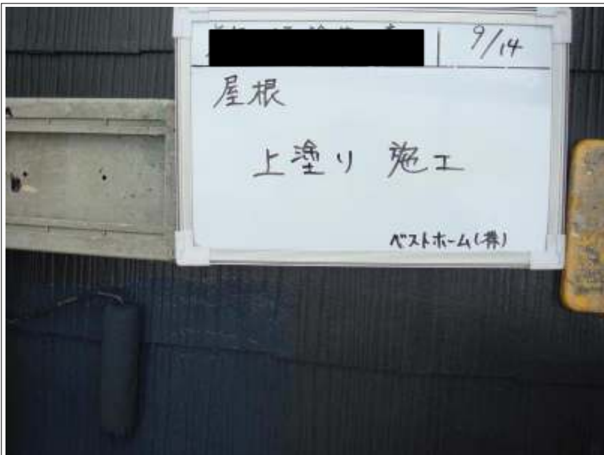
屋根上塗り塗装施工中
