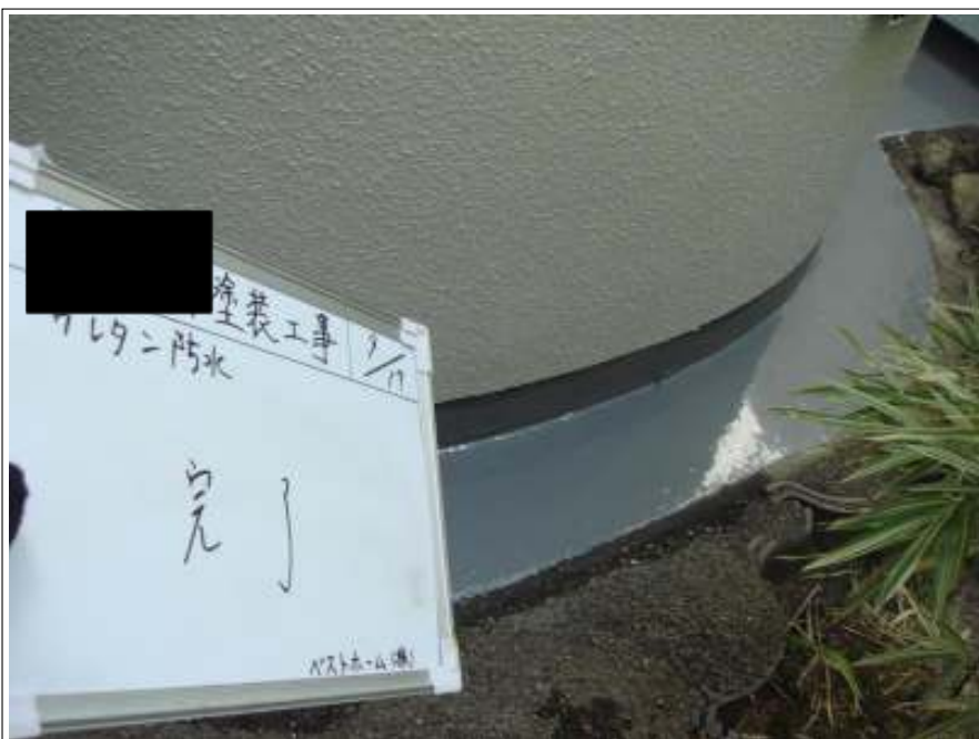
ウレタン防水施工完了
