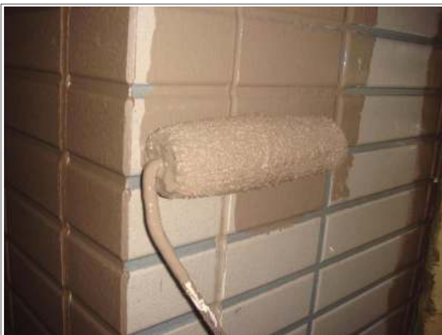
外壁中塗り塗装施工中
