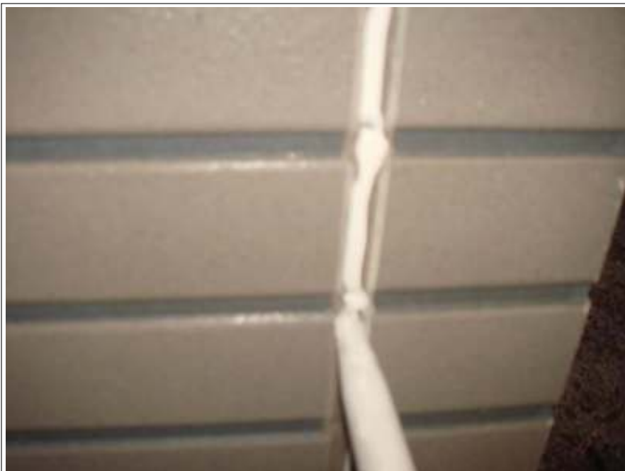
外壁 シーリング補修施工中
