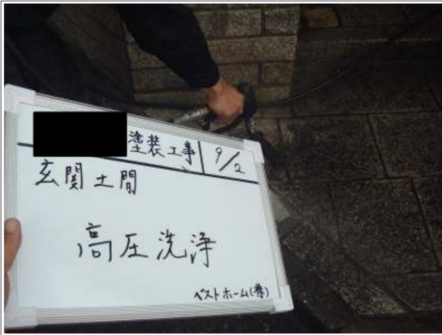
玄関土間高圧洗浄中
