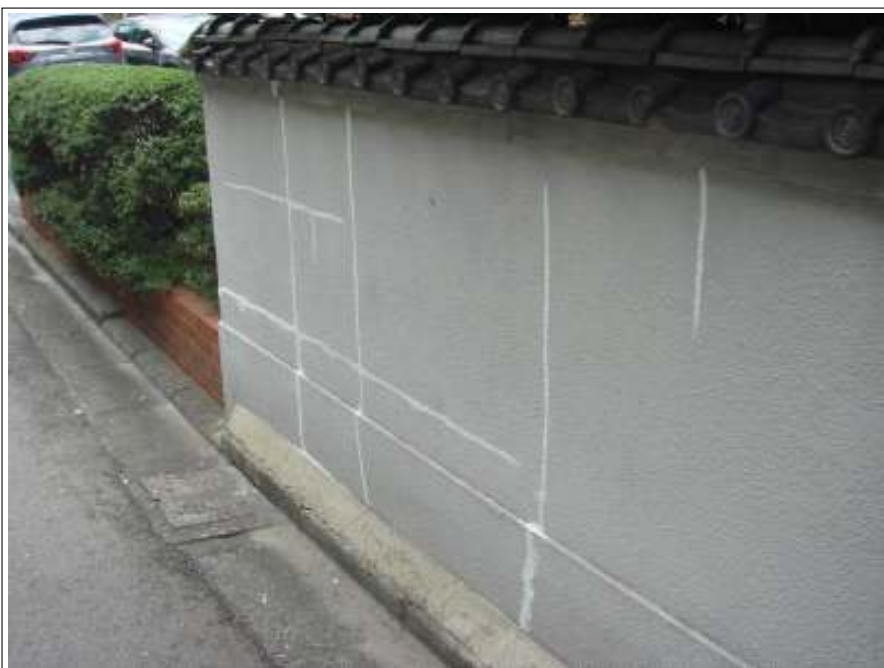
外壁 クラック補修完了
