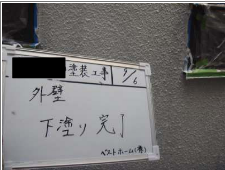
外壁下塗り塗装施工完了
