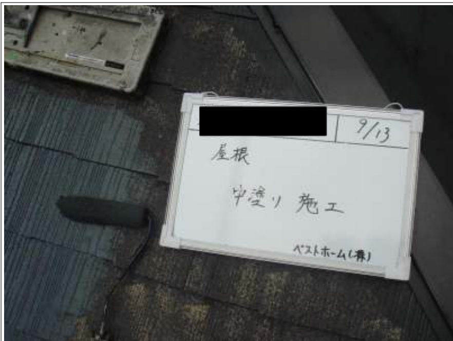
屋根中塗り塗装施工中
