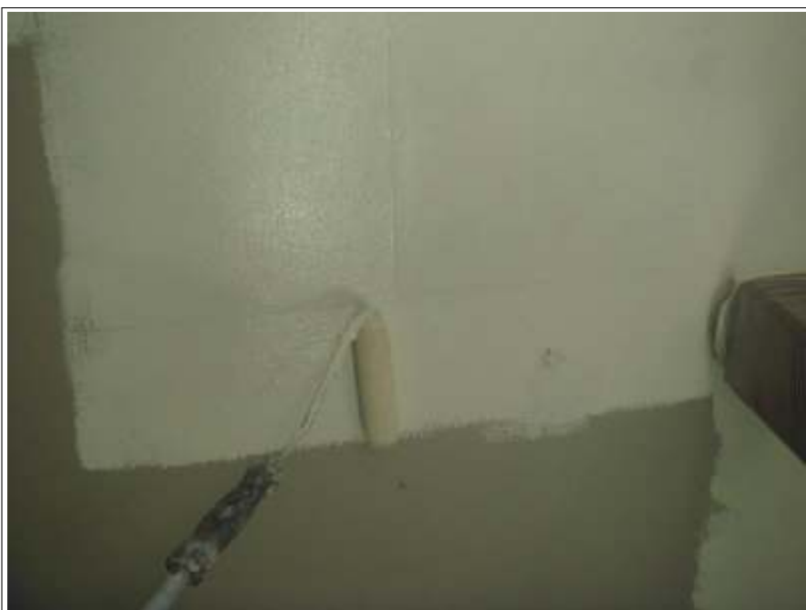
軒天塗装 1回目施工中
