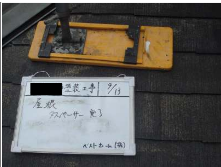
屋根タスペーサー取付完了
