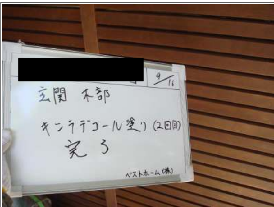
玄関木部塗装完了
