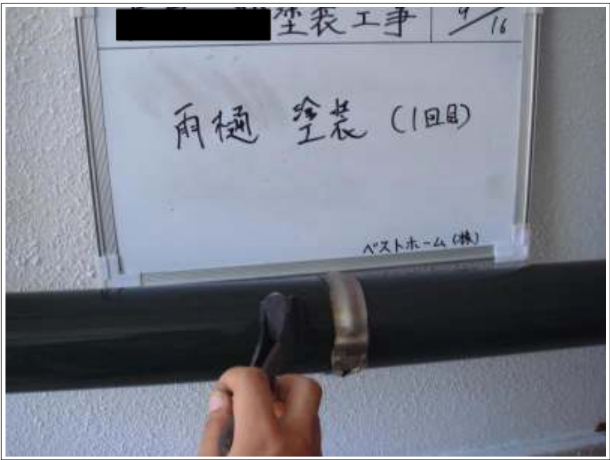
雨樋塗装 1 回目施工中
