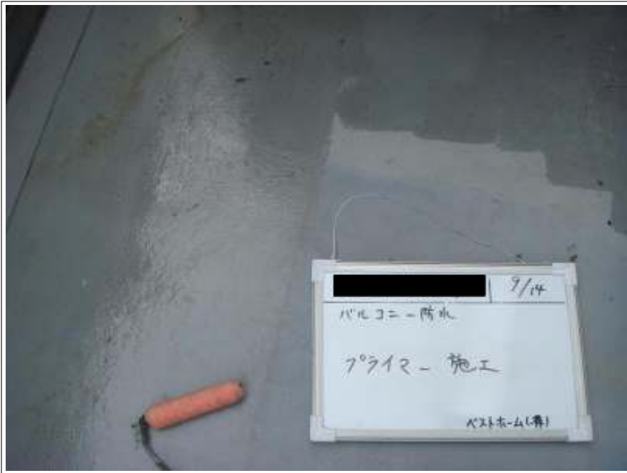
バルコニー防水 下塗り施工中
