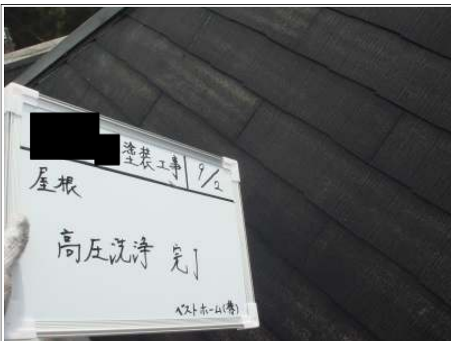
屋根高圧洗浄完了
