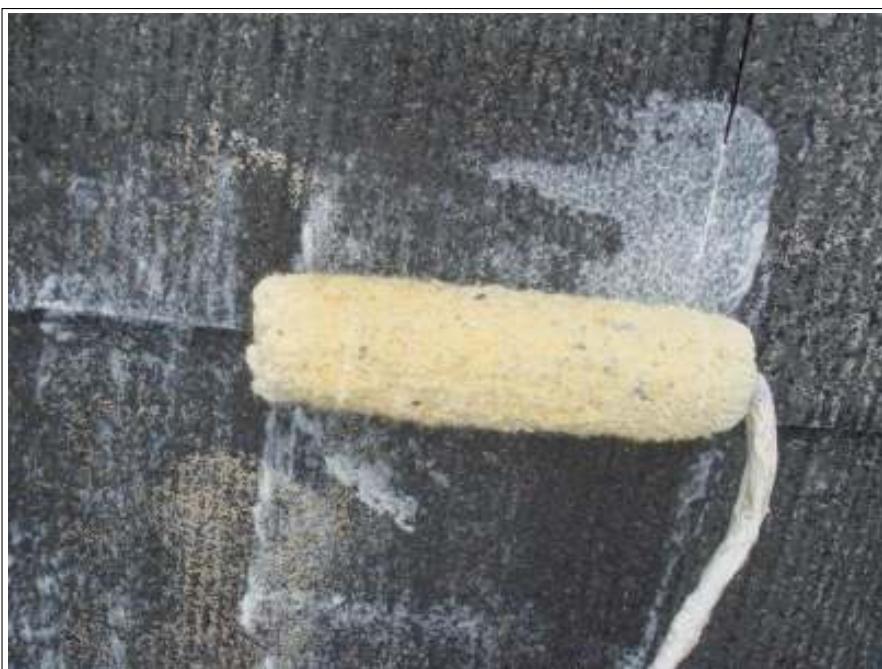
屋根下塗り塗装施工中
