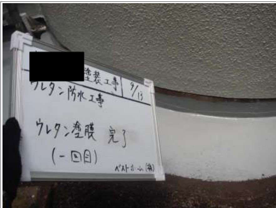
ウレタン塗膜 1 回目施工完了
