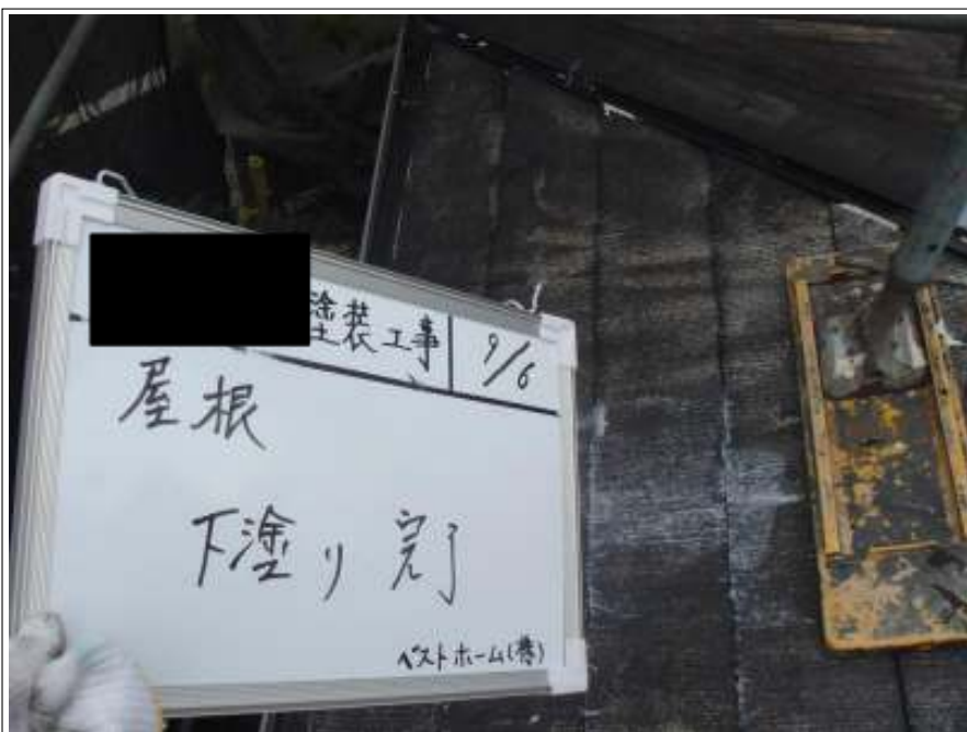
屋根下塗り完了
