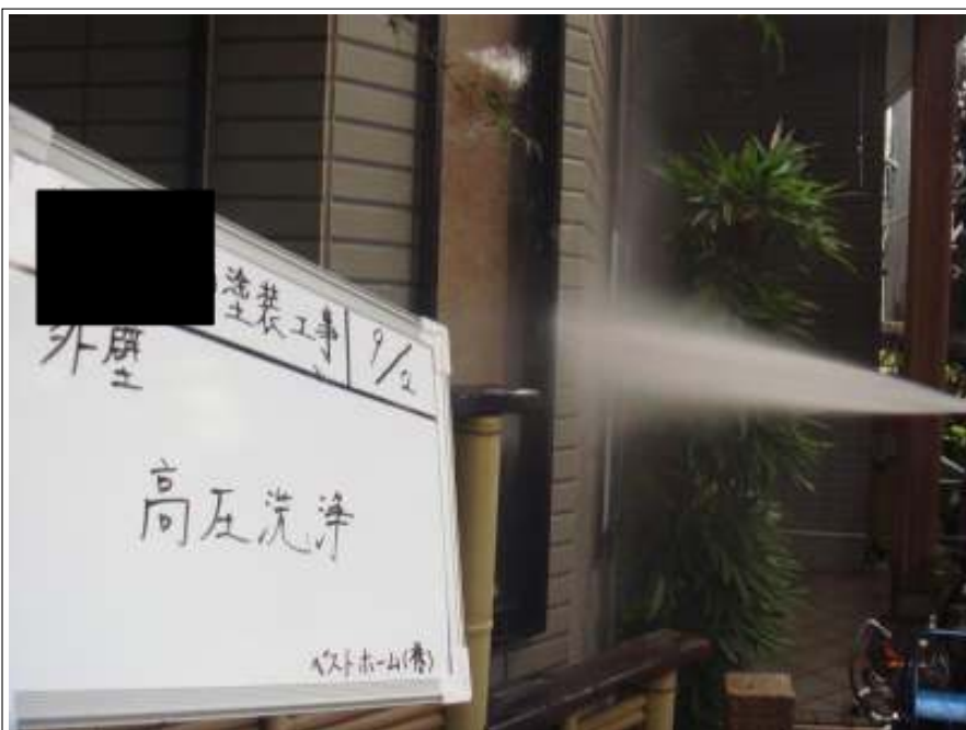
外壁高圧洗浄中
