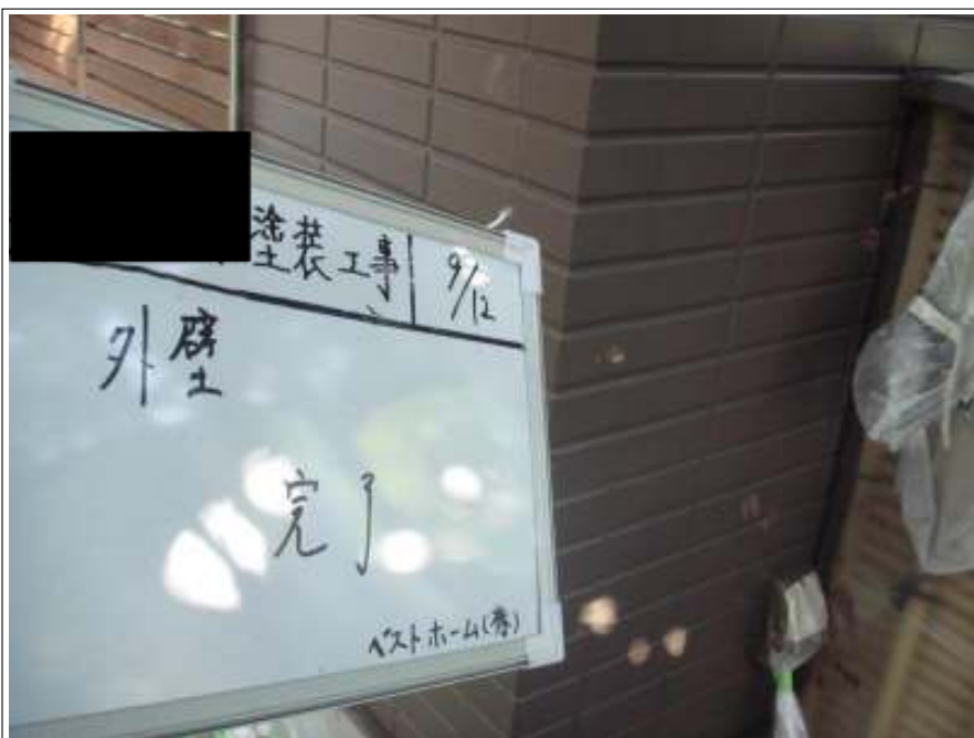
外壁上塗り塗装施工完了
