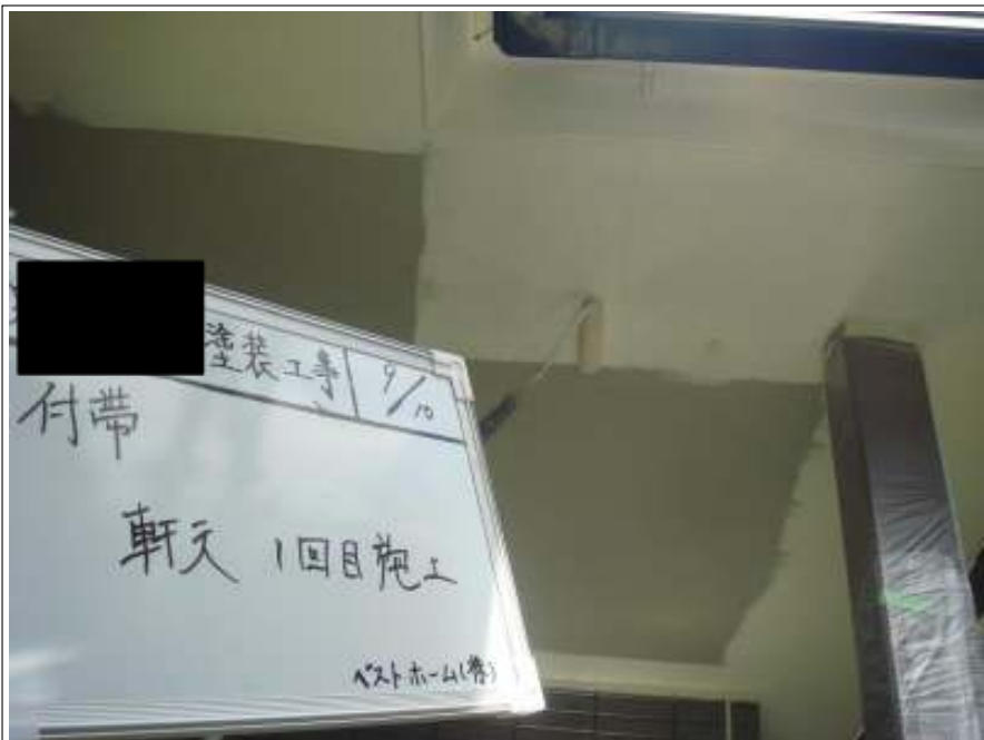
軒天塗装 1回目施工中
