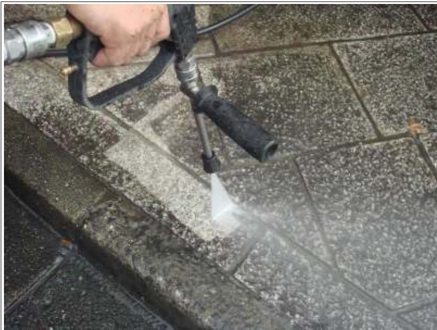
玄関土間高圧洗浄中
