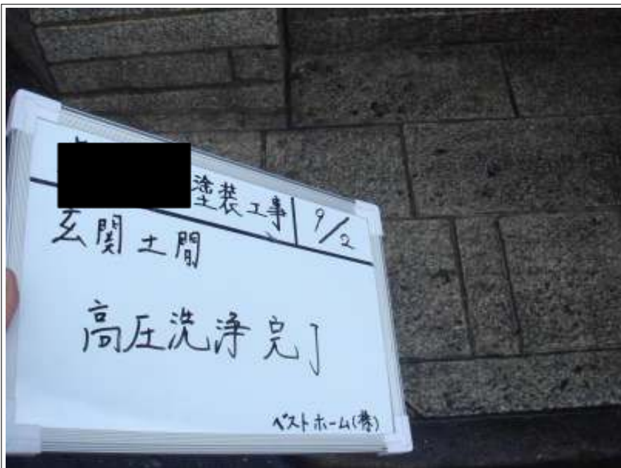
玄関土間高圧洗浄完了
