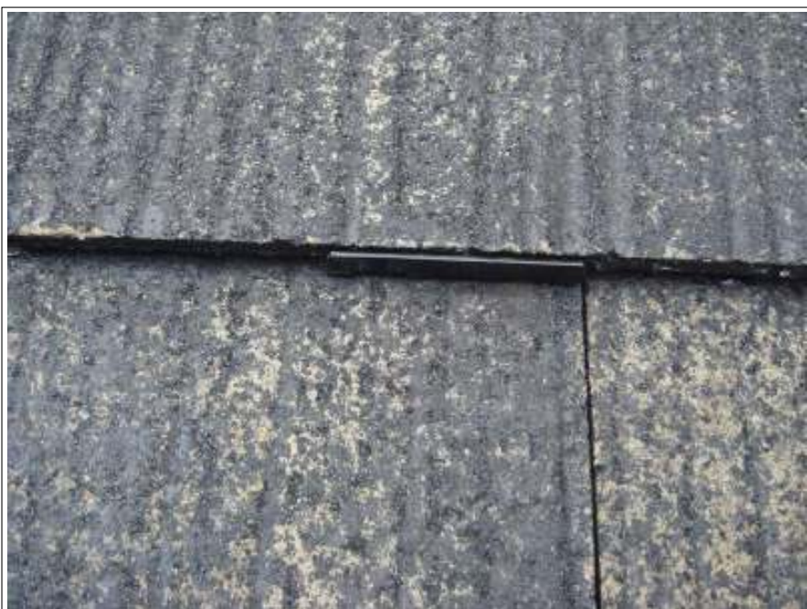
屋根タスペーサー取付完了
