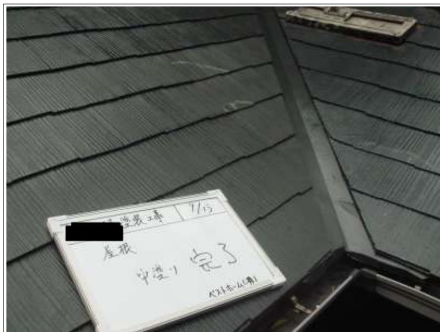
屋根中塗り塗装完了
