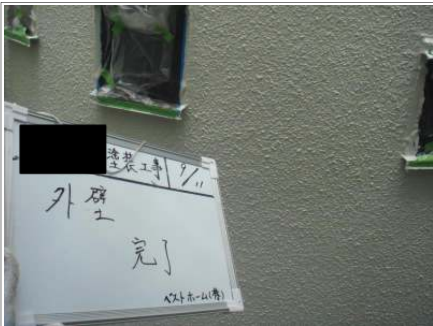
外壁上塗り塗装施工完了
