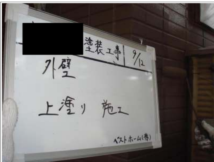
外壁上塗り塗装施工中
