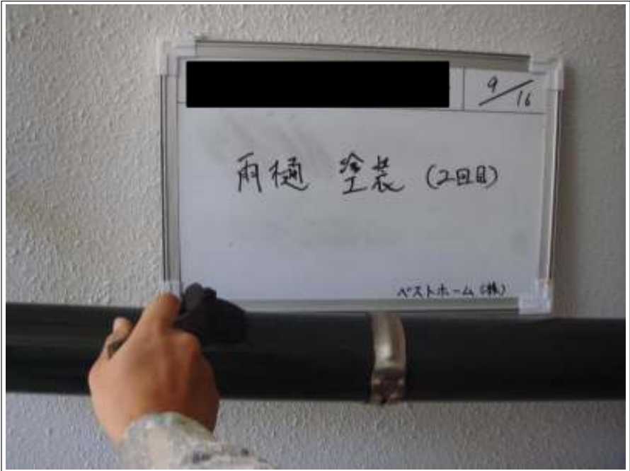
雨樋塗装 2 回目施工中
