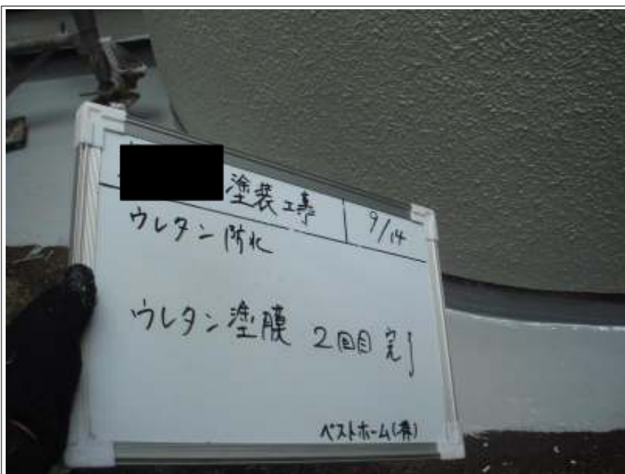
ウレタン塗膜 2 回目施工完了
