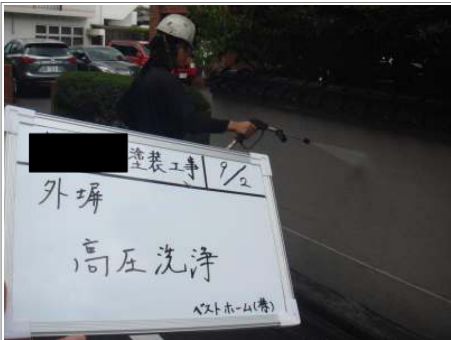
外塀高压洗浄中
