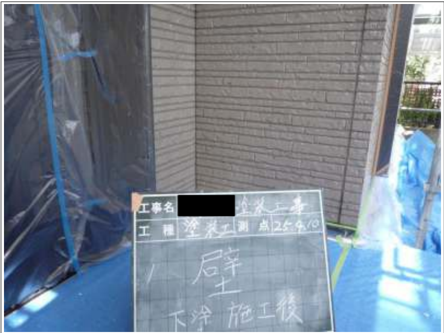
外壁下塗り施工完了
