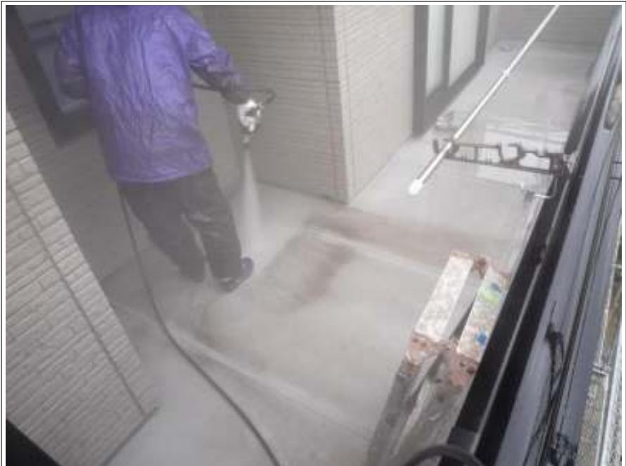
ベランダ部高圧洗浄施工状況
