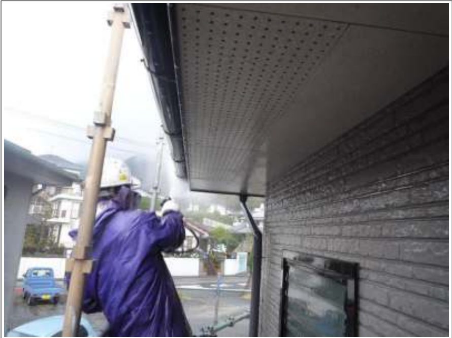
破風高圧洗浄上施工状況
