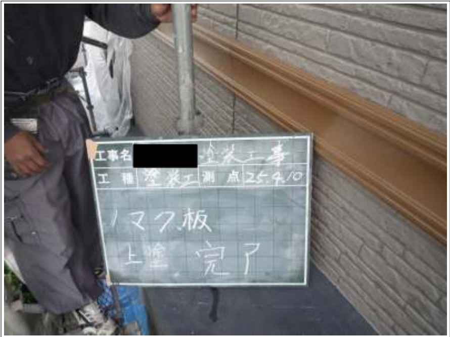
帯上塗り施工完了
