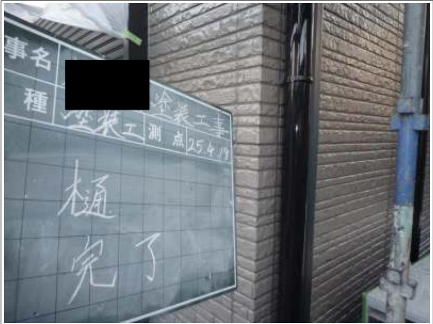
雨樋上塗り施工完了
