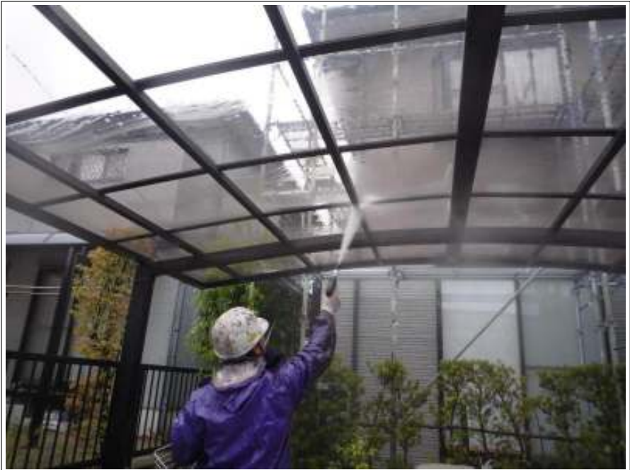
カーポート高圧洗浄施工状況
