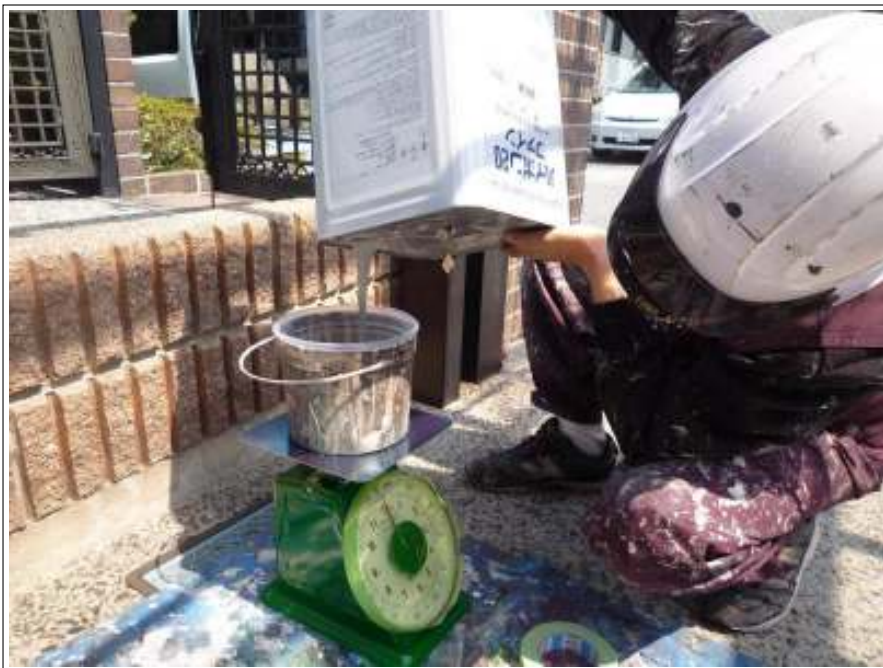
鉄部下塗り用塗料計量中
