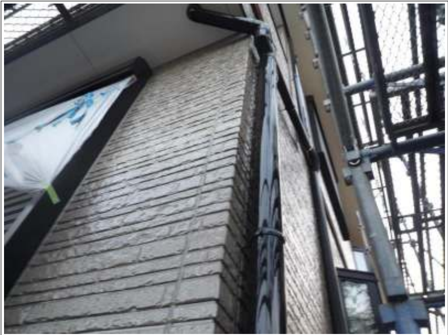
雨樋上塗り施工完了
