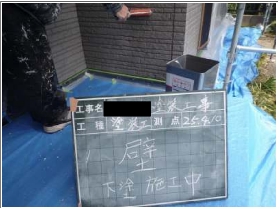
外壁下塗り施工状況
