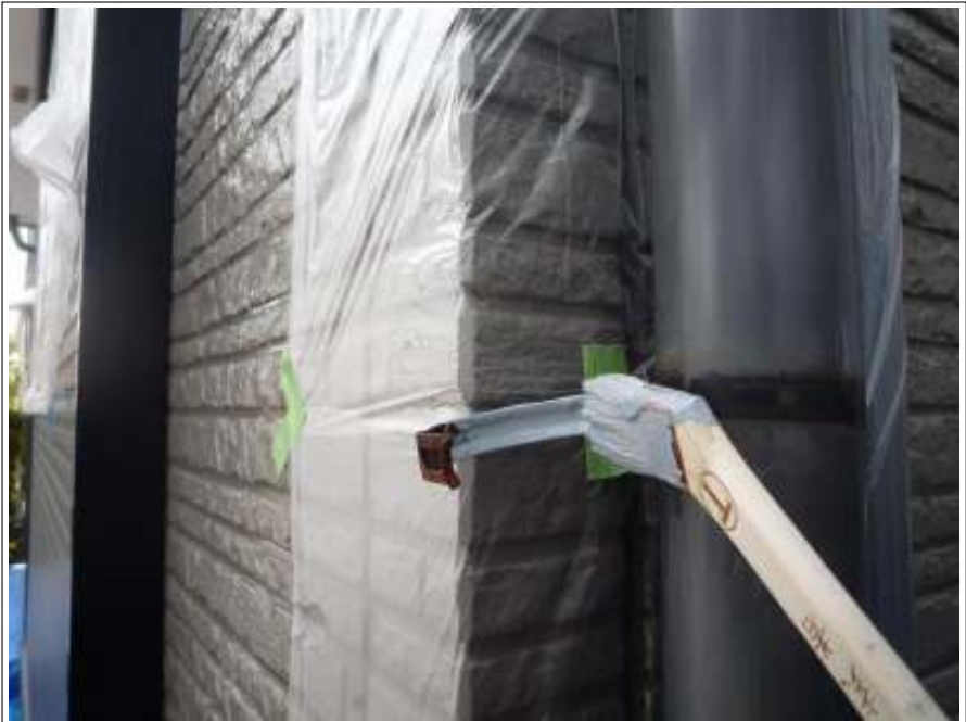
雨樋バンドサビ止め施工中
