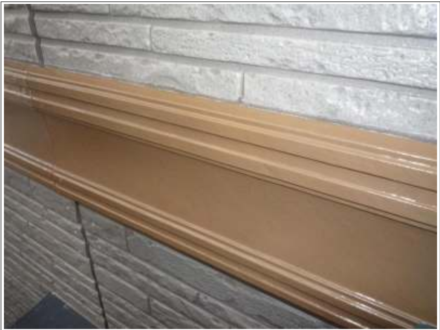
帯上塗り施工完了
