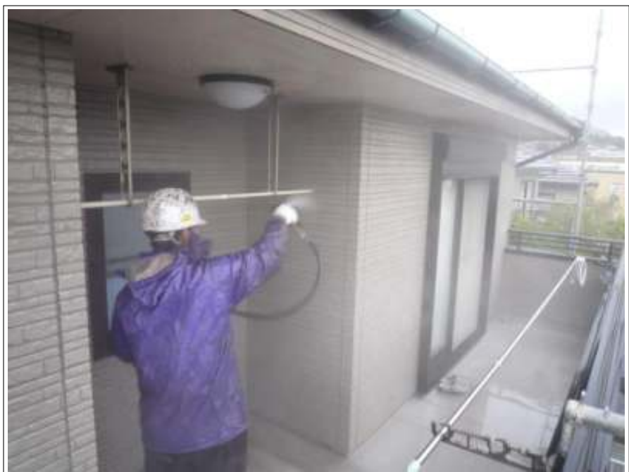
外壁高圧洗浄施工中
