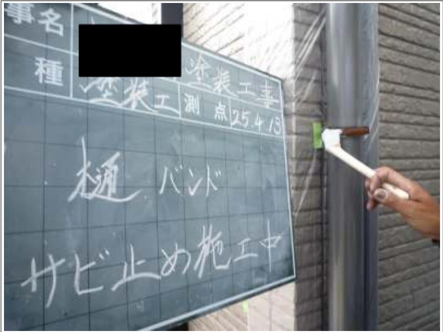
雨樋バンドサビ止め施工状況
