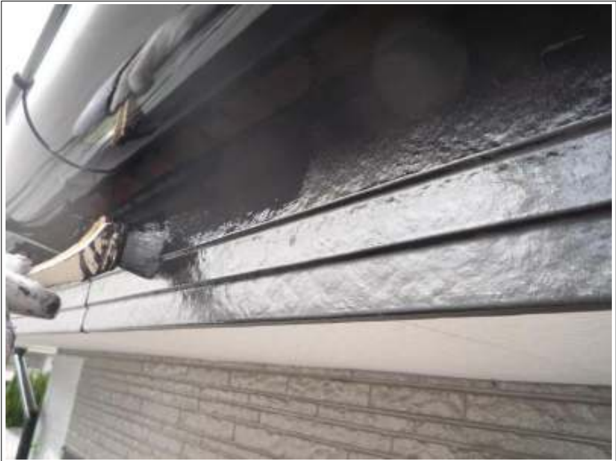
破風上塗り施工中（2回目）
