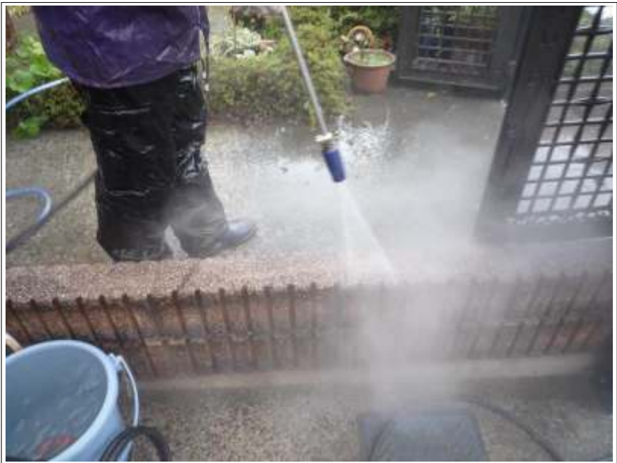
玄関前高圧洗浄施工中
