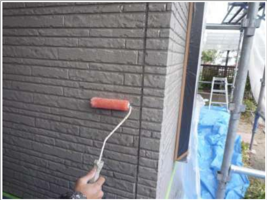
外壁下塗り施工中
