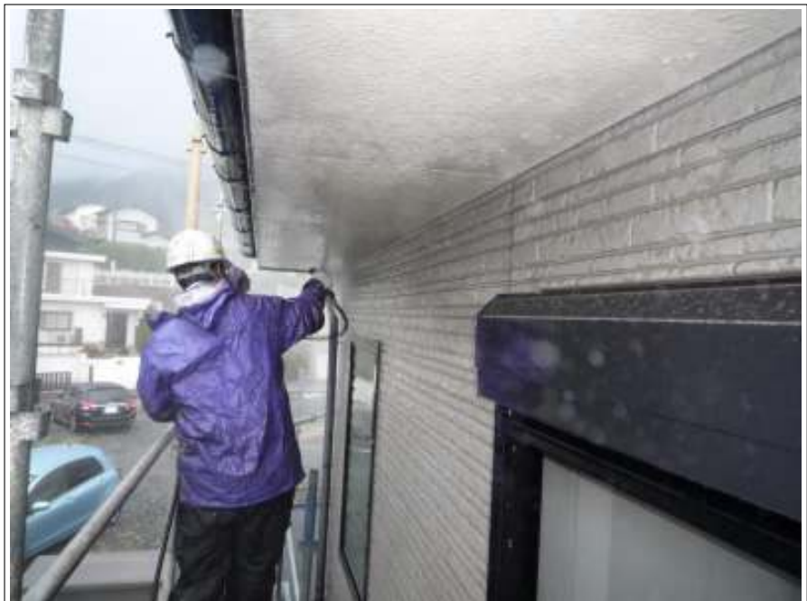
外壁高圧洗浄施工状況
