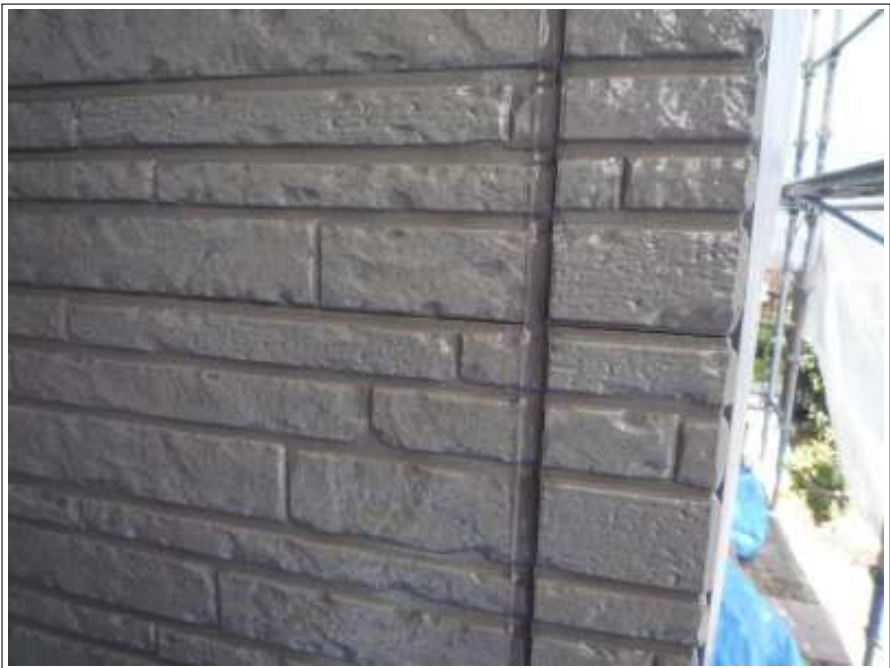
外壁下塗り施工完了
