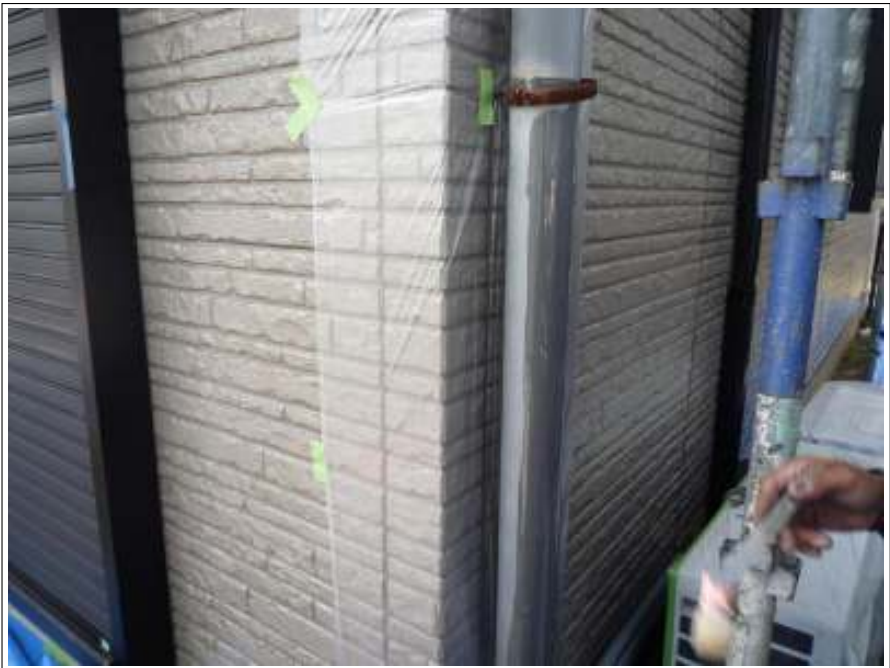
雨樋下塗り施工完了
