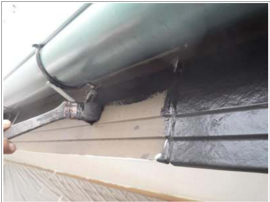
破風上塗り施工中（1回目）
