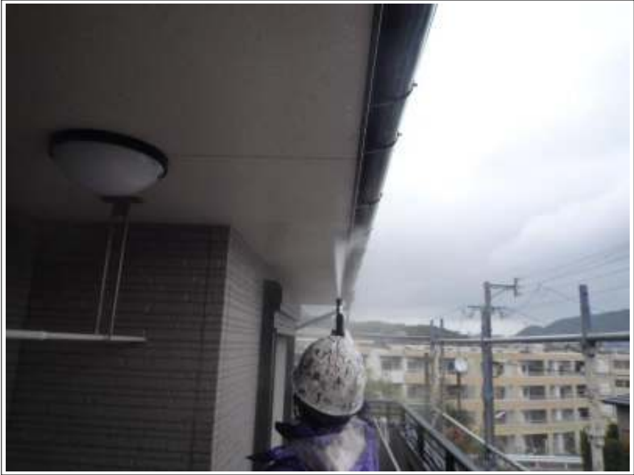
軒天高圧洗浄施工状況
