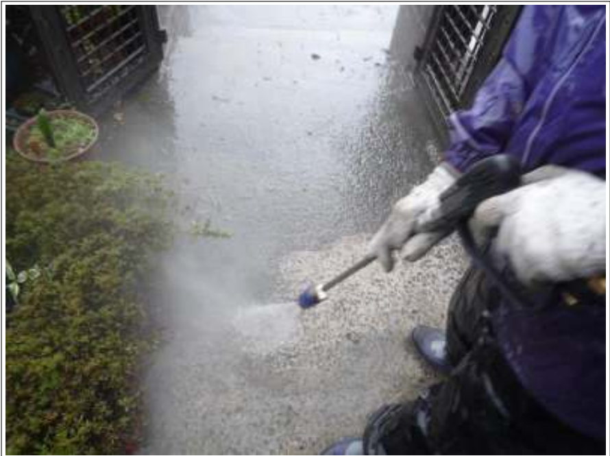
玄関前高圧洗浄施工中
