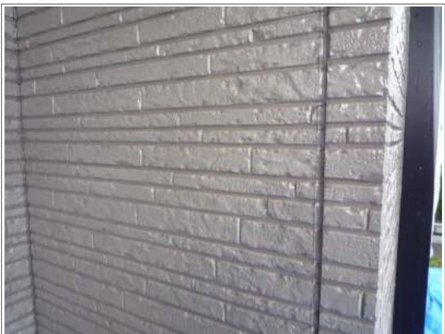
外壁上塗り施工完了
