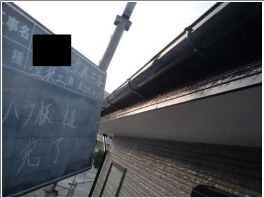
破風上塗り施工完了（2回目）
