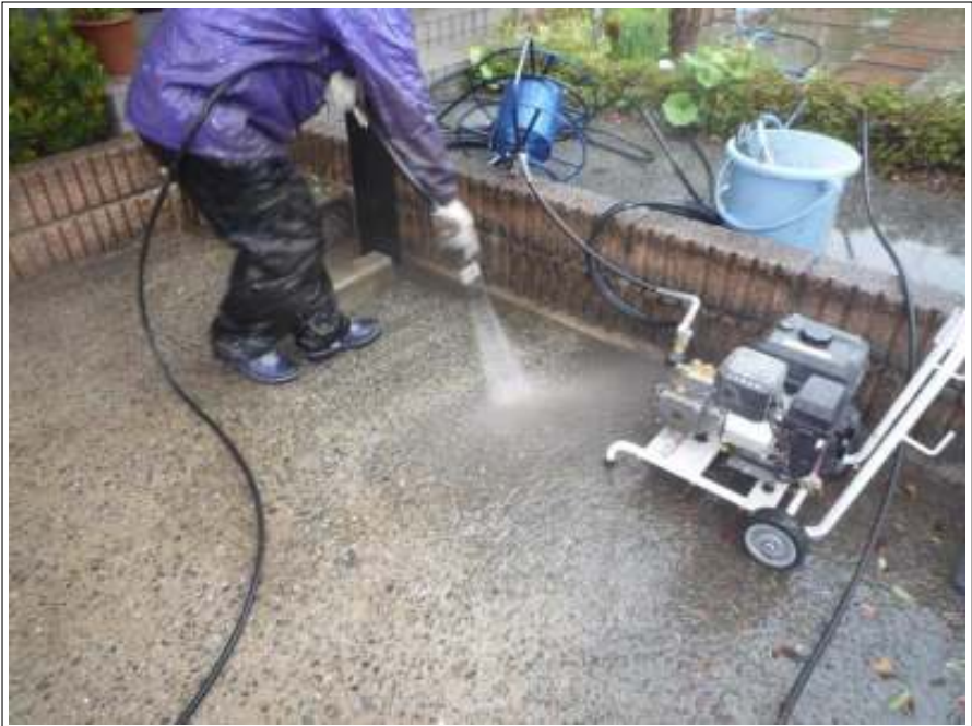
土間高圧洗浄施工中
