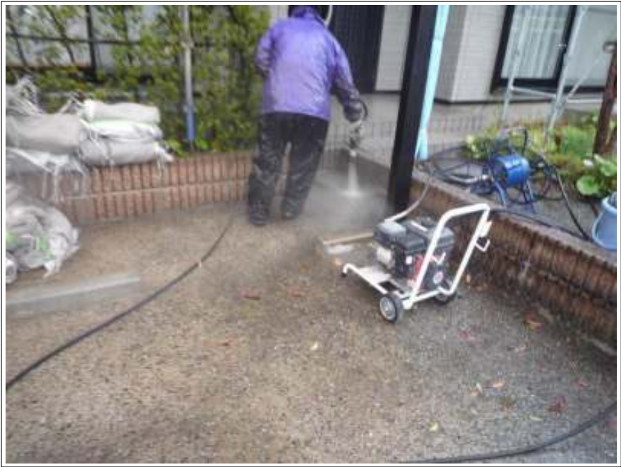
土間高圧洗浄施工状況
