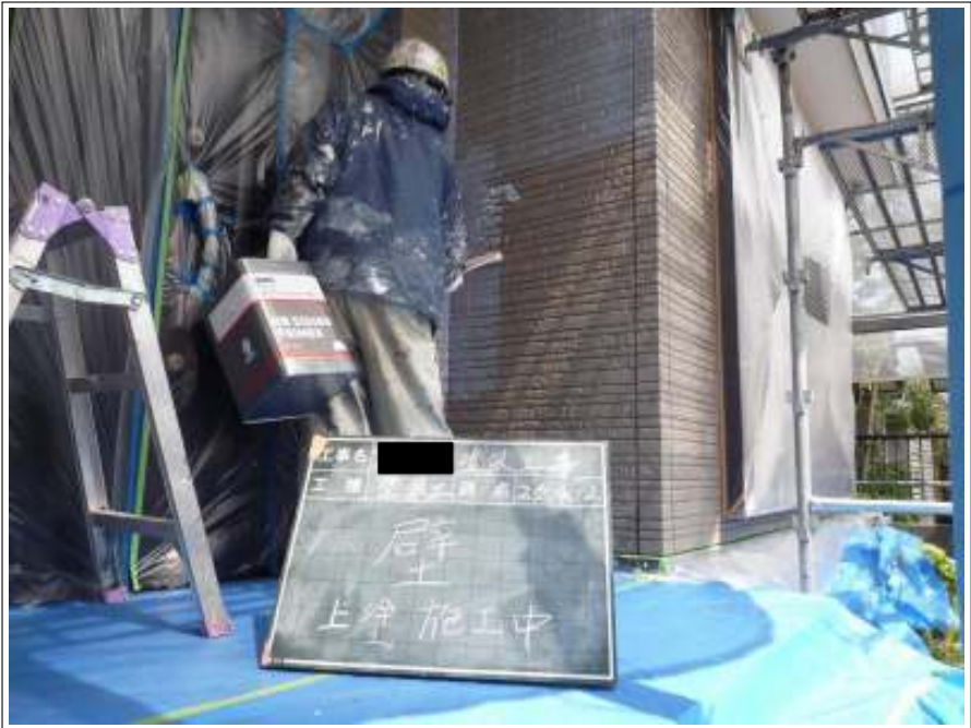
外壁上塗り施工状況
