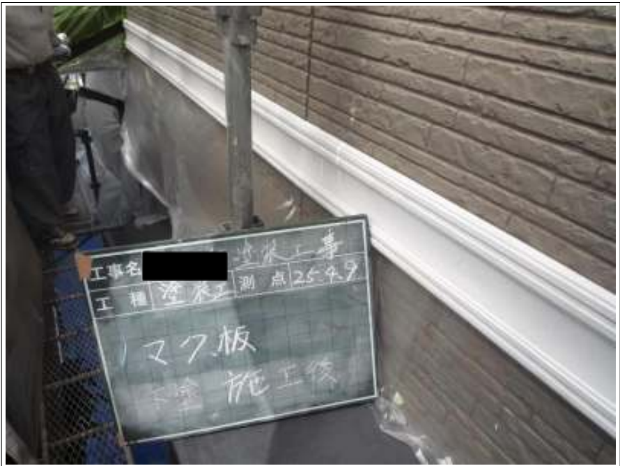
帯下塗り施工完了
