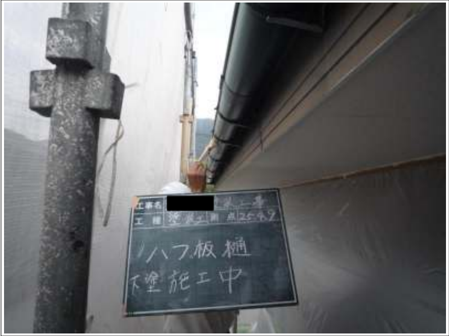
破風下塗り施工状況
