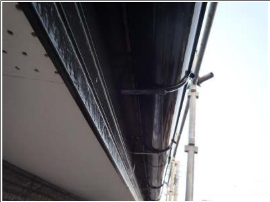
破風上塗り施工完了（2回目）
