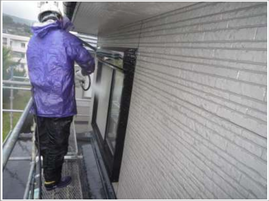
網戸高圧洗浄施工状況
