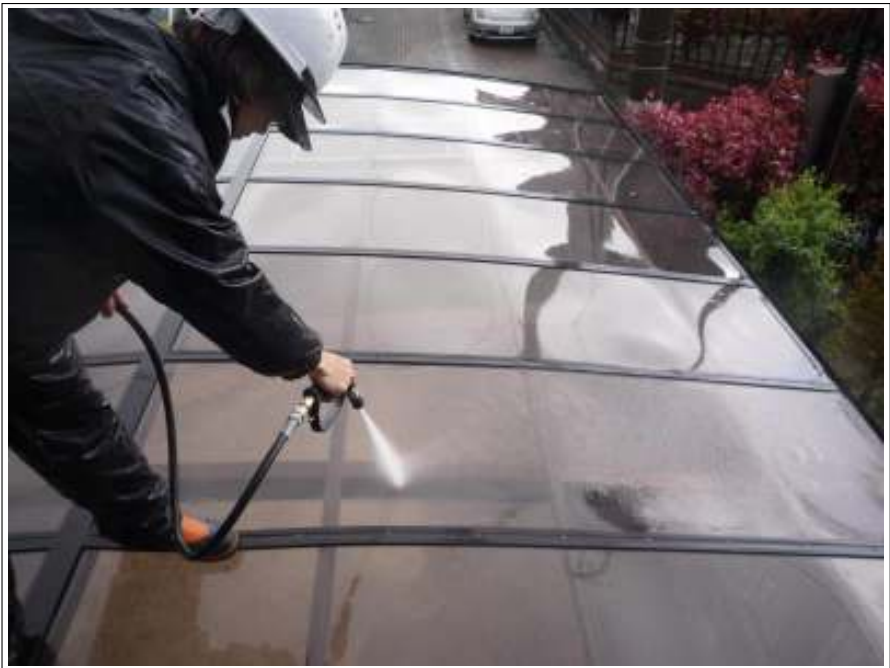
カーポート高圧洗浄施工中
