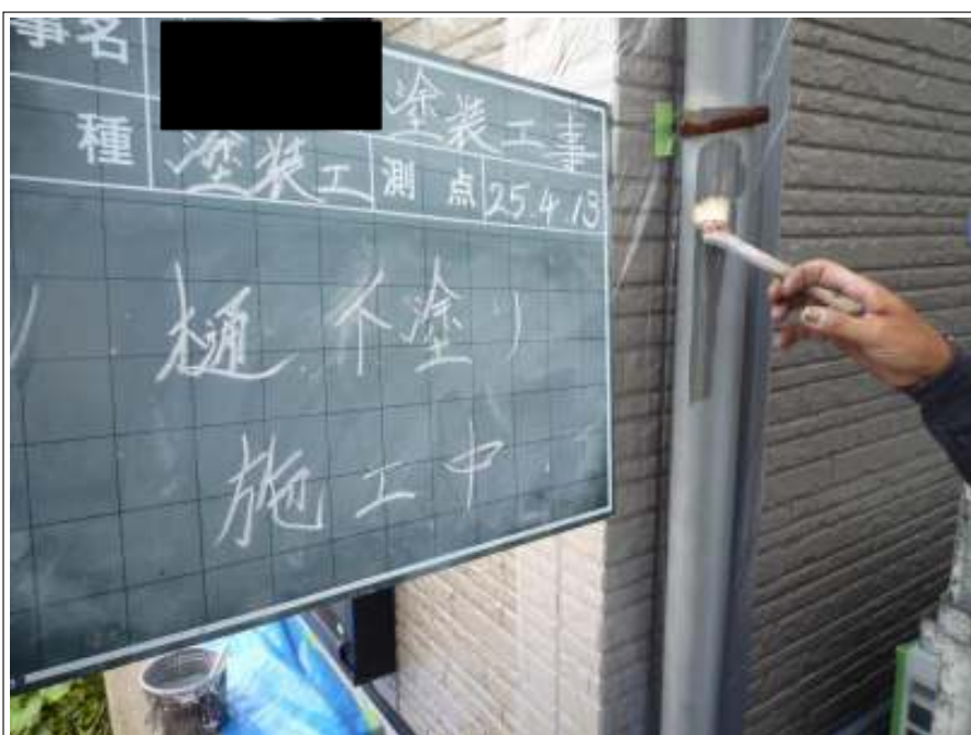
雨樋下塗り施工状況
