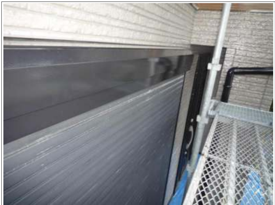
シャッターボックス施工完了
