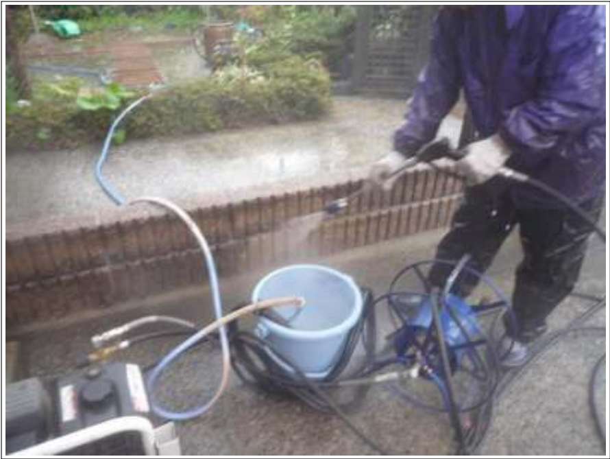
玄関前高圧洗浄施工中
