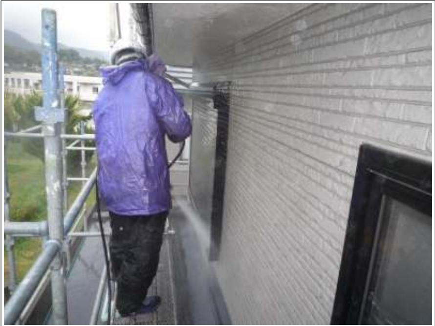
雨戸高圧洗浄施工中
