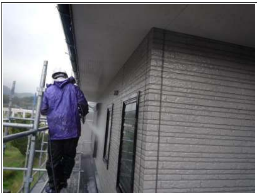
外壁高圧洗浄施工中
