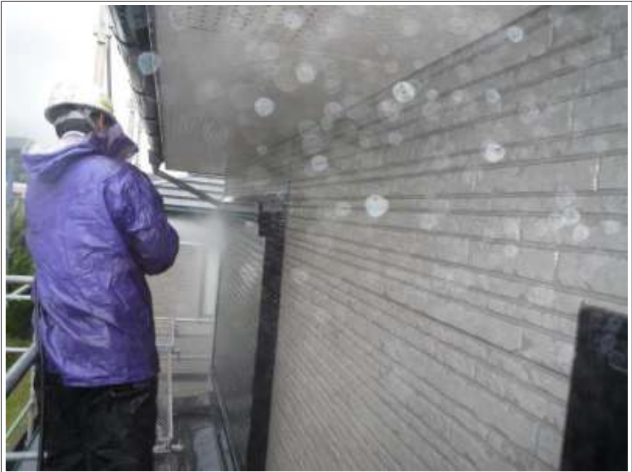
雨戸高圧洗浄施工状況
