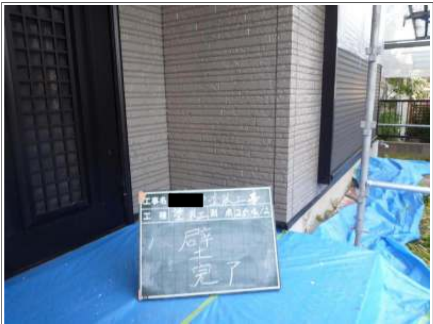
外壁上塗り施工完了
