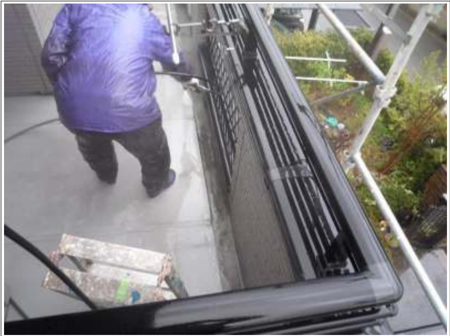
ベランダ部高圧洗浄施工中
