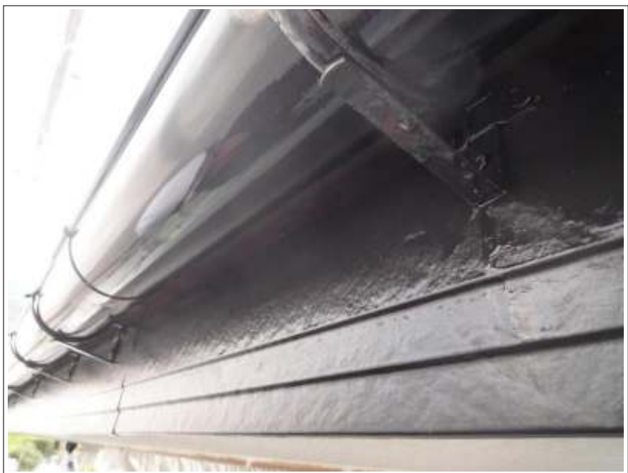
破風上塗り施工完了（1回目）
