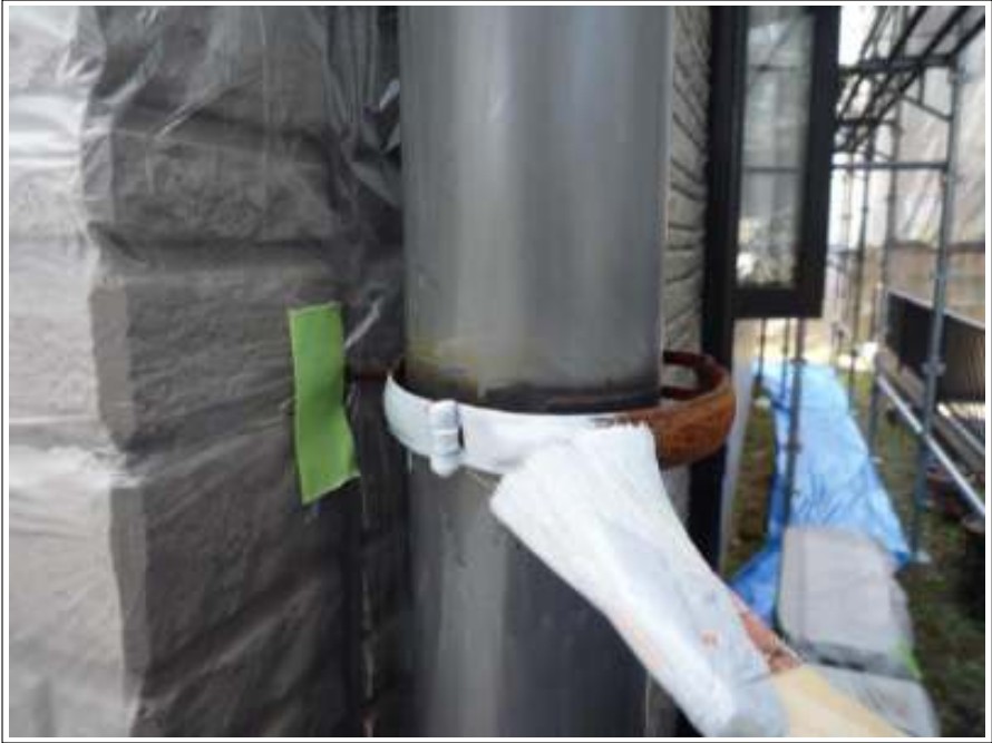
雨樋バンドサビ止め施工中
