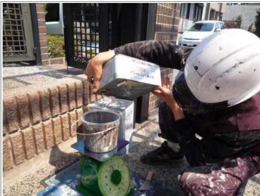
鉄部下塗り用塗料計測中
