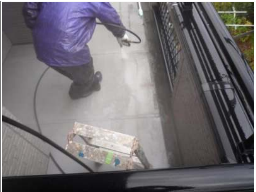
ベランダ部高圧洗浄施工中
