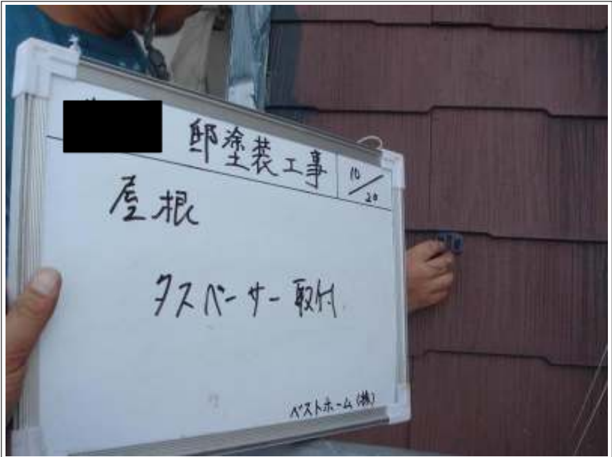
屋根タスペーサー取付施工中
