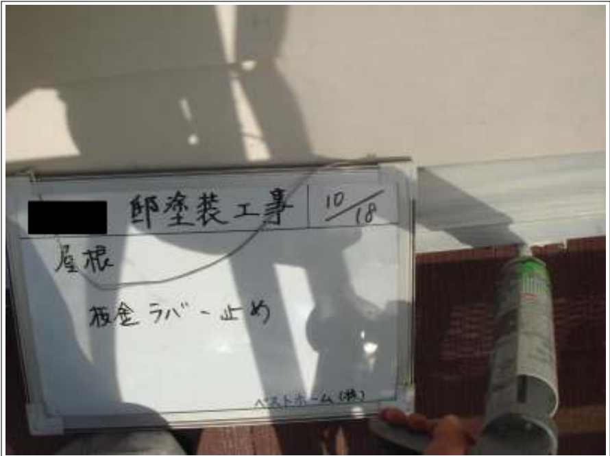
屋根板金ラバー止め施工中
