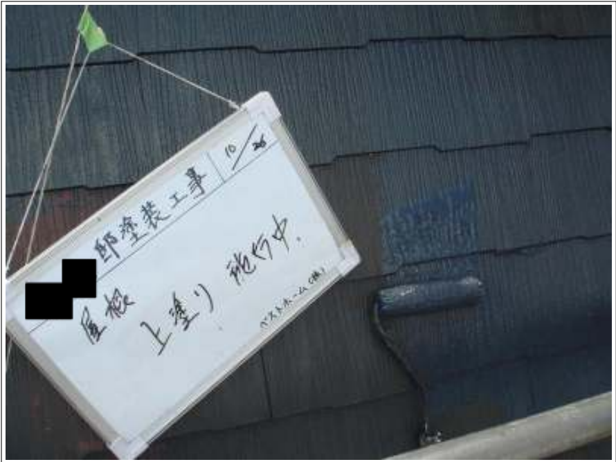
屋根塗装上塗り施工中
