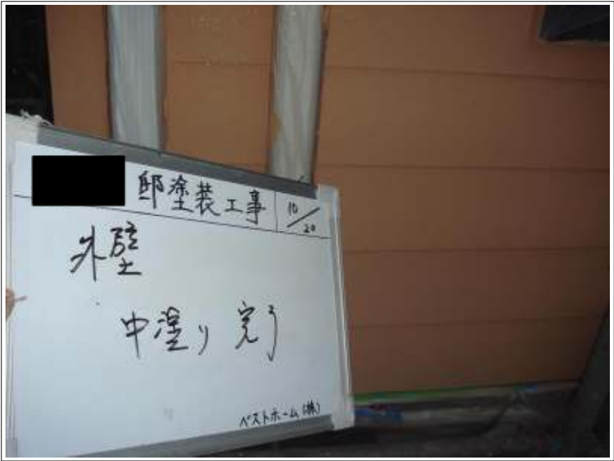
外壁中塗り施工完了
