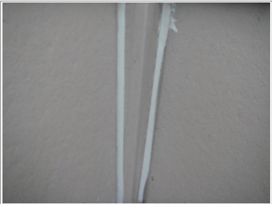
外壁シーリング補修施工中
