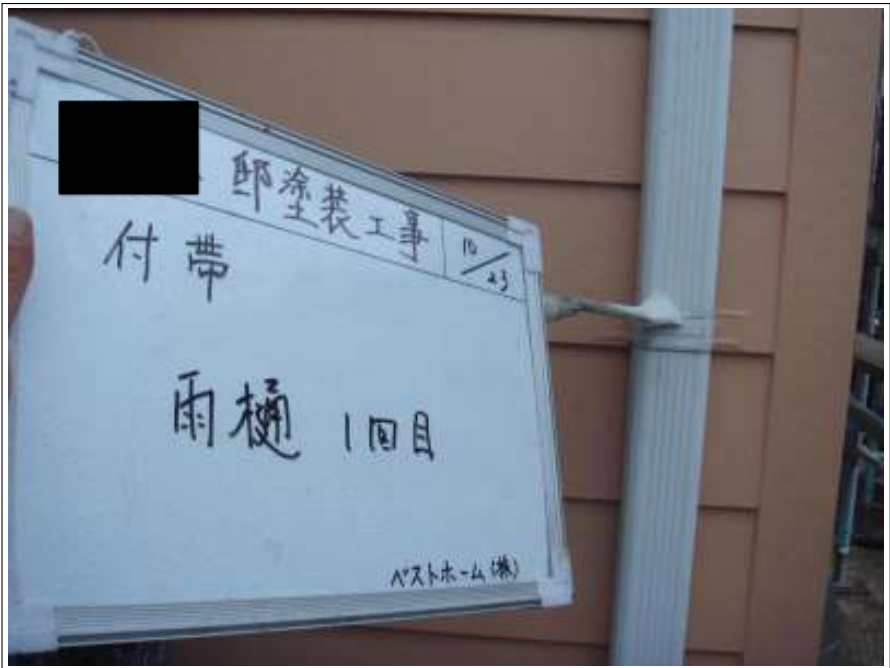
付帯雨樋 1 回目施工中
