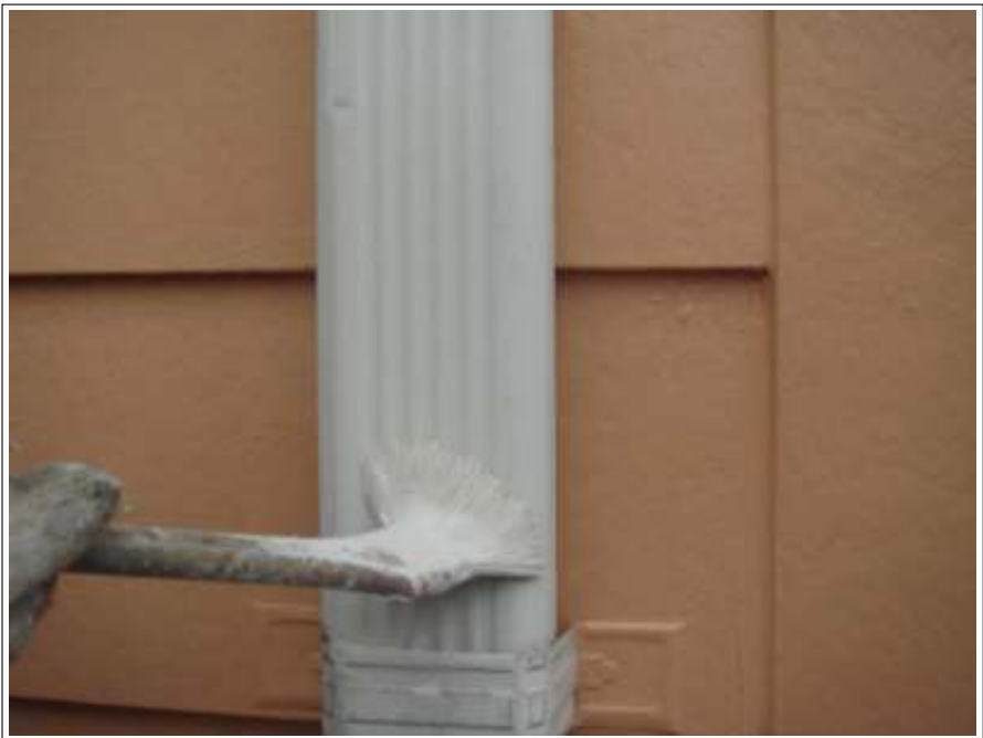
付帯雨樋 1 回目施工中
