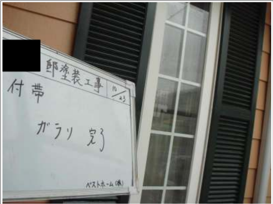
付帯ガラリ上塗り 2 回目施工完了
