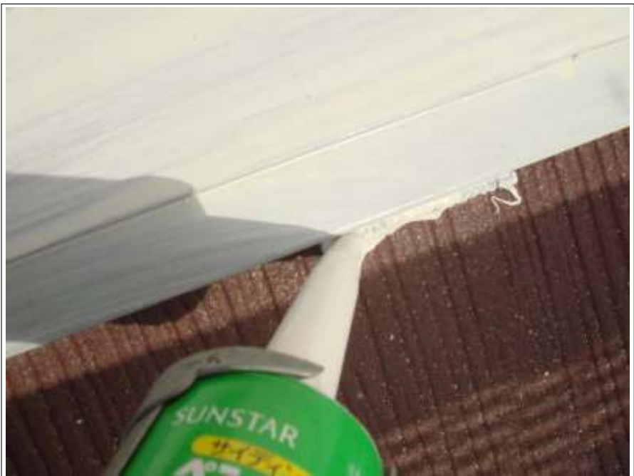
屋根板金ラバー止め施工中
