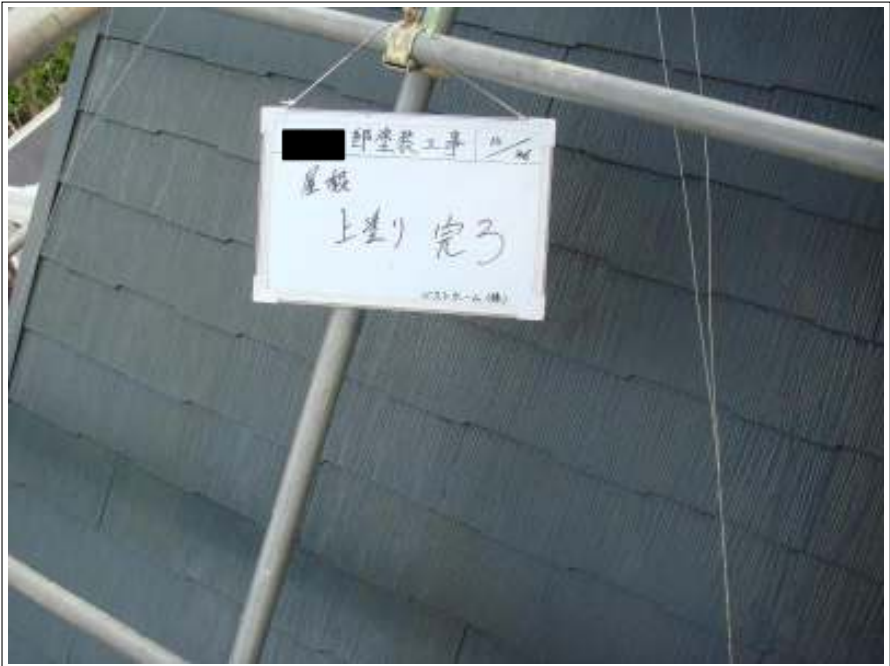
屋根塗装上塗り施工完了
