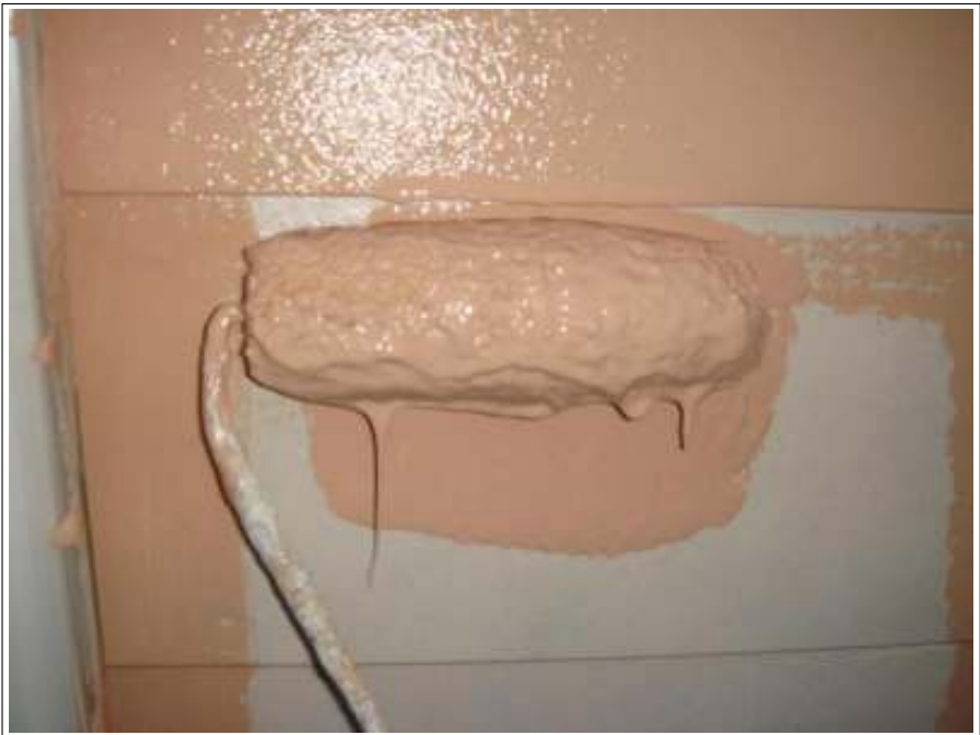
外壁中塗り施工中
