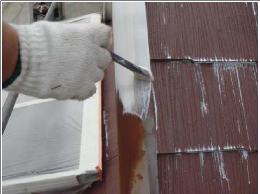
屋根板金サビ止め塗り施工中
