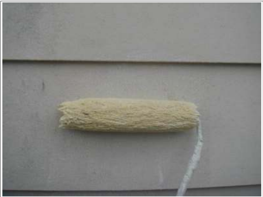
外壁下塗り施工中
