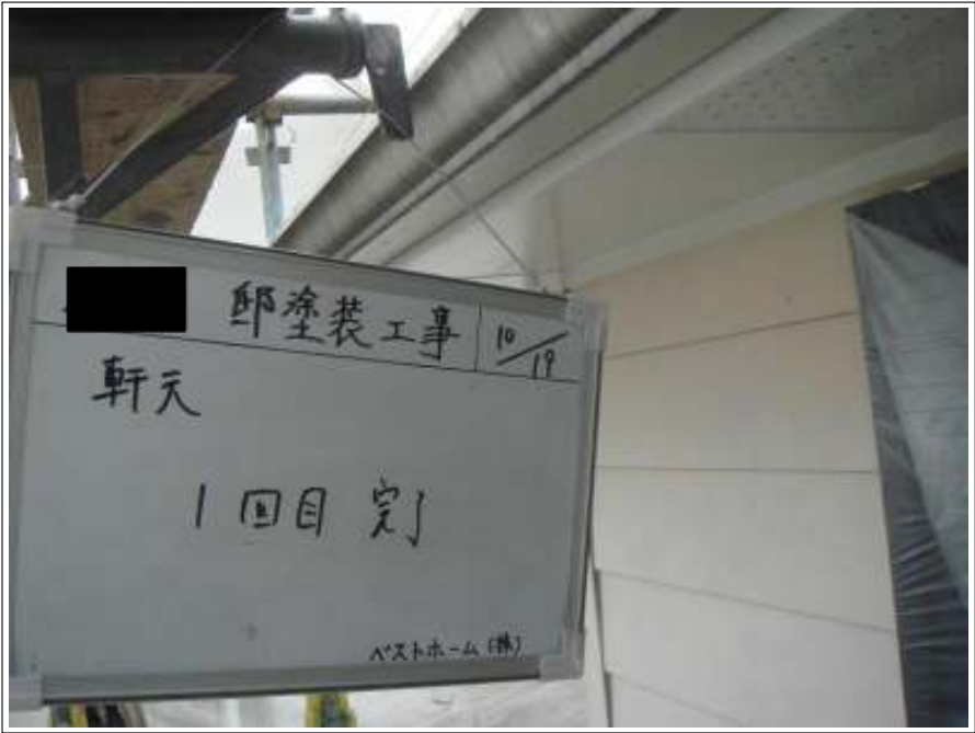
軒天塗装 1 回目施工完了
