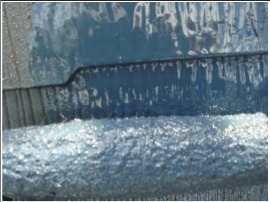
屋根塗装上塗り施工中
