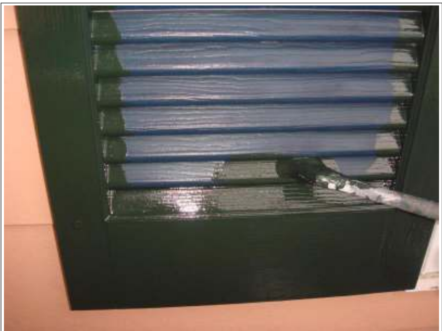
付帯ガラソ上塗り 1 回目施工中
