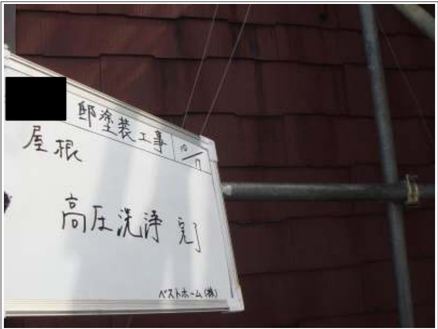
屋根高圧洗浄完了
