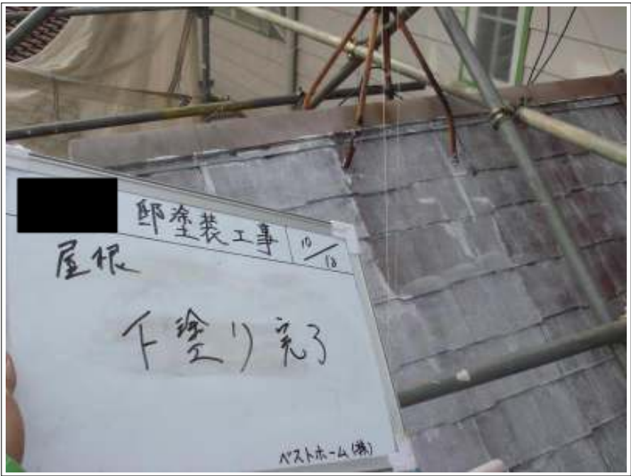
屋根下塗り施工完了
