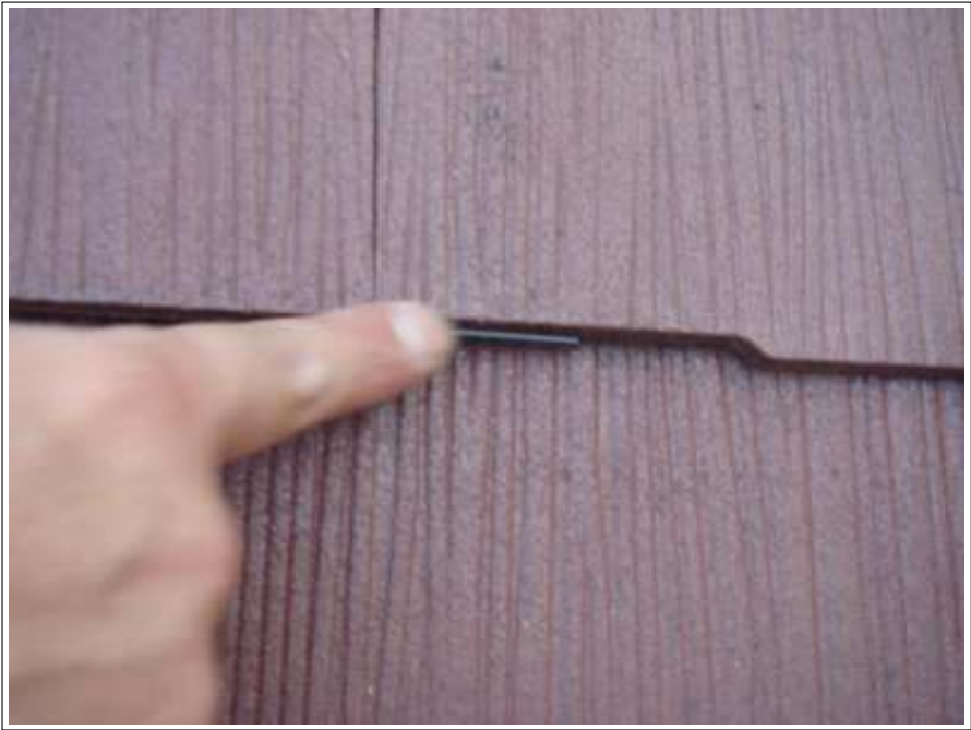
屋根タスペーサー取付施工後
