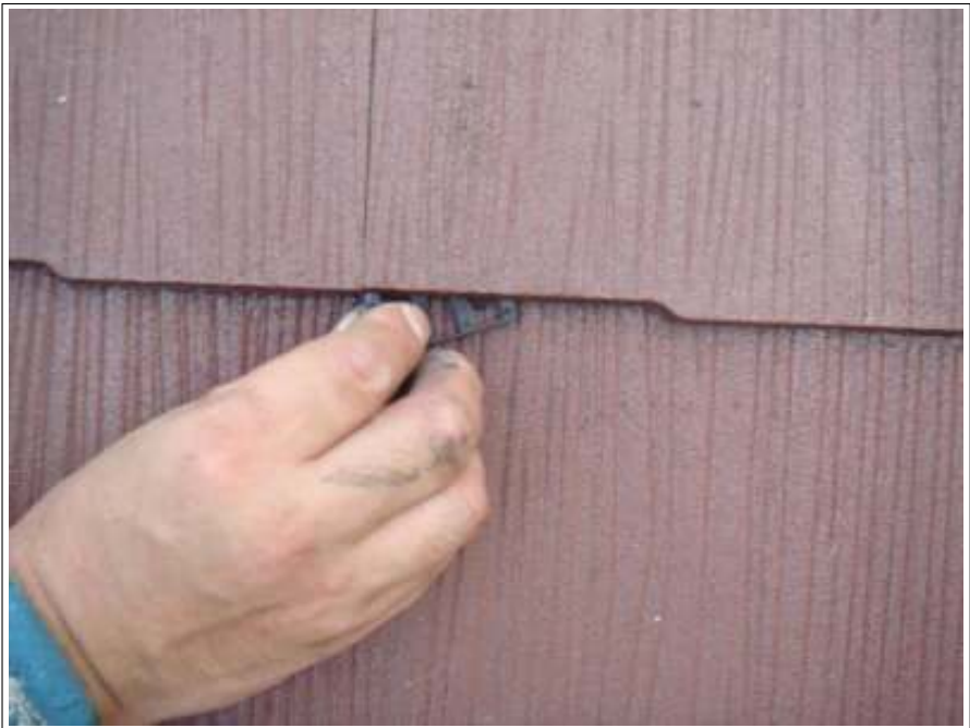
屋根タスペーサー取付施工中
