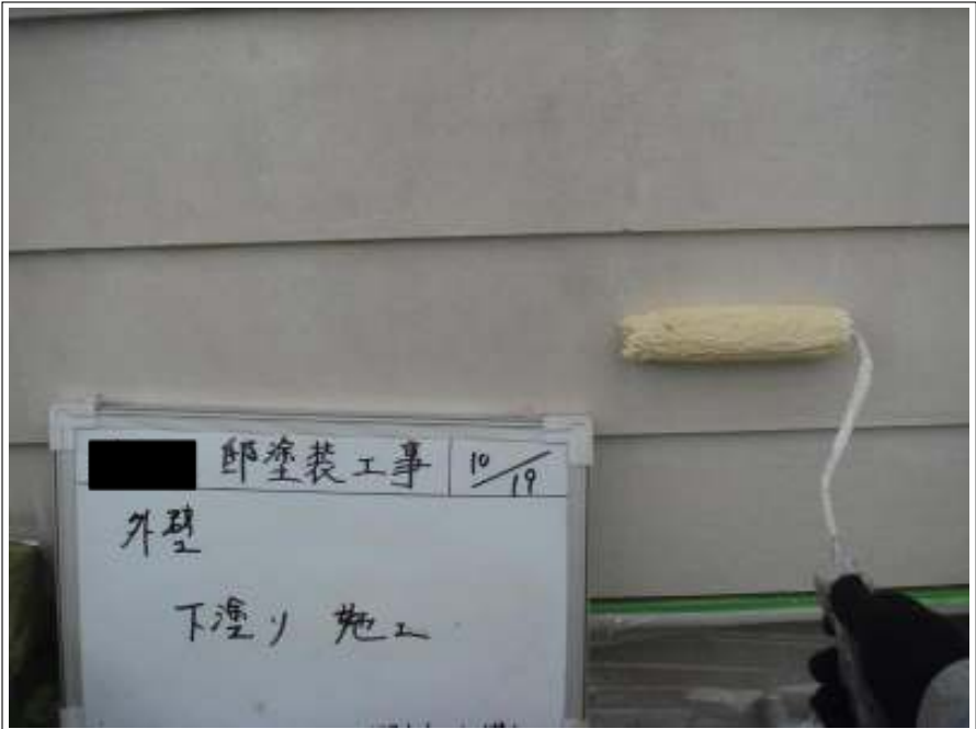
外壁下塗り施工中
