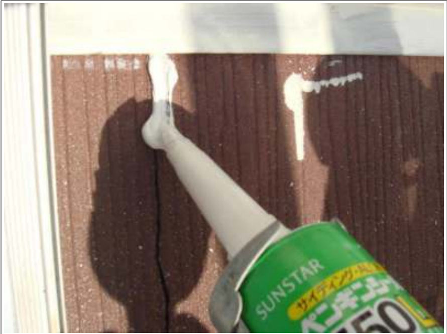
屋根クラック補修施工中
