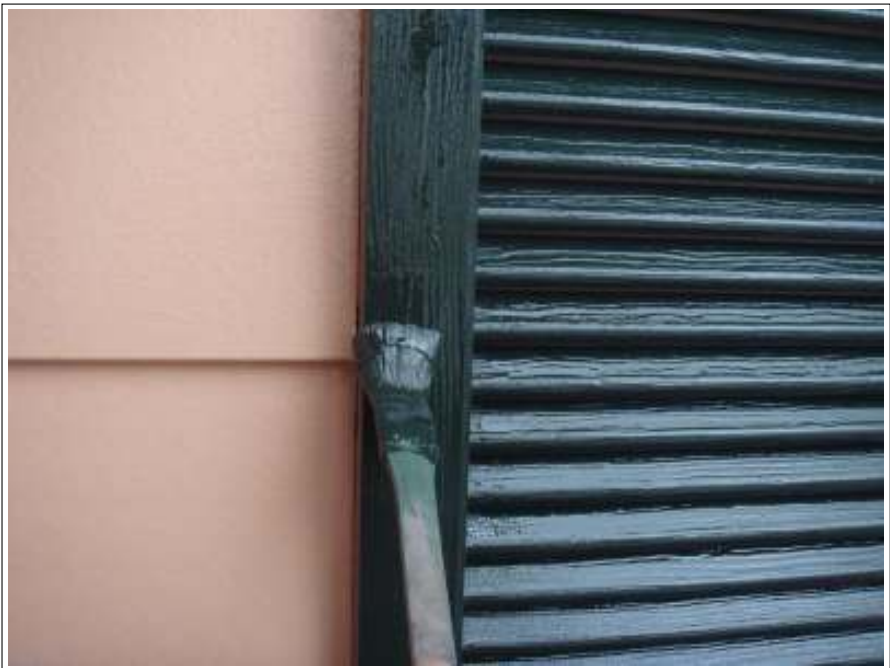
付帯ガラリ上塗り 2 回目施工中
