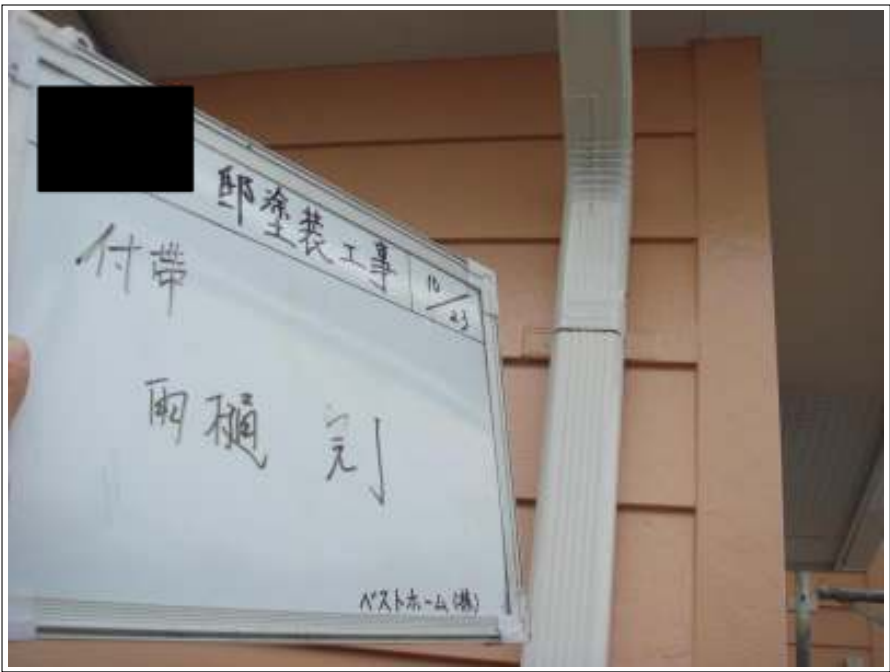
付帯雨樋 2 回目施工完了
