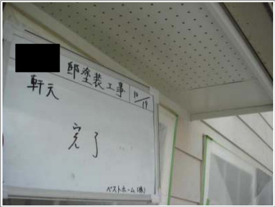
軒天塗装 2 回目施工完了
