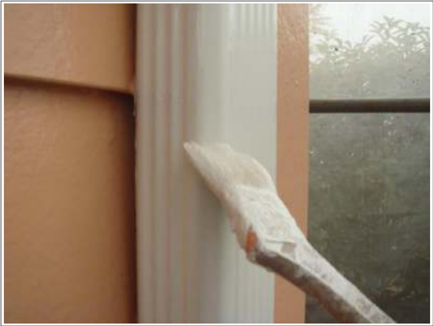
付帯雨樋 2 回目施工中
