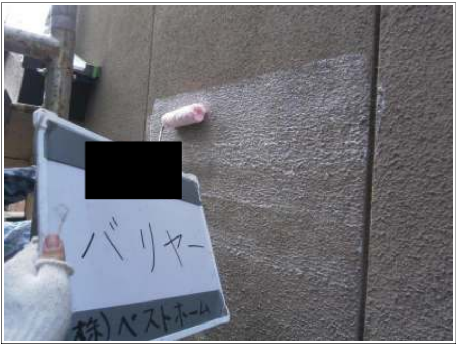
バリアー施工中
