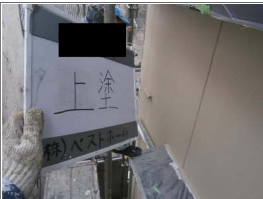
上塗り施工完了
