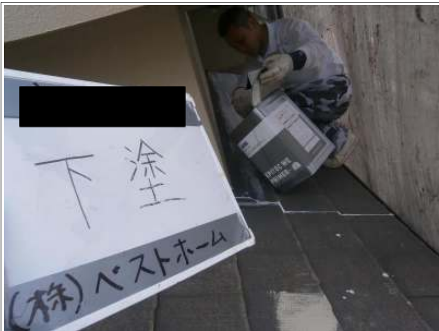
下塗り施工中
