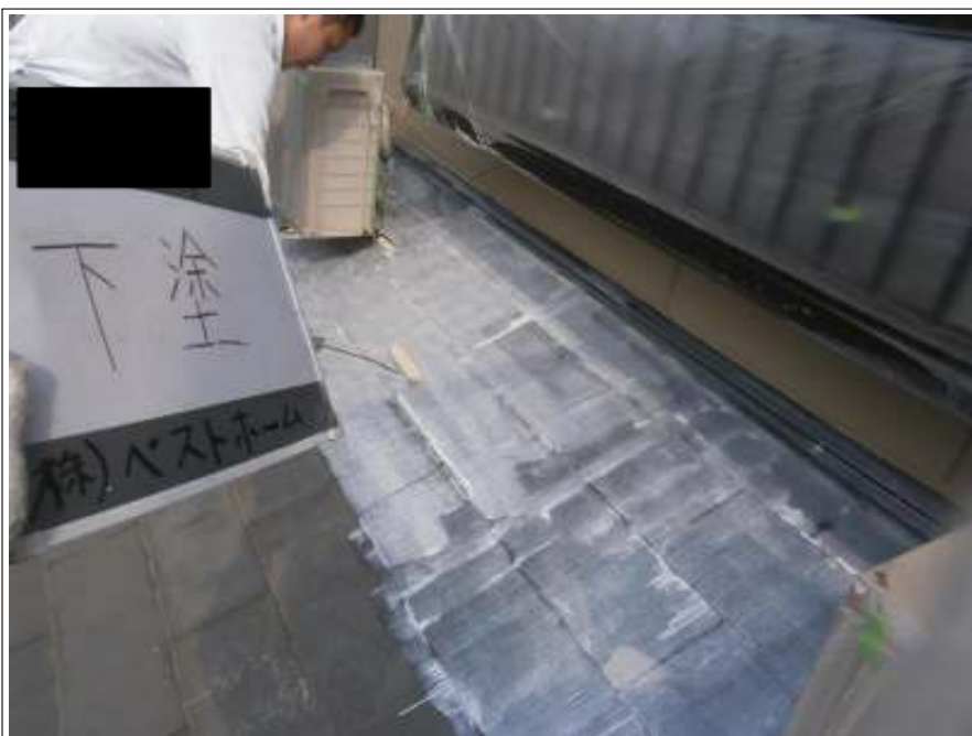
下塗り施工中
