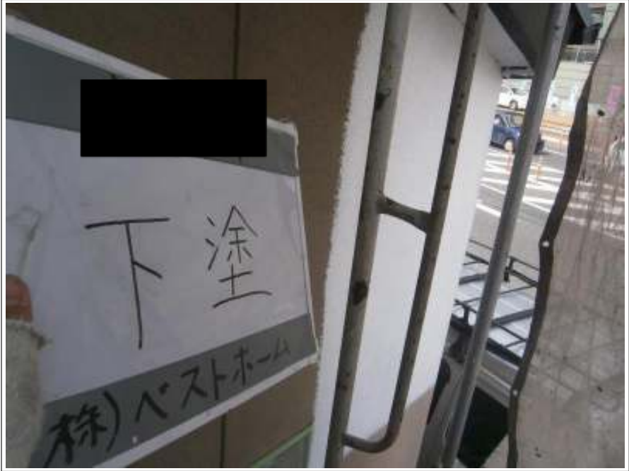
下塗り施工状況
