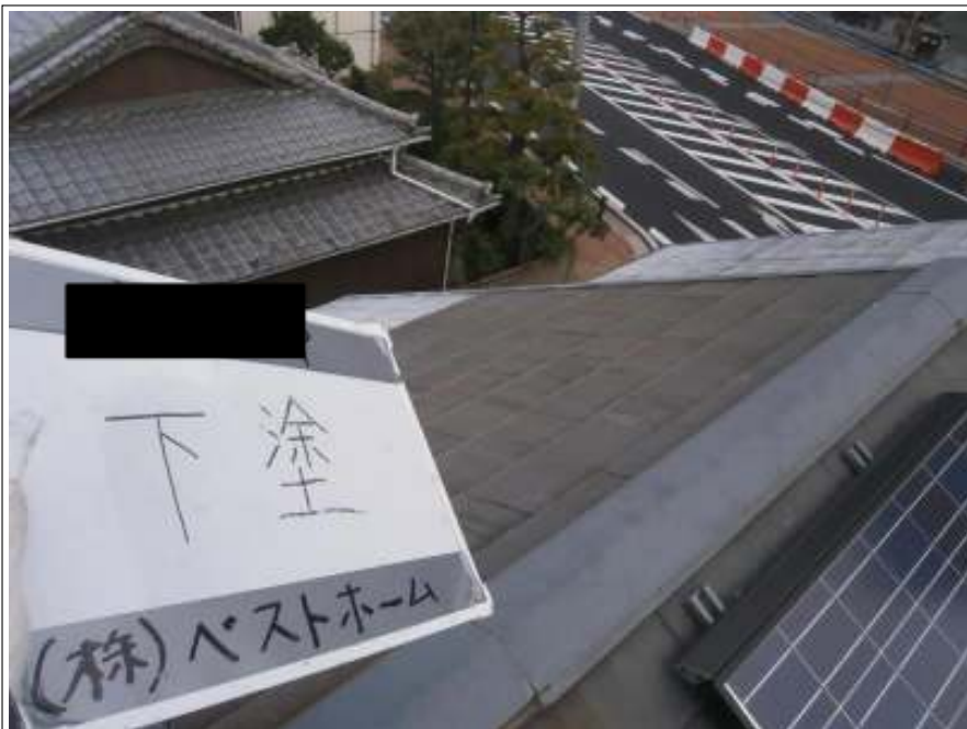
下塗り施工状況
