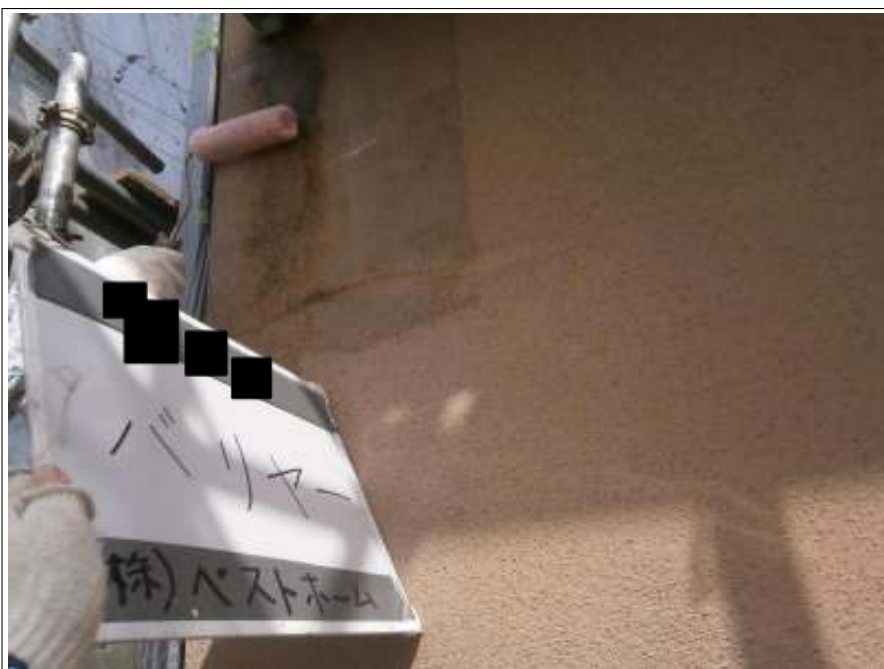
バリアー施工中
