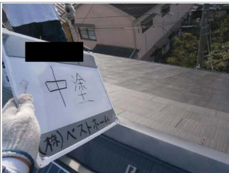
中塗り施工状況
