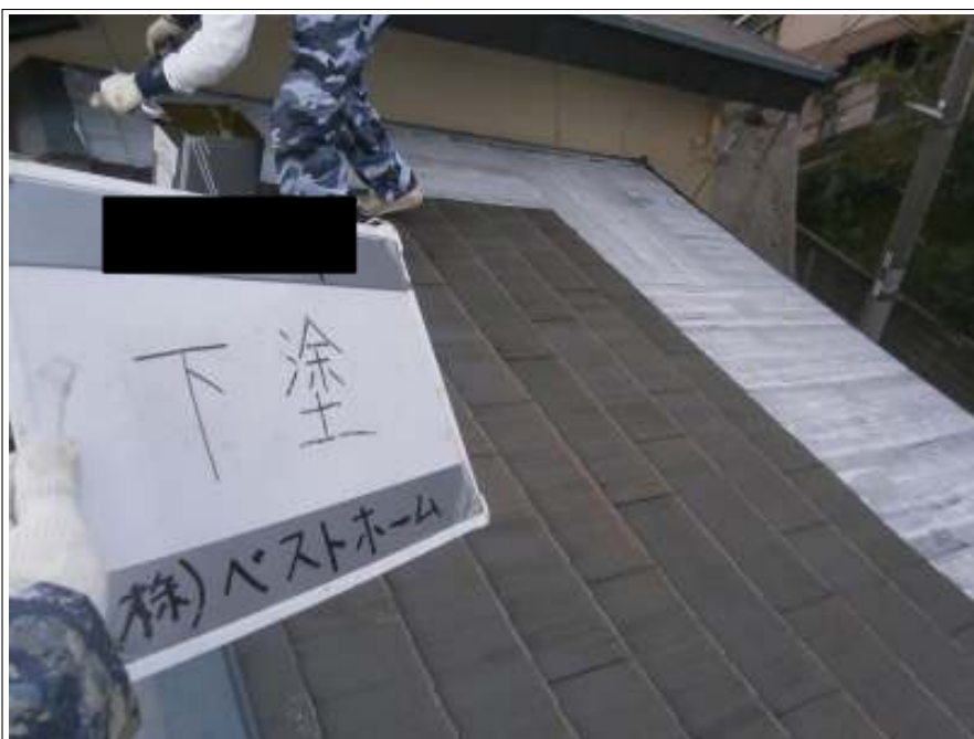
下塗り施工中
