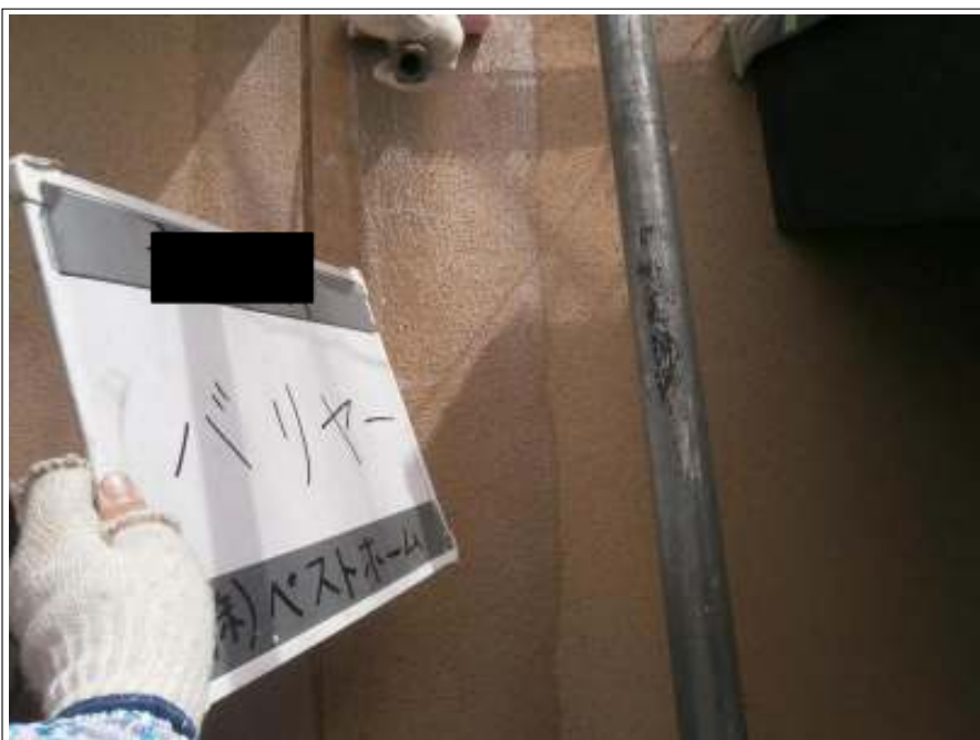
バリアー施工中
