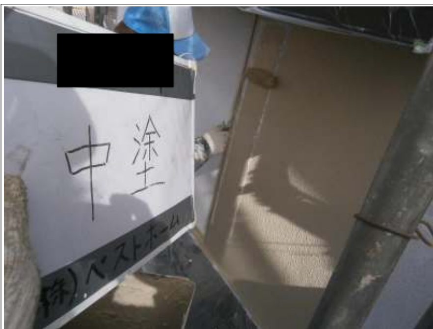
中塗り施工中
