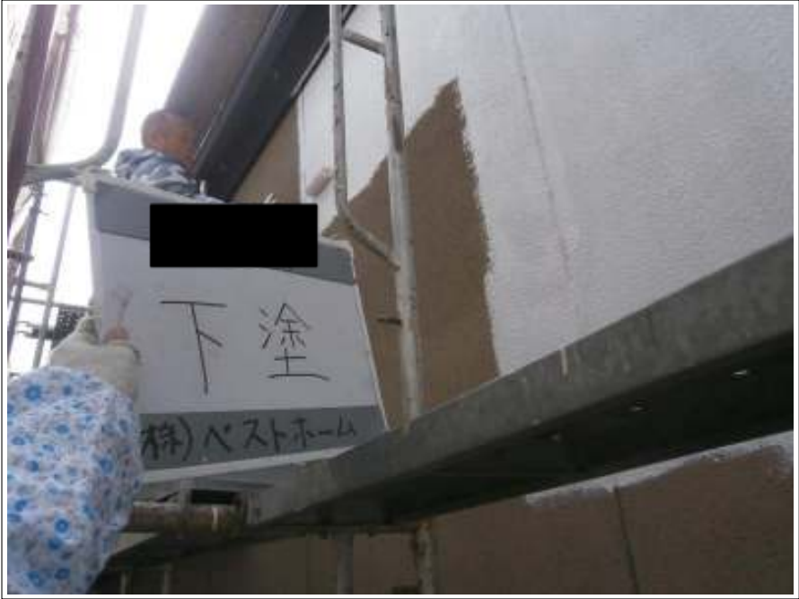
下塗り施工中
