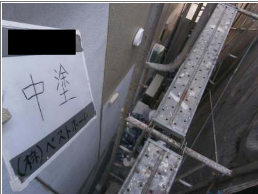
中塗り施工状況
