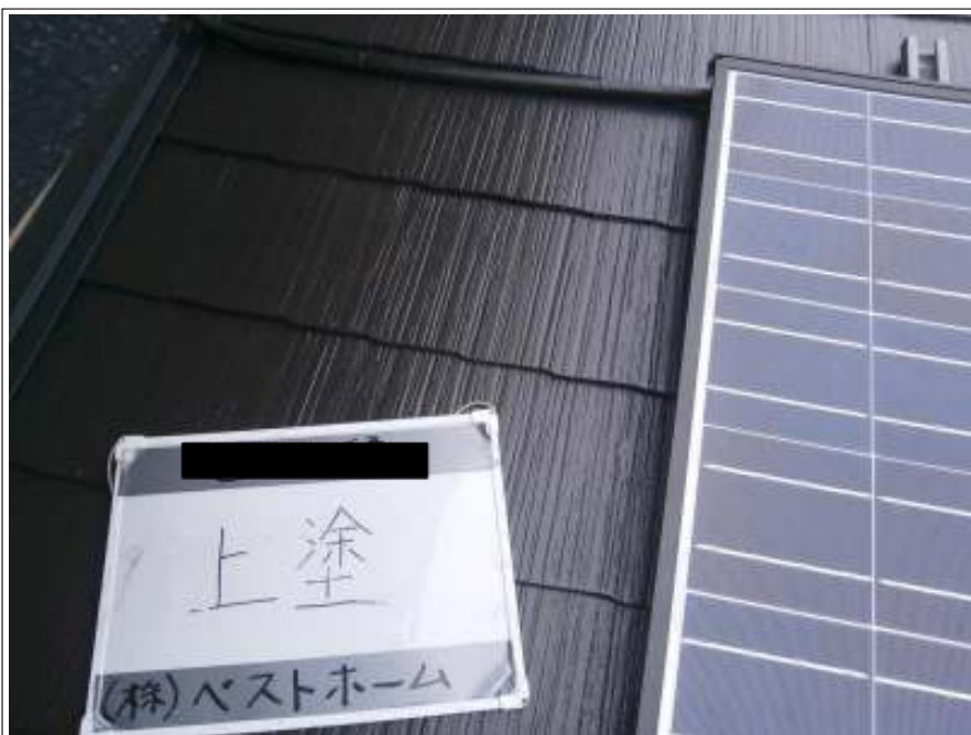
上塗り施工状況
