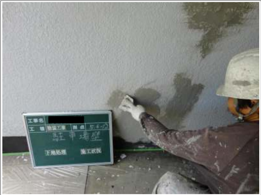
駐車場外壁下地処理施工中
