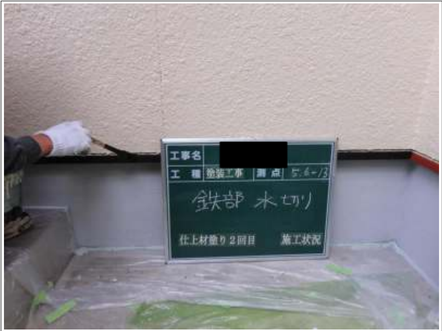
水切上塗り施工状況（2回目）
