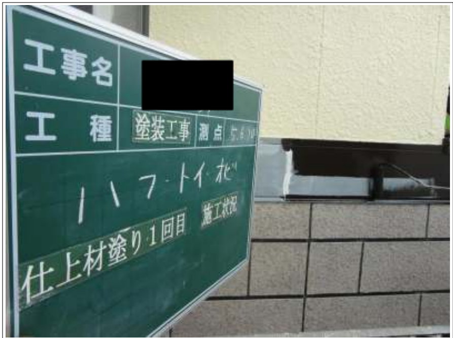
帯上塗り施工状況（1回目）
