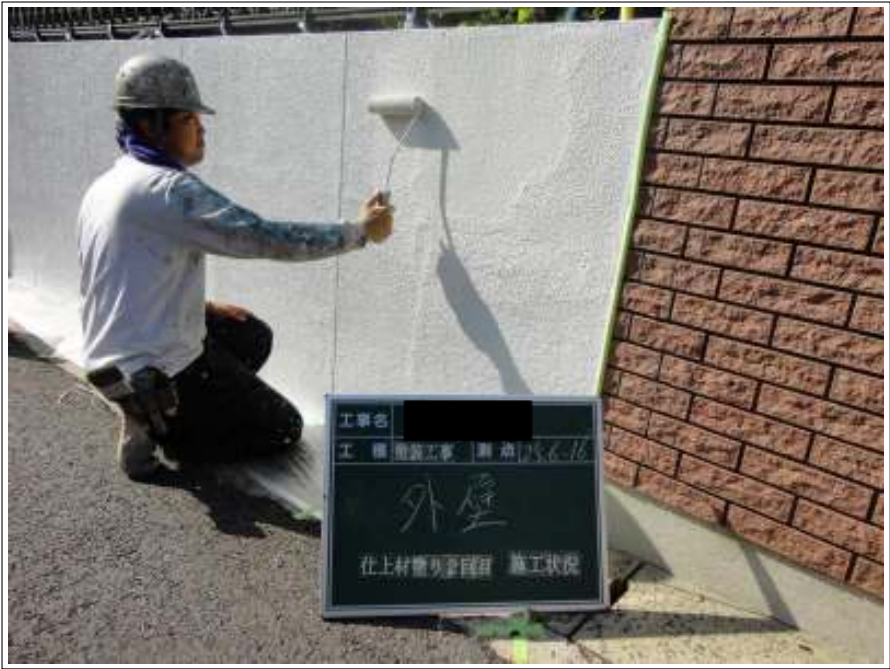
外塀上塗り施工状況（2回目）
