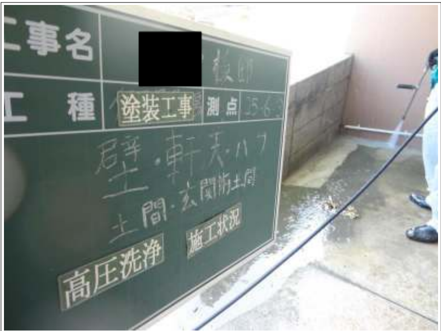
土間高压洗浄施工中
