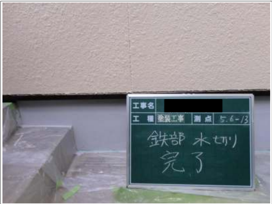
水切施工完了
