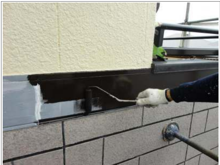
帯上塗り施工中（1回目）
