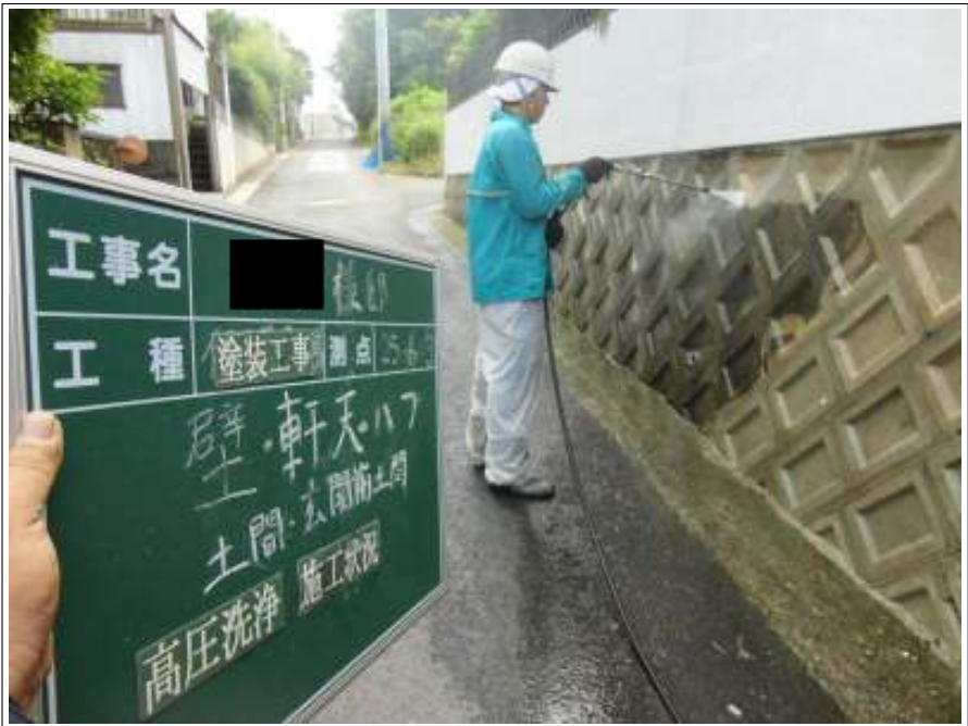
外塀高圧洗浄施工状況
