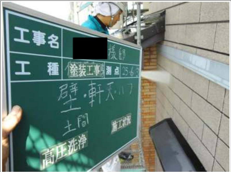
外壁高圧洗浄施工中
