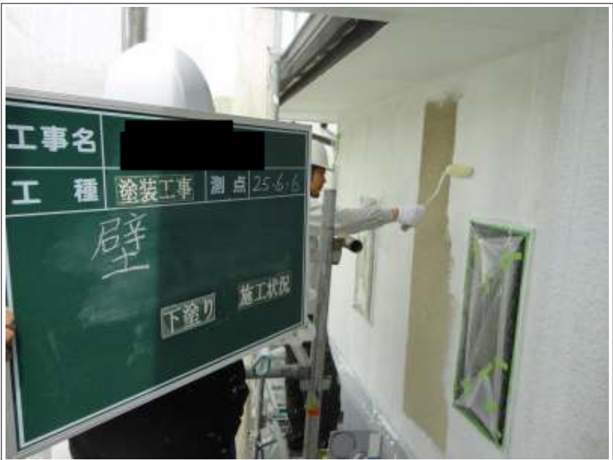
外壁下塗り施工状況
