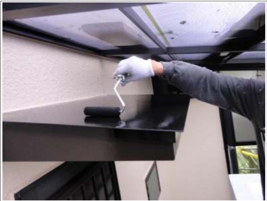
小底上塗り施工中（2回目）
