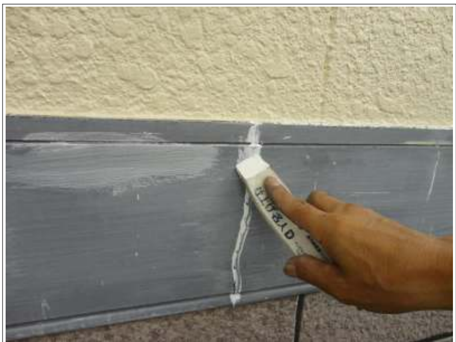
帯下地処理施工中
