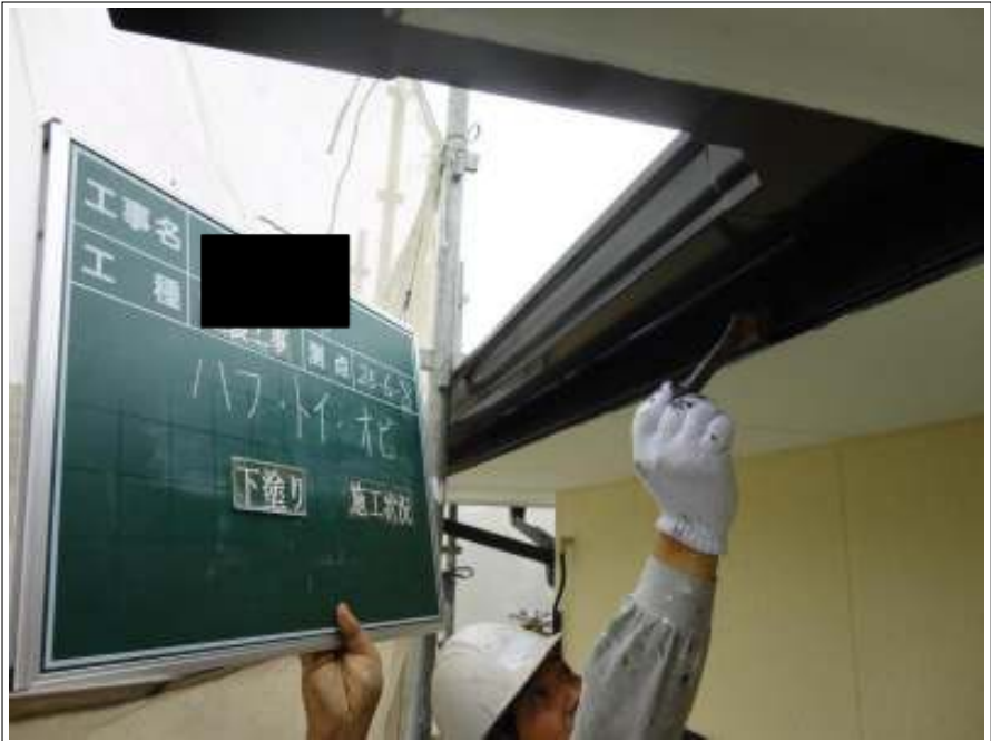
破風下塗り施工状況
