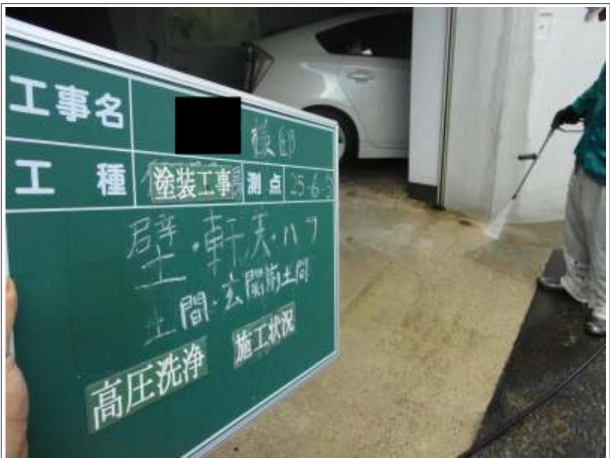
土間高压洗浄施工中
