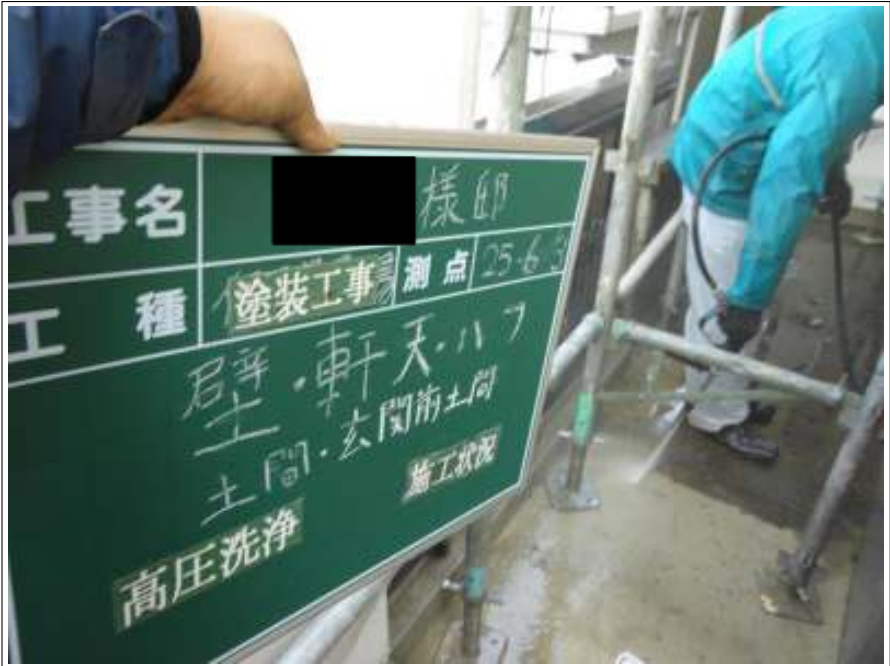
土間高圧洗浄施工状況
