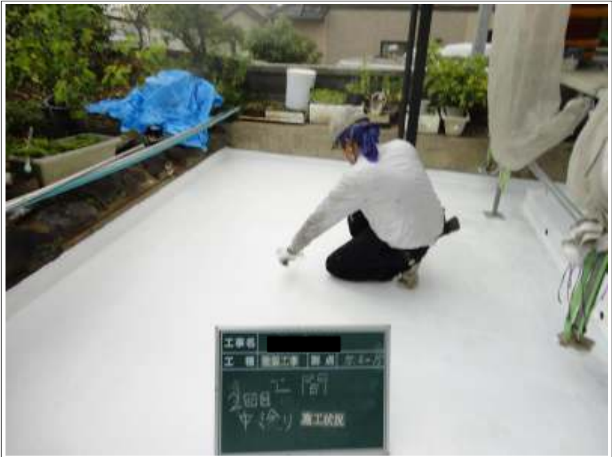
土間中塗り施工状況（2回目）
