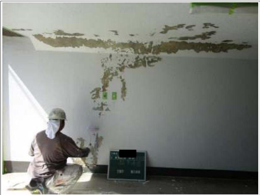
駐車場外壁下塗り施工状況
