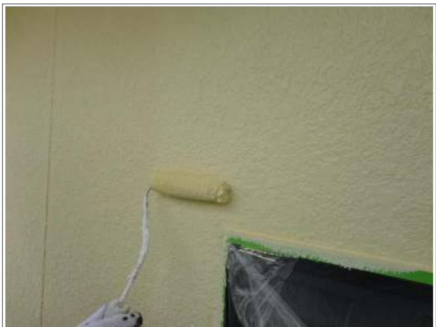
外壁上塗り施工中（2回目）
