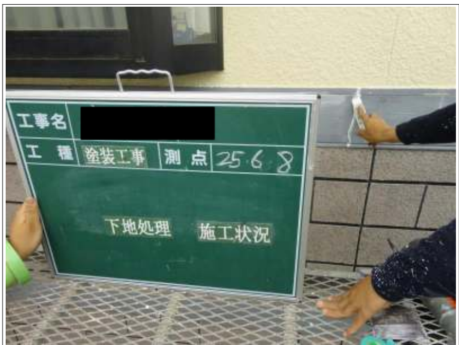
帯下地処理施工状況
