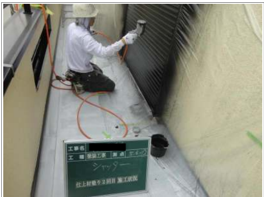
シャッター上塗り施工状況（2回目）
