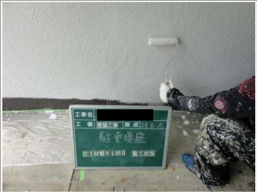
駐車場外壁上塗り施工状況（1回目）
