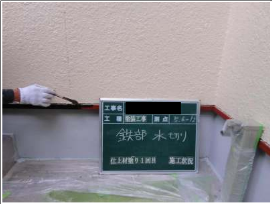
水切上塗り施工状況（1回目）
