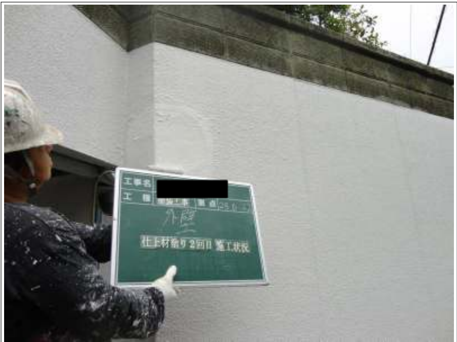
外塀上塗り施工状況（2回目）
