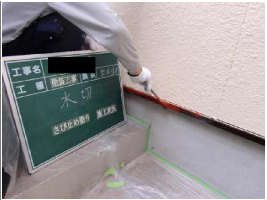
水切サビ止め施工状況
