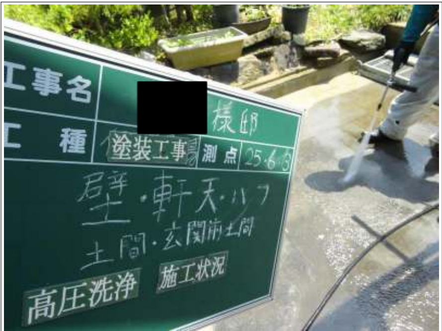
土間高圧洗浄施工中
