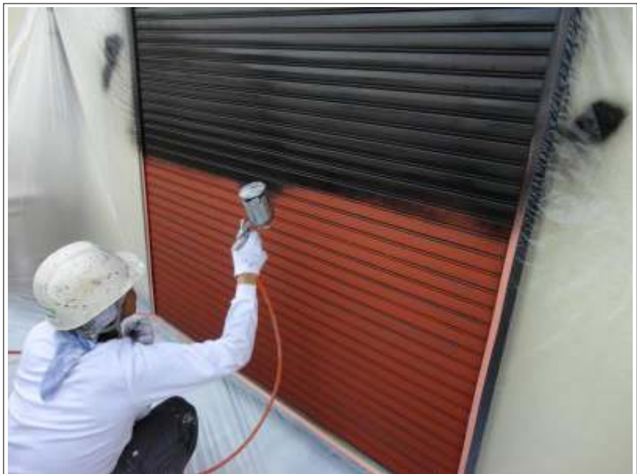
シャッター上塗り施工中（1回目）
