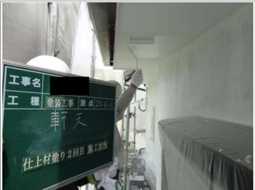
軒天上塗り施工状況（2回目）
