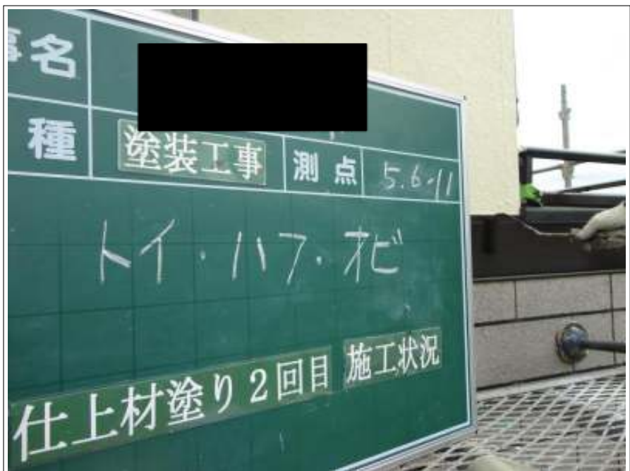
帯上塗り施工状況（2回目）
