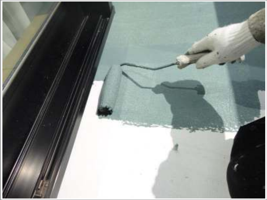
バルコニー上塗り施工中（1回目）
