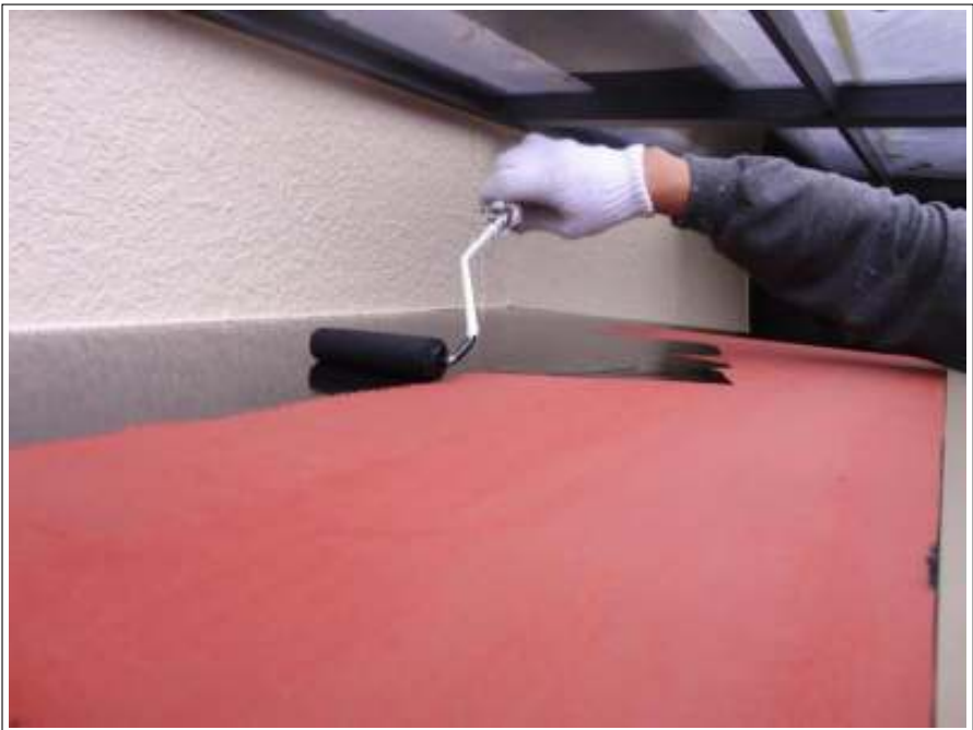
小底上塗り施工中（1回目）
