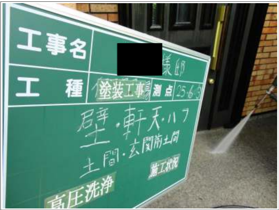
玄関前高圧洗浄施工状況
