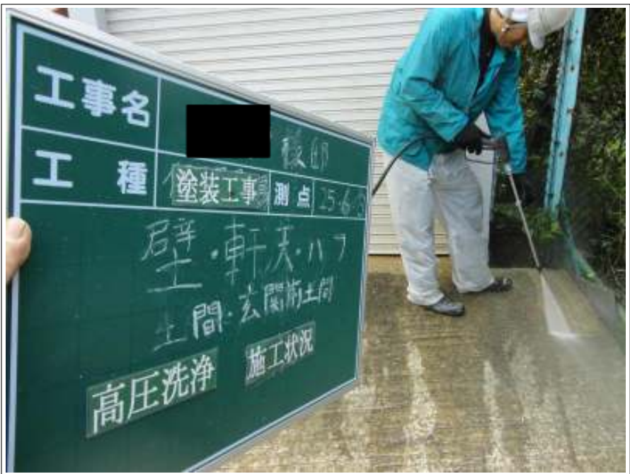
土間高压洗浄施工中
