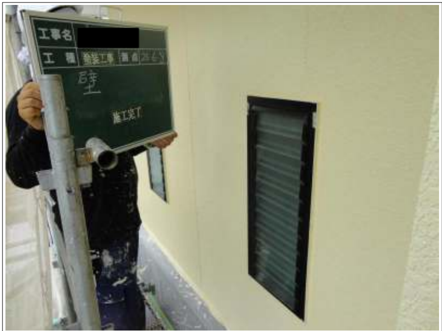
外壁上塗り施工完了（2回目）
