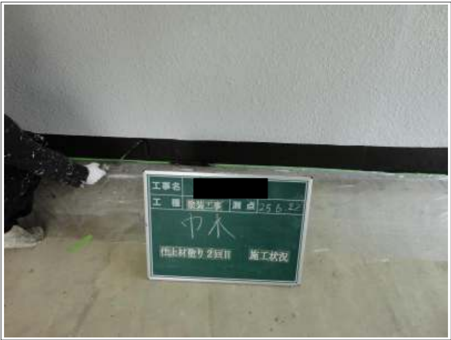
巾木上塗り施工状況（2回目）
