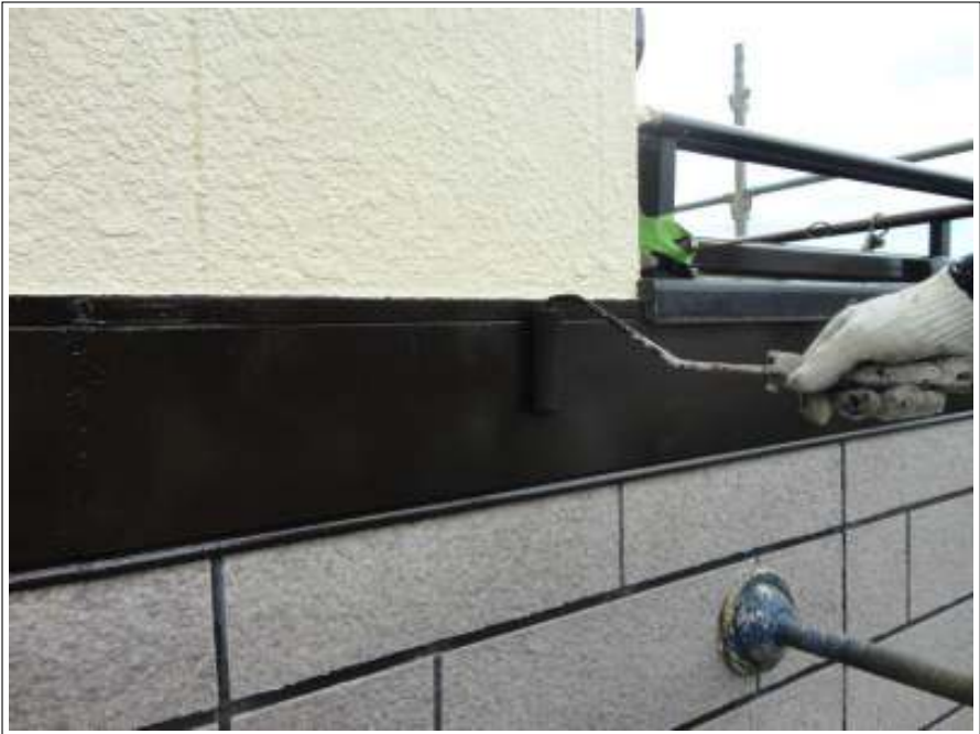
帯上塗り施工中（2回目）
