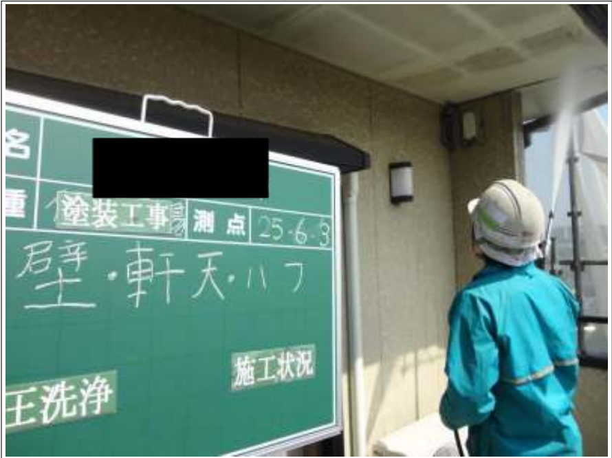
軒天高圧洗浄施工状況
