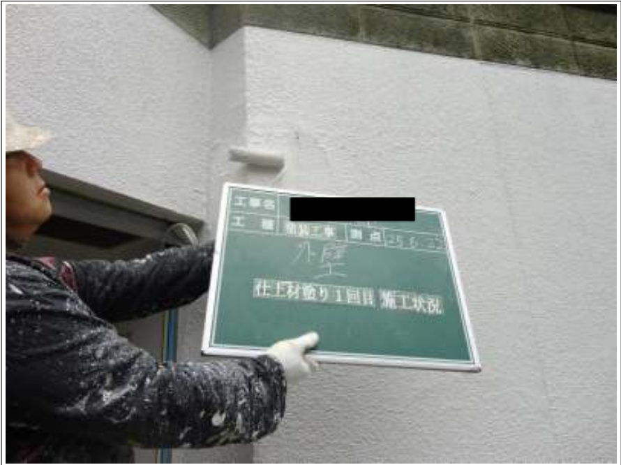
外塀上塗り施工状況（1回目）
