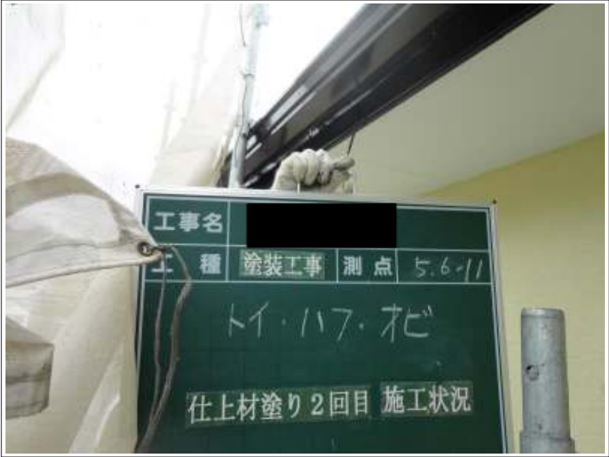
破風上塗り施工状況（2回目）
