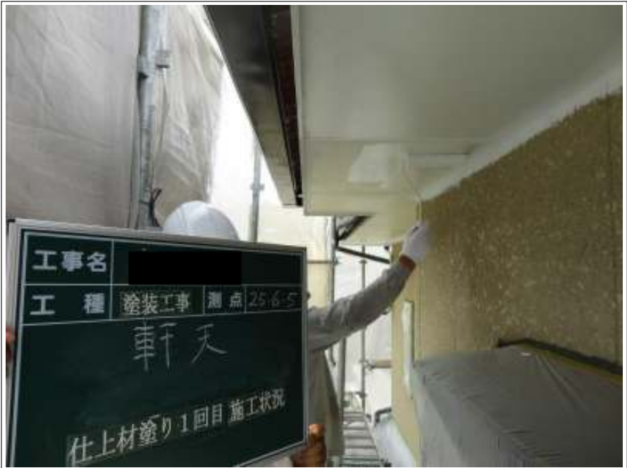
軒天上塗り施工状況（1回目）
