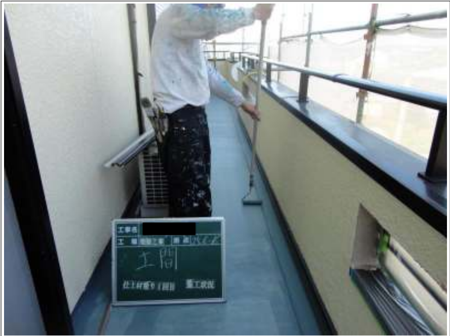
バルコニー上塗り施工状況（2回目）
