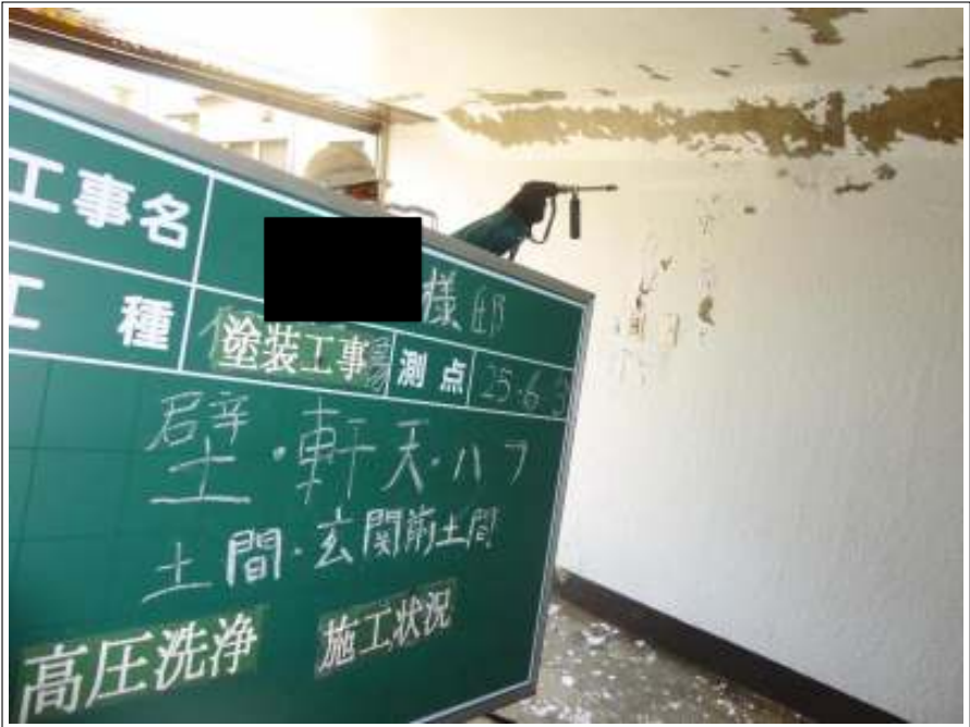
駐車場壁高圧洗浄施工状況
