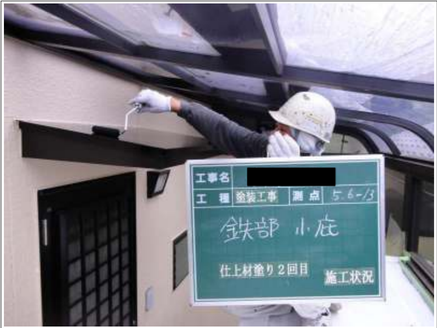
小底上塗り施工状況（2回目）
