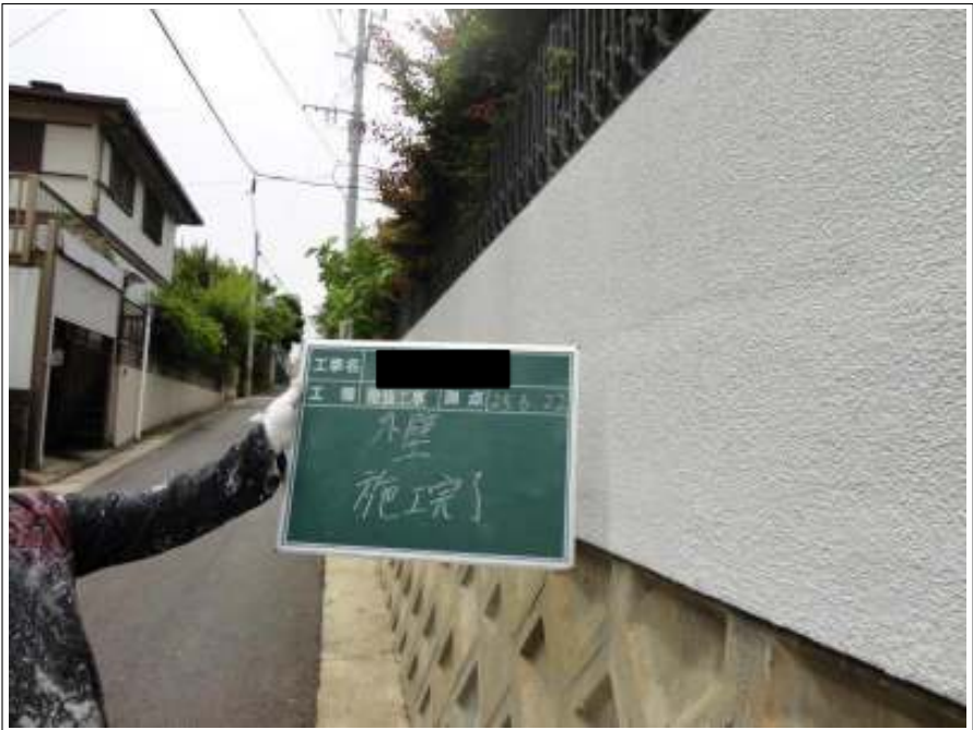
外塀上塗り施工完了
