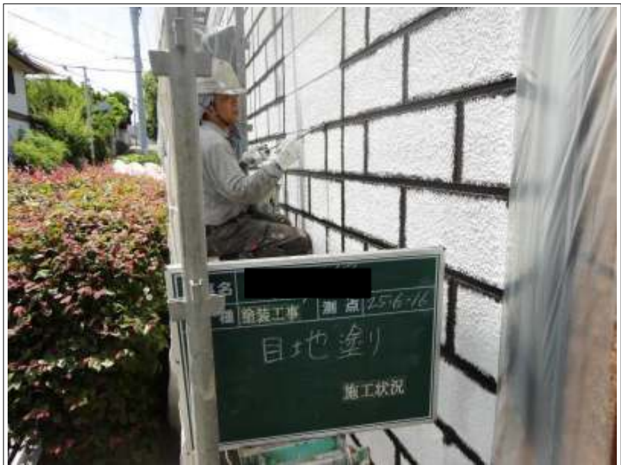
外壁目地施工状況
