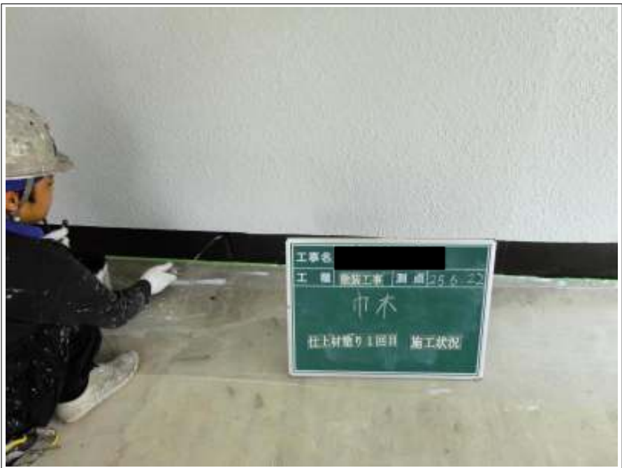
巾木上塗り施工状況（1回目）
