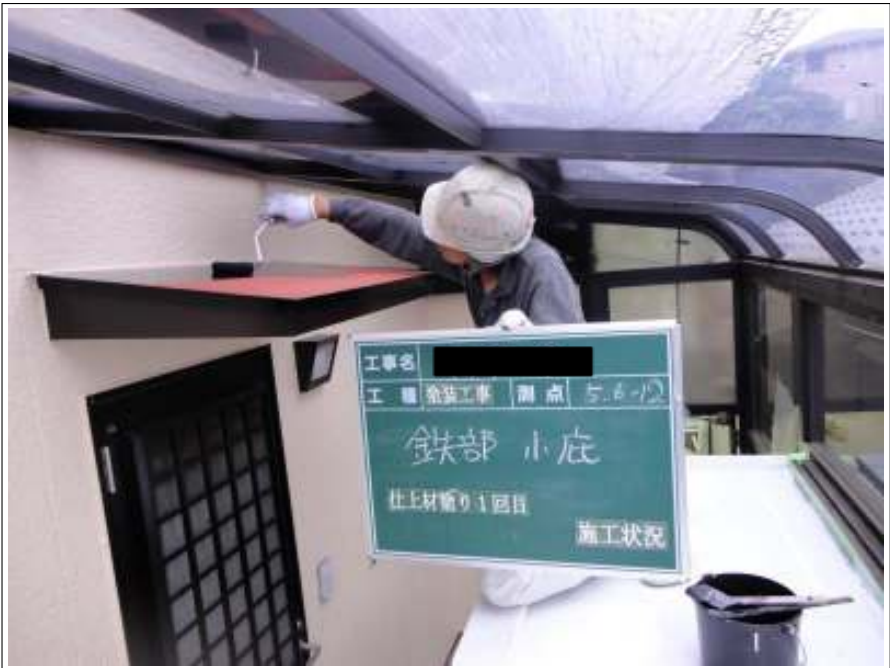
小底上塗り施工状況（1回目）
