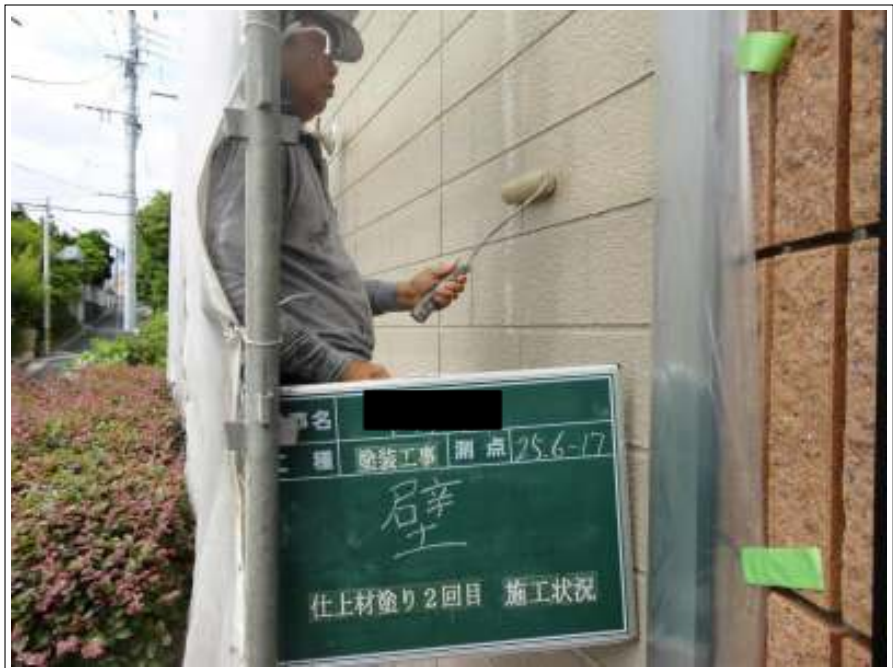
外壁上塗り施工状況（2回目）
