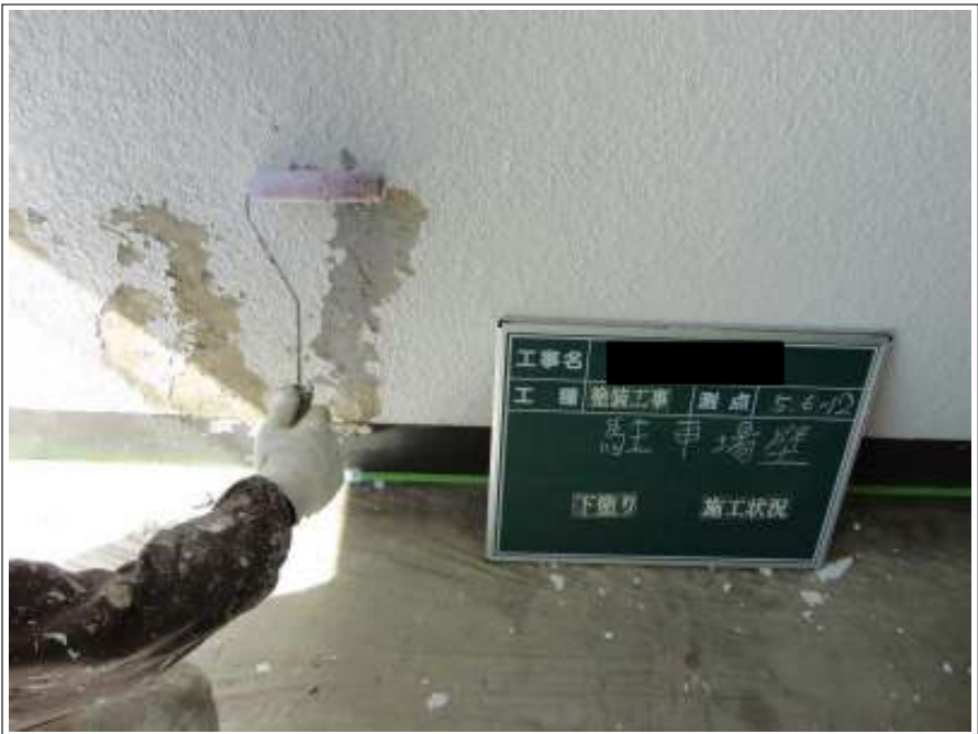
駐車場外壁下塗り施工中
