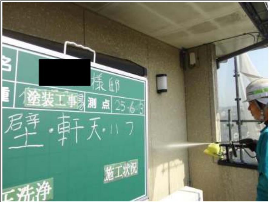
外壁高圧洗浄施工状況
