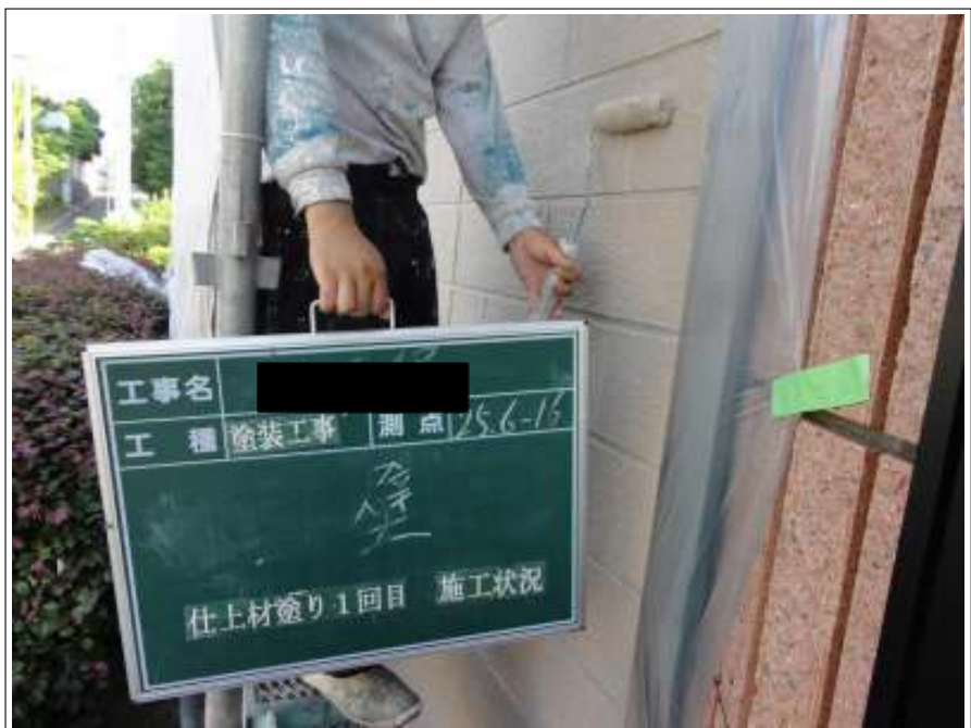
外壁上塗り施工状況（1回目）
