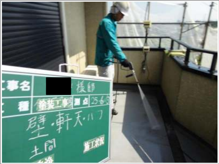
バルコニー高圧洗浄施工状況
