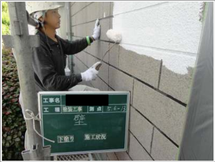
外壁下塗り施工状況
