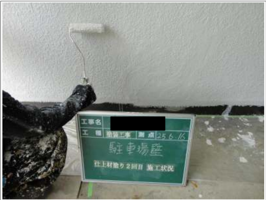
駐車場外壁上塗り施工状況（2回目）
