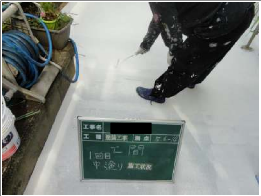
土間中塗り施工状況（1回目）
