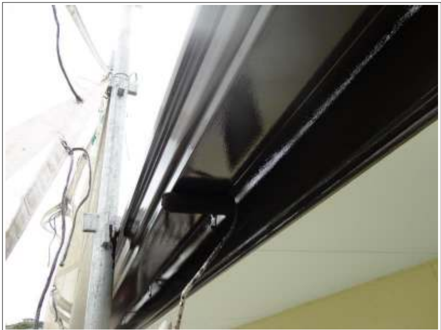
破風上塗り施工中（2回目）
