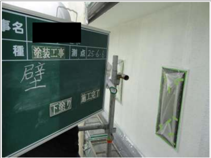
外壁下塗り施工完了
