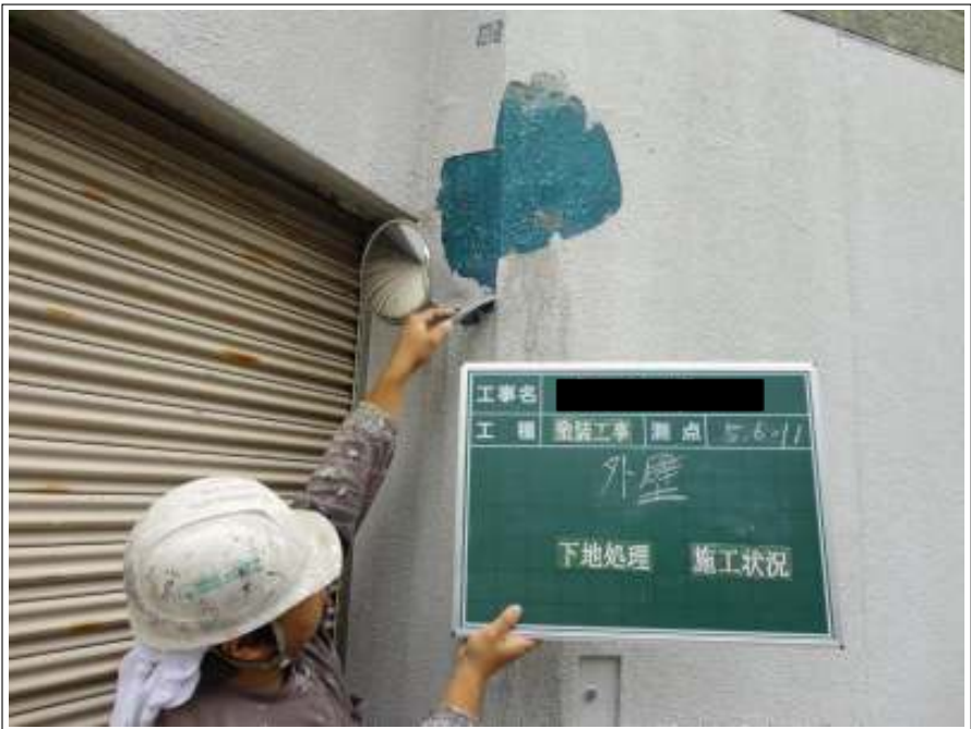
外壁下地処理施工状況
