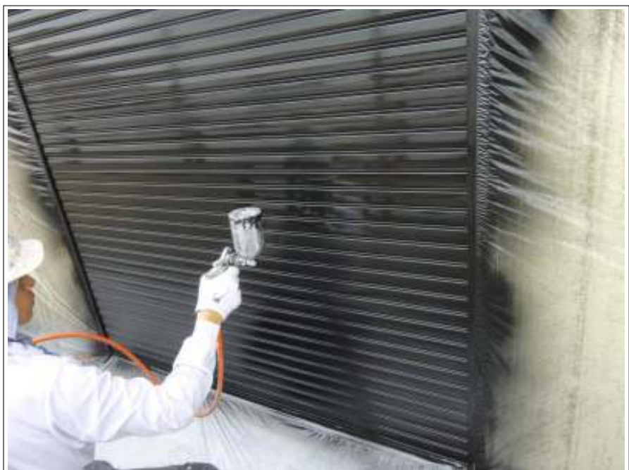
シャッター上塗り施工中（2回目）
