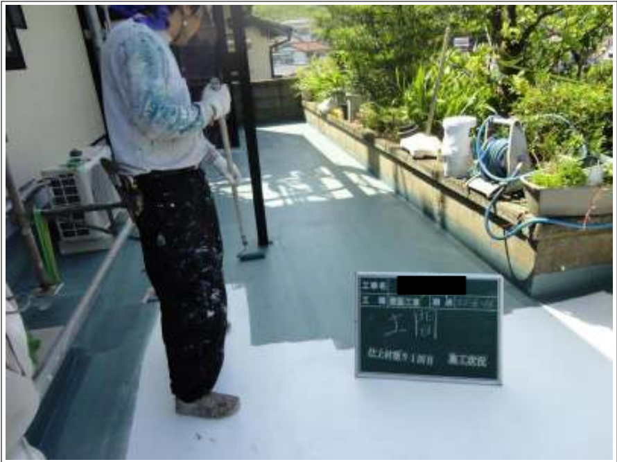
土間上塗り施工状況（1回目）
