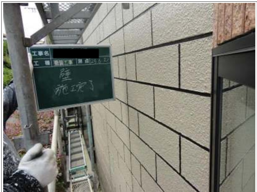
外壁上塗り施工完了
