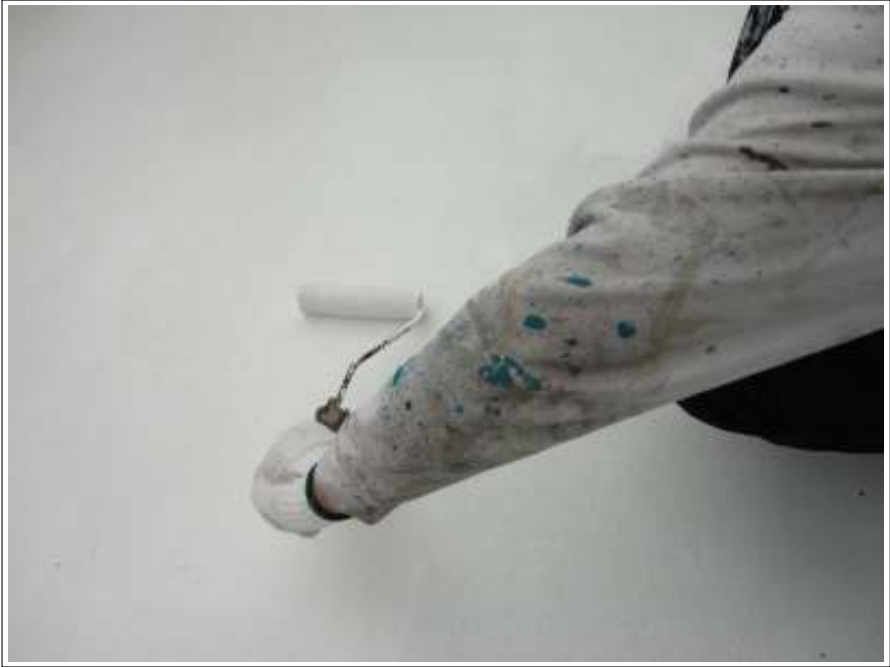
土間中塗り施工中（2回目）
