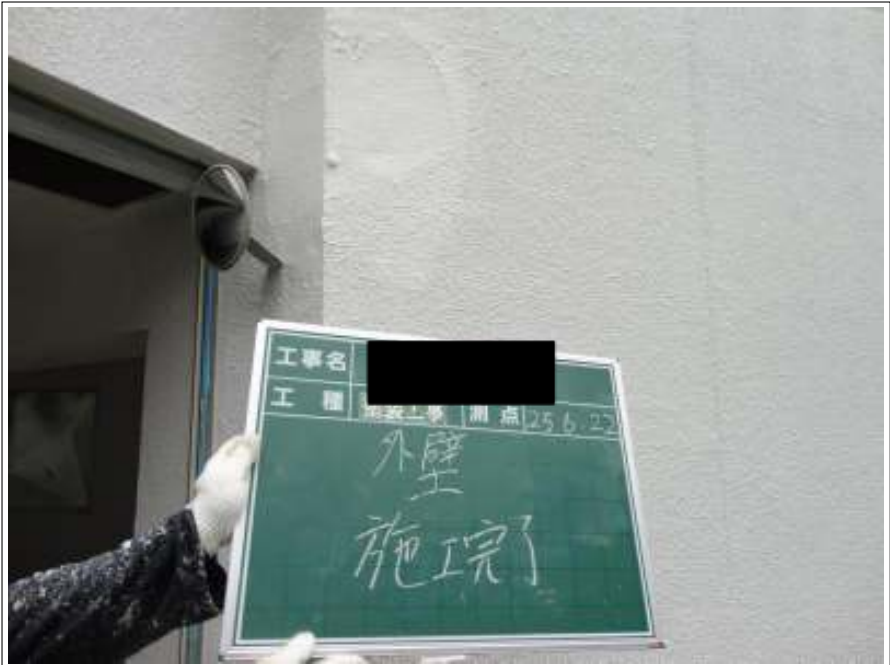
外塀上塗り施工完了
