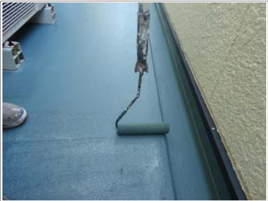
バルコニー上塗り施工中（2回目）
