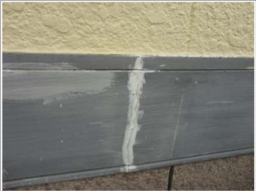
帯下地処理施工完了
