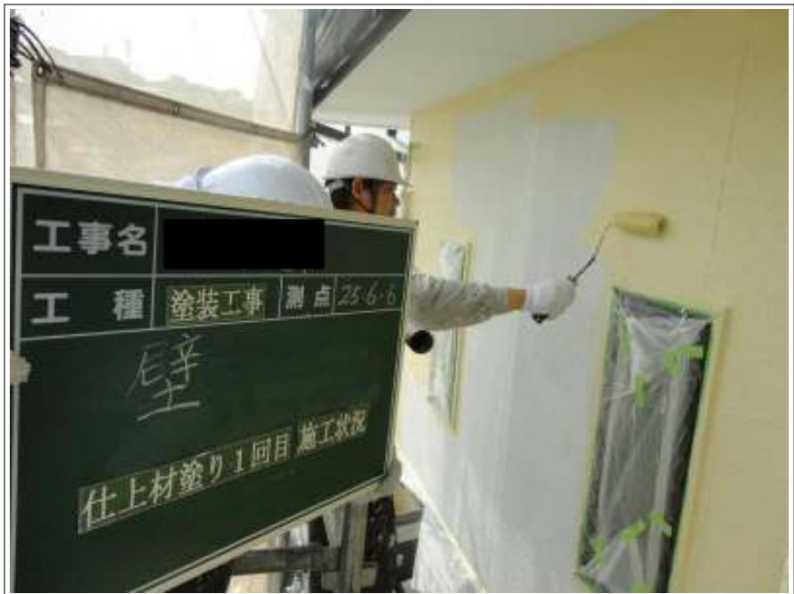
外壁上塗り施工状況（1回目）
