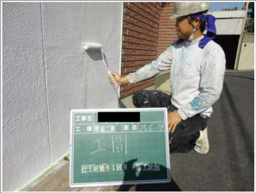
外塀上塗り施工状況（1回目）
