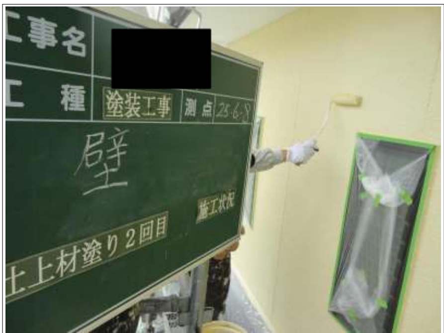
外壁上塗り施工状況（2回目）
