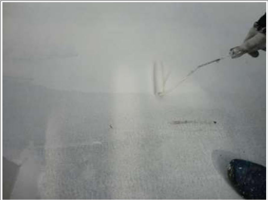
土間中塗り施工中（1回目）
