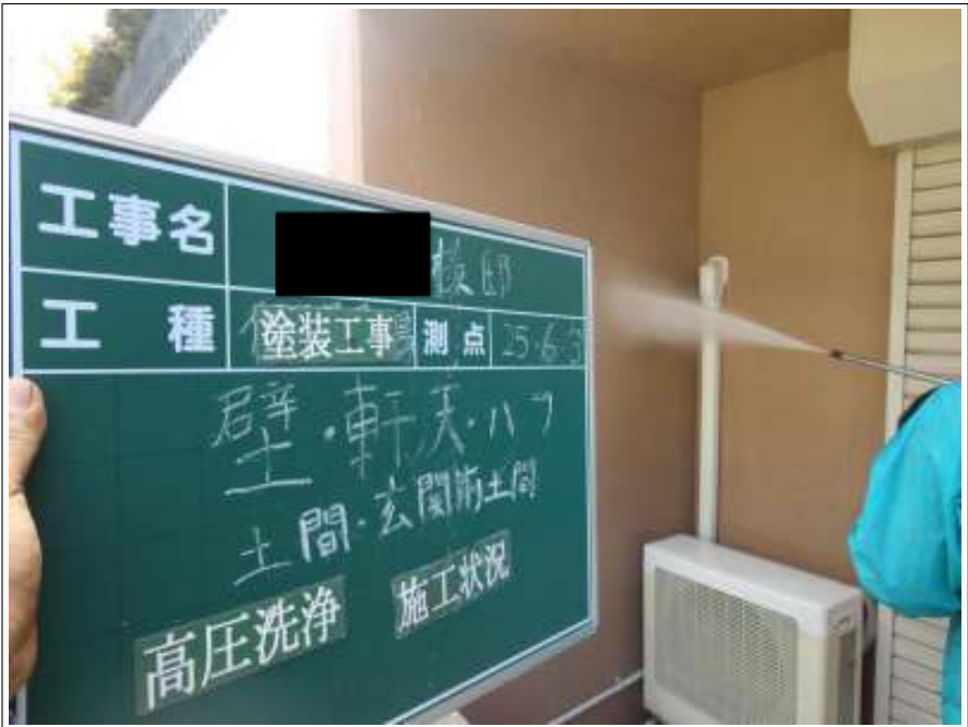
外壁高圧洗浄施工中
