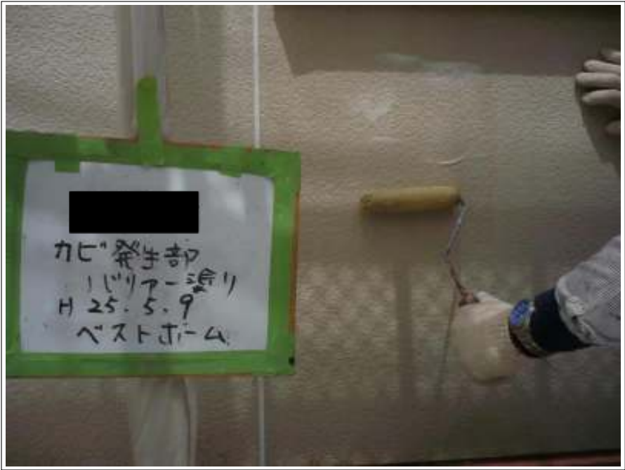
外壁バリアー施工状況
