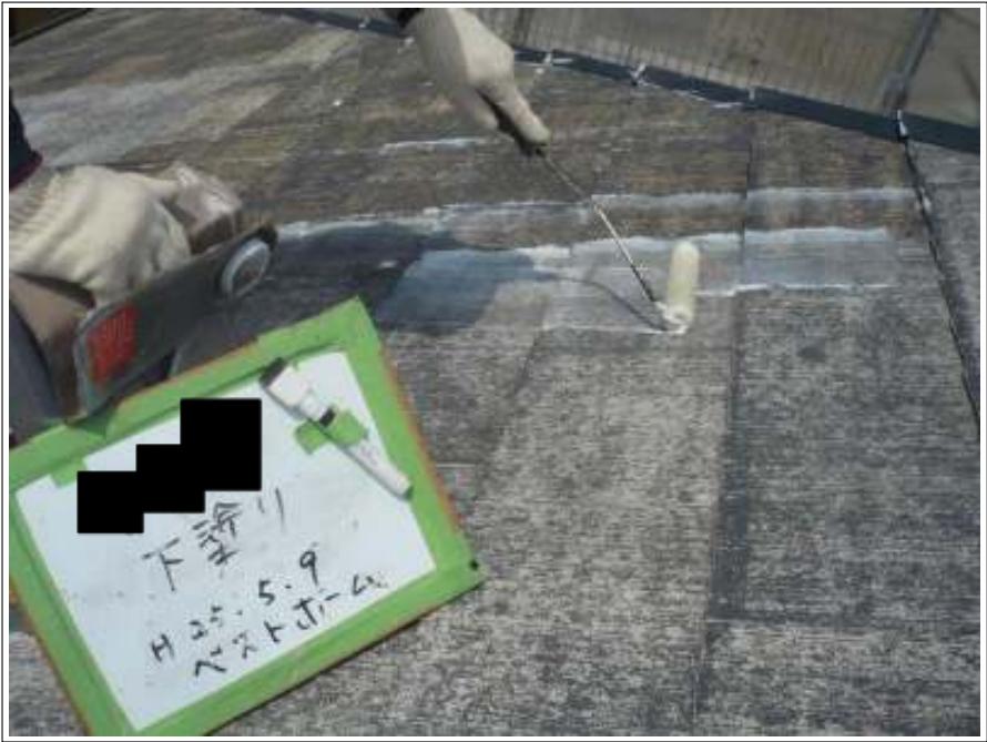
屋根下塗り施工状況
