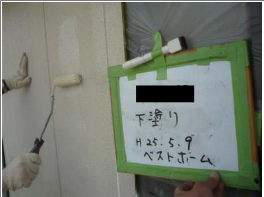
外壁下塗り施工状況
