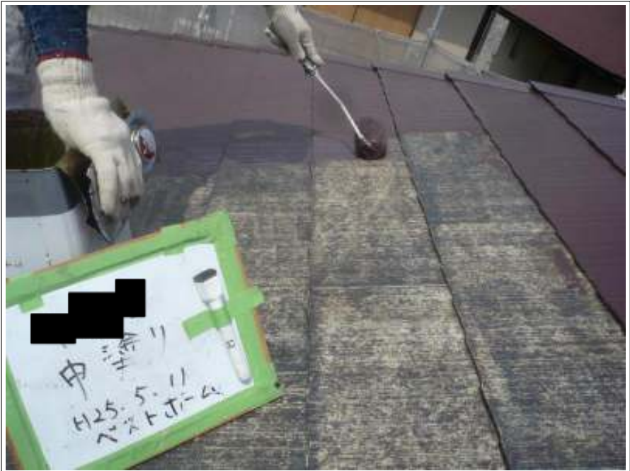
屋根中塗り施工状況
