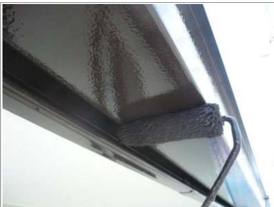
破風上塗り施工状況
