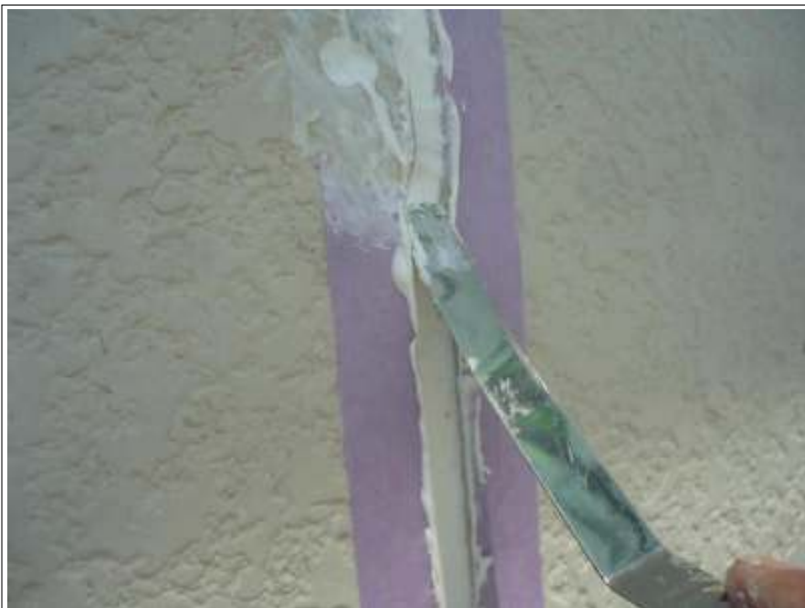
シーリング補修施工中
