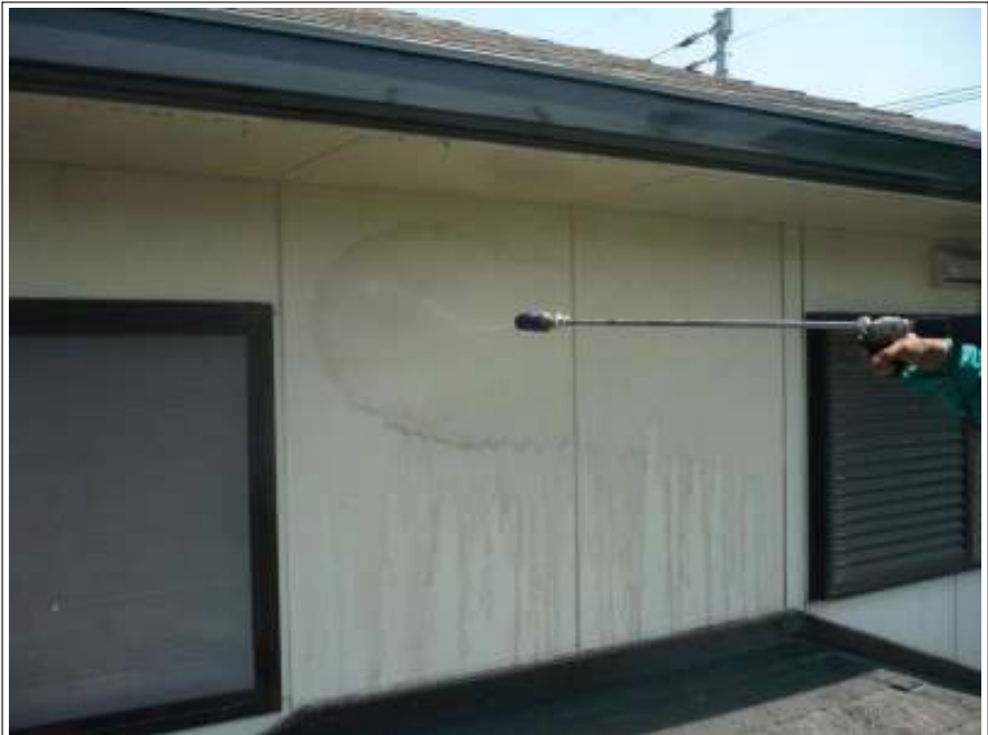
外壁高圧洗浄施工状況
