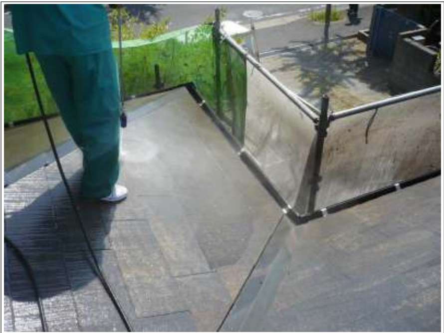
屋根高圧洗浄施工中
