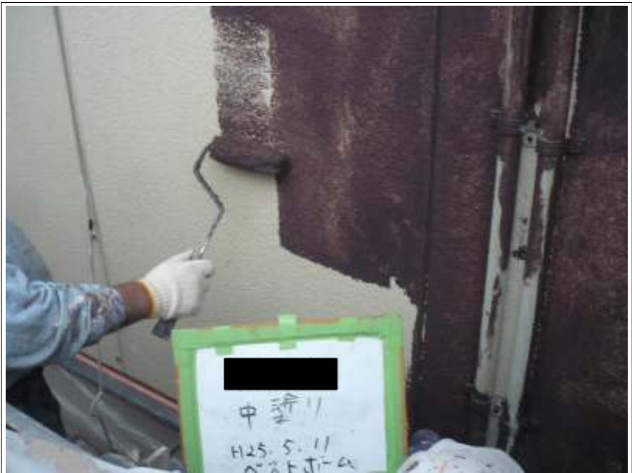
外壁中塗り施工状況
