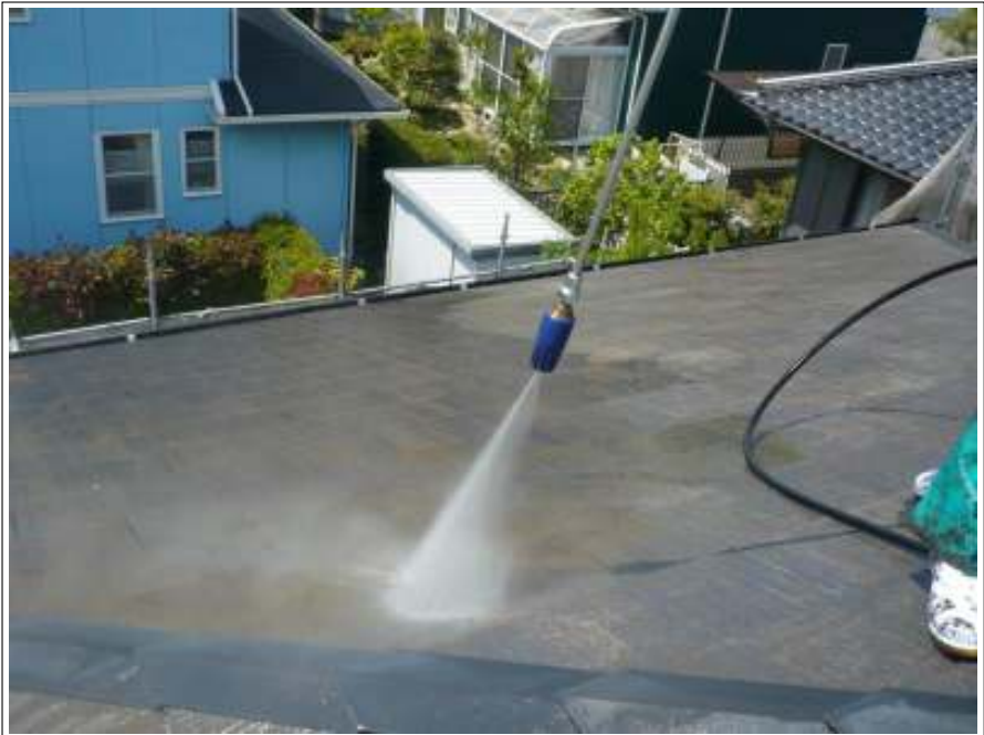
屋根高圧洗浄施工状況
