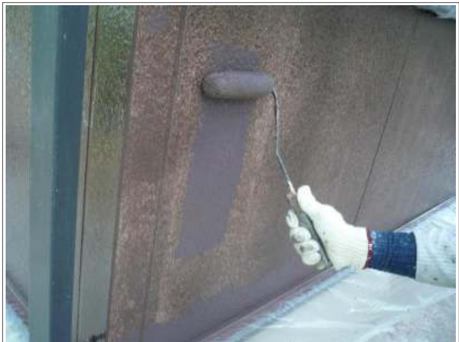
外壁上塗り施工状況
