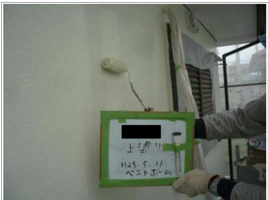
外壁上塗り施工状況
