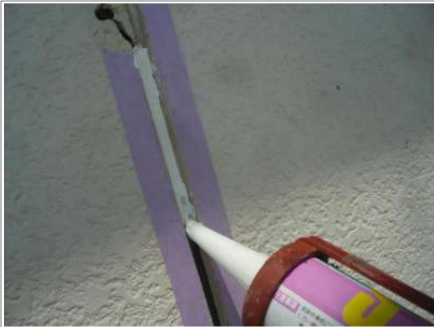
シーリング補修施工中
