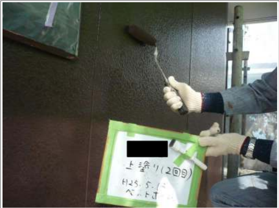
外壁上塗り施工状況（2回目）
