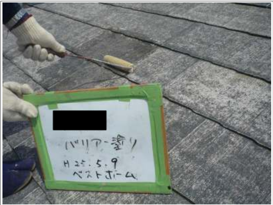
屋根バリアー施工状況
