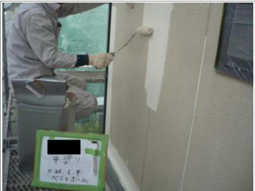
外壁中塗り施工状況
