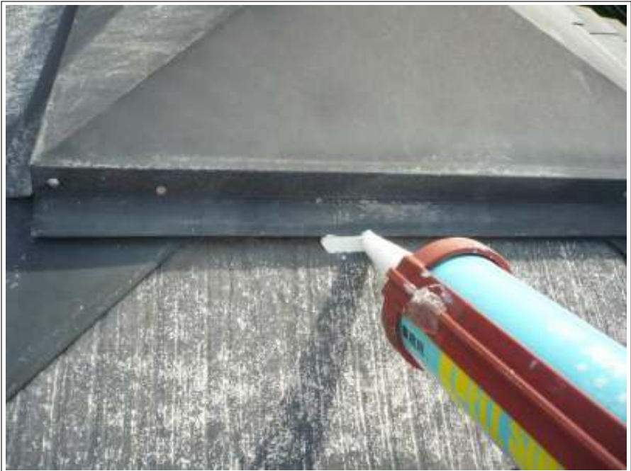
屋根ラバー止め施工状況
