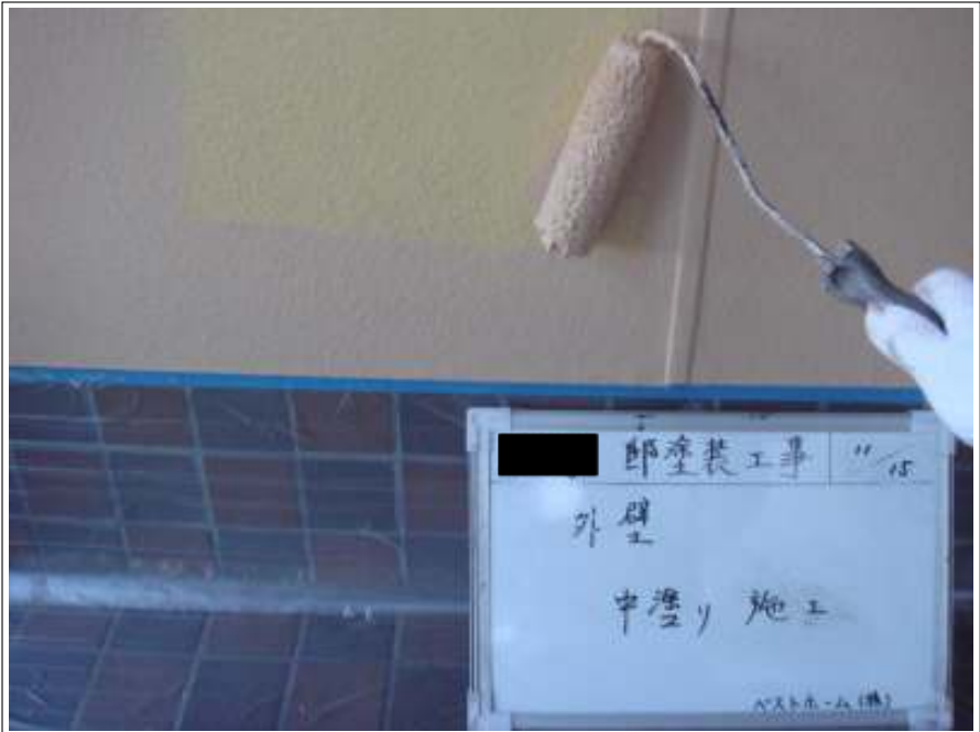
外壁塗装中塗り施工中
