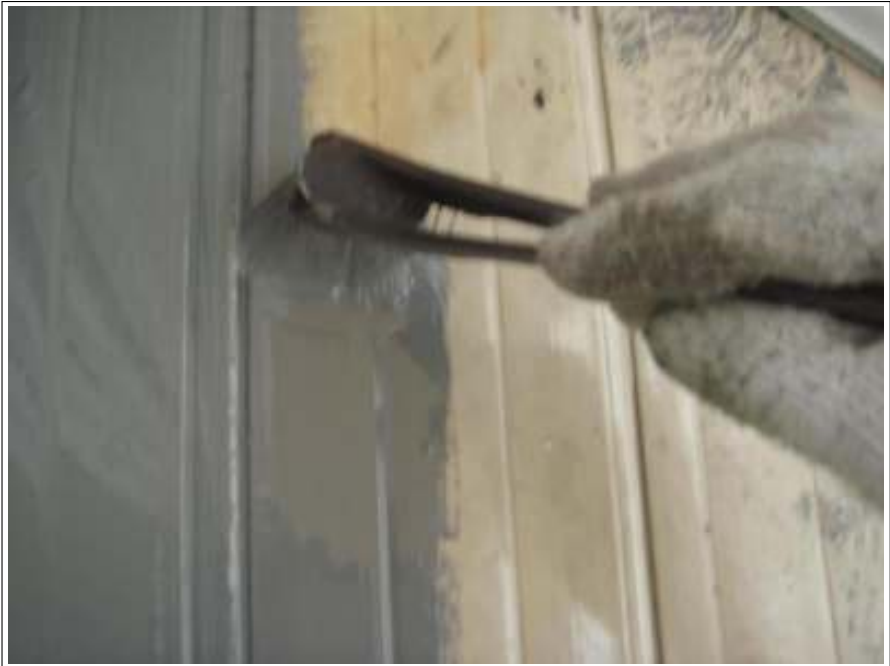
ベランダ防水 トップコート施工中
