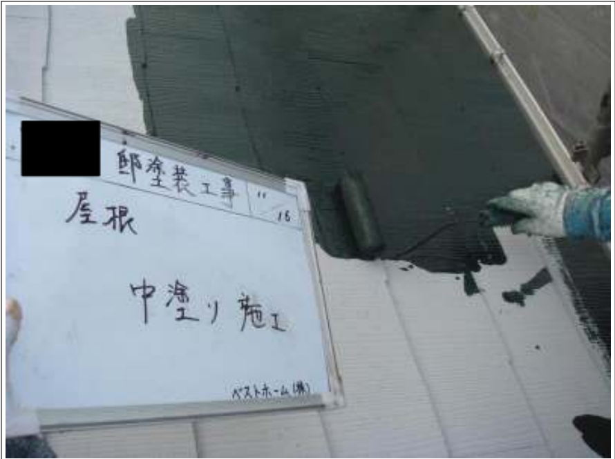
屋根塗装中塗り施工中
