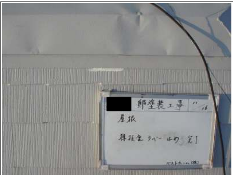
屋根 棟板金ラバー止め施工完了
