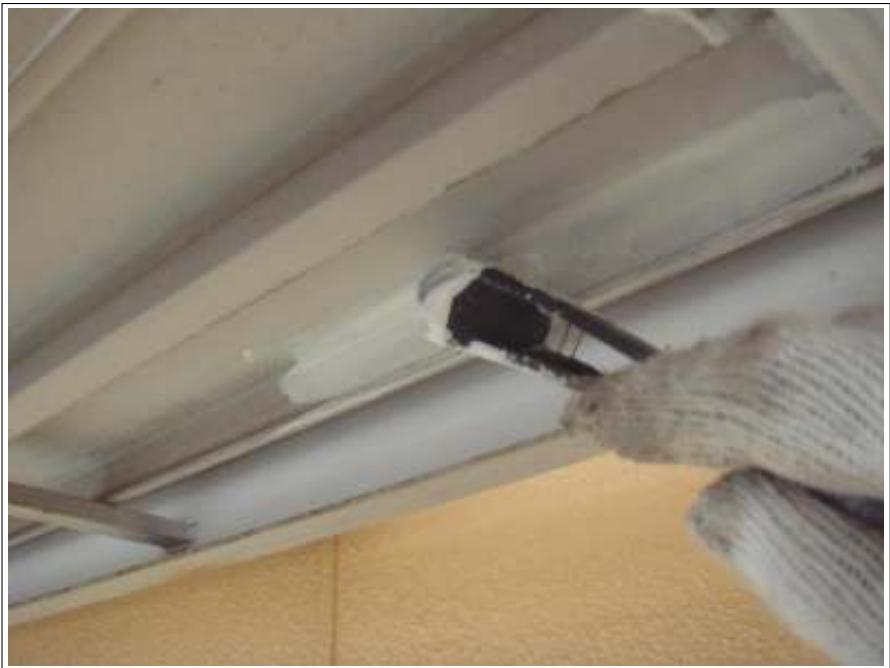
付帯 鉄格子錆止め施工中
