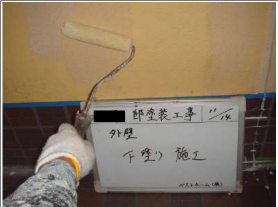
外壁塗装下塗り施工中
