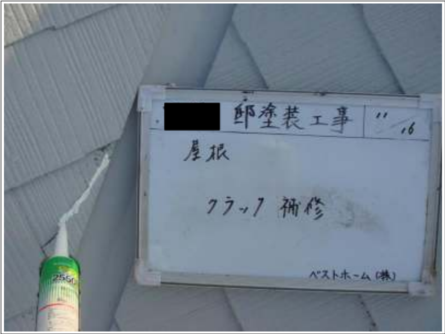
屋根 クラック補修施工中
