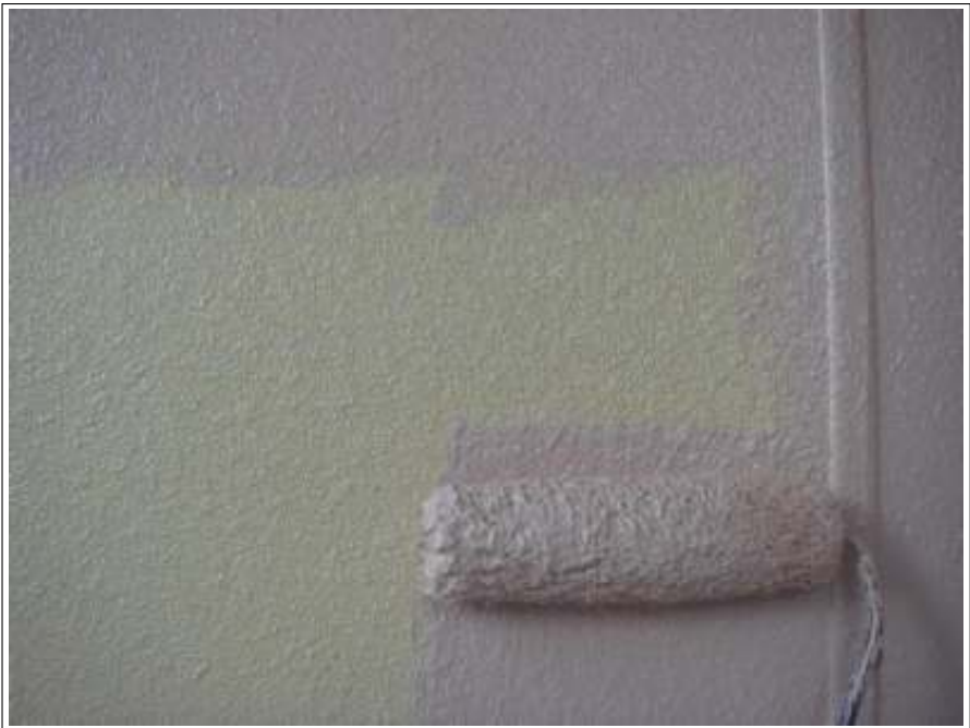
外壁塗装中塗り施工中
