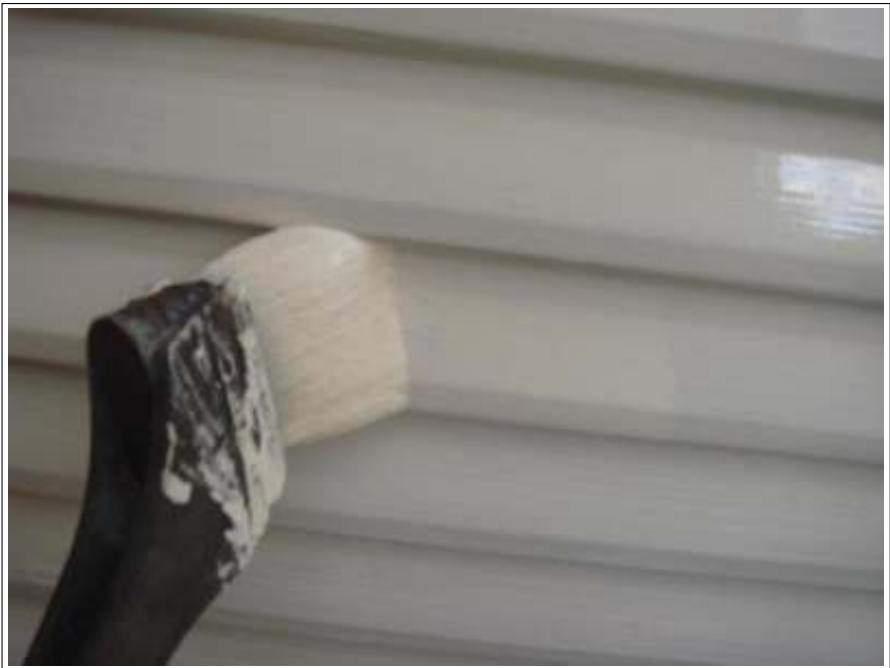
付帯 雨戸上塗り 1 回目施工中
