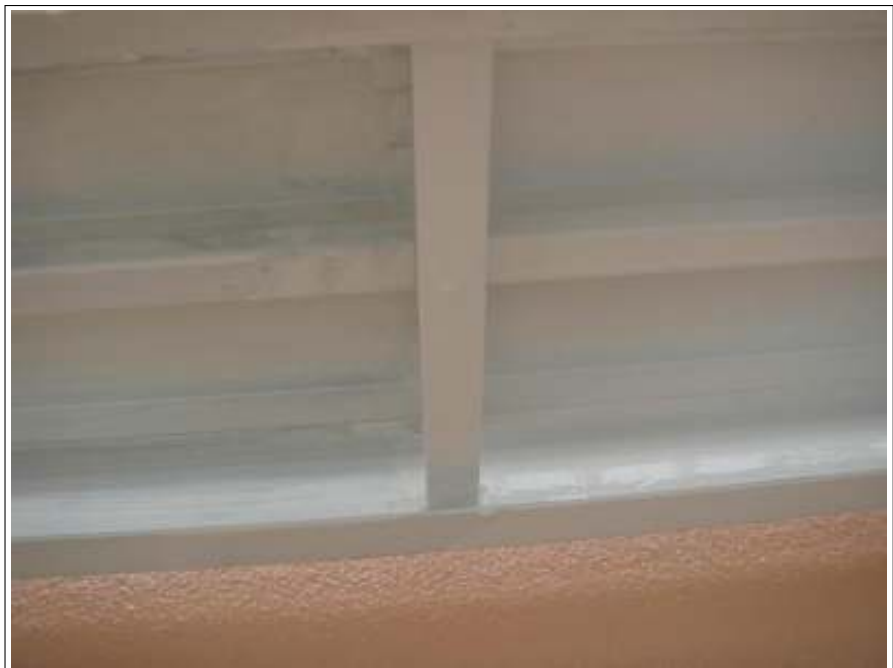
付帯 鉄格子上塗り施工中
