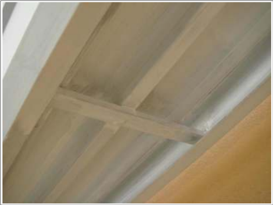
付帯 鉄格子錆止め完了
