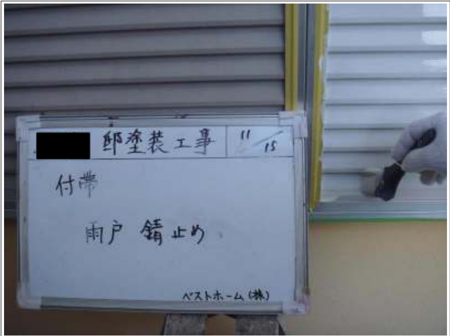
付帯 雨戸錆止め施工中
