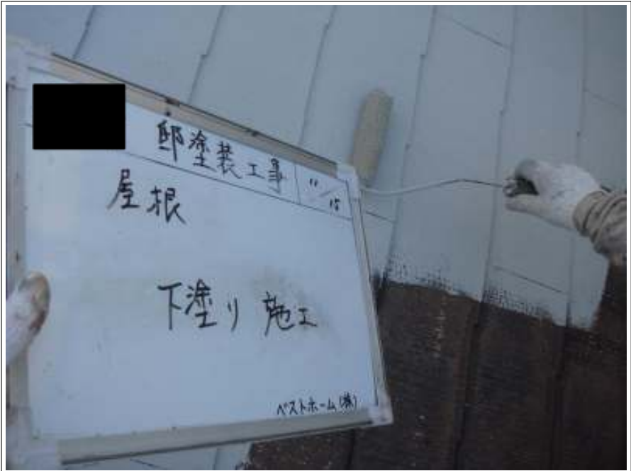
屋根塗装下塗り施工中
