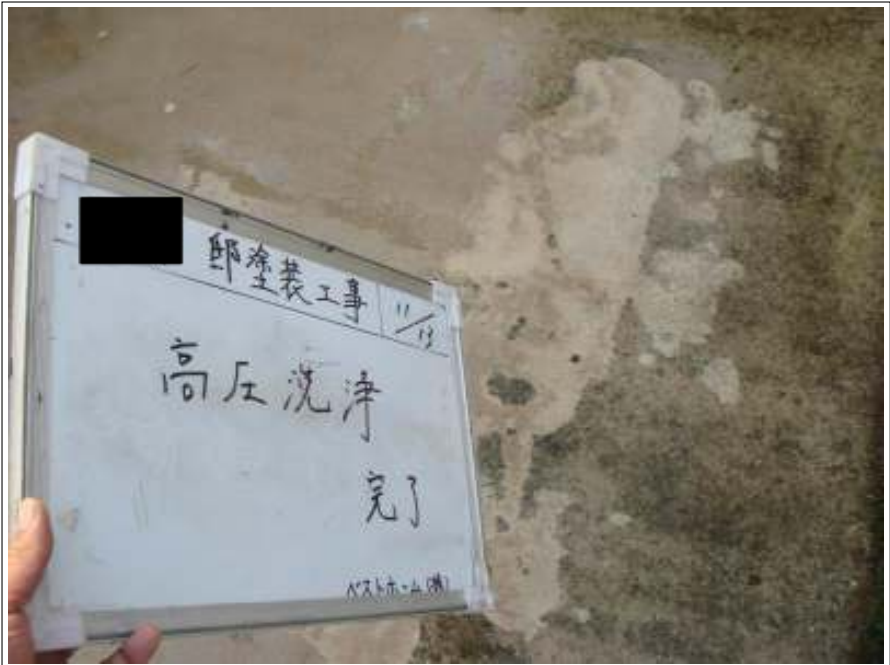
床高压洗浄完了
