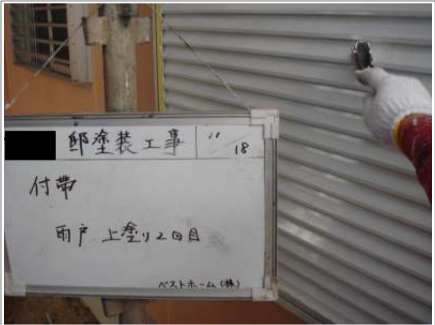
付帯 雨戸上塗り 2 回目施工中
