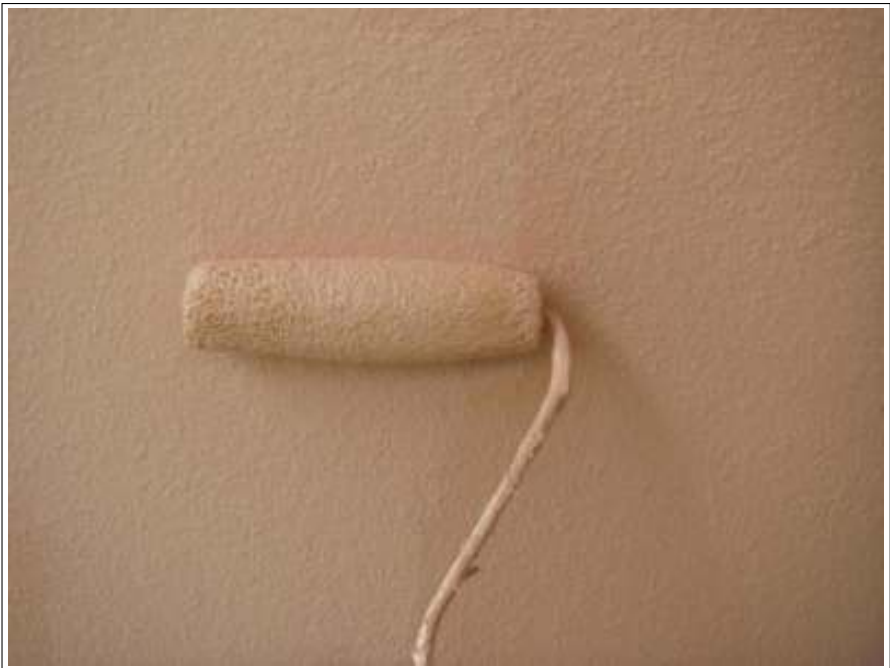
外壁塗装上塗り施工中
