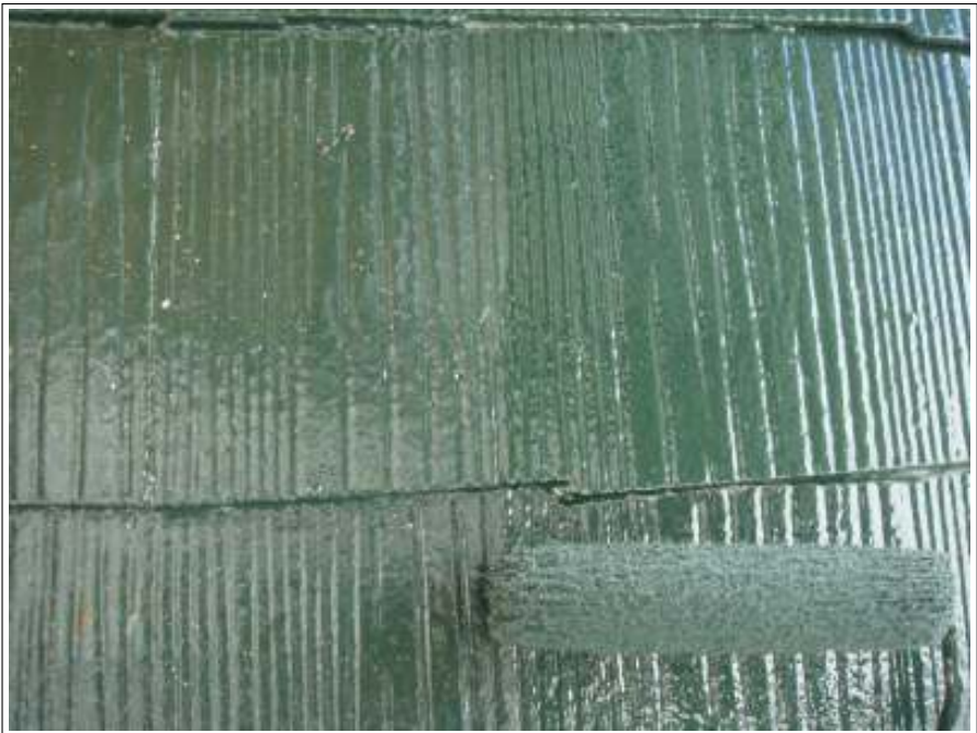
屋根塗装上塗り施工中
