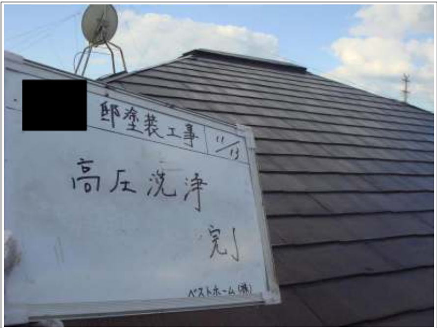
屋根高圧洗浄完了
