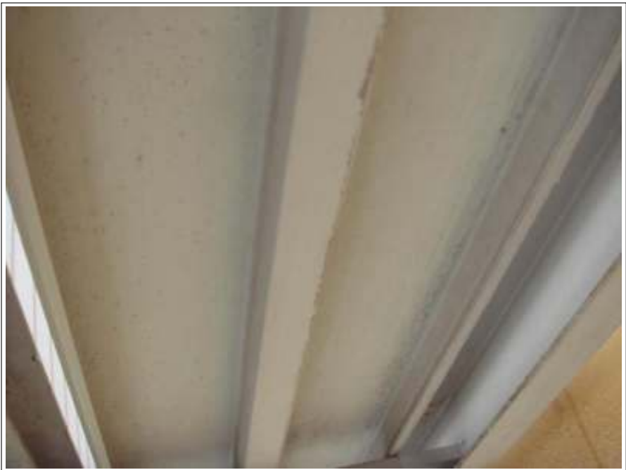
付帯 鉄格子ケレン施工完了
