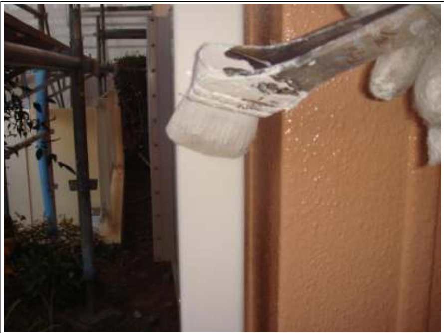
付帯 雨樋塗装 2 回目施工中
