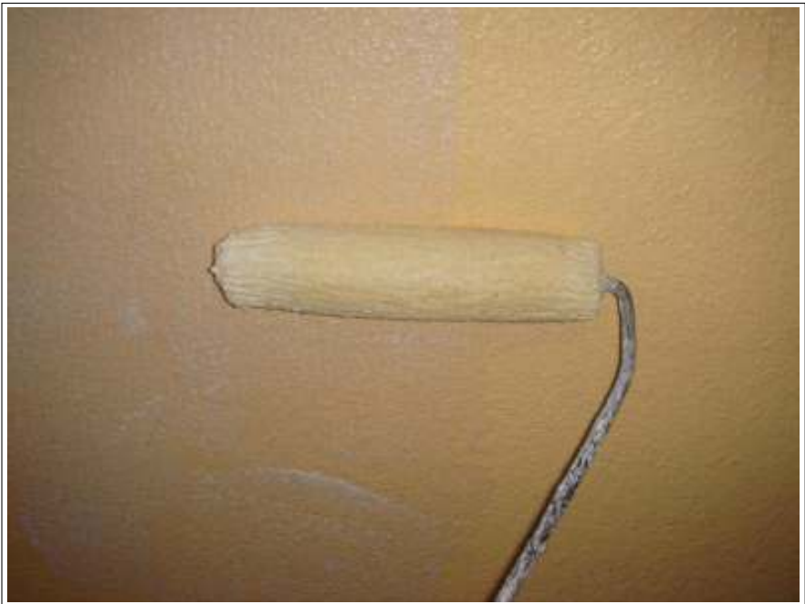
外壁塗装下塗り施工中
