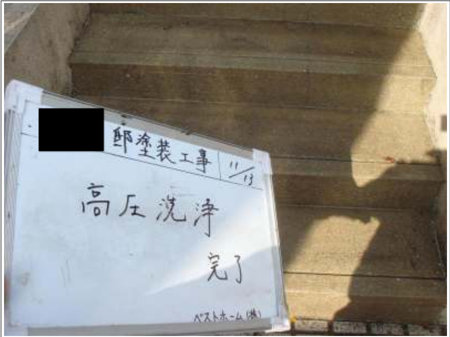
階段、土間高压洗浄完了
