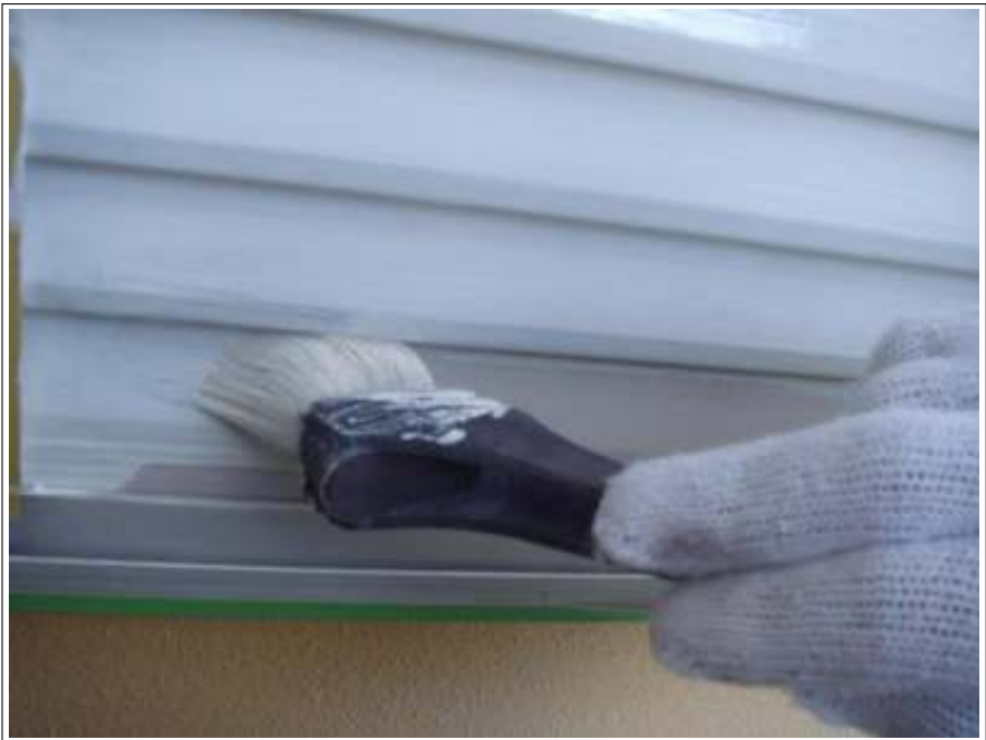
付帯 雨戸錆止め施工中
