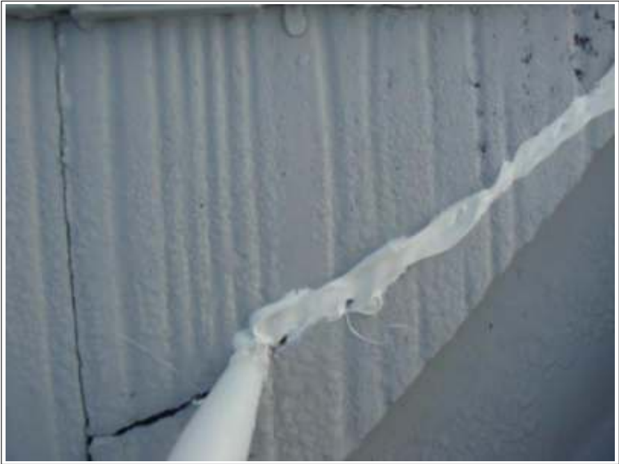
屋根 クラック補修施工中
