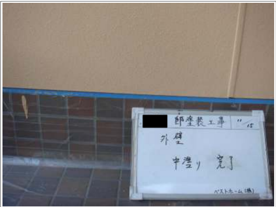
外壁塗装中塗り完了
