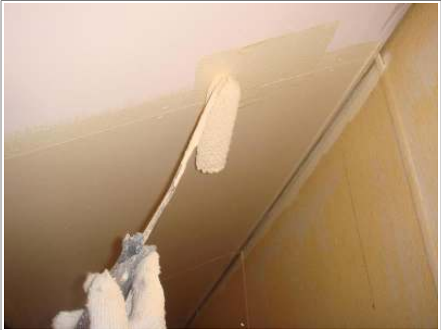
軒天塗装上塗り 1 回目施工中
