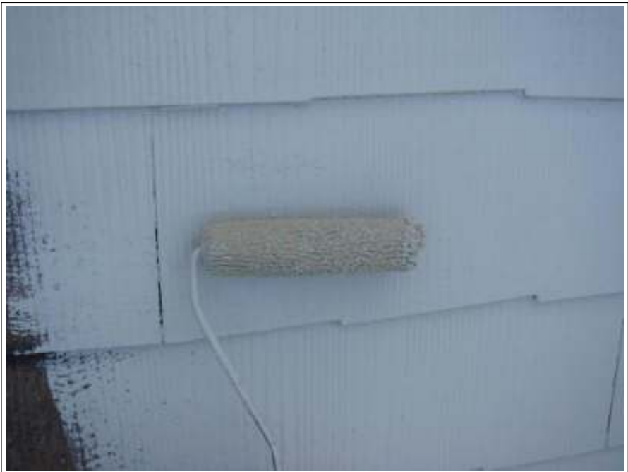
屋根塗装下塗り施工中
