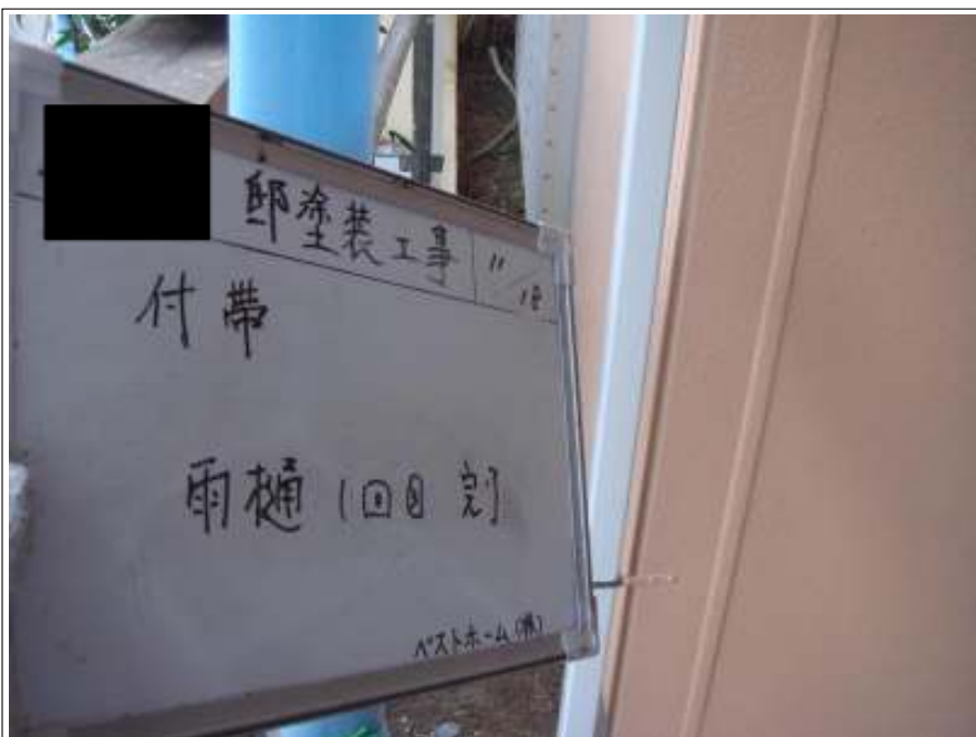
付帯 雨樋塗装 1 回目完了
