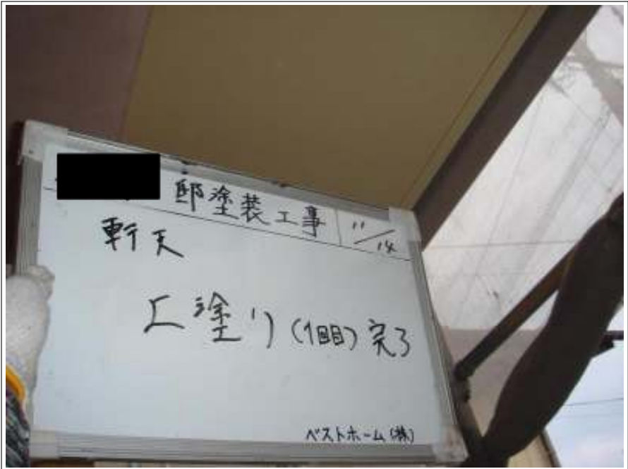
軒天塗装上塗り 1 回目施工完了
