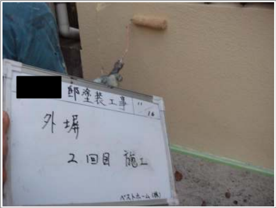
外塀塗装 2回目 施工中
