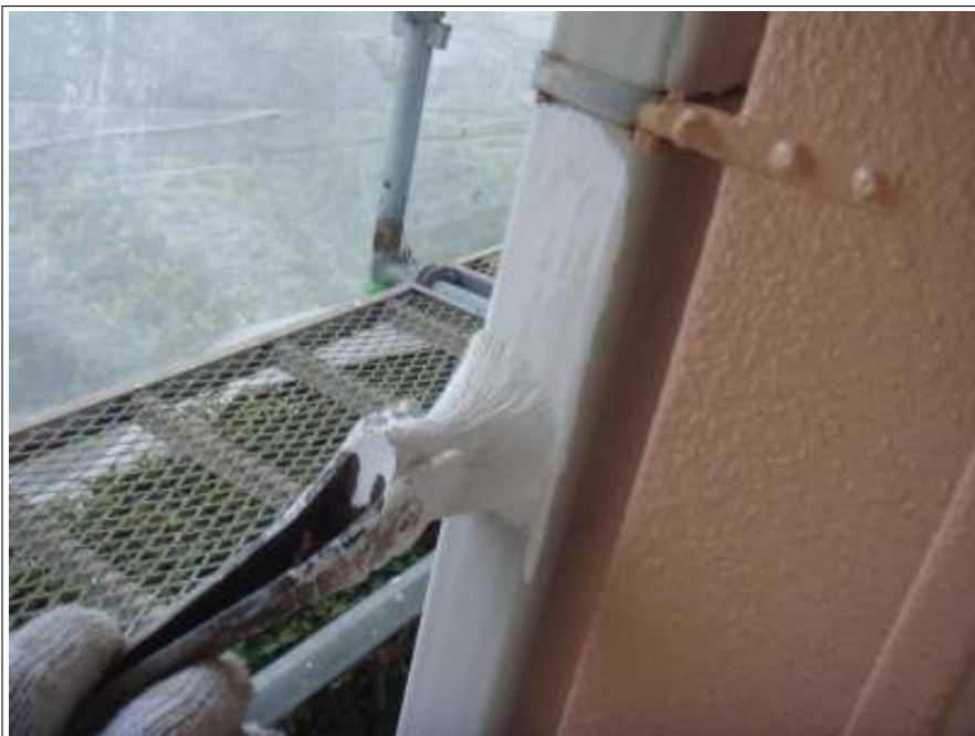
付帯 雨樋塗装 1 回目施工中
