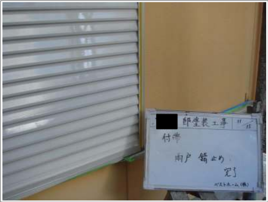
付帯 雨戸錆止め施工完了
