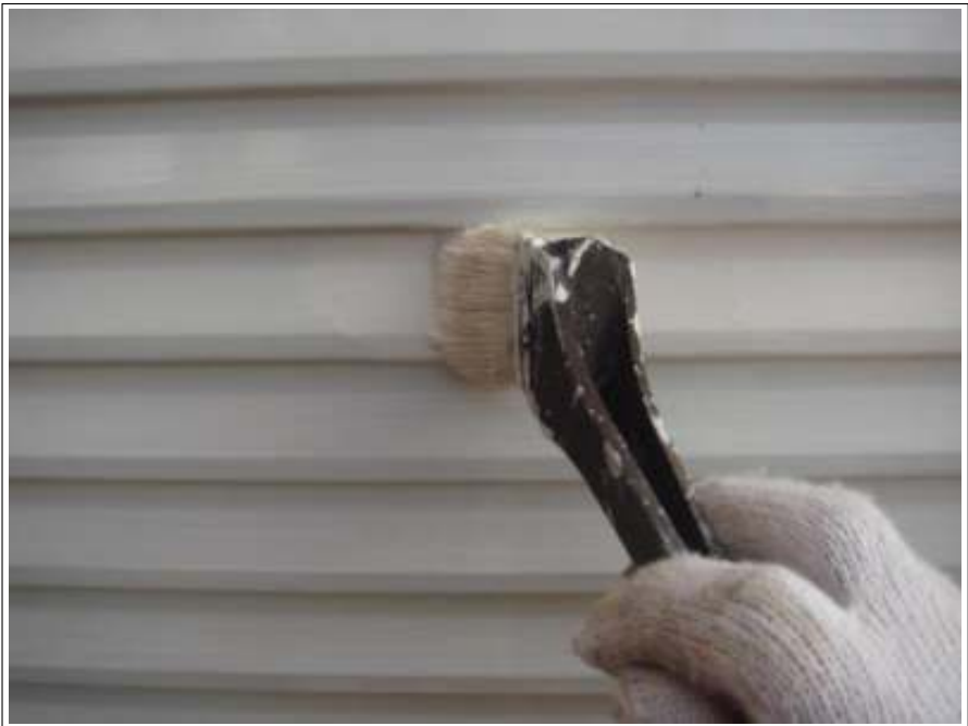
付帯 雨戸上塗り 2 回目施工中
