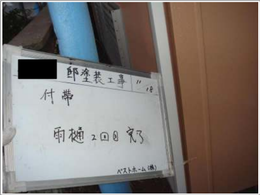
付帯 雨樋塗装 2 回目完了
