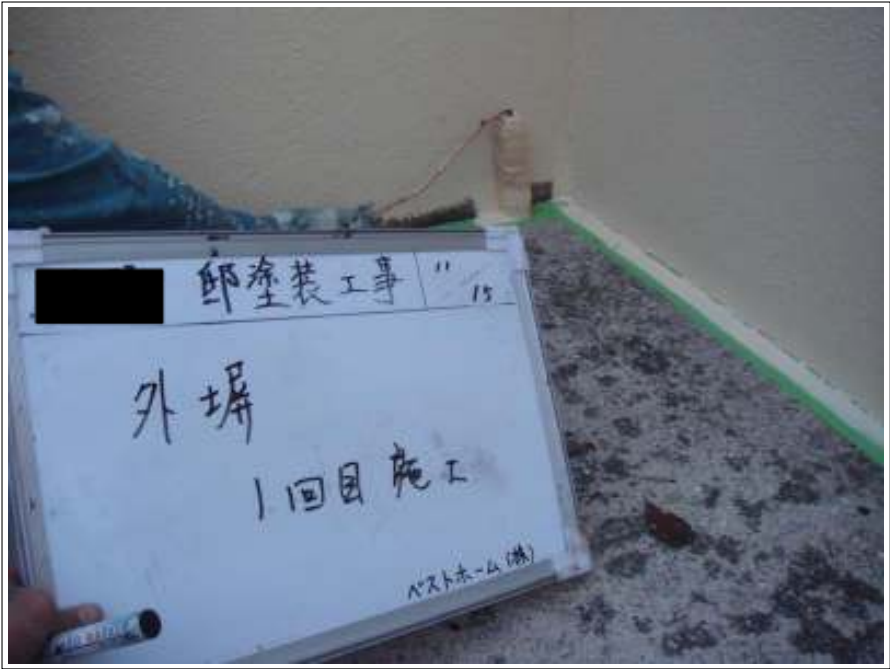
外壁塗装 1 回目施工中
