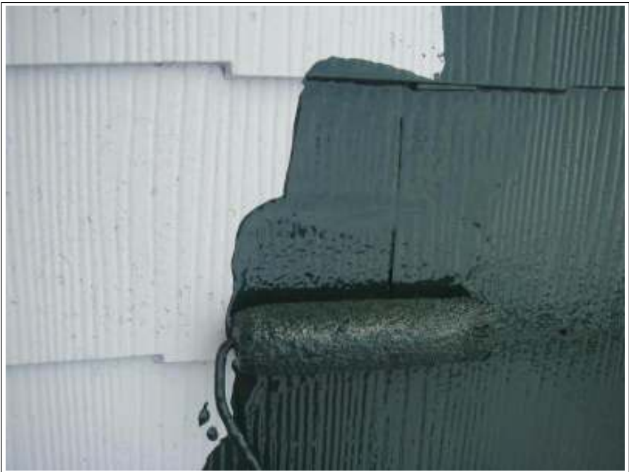
屋根塗装中塗り施工中
