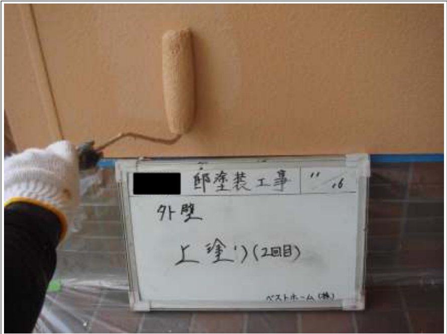
外壁塗装上塗り施工中
