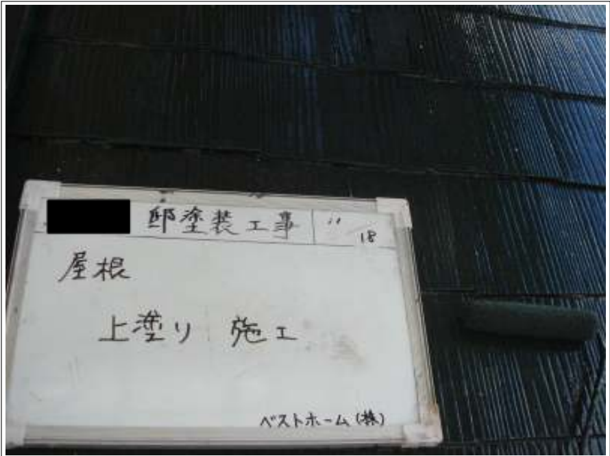
屋根塗装上塗り施工中
