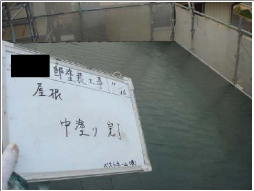
屋根塗装中塗り施工完了
