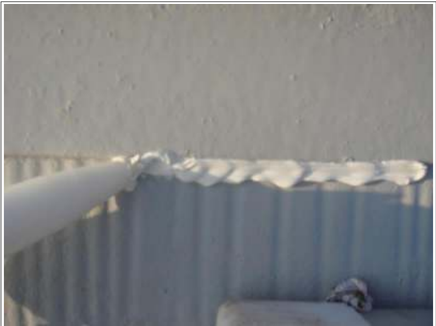
屋根 棟板金ラバー止め施工中
